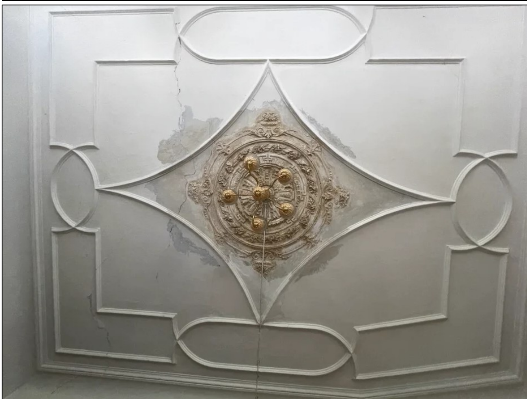
13. Комната (пом. 8: 25,7 м 2 ). Плафон потолка. *
