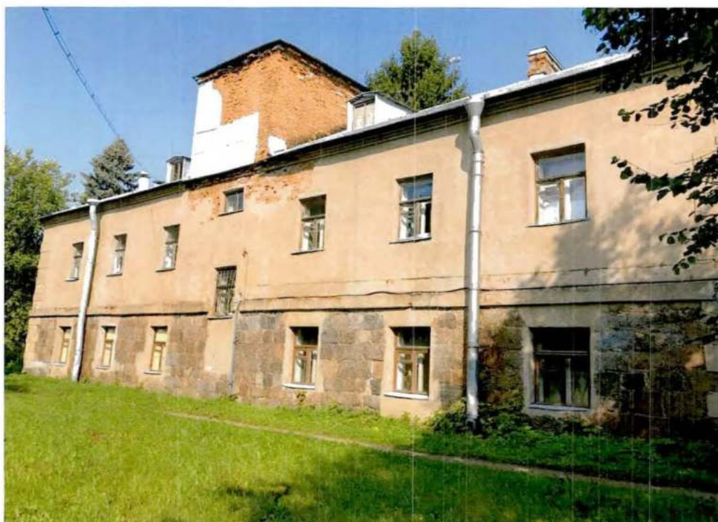
1. Вид с юго-запада. Фрагмент.
