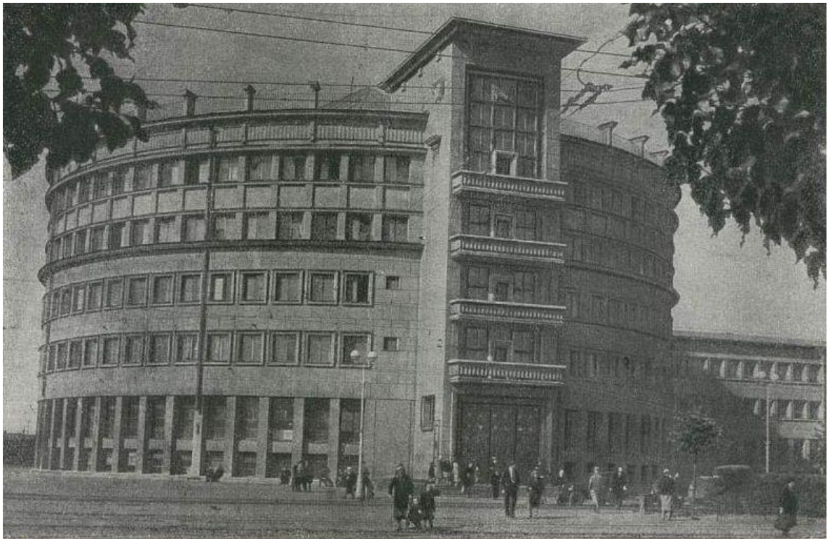
Дом Советов Московского района на Международном проспекте. Построен в 1936 г. по проекту члена-корреспондента Академии архитектуры СССР И. И. Фомина и архитектора В. Г. Даугаля.
