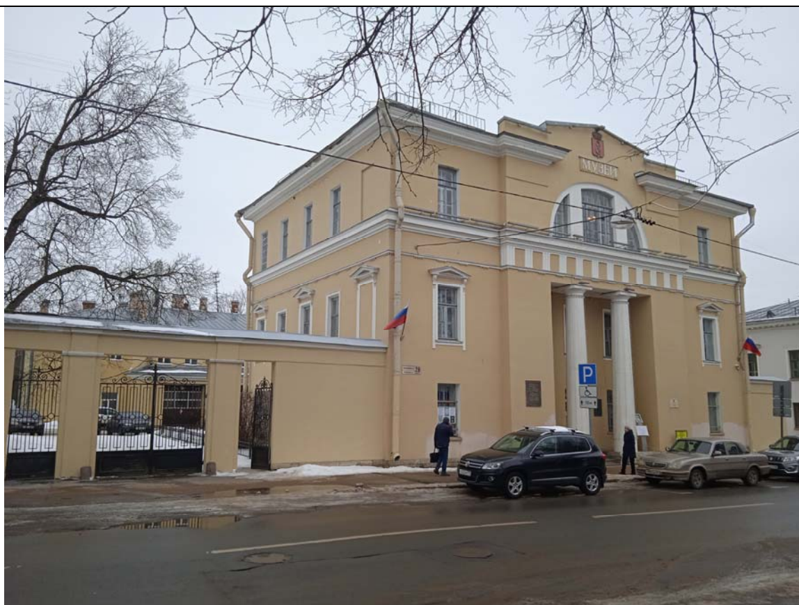
2. Объект культурного наследия федерального значения «Управление городское с оградой и воротами». Общий вид.
