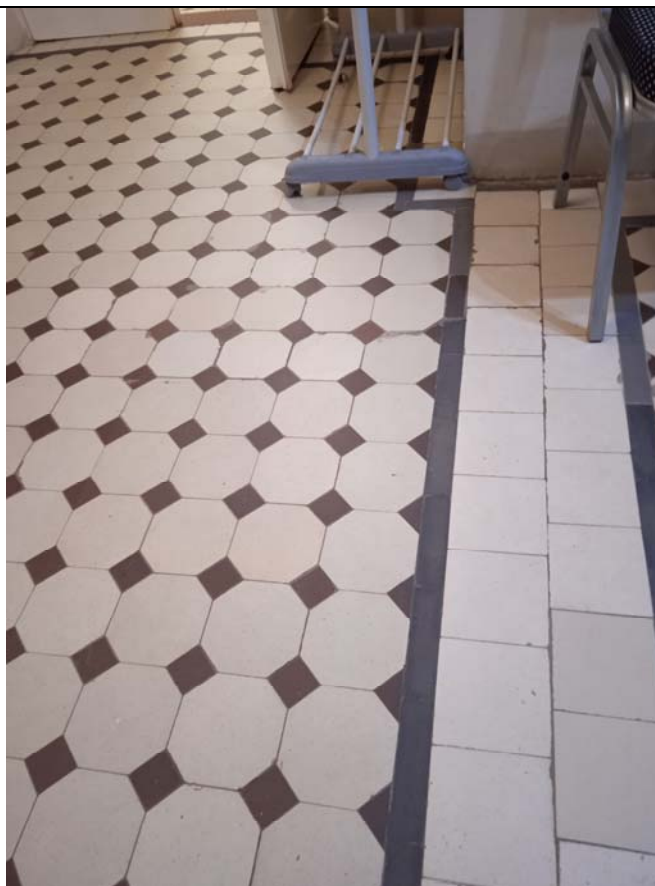
32. Объект культурного наследия федерального значения «Управление городское с оградой и воротами». Облицовка пола метлахской плиткой пом.1-Н, 1 этаж.
