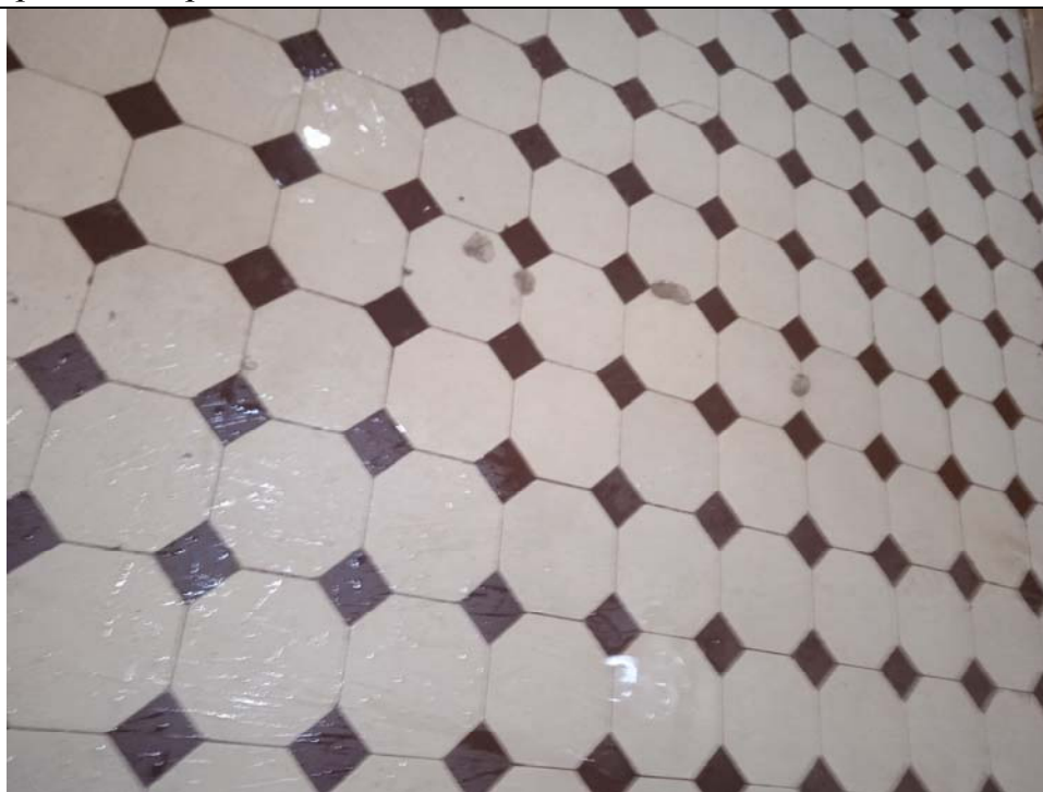
34. Объект культурного наследия федерального значения «Управление городское с оградой и воротами». Облицовка пола метлахской плиткой. Вестибюль.
