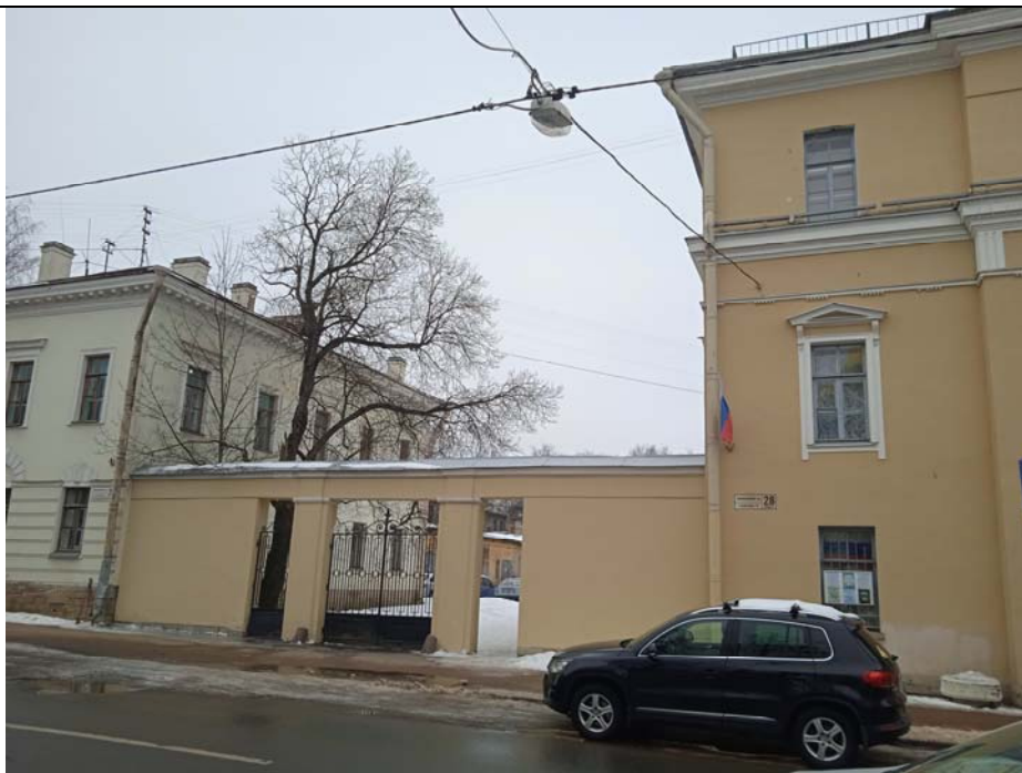
3. Объект культурного наследия федерального значения «Управление городское с оградой и воротами». Общий вид ограды с воротами.
