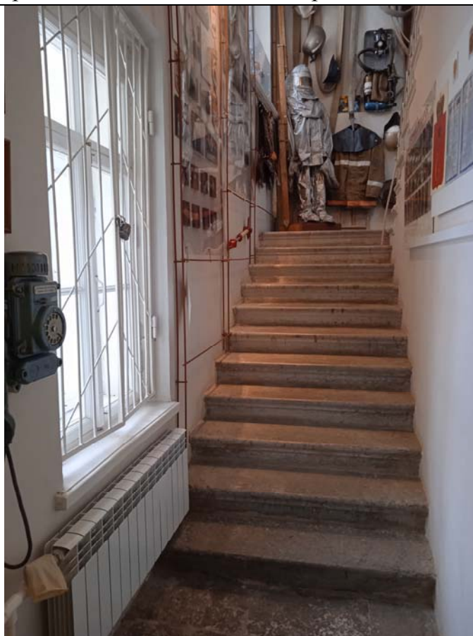
12. Объект культурного наследия федерального значения «Управление городское с оградой и воротами». Пожарная лестница. Общий вид.
