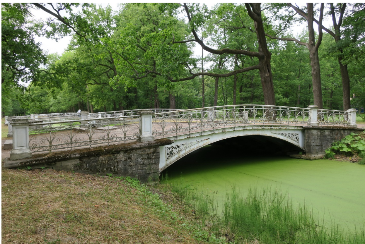
1. Низовой восточный фасад объекта культурного наследия федерального значения «Мост Металлический», расположенного по адресу: Санкт-Петербург, г. Пушкин, Александровский парк, литера БА. Вид с юго-востока. 01.07.2022
