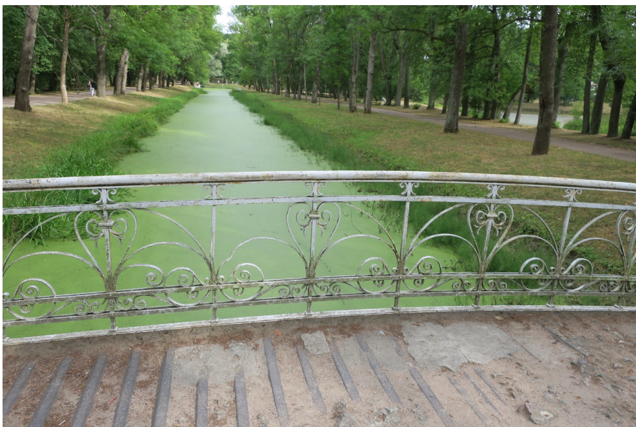
8. Перильное ограждение верхового фасада объекта культурного наследия федерального значения «Мост Металлический», расположенного по адресу: Санкт-Петербург, г. Пушкин, Александровский парк, литера БА. 01.07.2022
