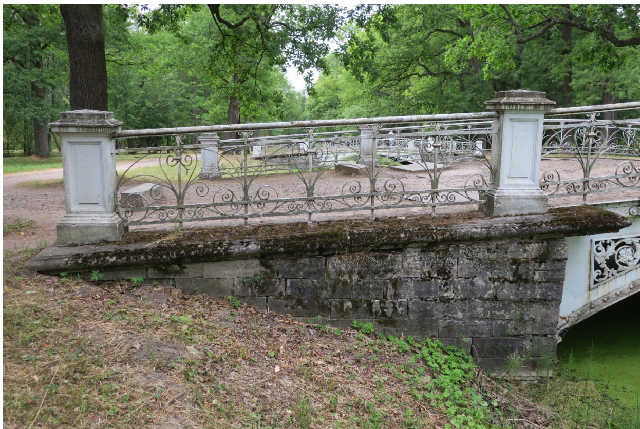
3. Левый устой низового фасада объекта культурного наследия федерального значения «Мост Металлический», расположенного по адресу: Санкт-Петербург, г. Пушкин, Александровский парк, литера БА. 01.07.2022
