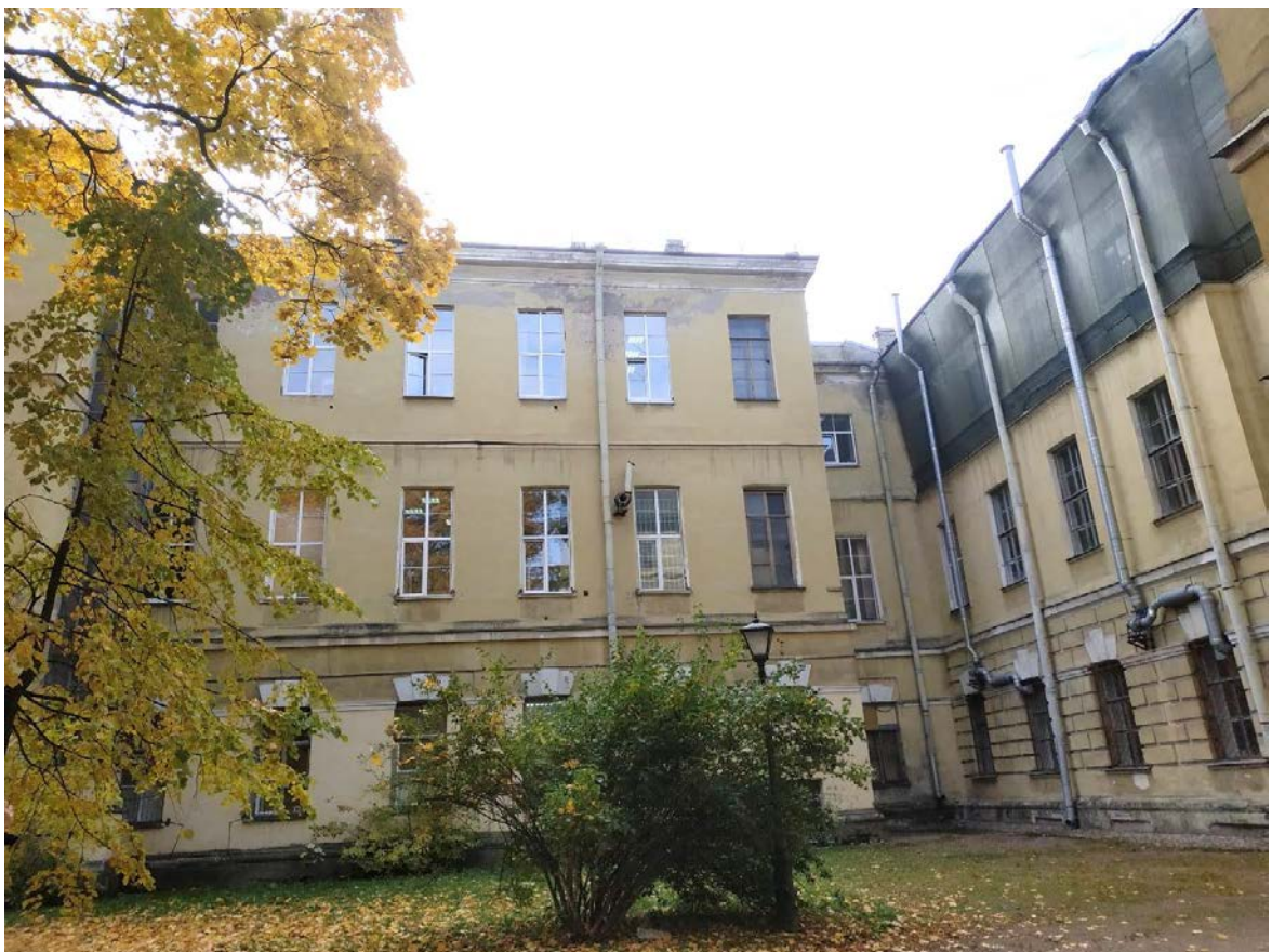
40. Примыкание южного флигеля к основному корпусу (южный ризалит).
