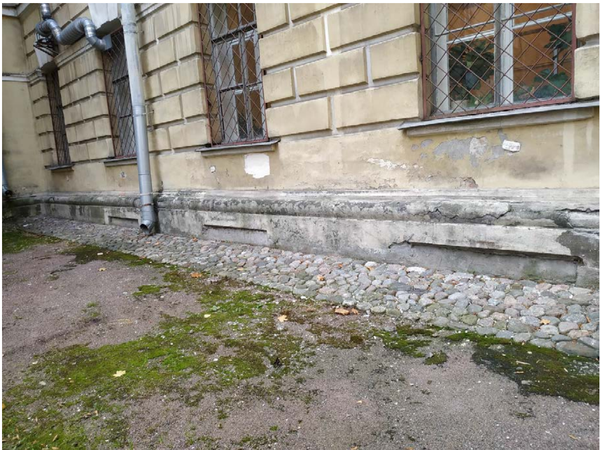
36. Поздние обмазочные слои известнякового цоколя цемент содержащим раствором.
