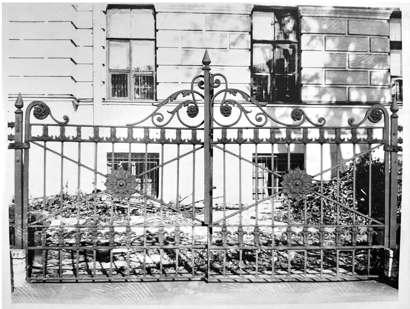
19. Филиал Государственной Публичной Библиотеки. Фонтанка, 36. (б. Екатерининский институт). Ограда у главного фасада здания. Фрагмент – ворота – ближе к северному ризалиту здания. Июнь 1962 года. // ЦГАНТД СПб, Ф.488, Оп.323, Д.295, фото 6, инв.№40222/2
