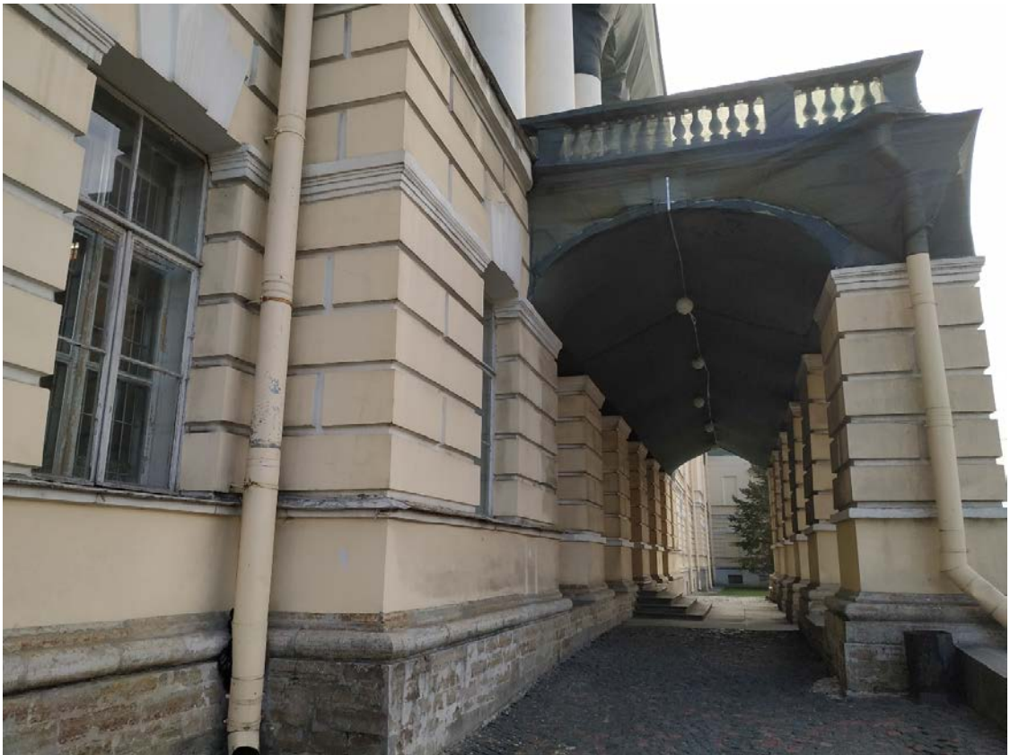
14. Общий вид колоннады и балкона-террасы с северной стороны.
