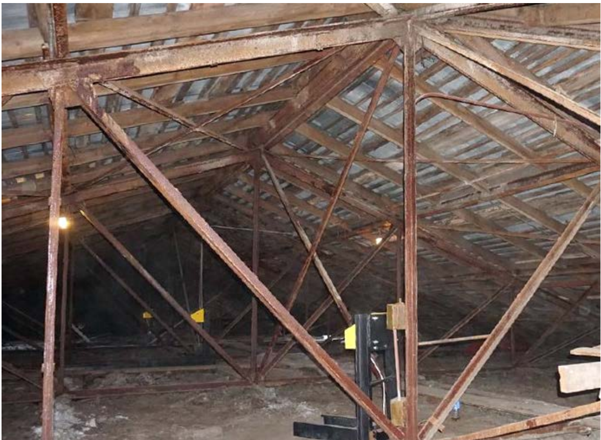
49. Металлические фермы (поздняя конструкция) над северным флигелем (лицевая часть).
