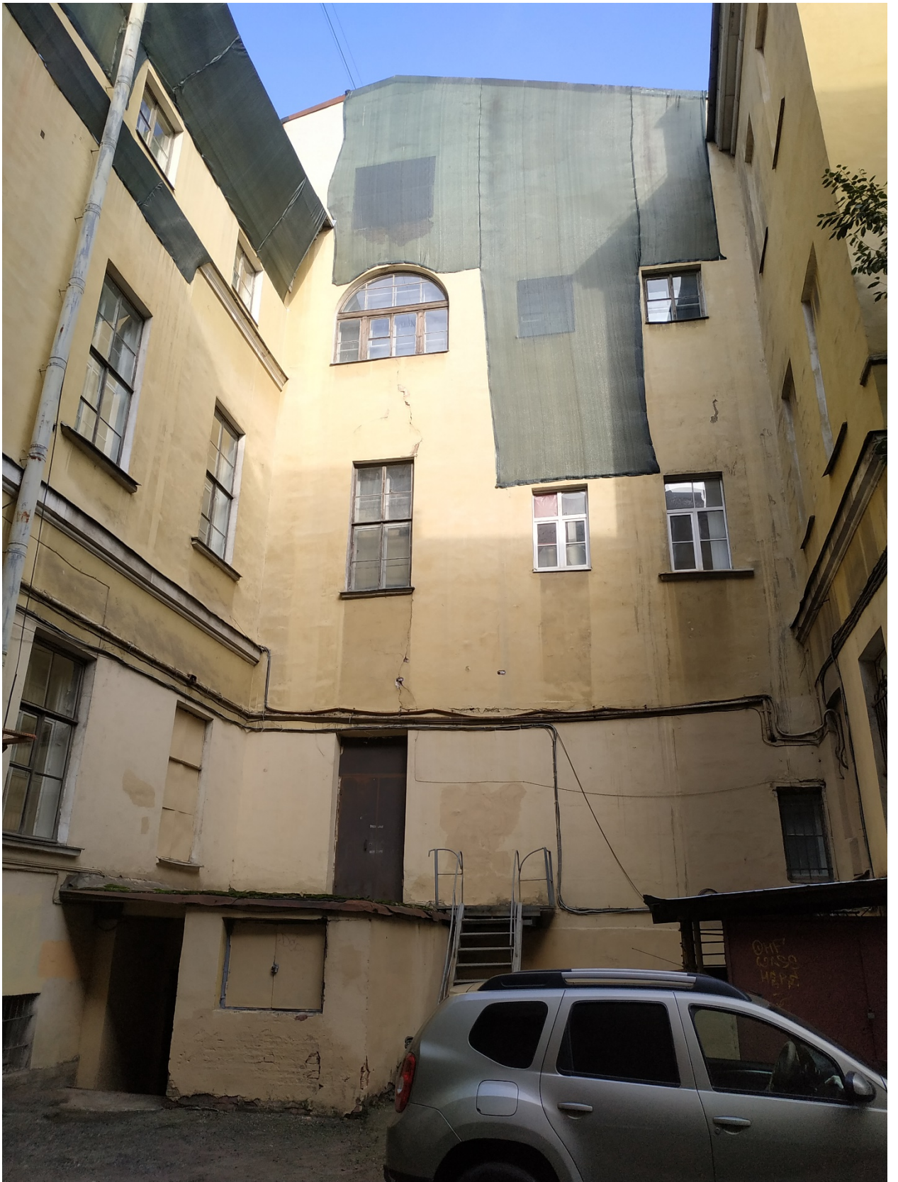
23. Южный фасад главного корпуса.
