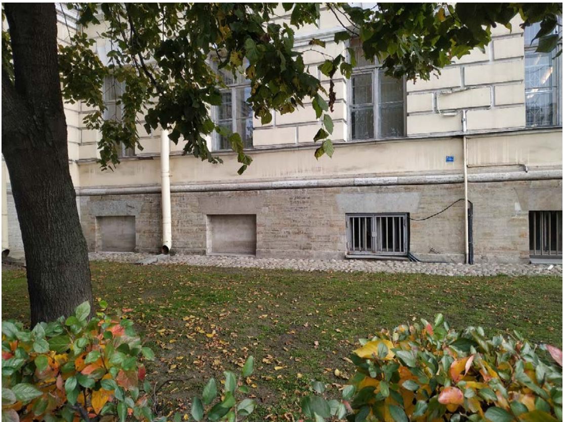
15. Заложенные оконные проемы цокольного этажа в северной части лицевого фасада.
