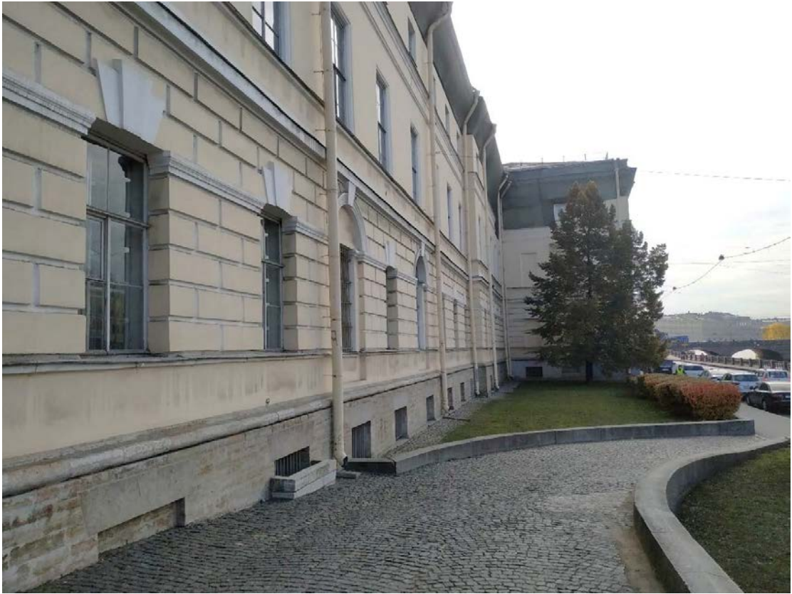
8. Общий вид южного пандуса.
