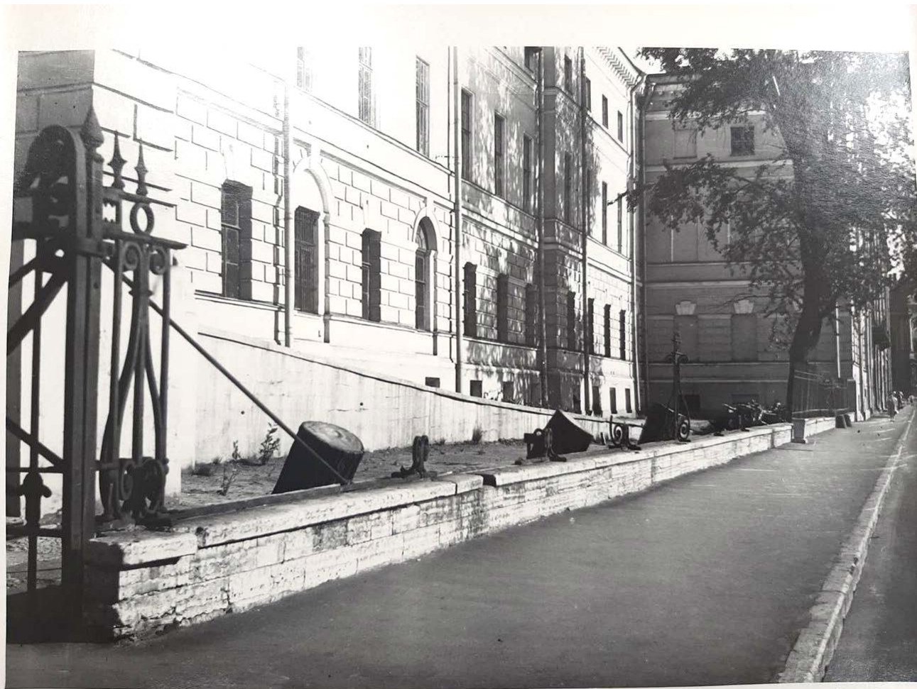
18. Филиал Государственной Публичной Библиотеки. Фонтанка, 36. (б. Екатерининский институт). Ограда у главного фасада. Общий вид цоколя от центрального входа в сторону южного ризалита. Июнь 1962 года. // ЦГАНТД СПб, Ф.488, Оп.323, Д.295, фото 3, инв.№40215/2
