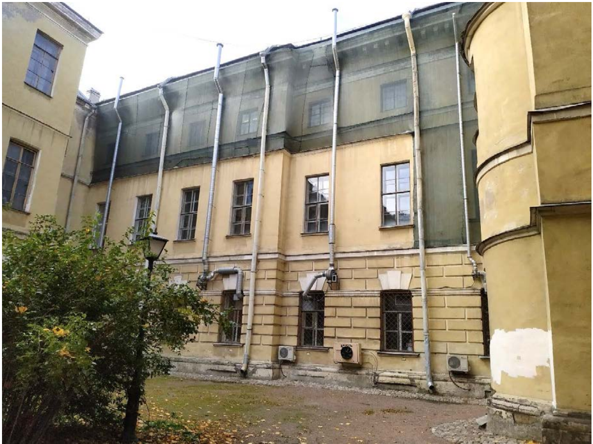
35. Южный фрагмент восточного фасада.
