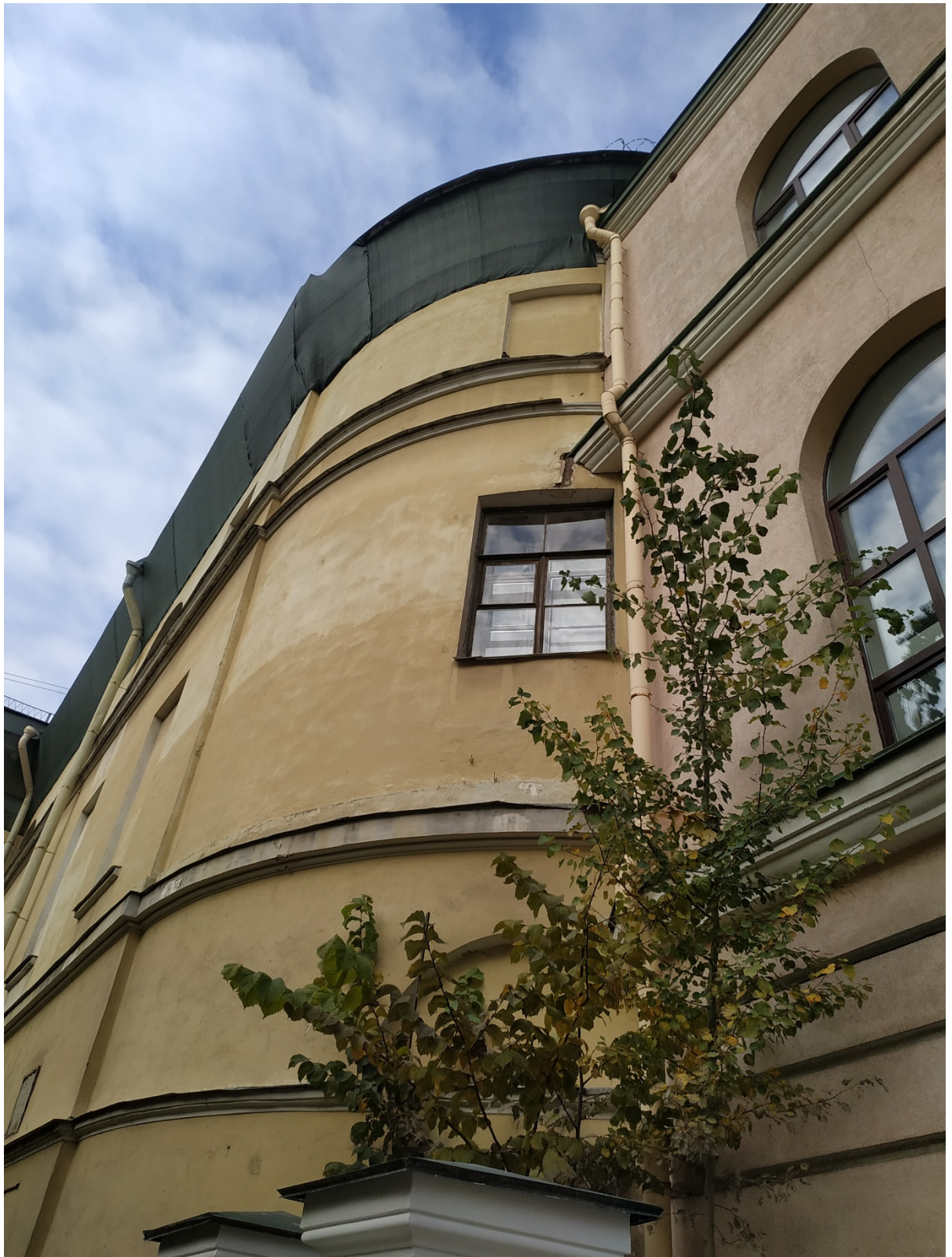
28. Примыкание позднего здания к апсиде церкви.
