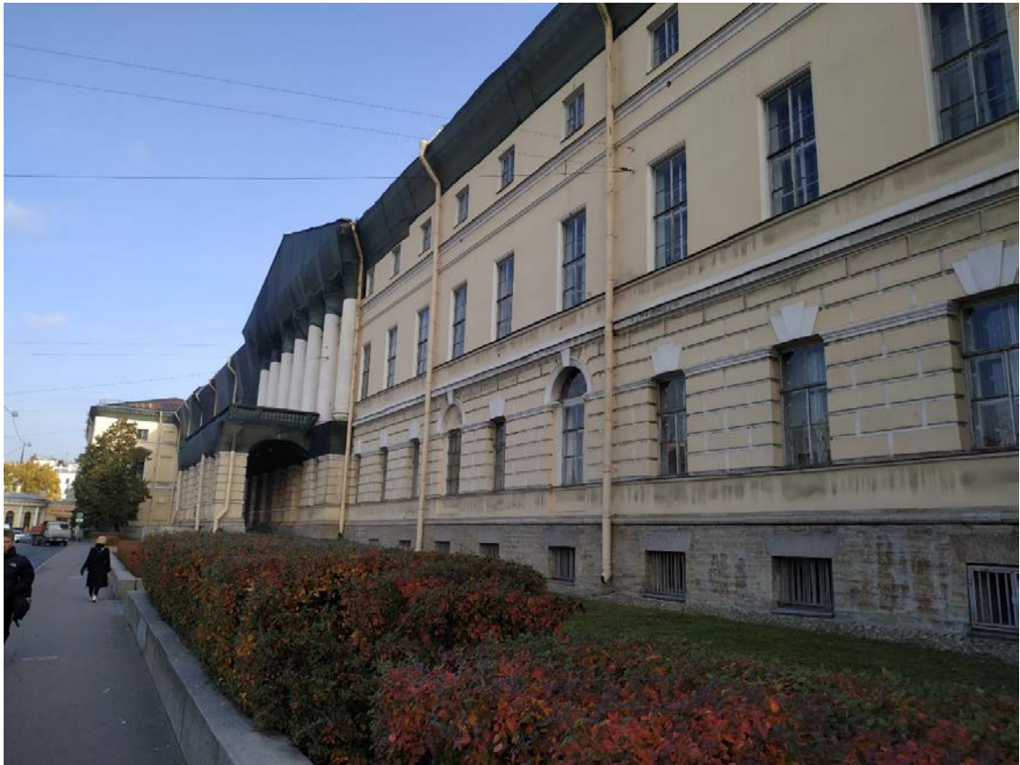
1. Вид лицевого фасада с наб. реки Фонтанки.
