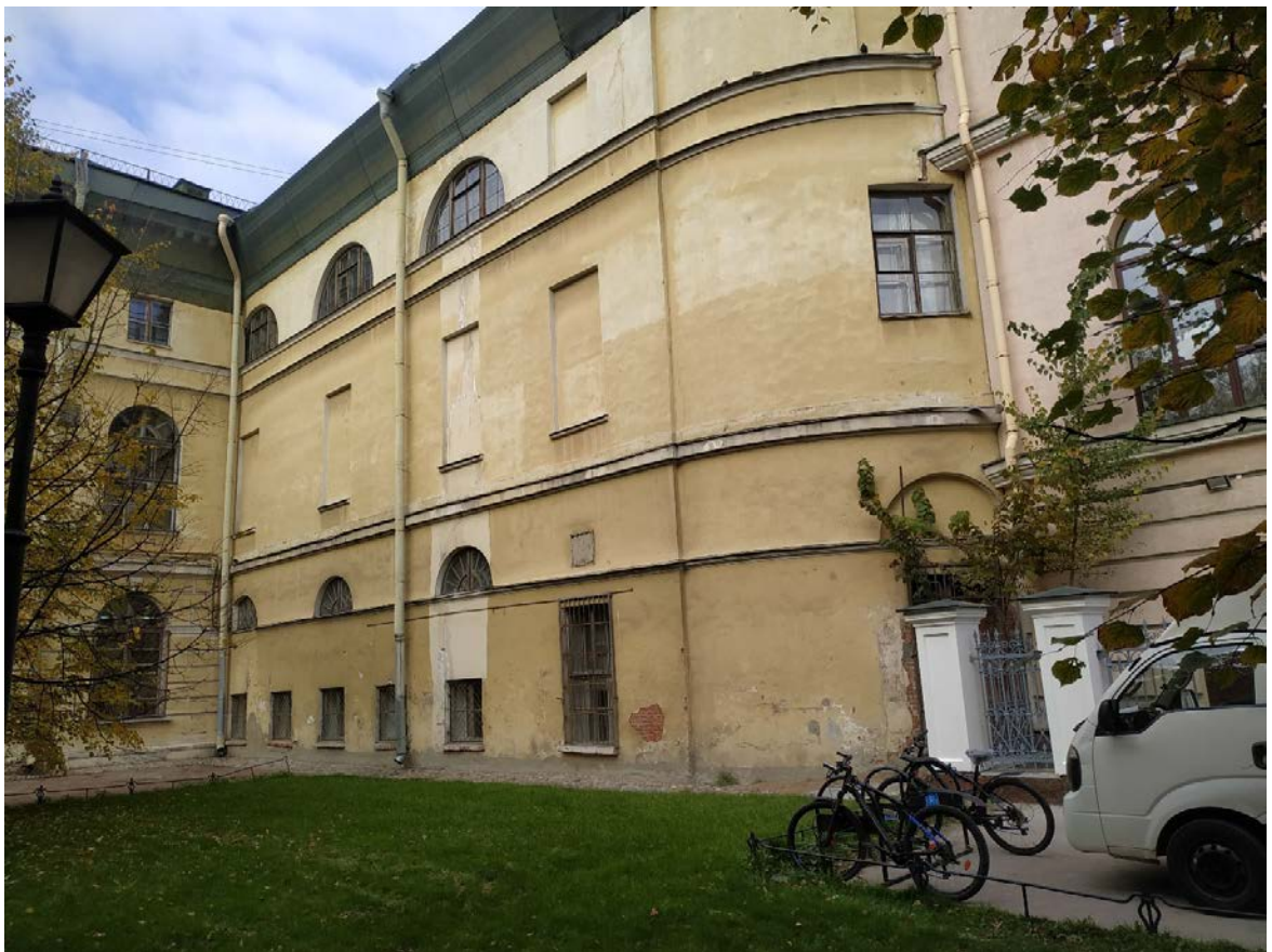
27. Южный фасад церкви.
