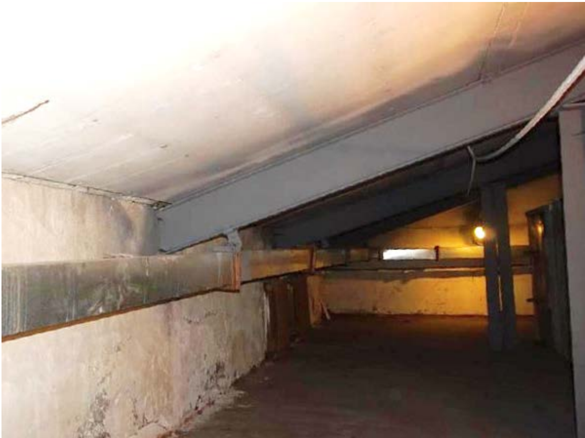
48. Металлические стропила (поздняя конструкция) над южным флигелем (лицевая часть).
