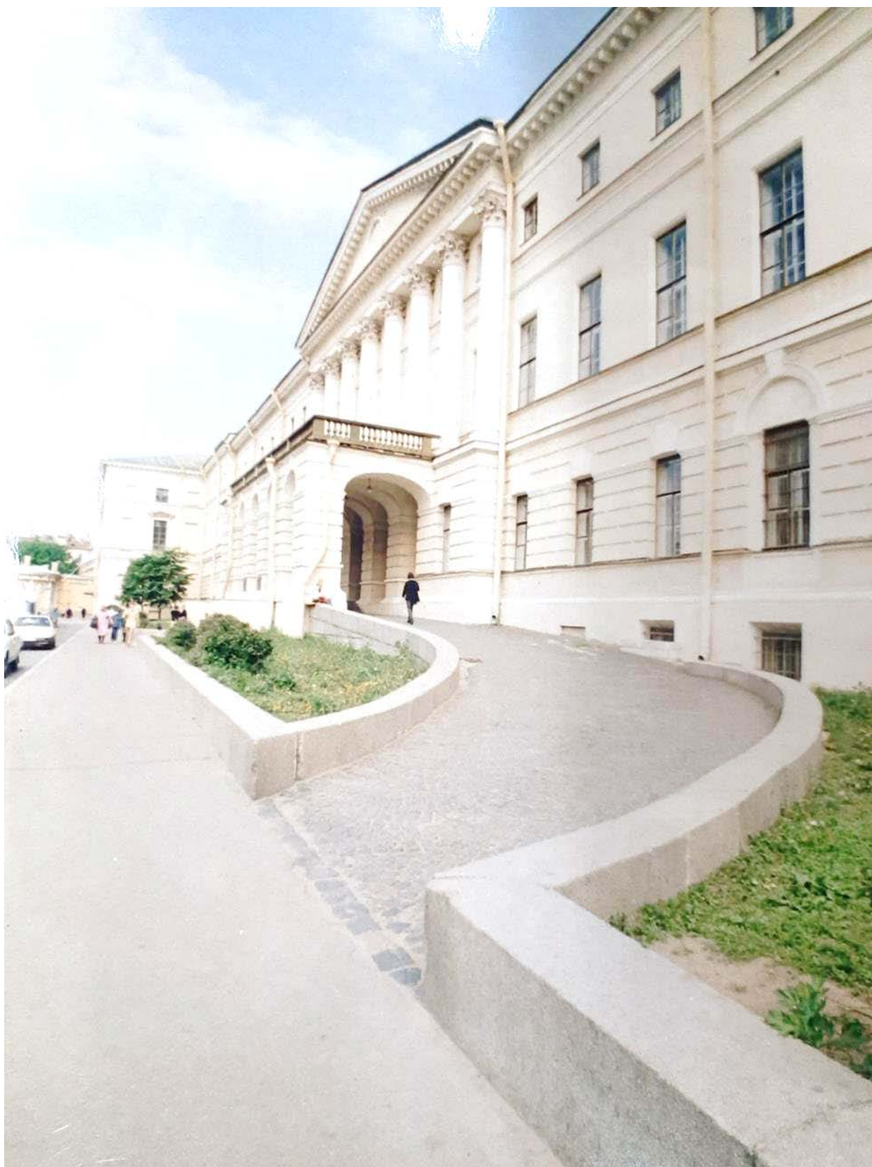
21. Институт Екатерининский. Главный (западный) фасад. Пандус. // Архив КГИОП.Паспорт. Екатерининский институт. Сост. А.В. Бертани, И.В. Савельева. 2000. П 983-1. №136п. Фото №2. 1999 г. А.К. Дергауз.
