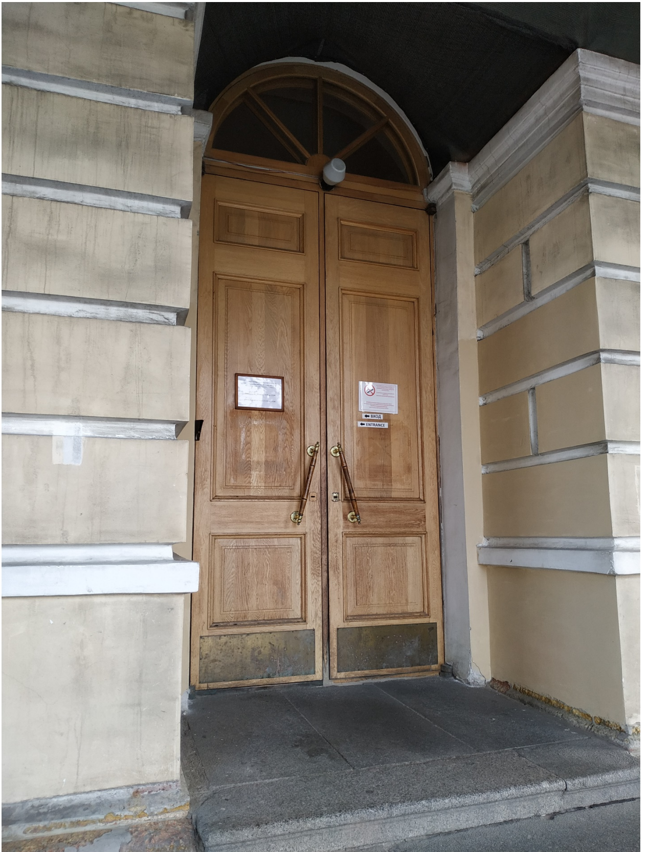
5. Дубовое дверное заполнение главного входа.
