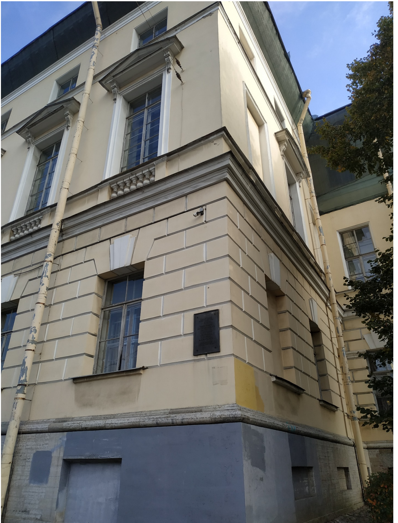
16. Угол северного ризалита лицевого фасада. Поздние окрасочные слои облицовки цоколя. Выполнена поздняя закладка оконных проемов цокольного этажа.
