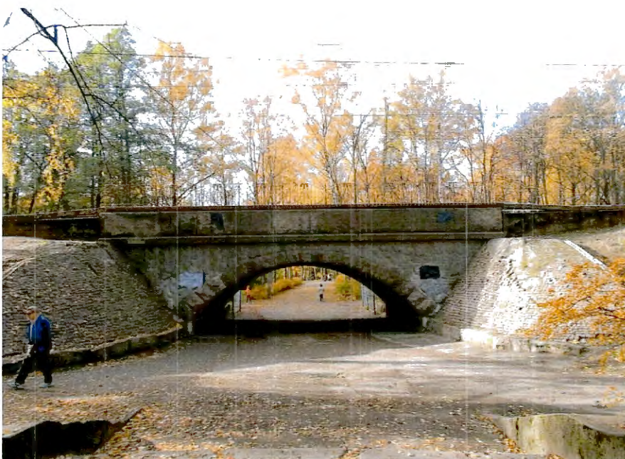
12. Железнодорожный мост в юго-восточной части парка.
