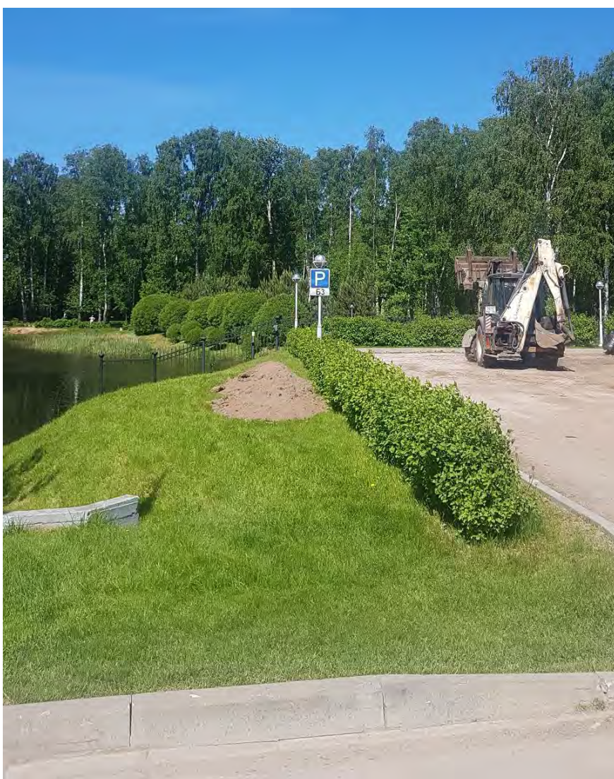
17. Территория проектирования в границах объекта культурного наследия регионального значения: «Удельный парк». Вид в северо-западном направлении. Территория Спортивной базы. Дата фотофиксации: 8 июня 2021г.
