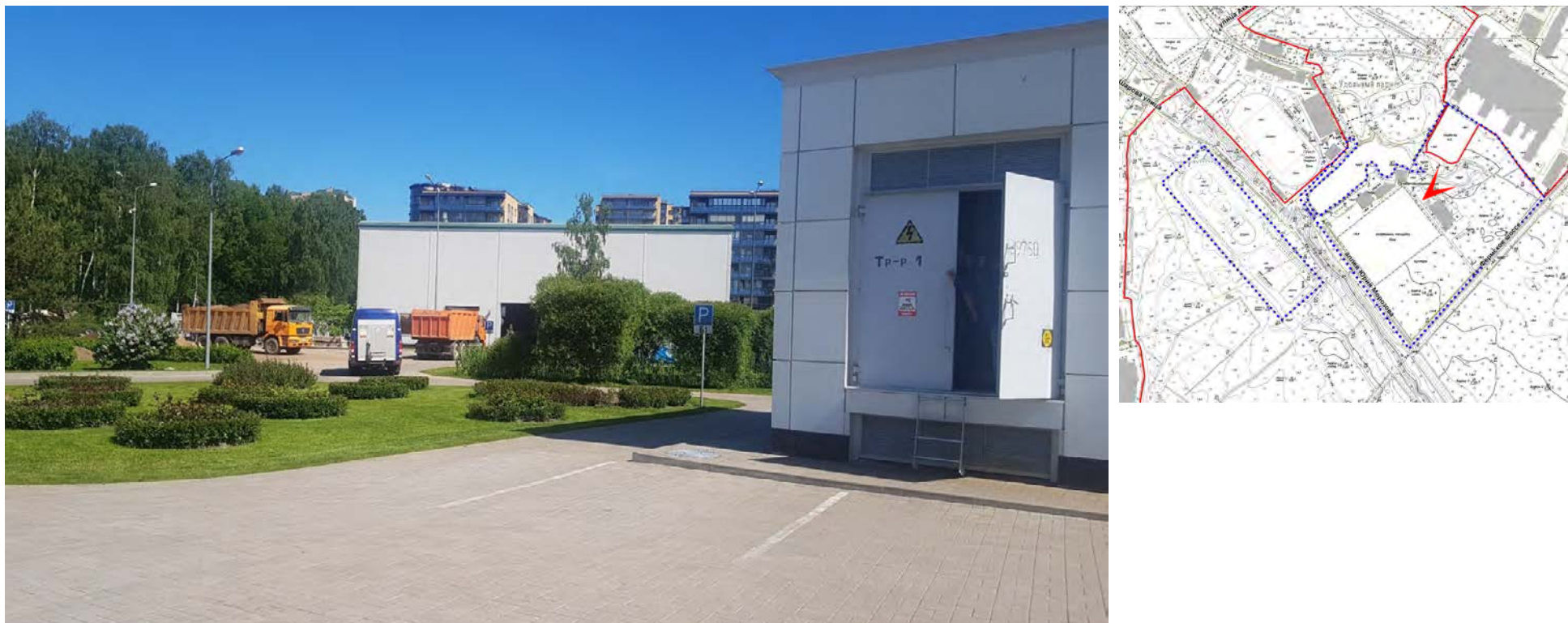
16. Территория проектирования в границах объекта культурного наследия регионального значения: «Удельный парк». Вид в северо-восточном направлении. Электростанция на территории Спортивной базы. Дата фотофиксации: 8 июня 2021г.
