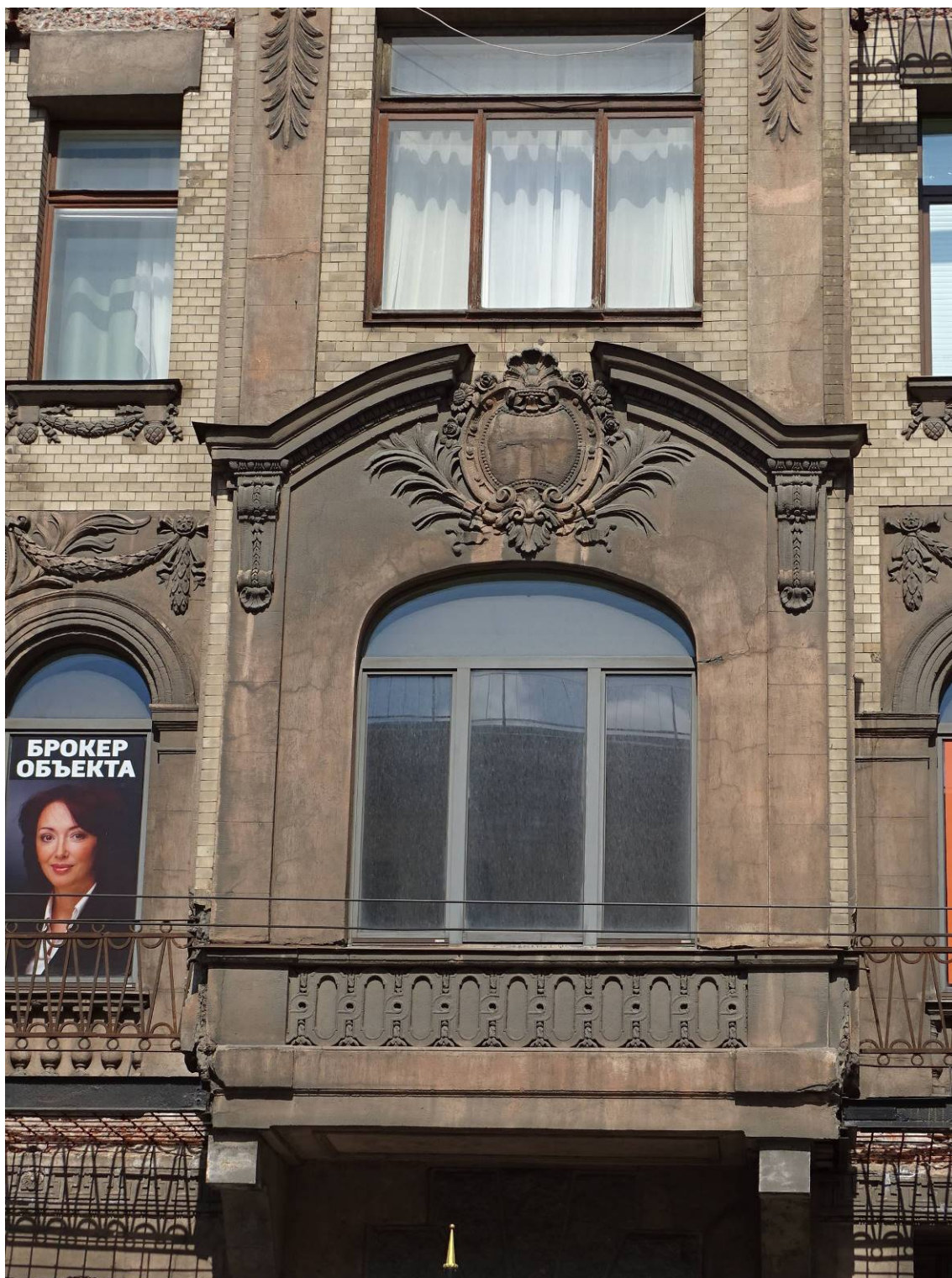
Фото 44. Здание по адресу: г. Санкт-Петербург, Кирочная ул., 22. Фрагмент лицевого фасада. Эркер. Оформление оконного проема в уровне 2-го этажа.
