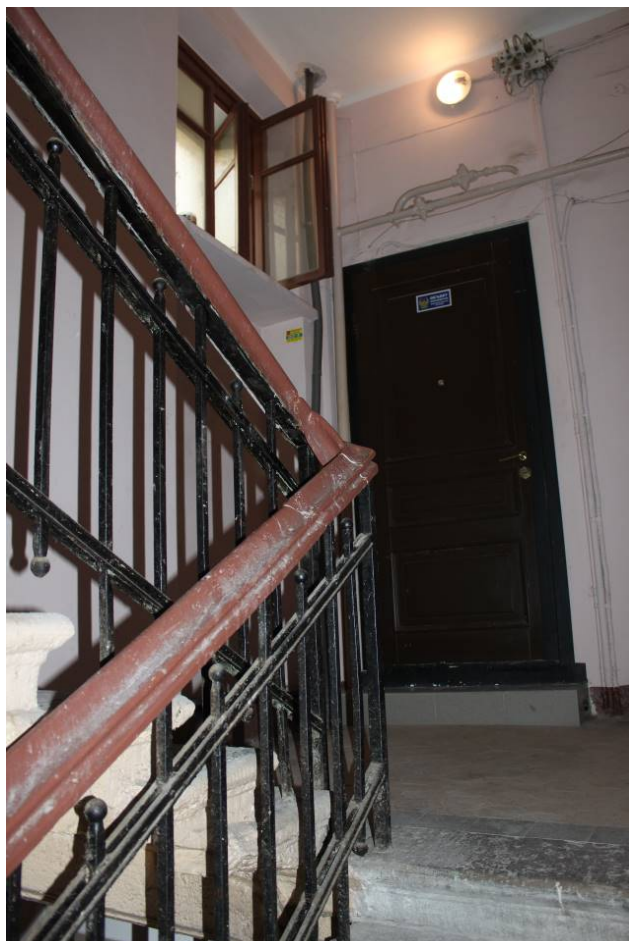
Фото 237. Лестница № 3: Площадка 4-го этажа. Съемка 26.04.2021 г. Трушковский В.Э.
