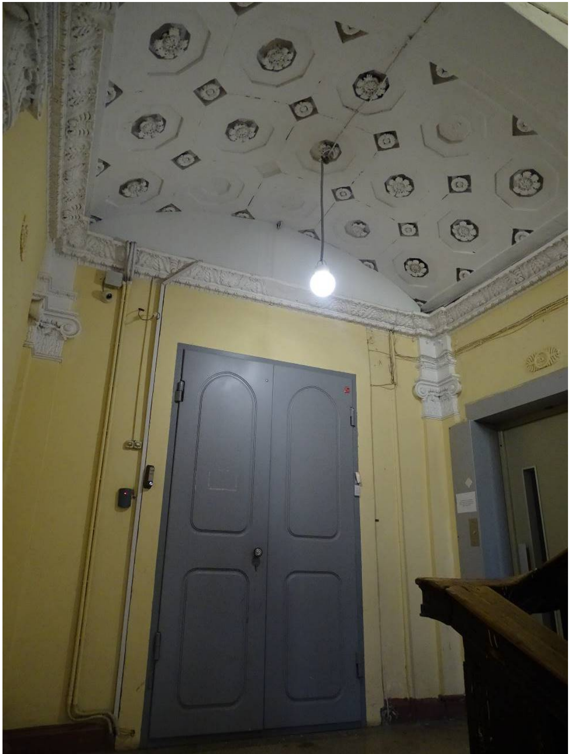
Фото 209. Лестница № 2: Площадка 4-го этажа. Съемка 26.04.2021 г. Трушковский В.Э.
