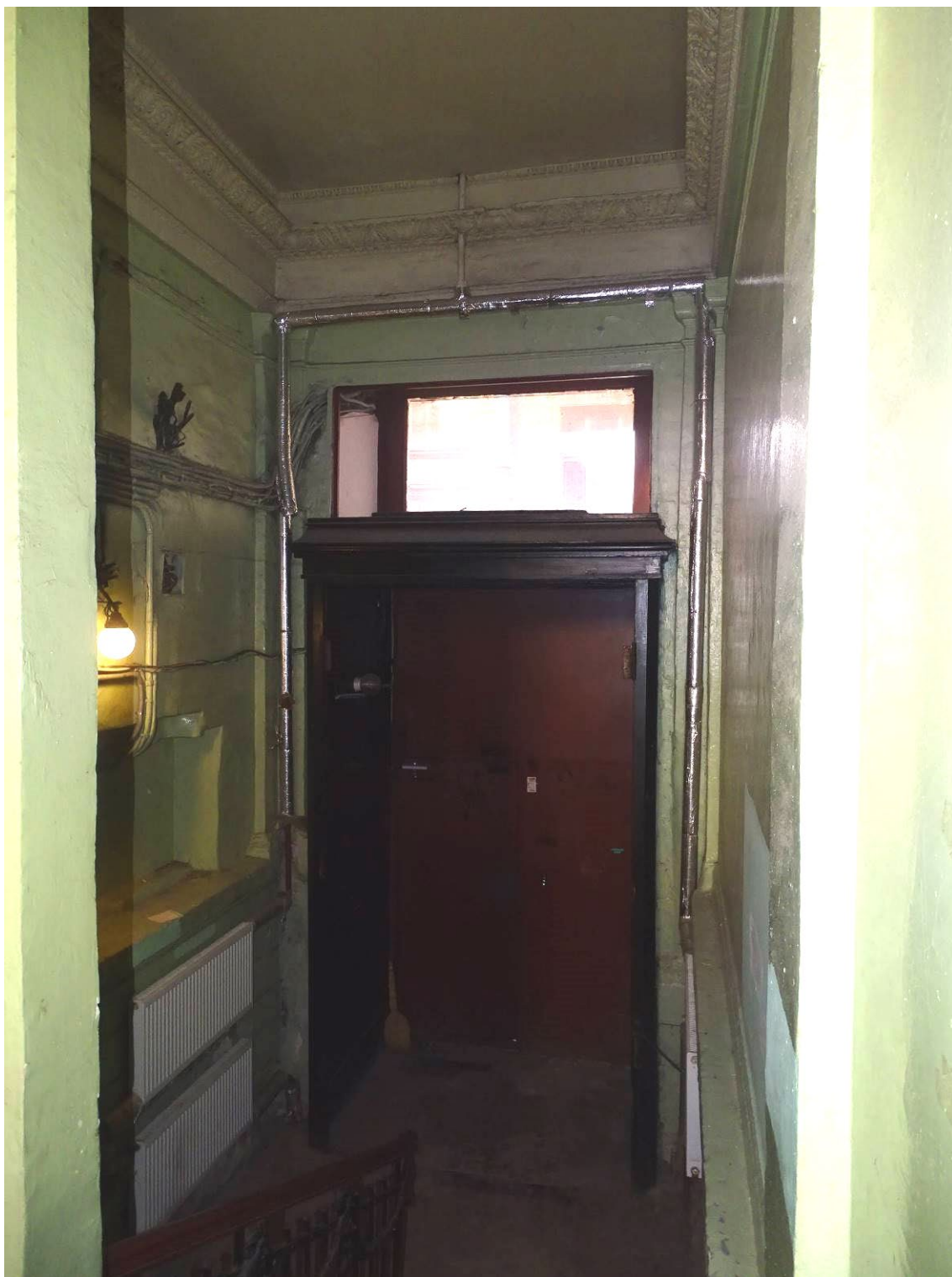
Фото 142. Лестница № 1: Вестибюль. 1-й этаж. Входная дверь. Съемка 26.04.2021 г. Трушковский В.Э.
