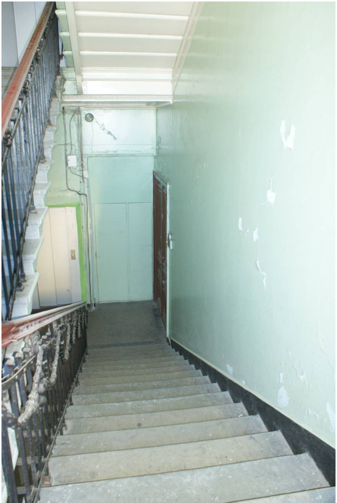
Фото 165. Лестница № 1: Площадка 4-го этажа. Съемка 26.04.2021 г. Трушковский В.Э.
