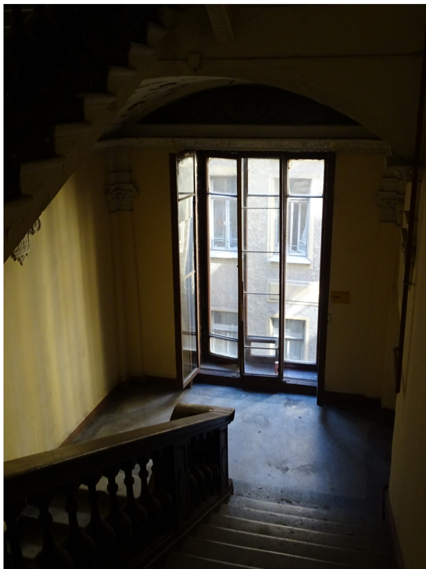
Фото 205. Лестница № 2: Площадка между 3-м и 4-м этажом. Съемка 26.04.2021 г. Трушковский В.Э.
