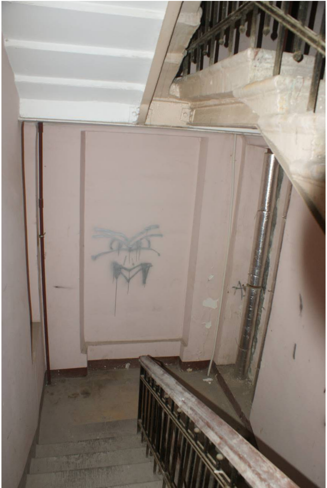
Фото 247. Лестница № 3: Площадка между 6-м и 7-м этажом. Съемка 26.04.2021 г. Трушковский В.Э.
