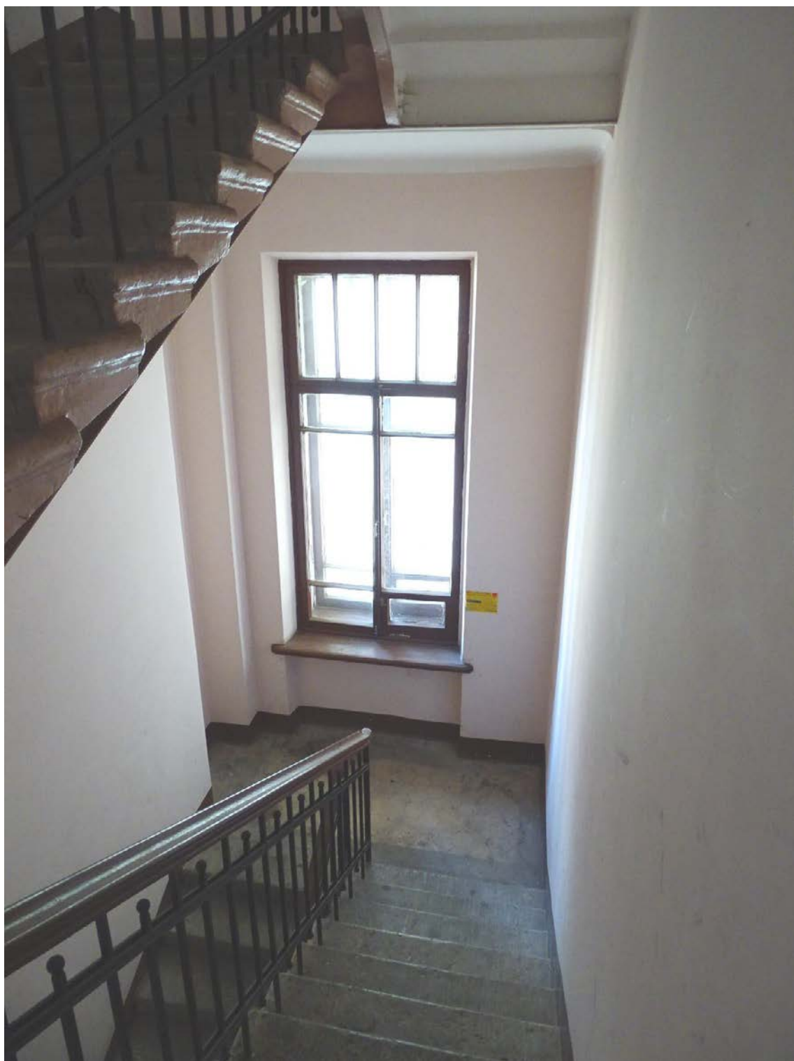
Фото 274. Лестница № 6: Площадка между 5-м и 6-м этажом. Съемка 26.04.2021 г. Трушковский В.Э.
