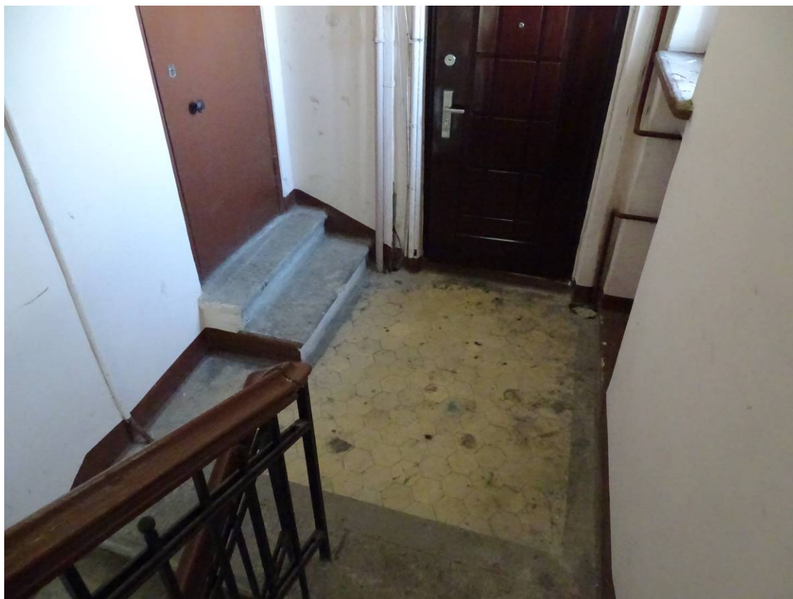
Фото 276. Лестница № 6: Площадка 6-го этажа. Покрытие пола. Съемка 26.04.2021 г. Трушковский В.Э.
