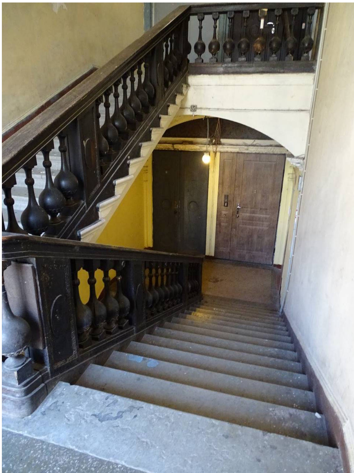
Фото 214. Лестница № 2: Площадка 5-го этажа. Съемка 26.04.2021 г. Трушковский В.Э.
