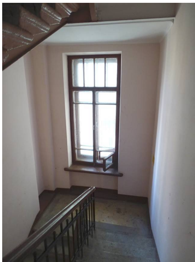
Фото 269. Лестница № 6: Площадка между 4-м и 5-м этажом. Съемка 26.04.2021 г. Трушковский В.Э.
