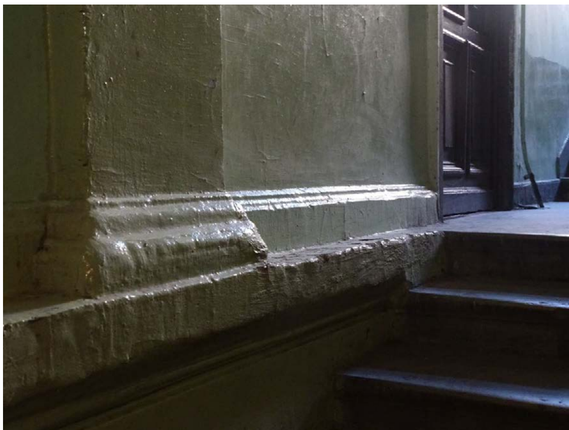
Фото 145. Лестница № 1: Вестибюль. 1-й этаж. Оформление стен. Съемка 26.04.2021 г. Трушковский В.Э.
