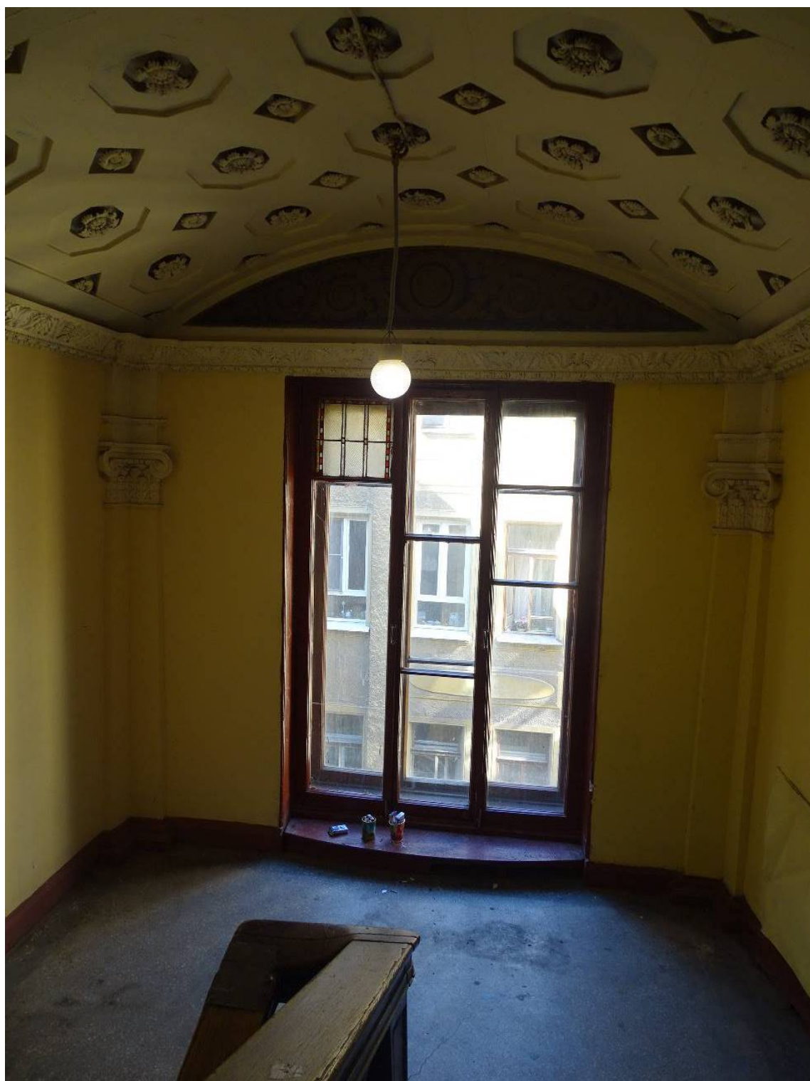
Фото 211. Лестница № 2: Площадка между 4-м и 5-м этажом. Съемка 26.04.2021 г. Трушковский В.Э.
