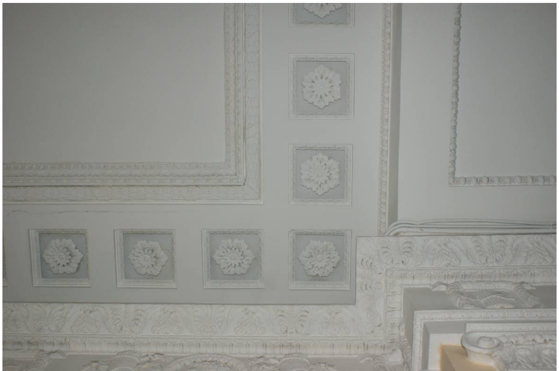
Фото 182. Лестница № 2: Вестибюль. Съемка 26.04.2021 г. Трушковский В.Э.
