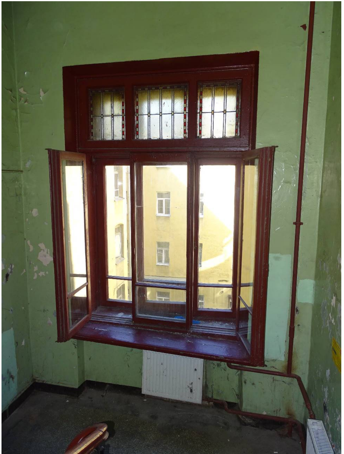
Фото 160. Лестница № 1: Площадка между 2-м и 3-м этажом. Оформление окна. Съемка 26.04.2021 г. Трушковский В.Э.
