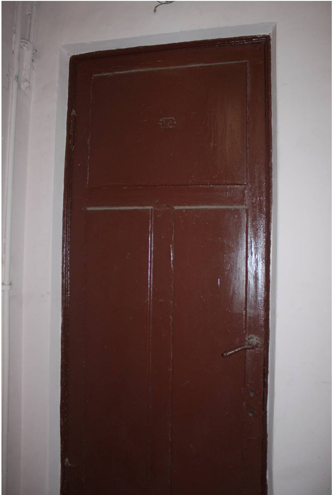
Фото 234. Лестница № 3: Площадка 3-го этажа. Оформление двери. Съемка 26.04.2021 г. Трушковский В.Э.
