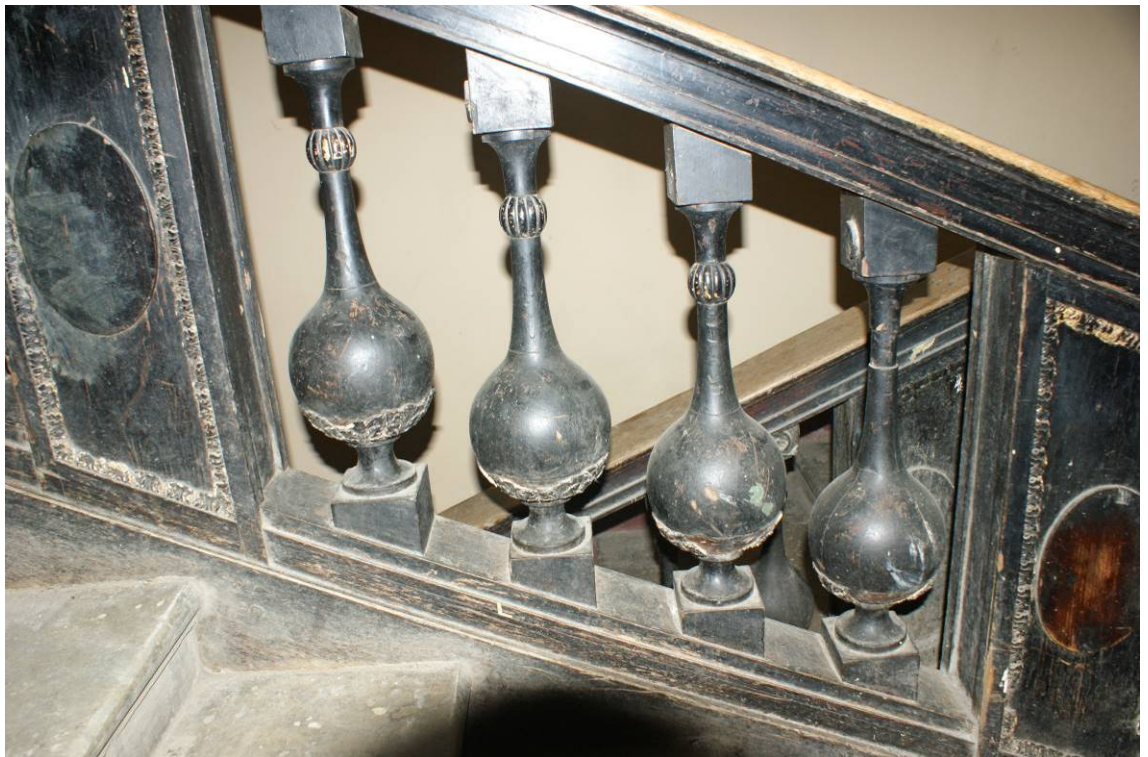
Фото 191. Лестница № 2: Фрагмент лестничного ограждения. Съемка 26.04.2021 г. Трушковский В.Э.
