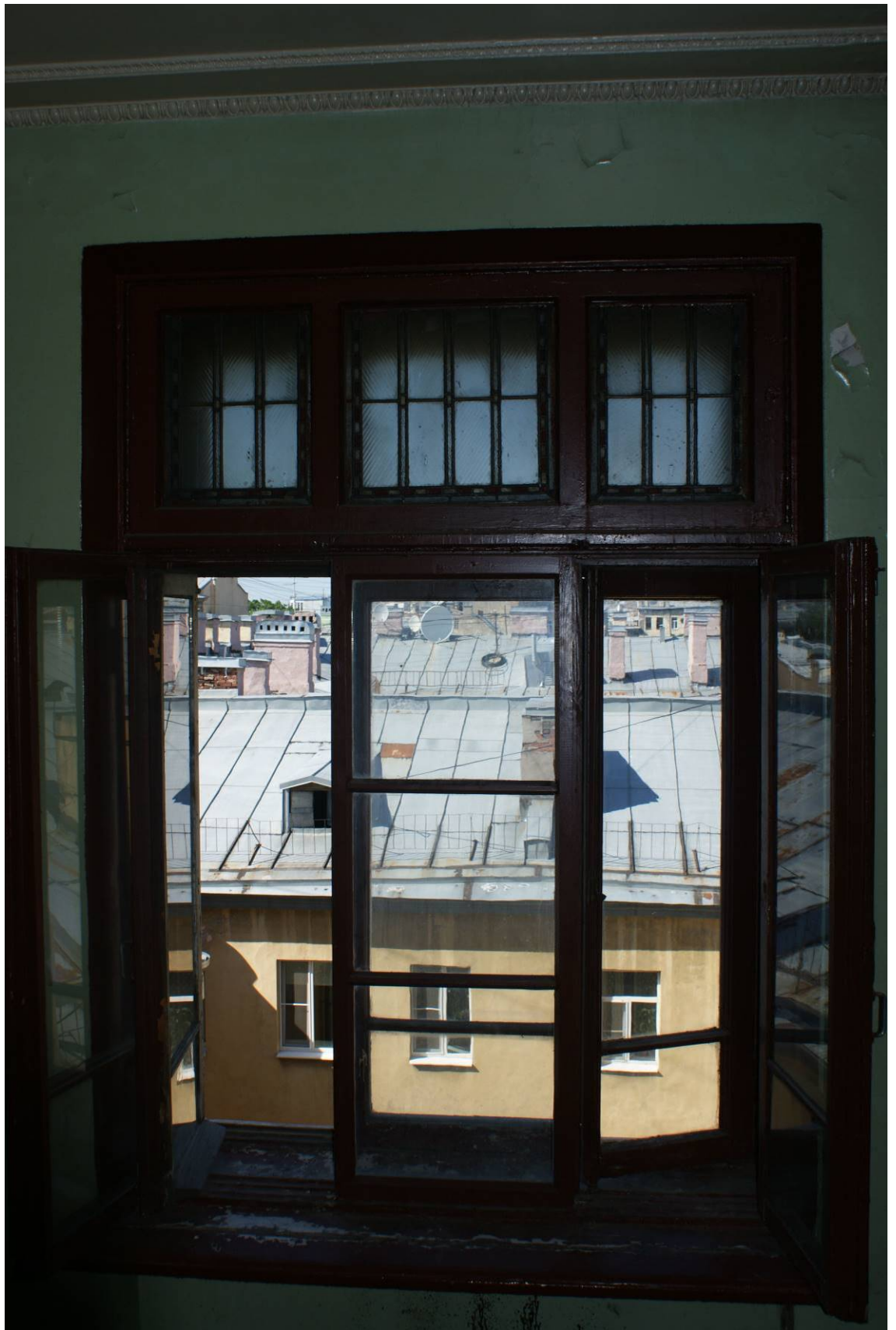
Фото 167. Лестница № 1: Площадка между 4-м и 5-м этажом. Съемка 26.04.2021 г. Трушковский В.Э.
