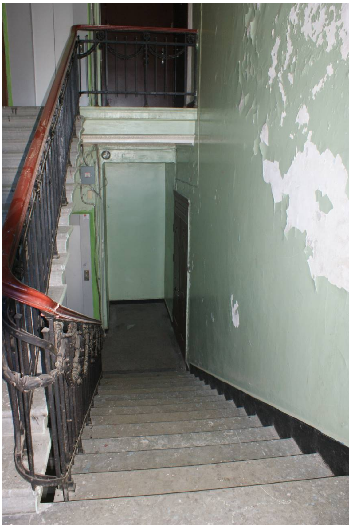
Фото 168. Лестница № 1: Площадка 5-го этажа. Съемка 26.04.2021 г. Трушковский В.Э.
