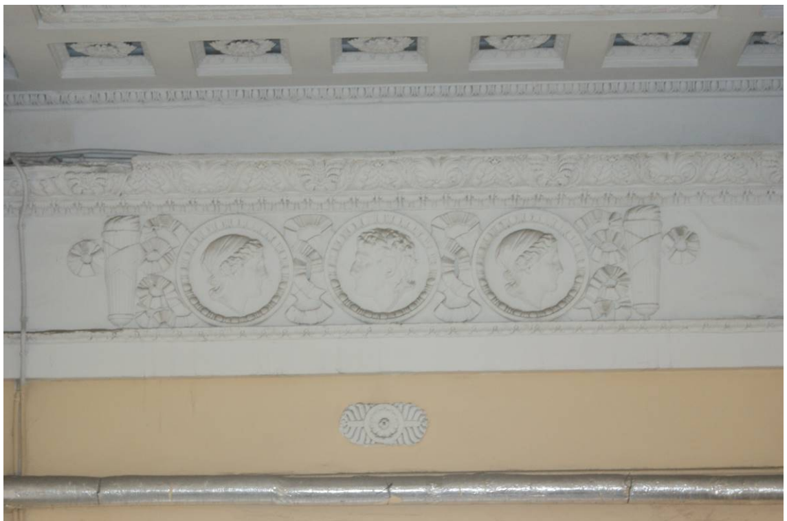
Фото 183. Лестница № 2: Вестибюль. 1-й этаж. Оформление стен. Съемка 26.04.2021 г. Трушковский В.Э.
