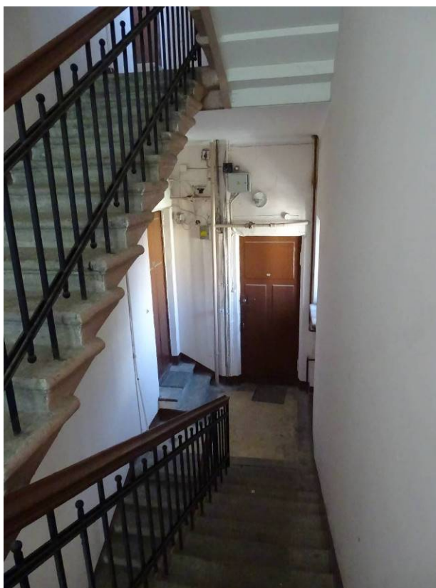
Фото 271. Лестница № 6: Площадка 5-го этажа. Съемка 26.04.2021 г. Трушковский В.Э.
