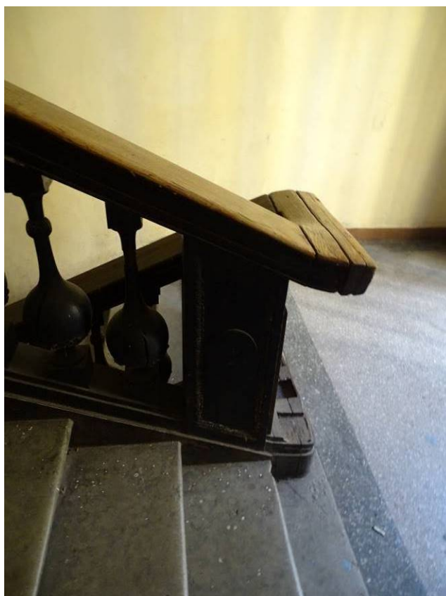
Фото 206. Лестница № 2: Площадка между 3-м и 4-м этажом. Съемка 26.04.2021 г. Трушковский В.Э.
