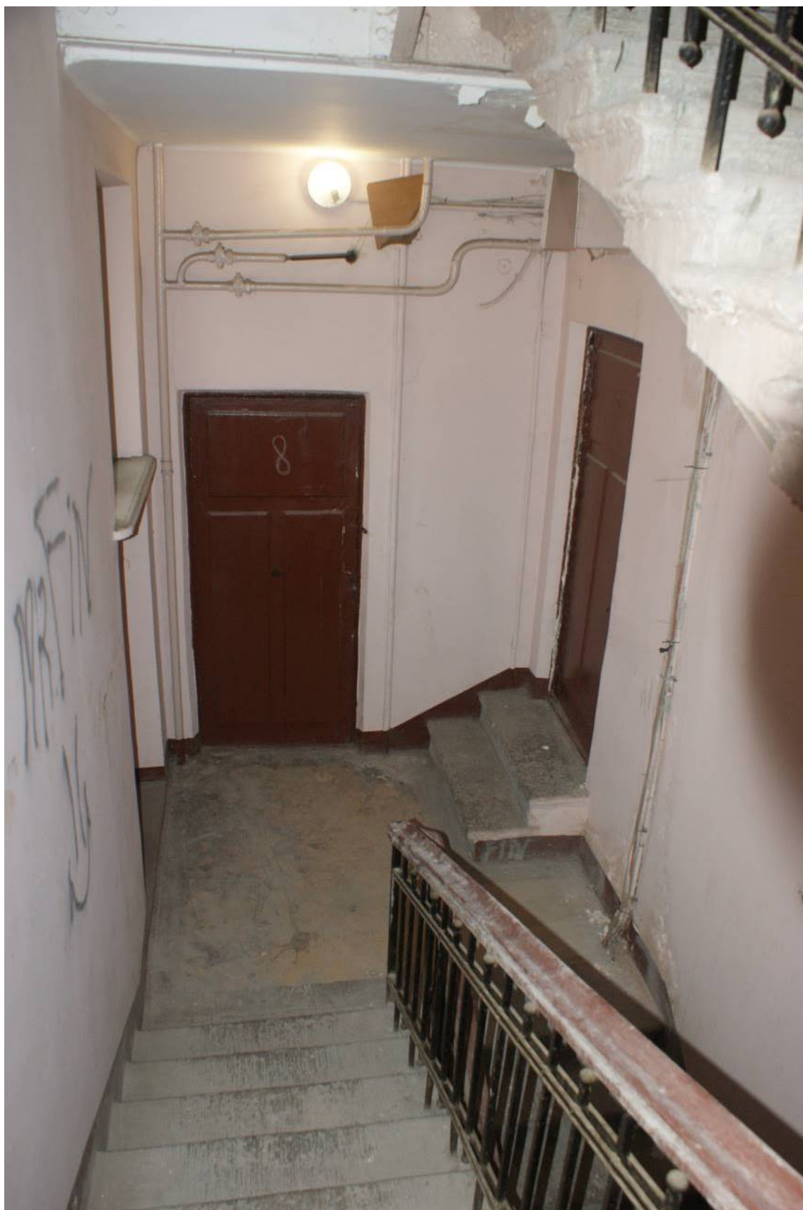
Фото 244. Лестница № 3: Площадка 6-го этажа. Съёмка 26.04.2021 г. Трушковский В.Э.
