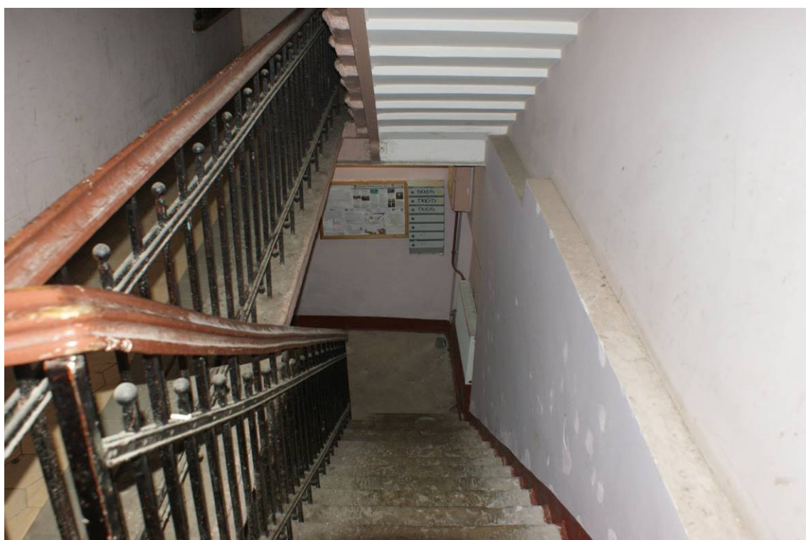
Фото 254. Лестница № 6: 1-й этаж. Съемка 26.04.2021 г. Трушковский В.Э.
