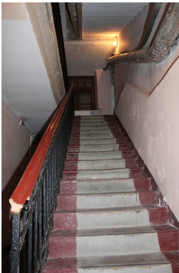
Фото 224. Лестница № 3: Лестничный марш на площадку 2-го этажа. Съемка 26.04.2021 г. Трушковский В.Э.
