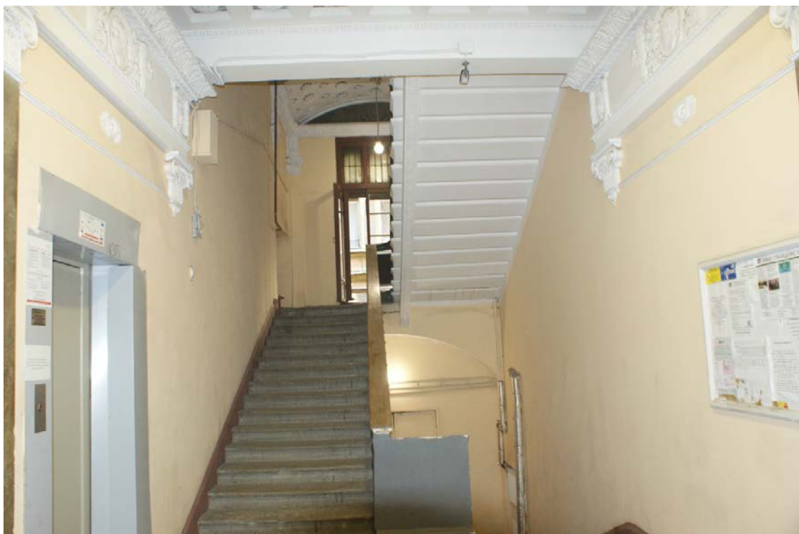
Фото 188. Лестница № 2: Площадка 1-го этажа. Съемка 26.04.2021 г. Трушковский В.Э.
