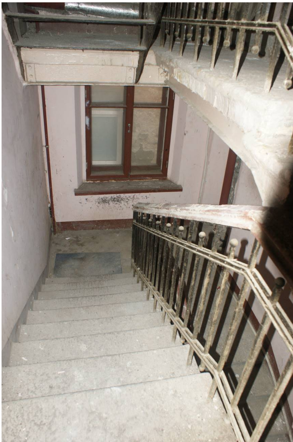
Фото 250. Лестница № 3: Площадка между 7-м и техническим этажом.
