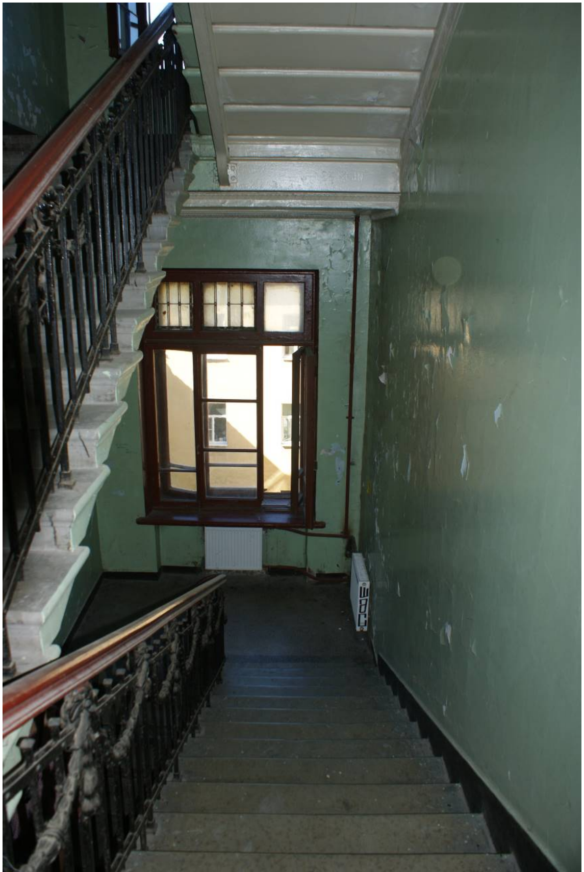
Фото 163. Лестница № 1: Площадка между 3-м и 4-м этажом. Съемка 26.04.2021 г. Трушковский В.Э.
