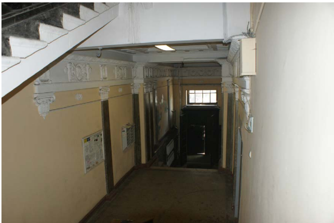
Фото 185. Лестница № 2: Площадка 1-го этажа. Съемка 26.04.2021 г. Трушковский В.Э.
