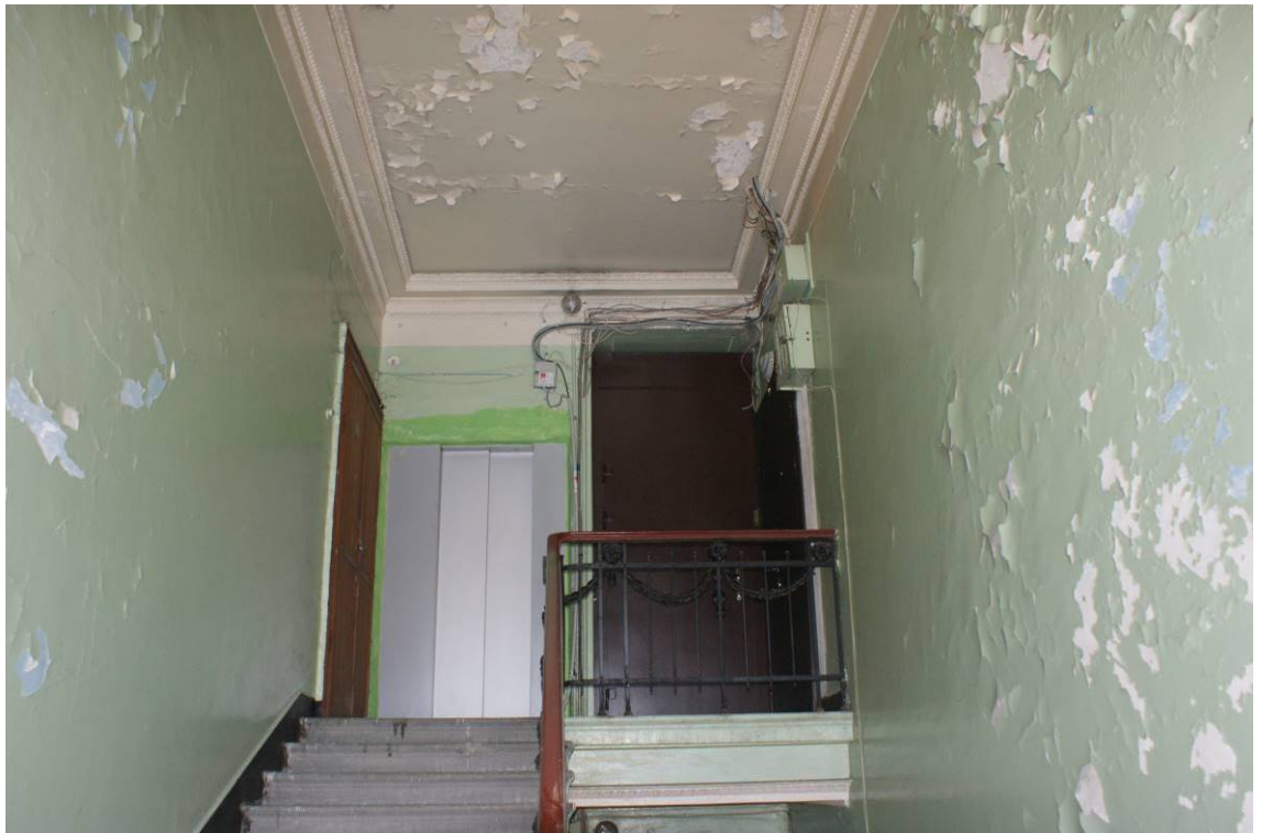
Фото 173. Лестница № 1: Площадка 6-го этажа. Съемка 26.04.2021 г. Трушковский В.Э.
