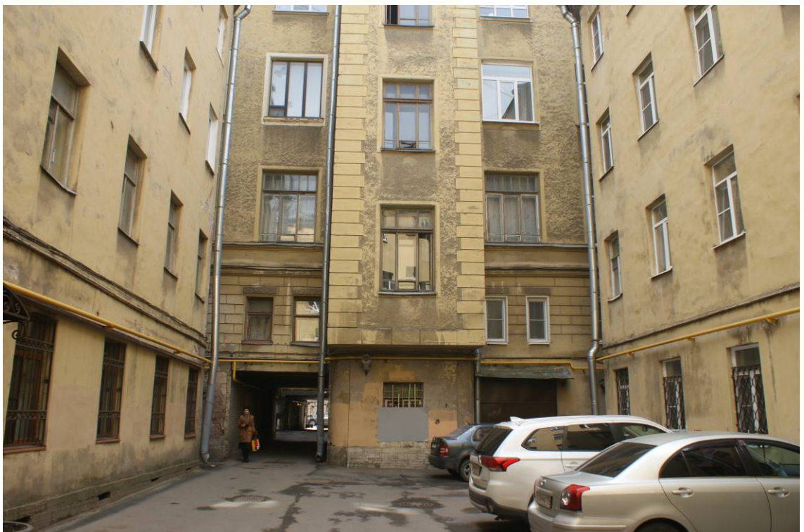
Фото 68. Здание по адресу: г. Санкт-Петербург, Кирочная ул., 22. Фрагмент южного фасада северного внутреннего двора. 1-й, 2-й, 3-й, 4-й этажи. Съемка 26.04.2021 г. Трушковский В.Э.
