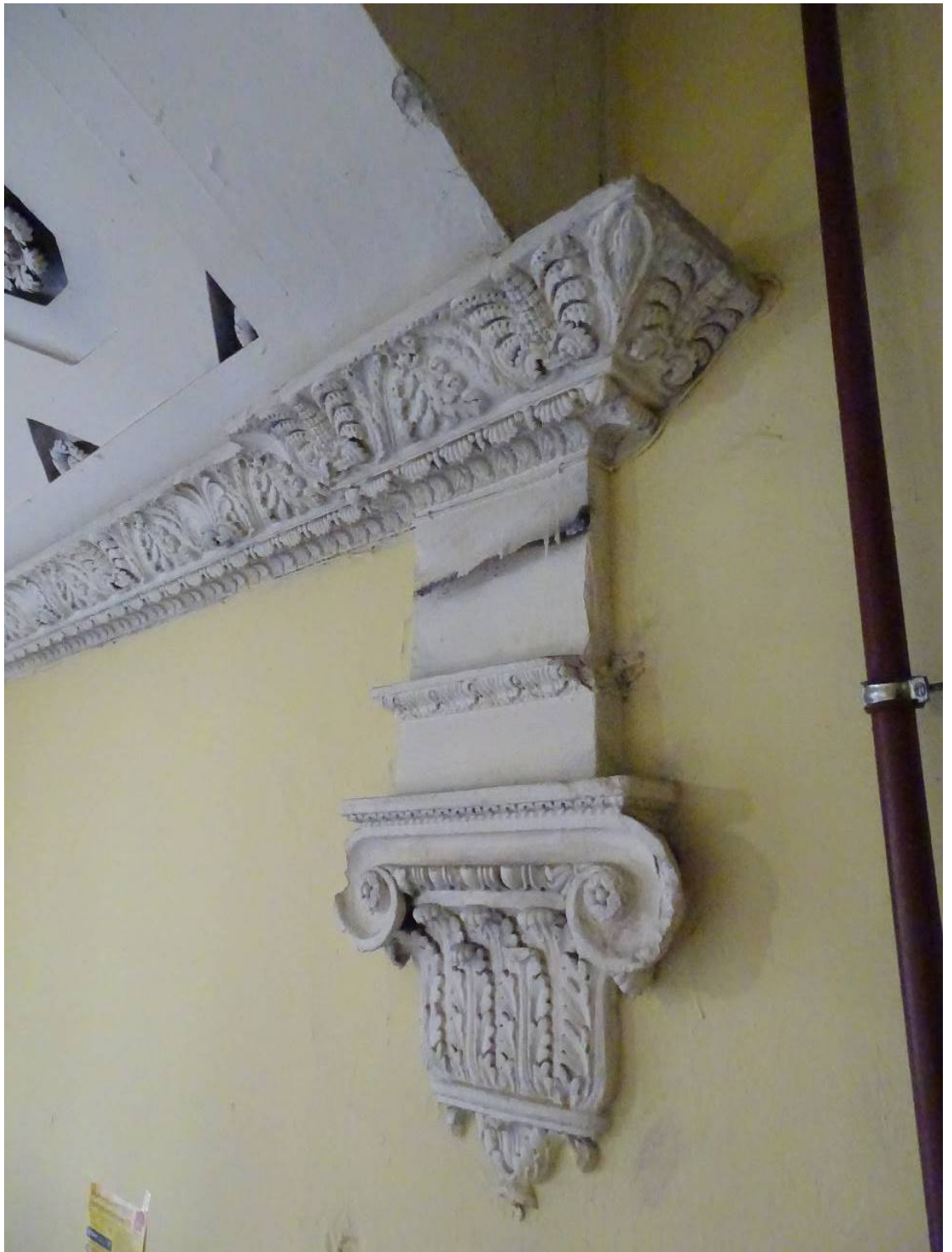
Фото 212. Лестница № 2: Площадка между 4-м и 5-м этажом. Декоративное оформление стен. Фрагмент. Съемка 26.04.2021 г. Трушковский В.Э.
