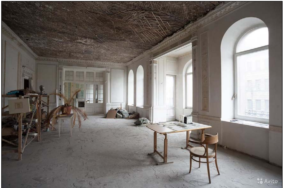
19. Интерьер квартиры А. П. Мещерского: парадный зал (после пожара на верхних этажах пострадал потолок). Фото из открытых источников.
