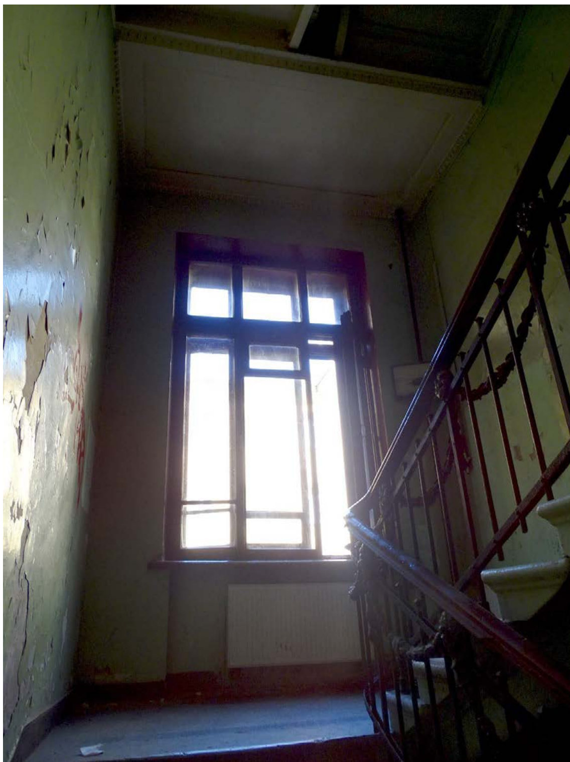
Фото 157. Лестница № 1: Площадка между 1-м и 2-м этажом. Съемка 26.04.2021 г. Трушковский В.Э.
