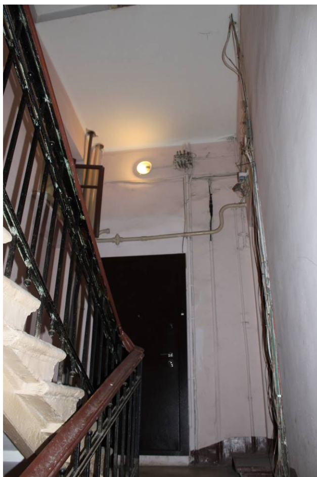
Фото 232. Лестница № 3: Площадка 3-го этажа. Съемка 26.04.2021 г. Трушковский В.Э.
