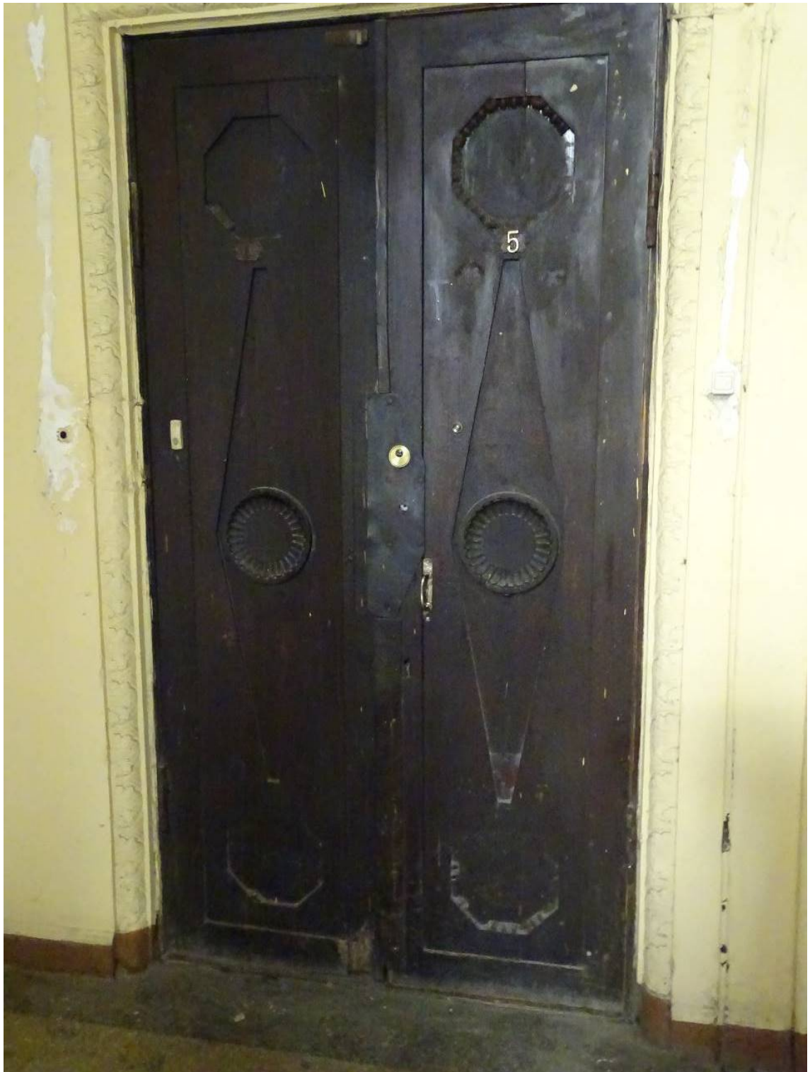
Фото 202. Лестница № 2: Площадка 3-го этажа. Оформление двери. Съемка 26.04.2021 г. Трушковский В.Э.
