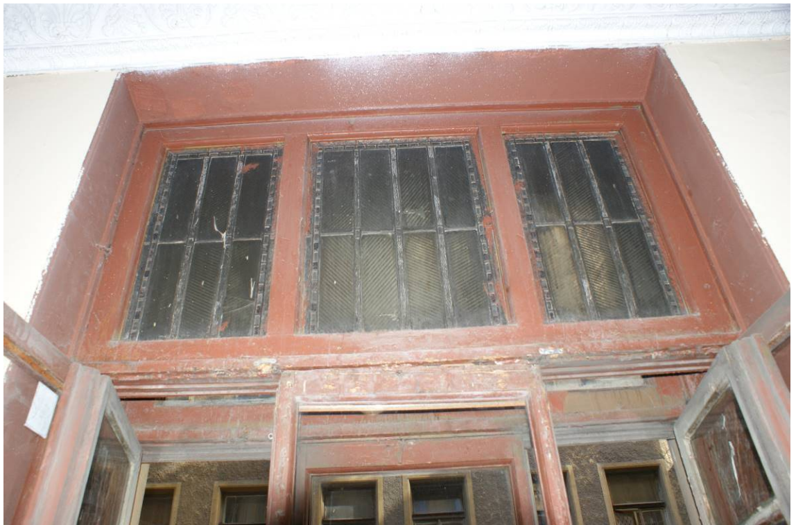
Фото 193. Лестница № 2: Площадка между 1-м и 2-м этажом. Оформление окна. Съемка 26.04.2021 г. Трушковский В.Э.
