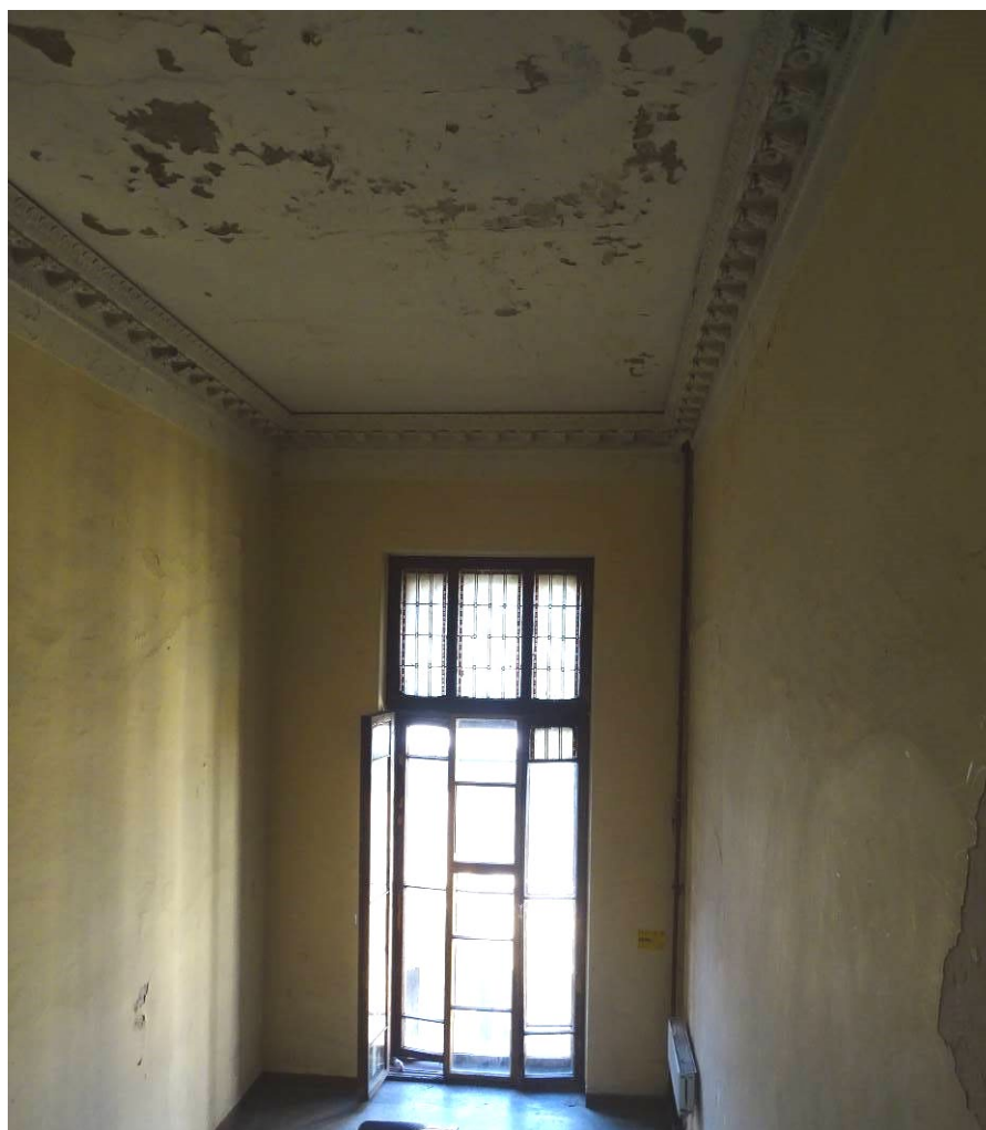
Фото 217. Лестница № 2: Площадка между 5-м и 6-м этажом. Съемка 26.04.2021 г. Трушковский В.Э.
