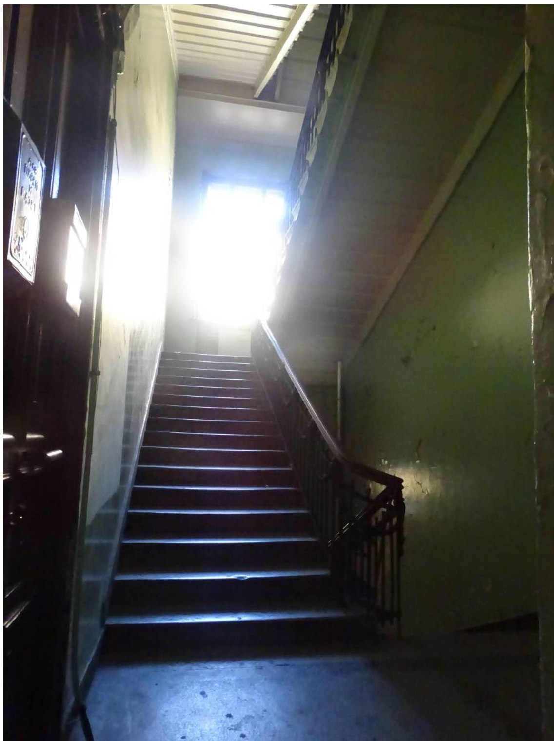
Фото 148. Лестница № 1: Площадка 1-го этажа. Съемка 26.04.2021 г. Трушковский В.Э.
