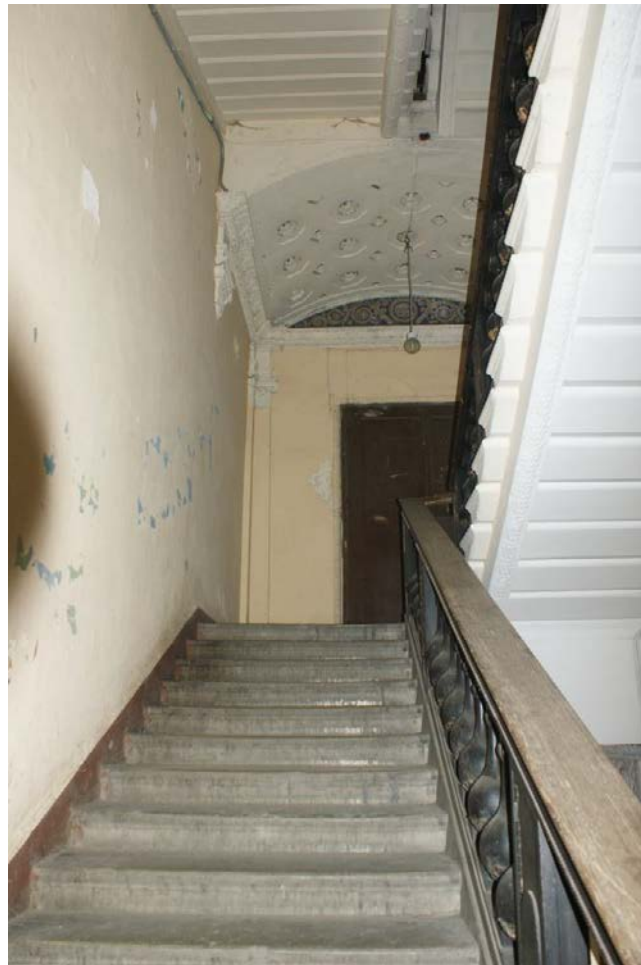
Фото 195. Лестница № 2: Площадка 2-го этажа. Съемка 26.04.2021 г. Трушковский В.Э.
