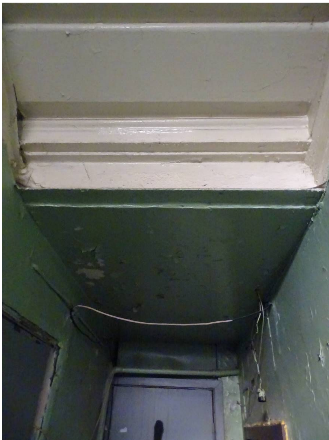
Фото 150. Лестница № 1: Площадка подвального этажа. 1-й этаж. Съемка 26.04.2021 г. Трушковский В.Э.
