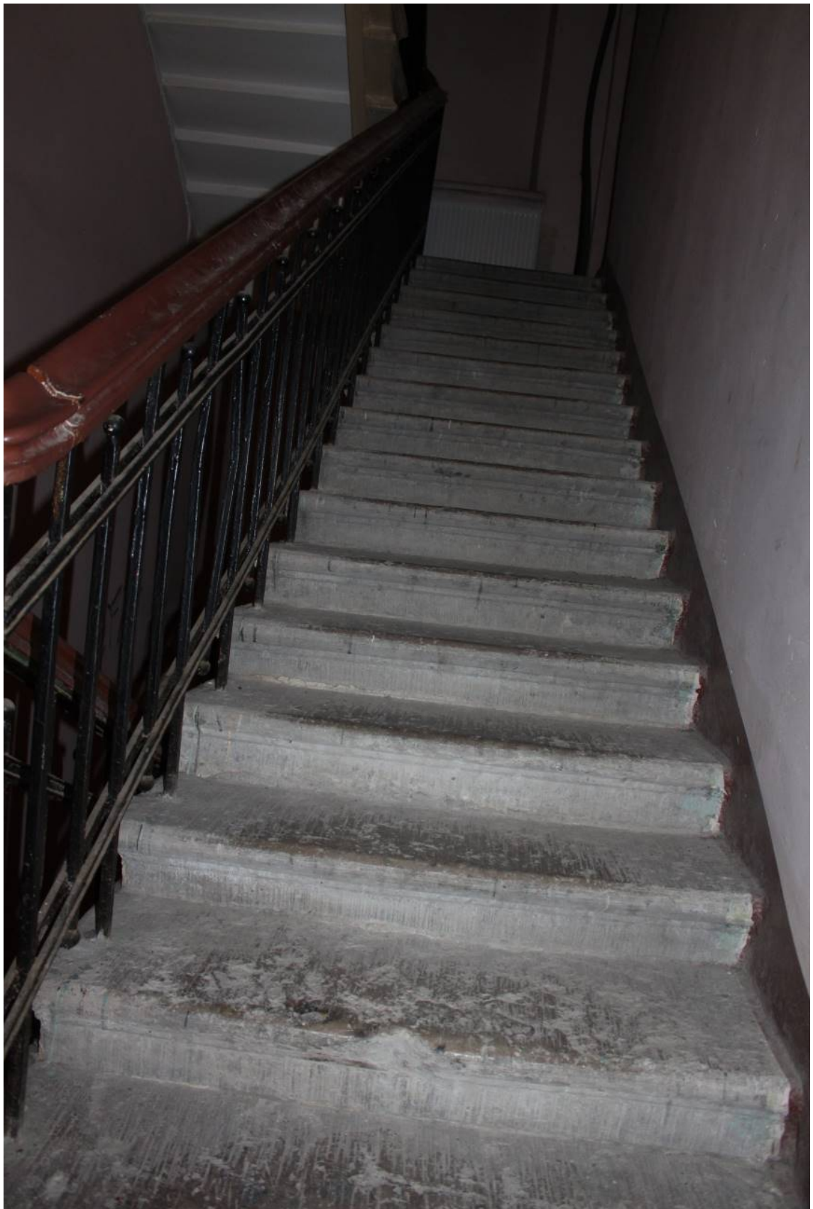
Фото 236. Лестница № 3: Лестничный марш на площадку между 3-м и 4-м этажом. Съемка 26.04.2021 г. Трушковский В.Э.
