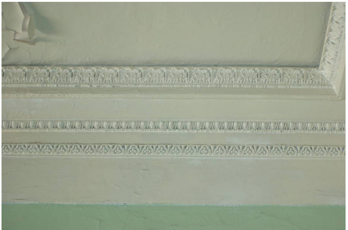
Фото 174. Лестница № 1: Площадка 6-го этажа. Оформление потолка. Съемка 26.04.2021 г. Трушковский В.Э.
