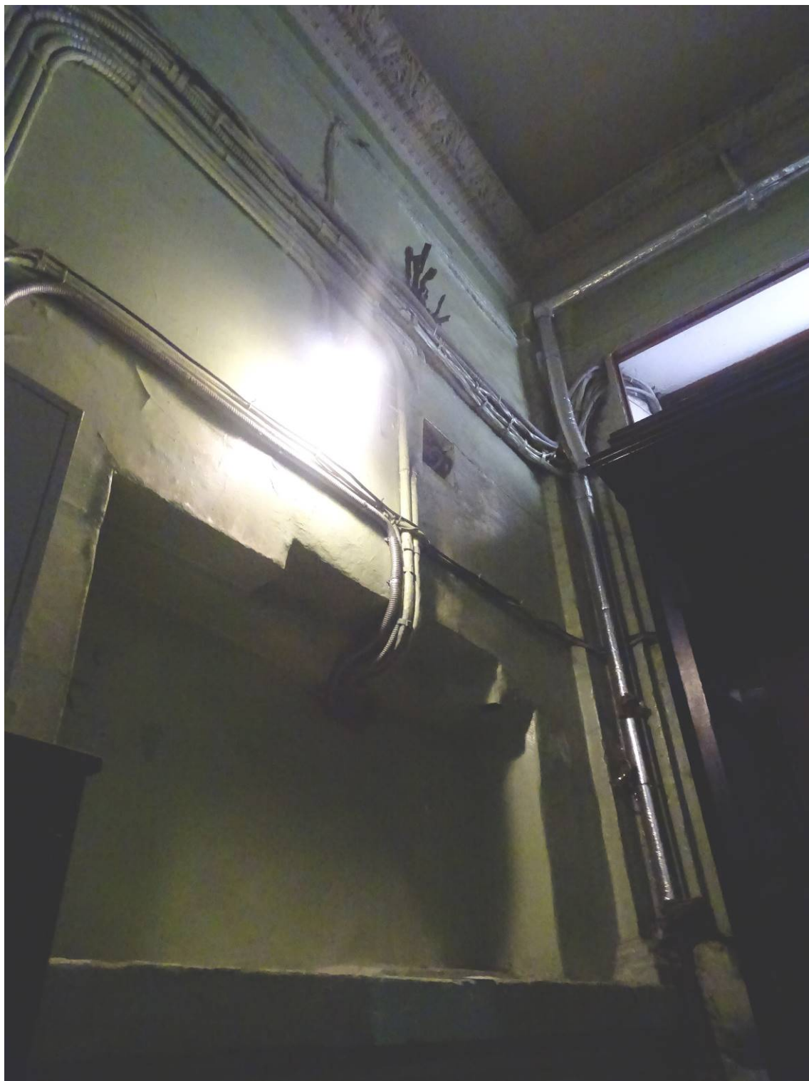
Фото 143. Лестница № 1: Вестибюль. 1-й этаж. Ниша в стене. Съемка 26.04.2021 г. Трушковский В.Э.
