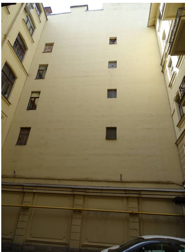
Фото 73. Здание по адресу: г. Санкт-Петербург, Кирочная ул., 22. Восточный дворовой фасад со стороны внутреннего двора дома 24 по ул. Кирочная. Съемка 26.04.2021 г. Трушковский В.Э.
