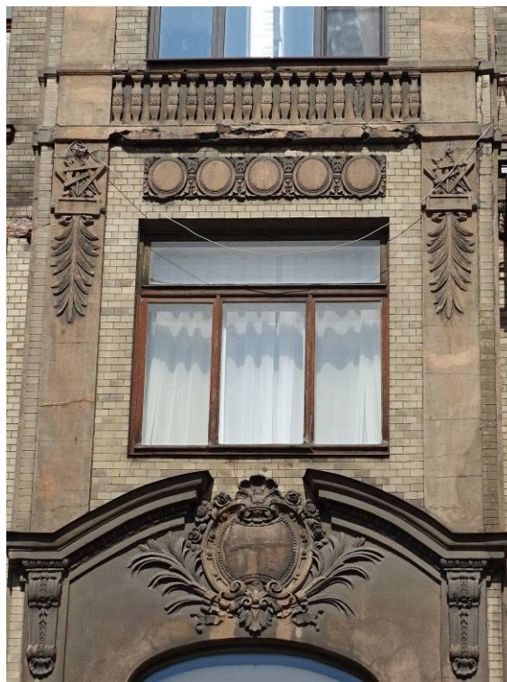
Фото 43. Здание по адресу: г. Санкт-Петербург, Кирочная ул., 22. Фрагмент лицевого фасада. Эркер. Оформление оконного проема в уровне 3-го этажа. Съемка 26.04.2021 г. Трушковский В.Э.
