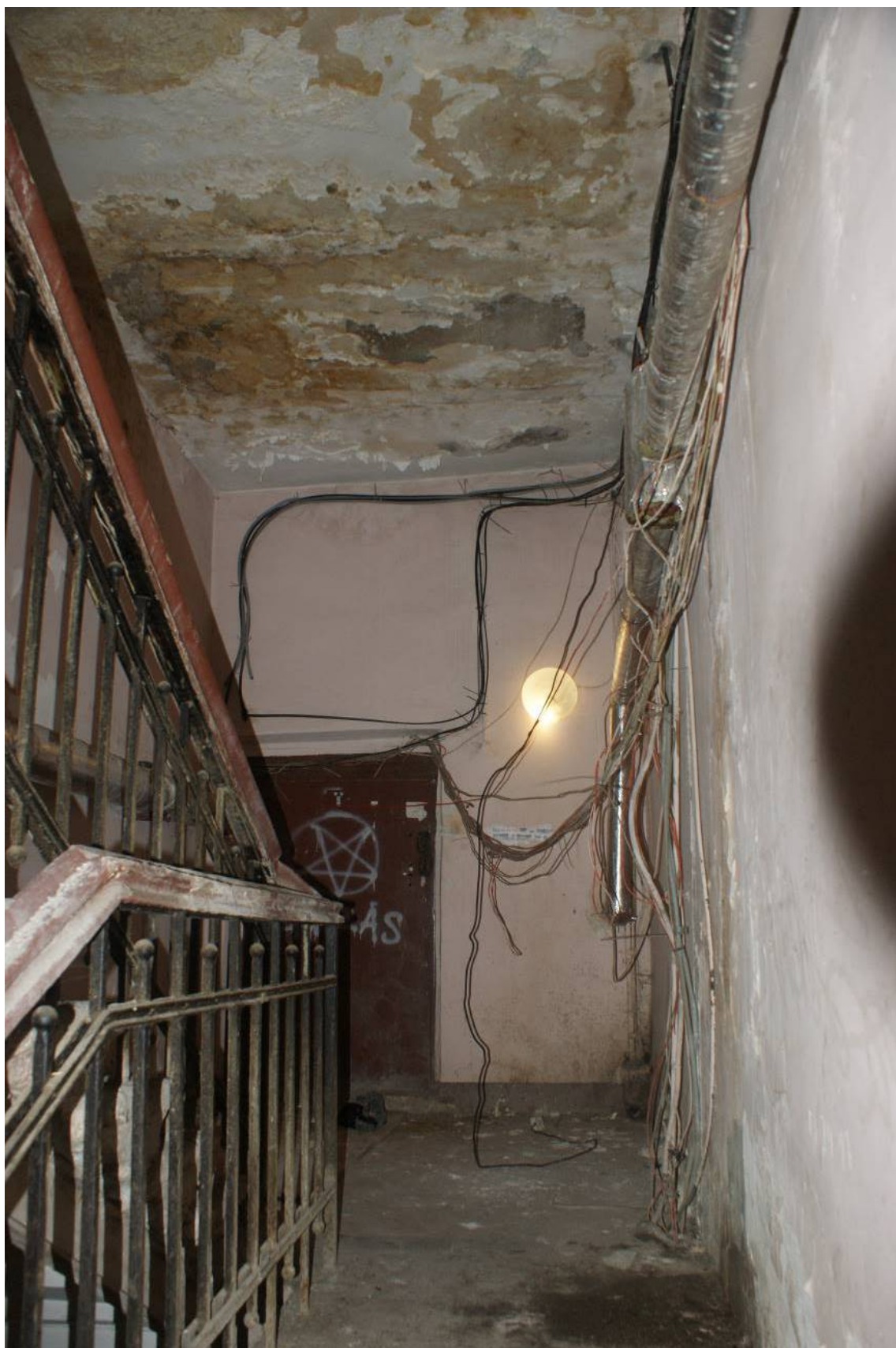
Фото 251. Лестница № 3: Площадка технического этажа. Съемка 26.04.2021 г. Трушковский В.Э.
