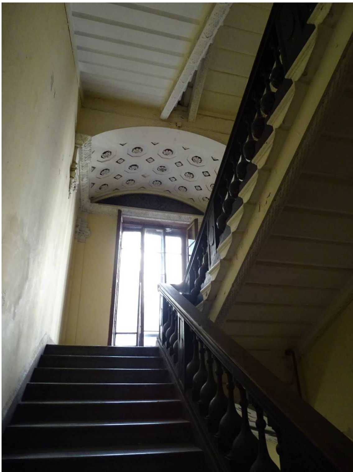
Фото 204. Лестница № 2: Площадка между 3-м и 4-м этажом. Съемка 26.04.2021 г. Трушковский В.Э.
