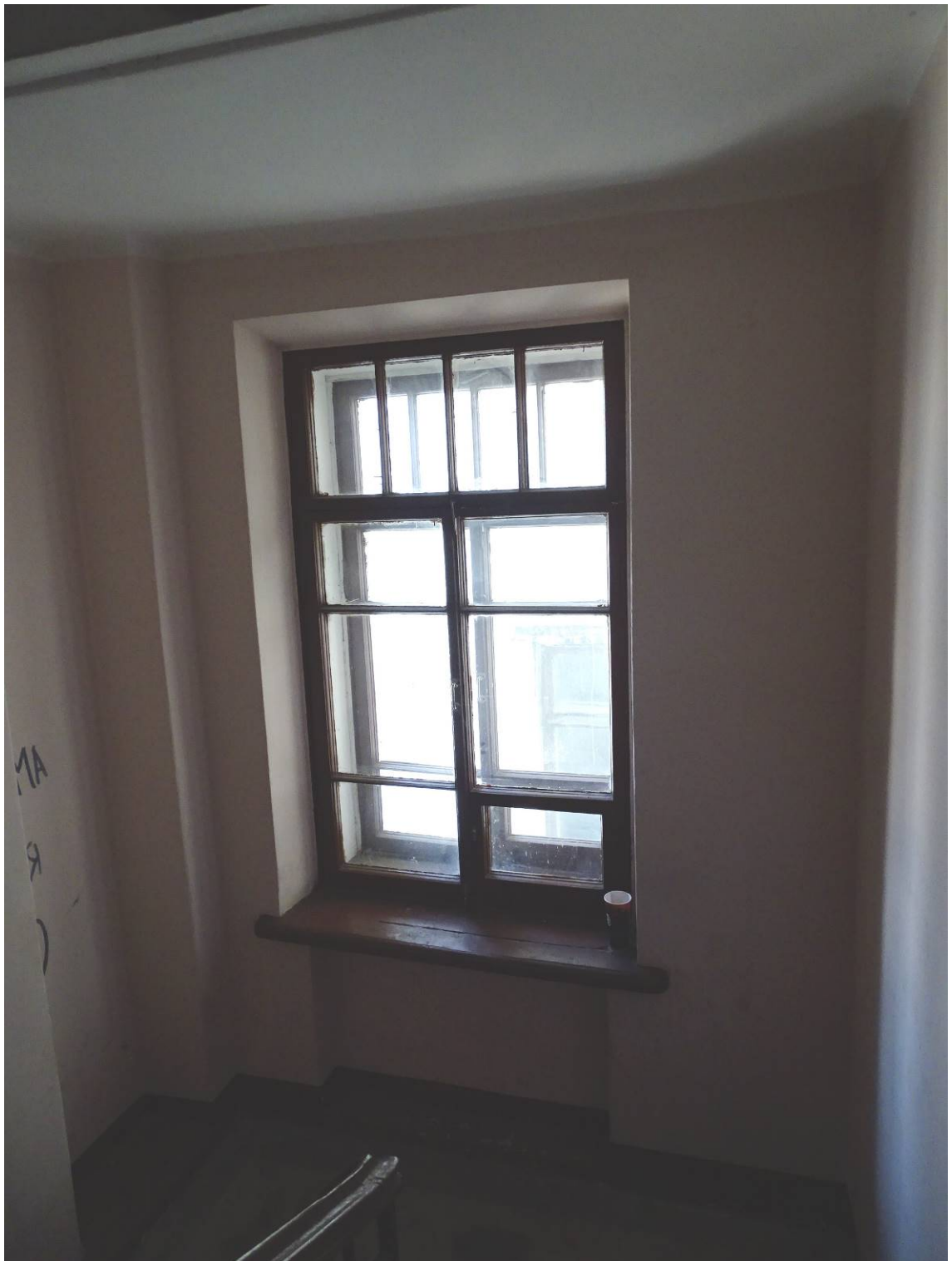
Фото 278. Лестница № 6: Площадка между 6-м и 7-м этажом. Съемка 26.04.2021 г. Трушковский В.Э.
