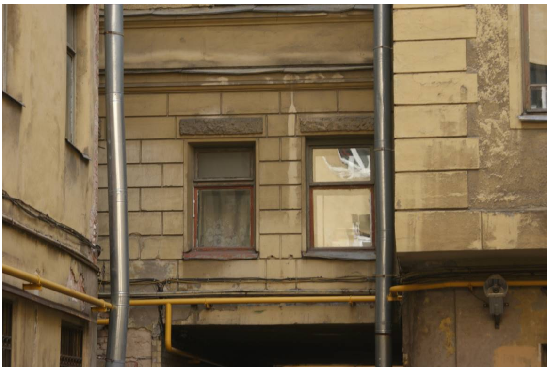
Фото 69. Здание по адресу: г. Санкт-Петербург, Кирочная ул., 22. Фрагмент южного фасада северного внутреннего двора. 2-й этаж. Съемка 26.04.2021 г. Трушковский В.Э.
