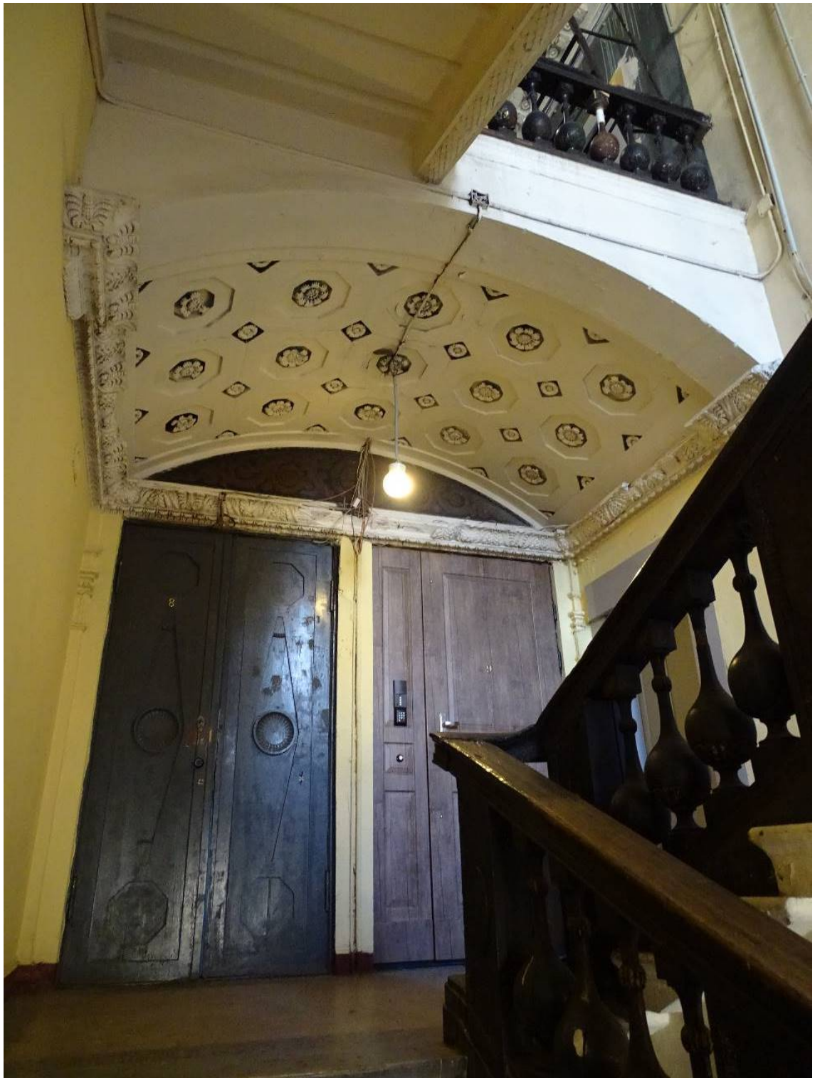
Фото 215. Лестница № 2: Площадка 5-го этажа. Съемка 26.04.2021 г. Трушковский В.Э.
