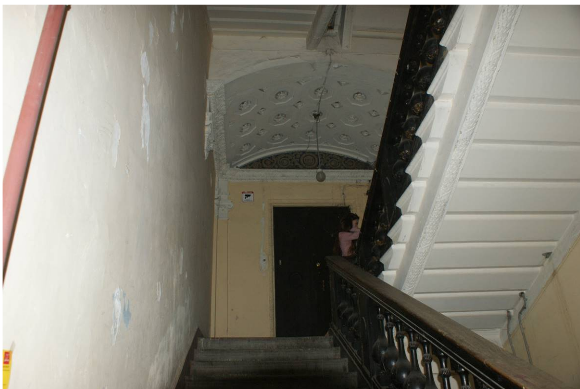
Фото 201. Лестница № 2: Площадка 3-го этажа. Съемка 26.04.2021 г. Трушковский В.Э.
