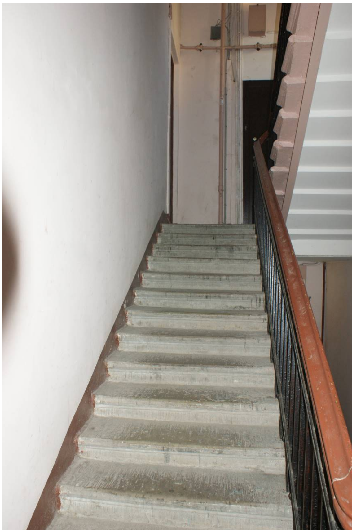
Фото 260. Лестница № 6: Лестничный марш на площадку 3-го этажа.
