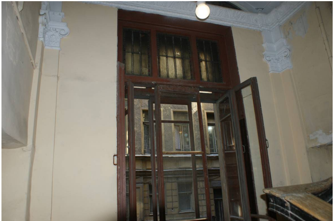
Фото 192. Лестница № 2: Площадка между 1-м и 2-м этажом. Оформление окна. Съемка 26.04.2021 г. Трушковский В.Э.
