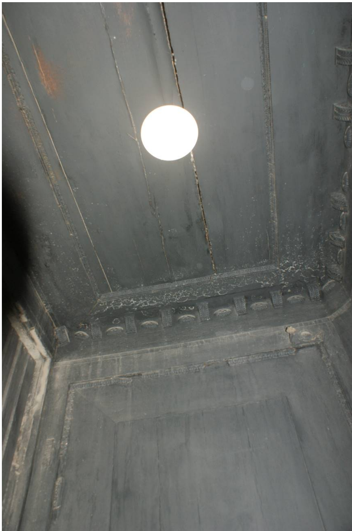
Фото 177. Лестница № 2: 1 этаж. Тамбур. Оформление потолка и стен. Съемка 26.04.2021 г. Трушковский В.Э.
