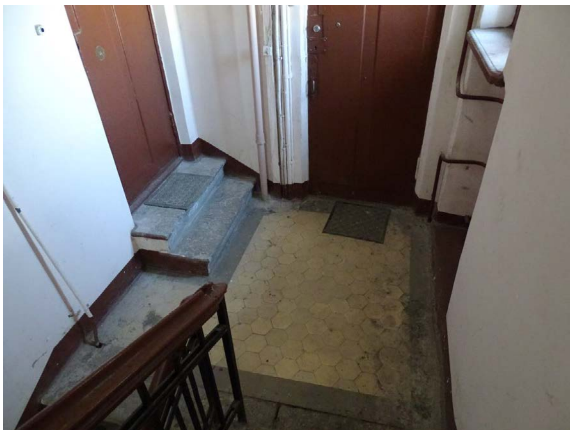
Фото 272. Лестница № 6: Площадка 5-го этажа. Покрытие пола. Съемка 26.04.2021 г. Трушковский В.Э.
