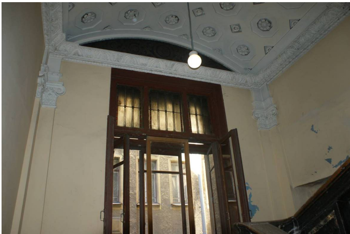
Фото 200. Лестница № 2: Площадка между 2-м и 3-м этажом. Съемка 26.04.2021 г. Трушковский В.Э.
