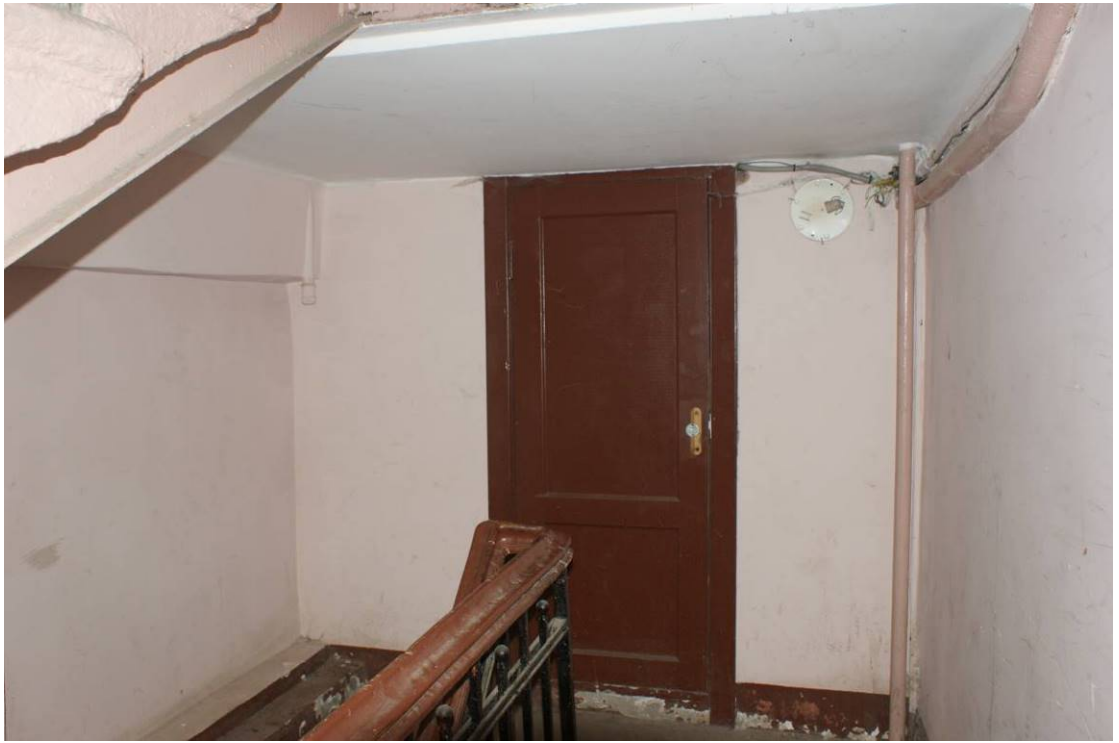
Фото 255. Лестница № 6: Площадка 2-го этажа. Съемка 26.04.2021 г. Трушковский В.Э.
