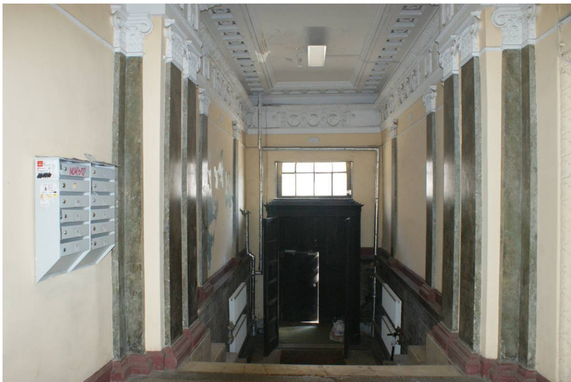
Фото 175. Лестница № 2: Вестибюль. Входная дверь. Съемка 26.04.2021 г. Трушковский В.Э.
