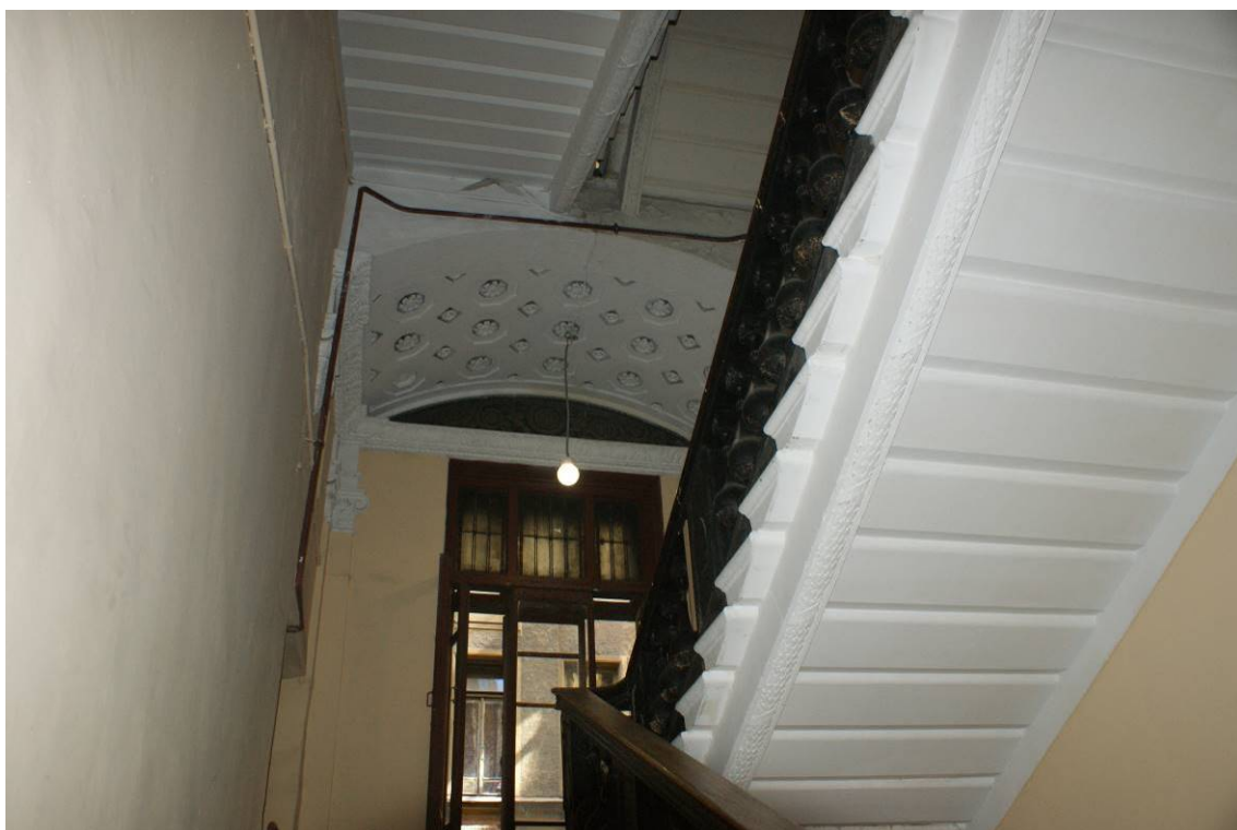
Фото 189. Лестница № 2: Площадка между 1-м и 2-м этажом. Съемка 26.04.2021 г. Трушковский В.Э.
