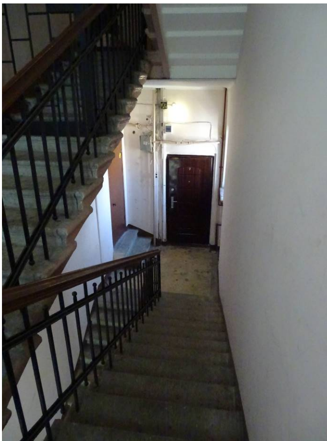
Фото 275. Лестница № 6: Площадка 6-го этажа. Съемка 26.04.2021 г. Трушковский В.Э.
