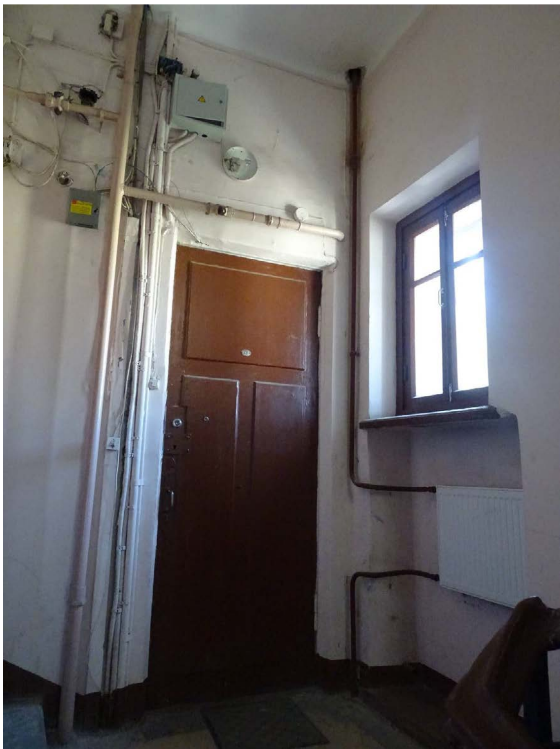
Фото 273. Лестница № 6: Площадка 5-го этажа. Покрытие пола. Съемка 26.04.2021 г. Трушковский В.Э.
