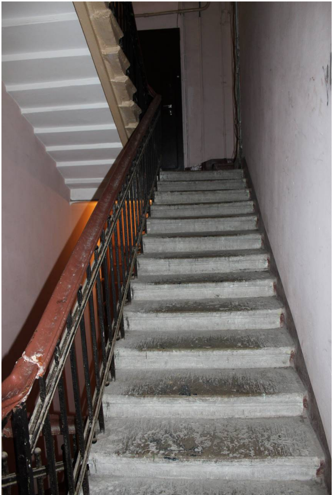
Фото 231. Лестница № 3: Лестничный марш на площадку 3-го этажа. Съемка 26.04.2021 г. Трушковский В.Э.
