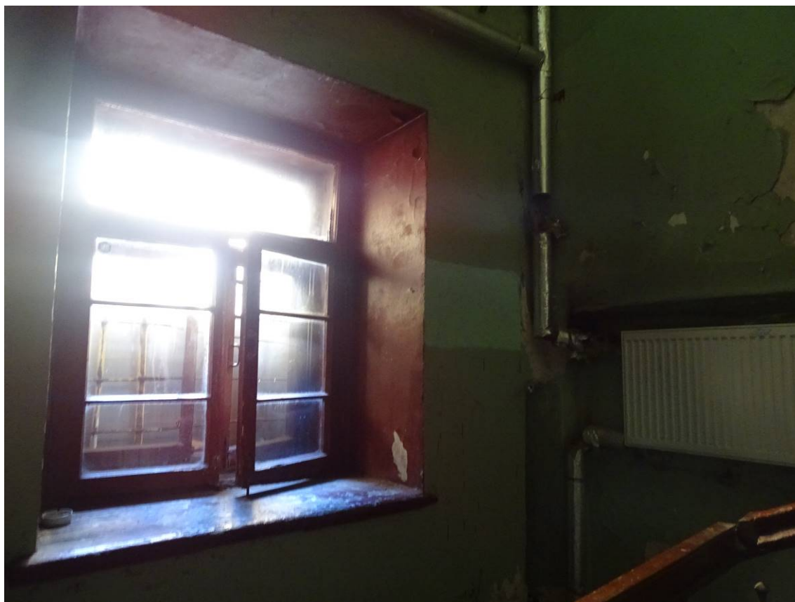
Фото 152. Лестница № 1: Площадка между подвальным и 1-м этажом. Съемка 26.04.2021 г. Трушковский В.Э.
