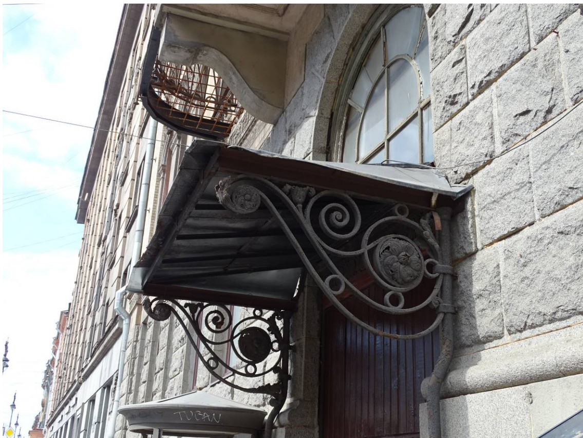
Фото 51. Здание по адресу: г. Санкт-Петербург, Кирочная ул., 22. Фрагмент лицевого фасада. Козырек. Съемка 26.04.2021 г. Трушковский В.Э.
