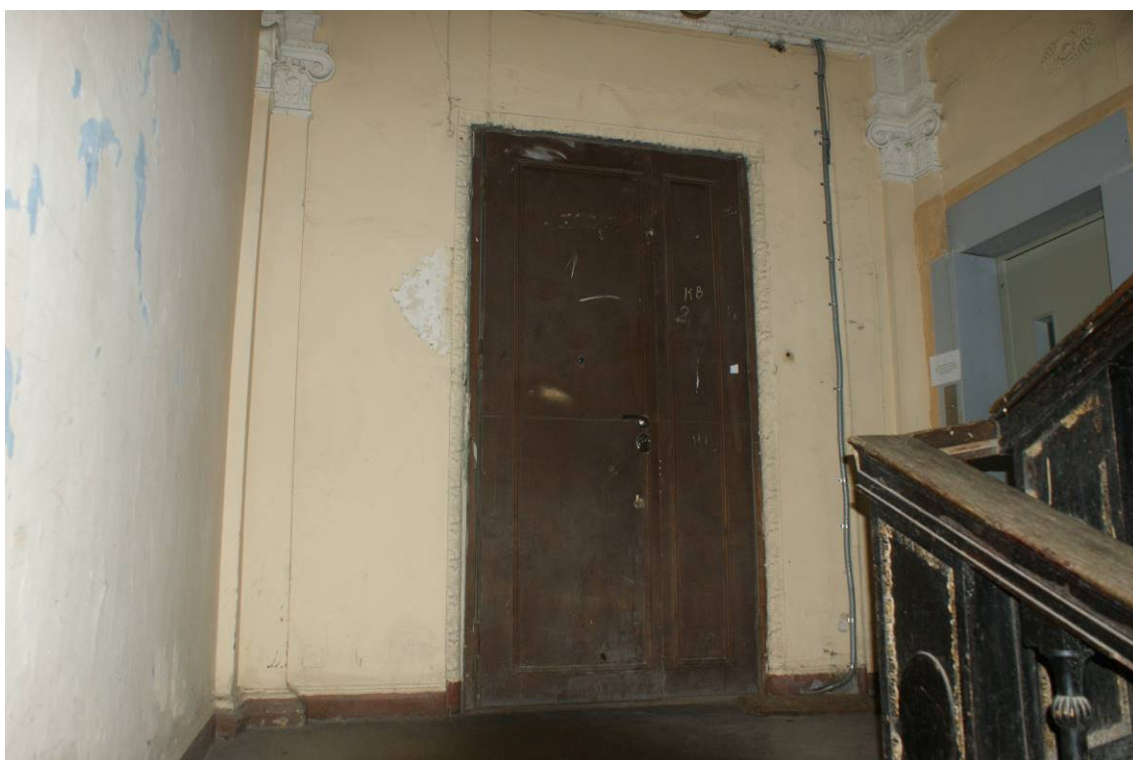
Фото 197. Лестница № 2: Площадка 2-го этажа. Оформление двери. Съемка 26.04.2021 г. Трушковский В.Э.
