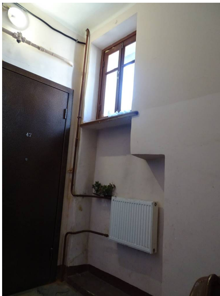
Фото 266. Лестница № 6: Площадка 4-го этажа. Ниша в стене. Съемка 26.04.2021 г. Трушковский В.Э.
