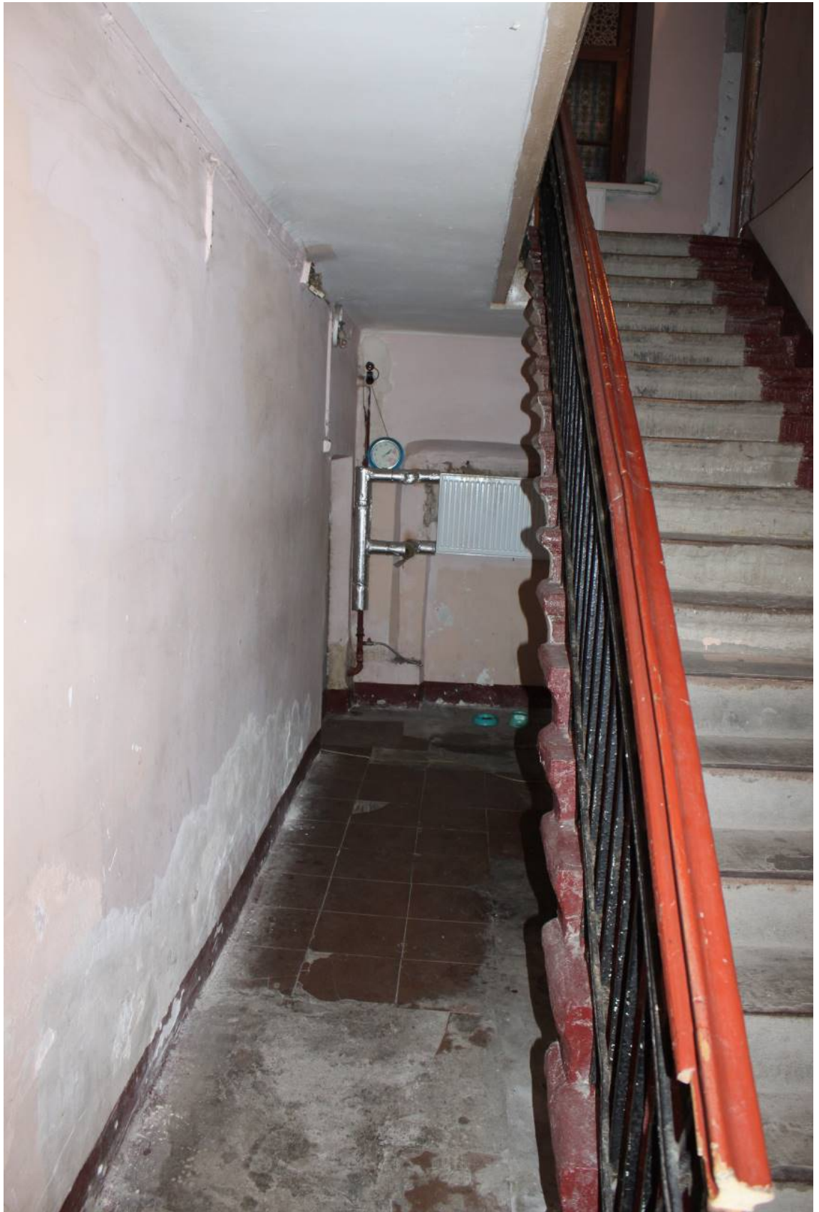
Фото 223. Лестница № 3: 1-й этаж. Пространство под лестницей. Съемка 26.04.2021 г. Трушковский В.Э.
