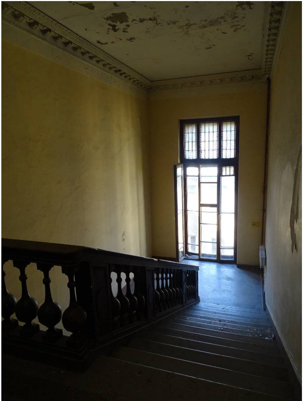
Фото 216. Лестница № 2: Площадка между 5-м и 6-м этажом. Съемка 26.04.2021 г. Трушковский В.Э.
