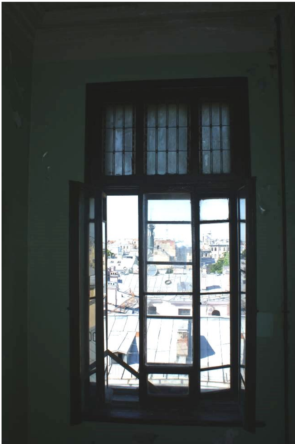
Фото 171. Лестница № 1: Площадка между 5-м и 6-м этажом. Оформление окна. Съемка 26.04.2021 г. Трушковский В.Э.
