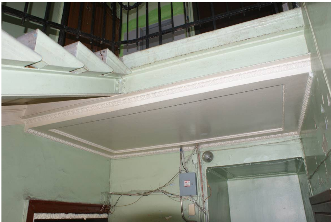
Фото 169. Лестница № 1: Площадка 5-го этажа. Съемка 26.04.2021 г. Трушковский В.Э.
