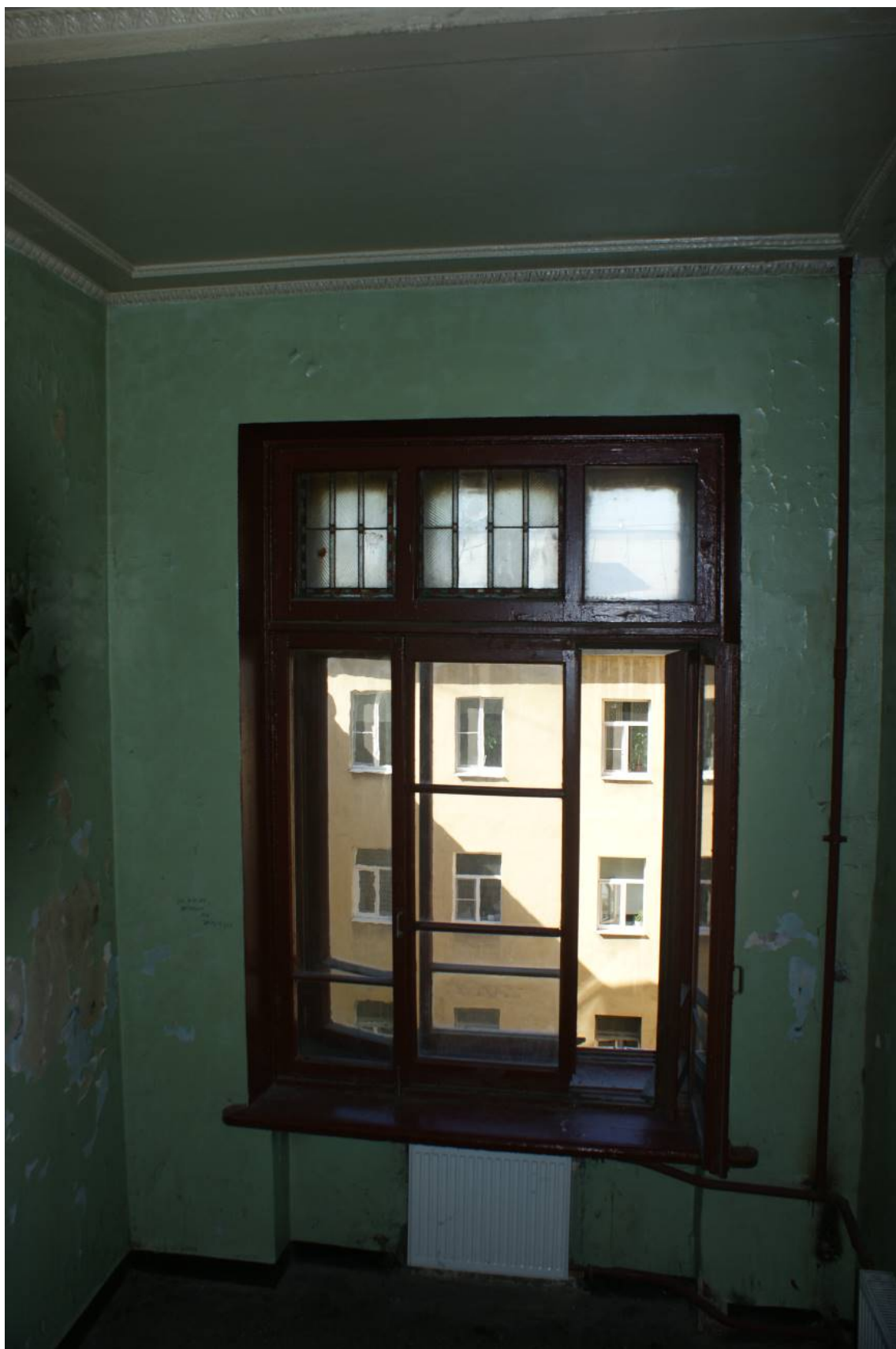
Фото 164. Лестница № 1: Площадка между 3-м и 4-м этажом. Оформление окна. Съемка 26.04.2021 г. Трушковский В.Э.
