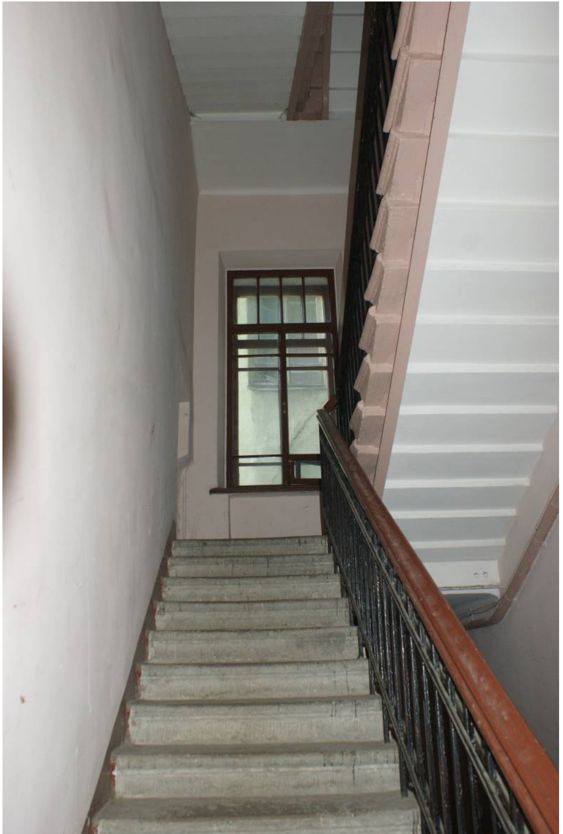
Фото 258. Лестница № 6: Площадка между 2-м и 3-м этажом. Съемка 26.04.2021 г. Трушковский В.Э.
