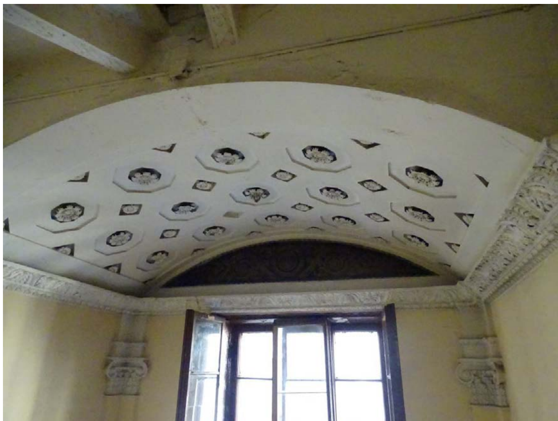
Фото 207. Лестница № 2: Площадка между 3-м и 4-м этажом. Оформление плафонов перекрытий. Съемка 26.04.2021 г. Трушковский В.Э.
