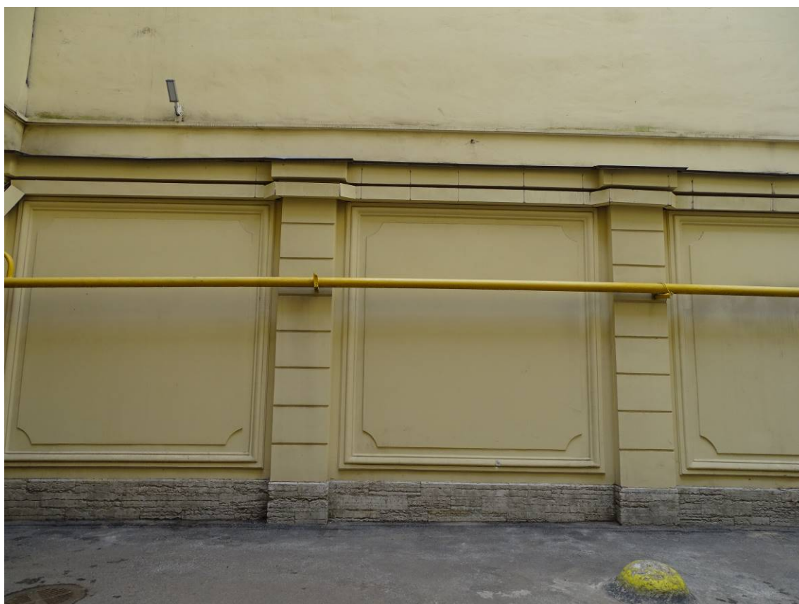
Фото 74. Здание по адресу: г. Санкт-Петербург, Кирочная ул., 22. Фрагмент восточного дворового фасада со стороны внутреннего двора дома 24 по ул. Кирочная. Съемка 26.04.2021 г. Трушковский В.Э.
