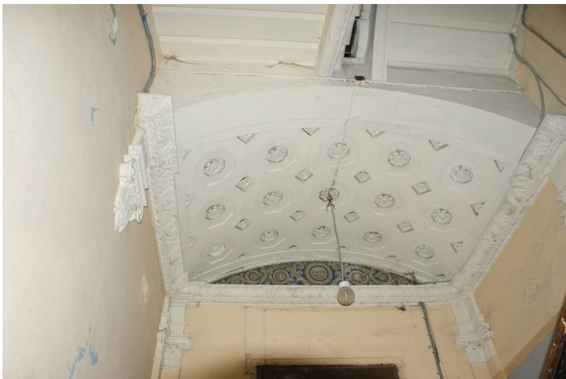
Фото 196. Лестница № 2: Площадка 2-го этажа. Оформление плафонов перекрытия. Съемка 26.04.2021 г. Трушковский В.Э.
