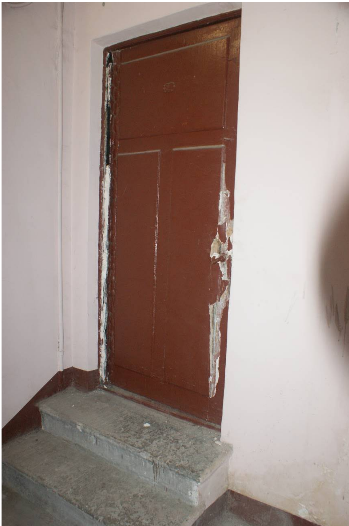
Фото 245. Лестница № 3: Площадка 6-го этажа. Оформление двери. Съемка 26.04.2021 г. Трушковский В.Э.
