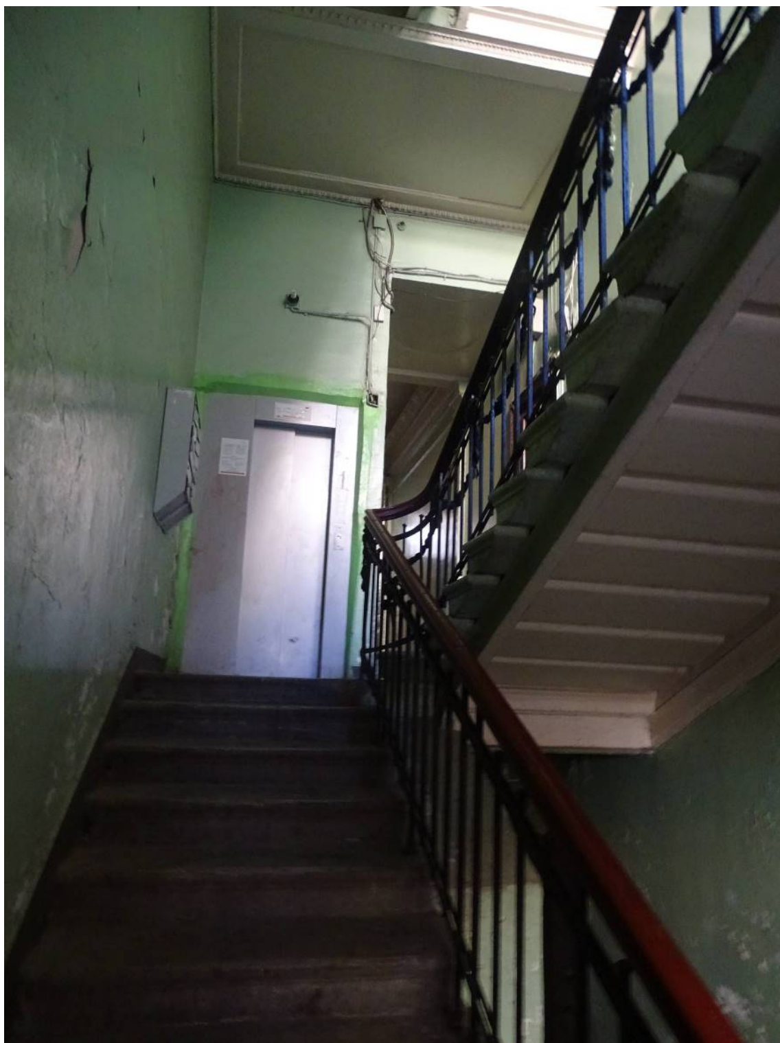
Фото 154. Лестница № 1: Площадка 1-го этажа. Съемка 26.04.2021 г. Трушковский В.Э.
