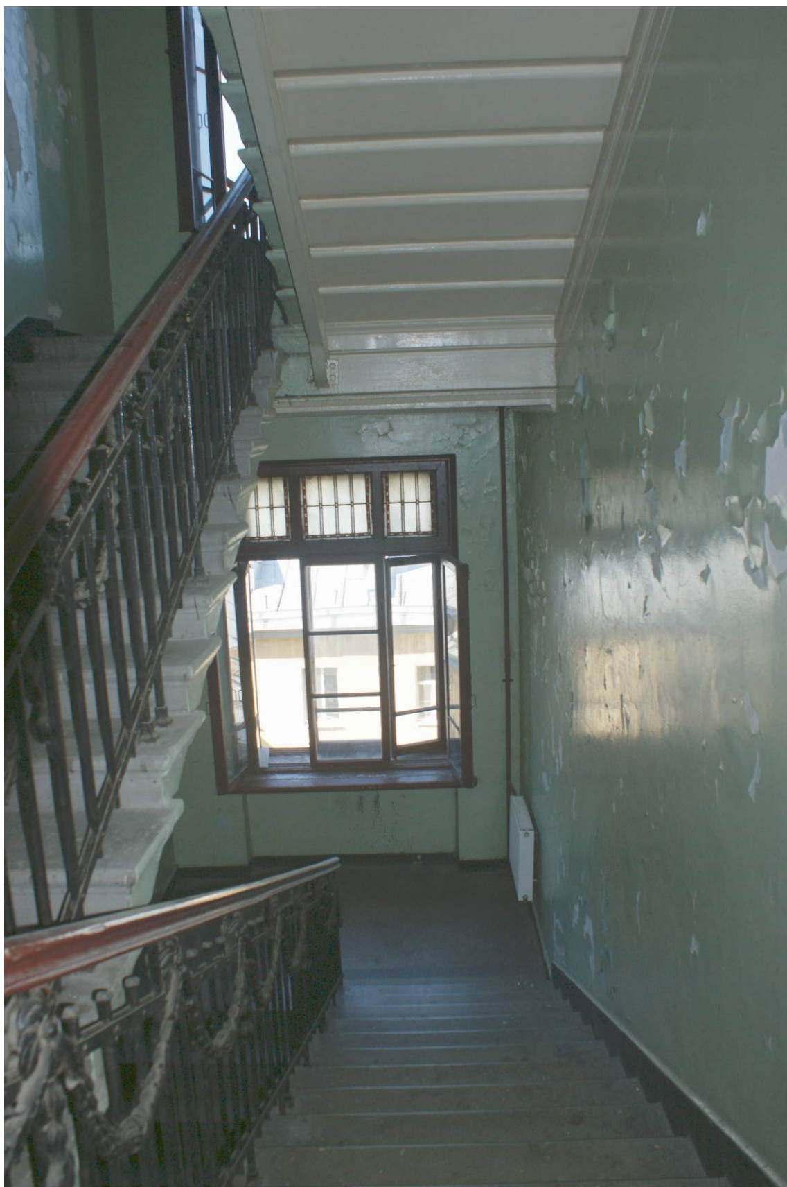
Фото 166. Лестница № 1: Площадка между 4-м и 5-м этажом. Съемка 26.04.2021 г. Трушковский В.Э.
