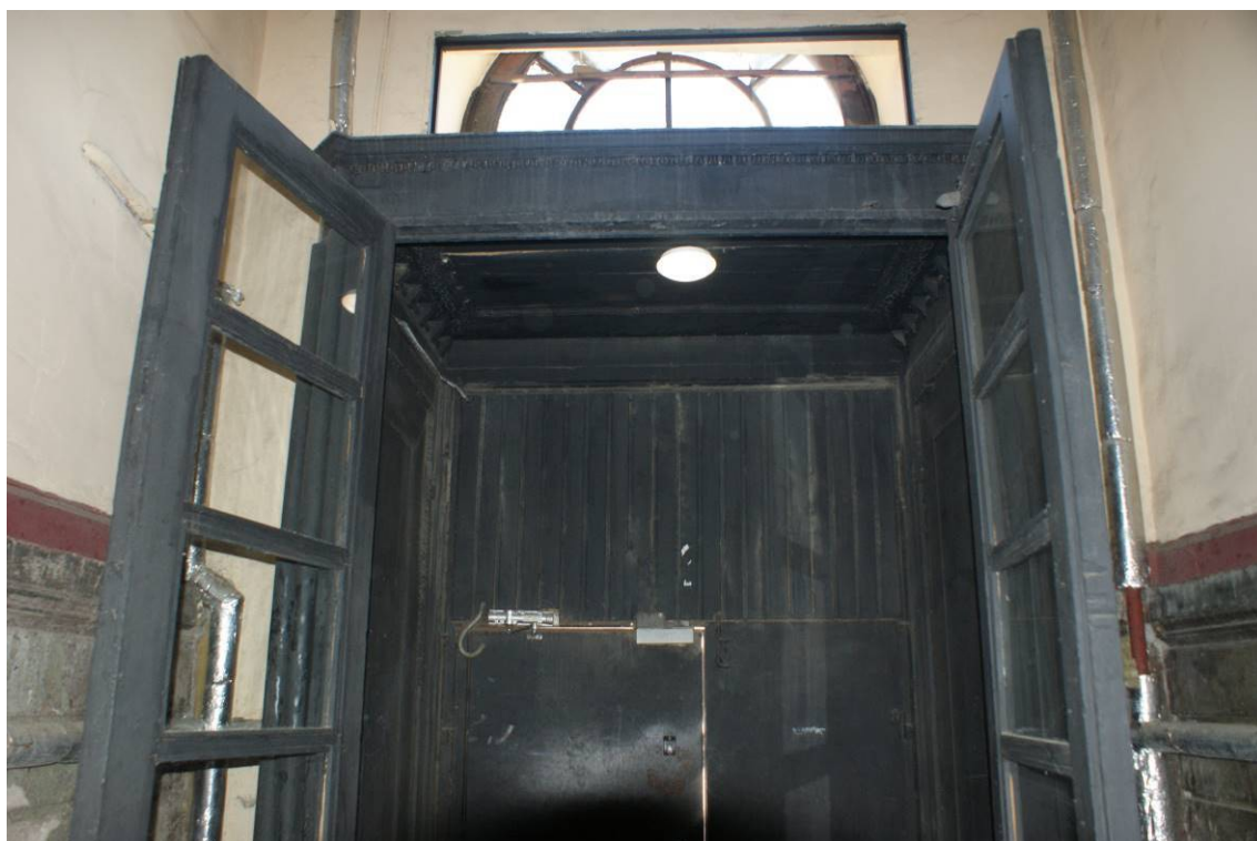
Фото 176. Лестница № 2: Вестибюль. 1-й этаж. Входная дверь. Съемка 26.04.2021 г. Трушковский В.Э.
