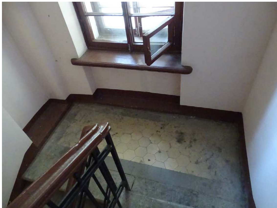
Фото 270. Лестница № 6: Площадка между 4-м и 5-м этажом. Покрытие пола. Съемка 26.04.2021 г. Трушковский В.Э.
