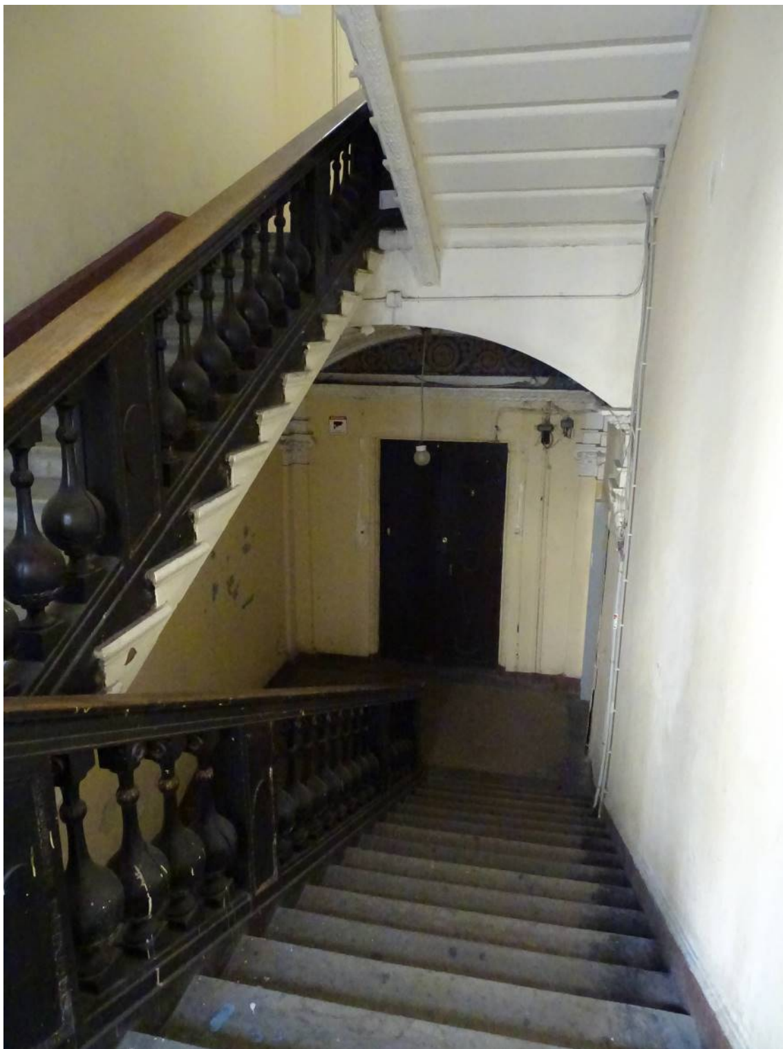
Фото 203. Лестница № 2: Площадка 3-го этажа. Съемка 26.04.2021 г. Трушковский В.Э.
