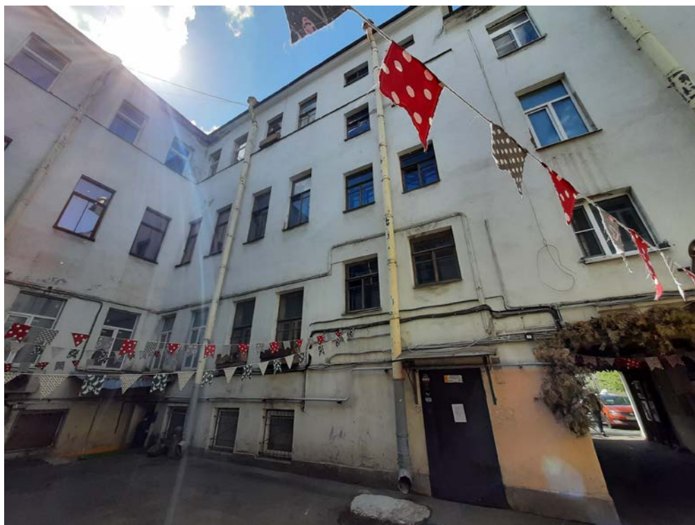
Фото 11. Фрагмент дворового фасада выявленного объекта культурного наследия «Дом Э. Паннаша»
