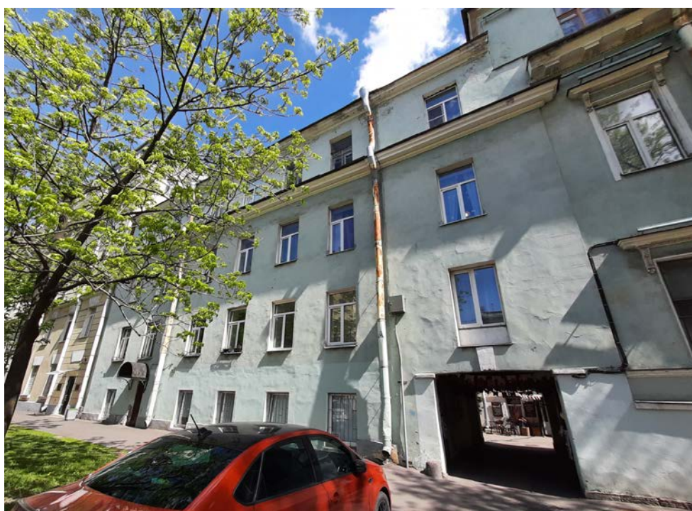
Фото 4. Лицевой фасад выявленного объекта культурного наследия «Дом Э. Паннаша»
