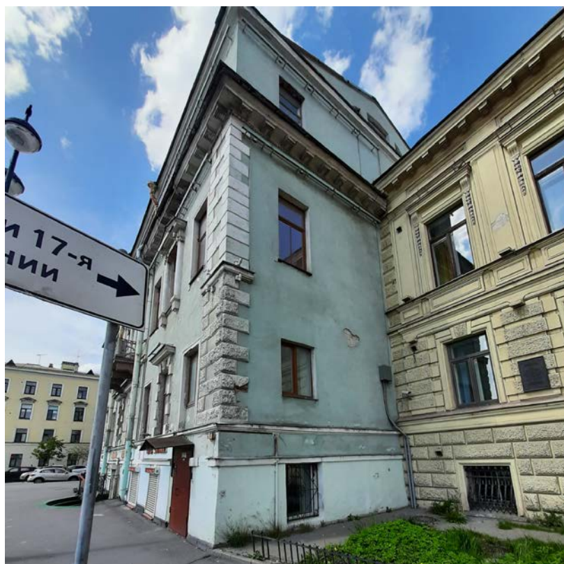
Фото 1. Лицевой фасад выявленного объекта культурного наследия «Дом Э. Паннаша»
