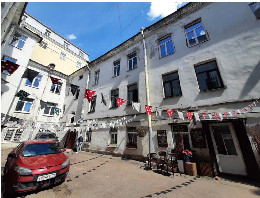
Фото 9. Фрагмент дворового фасада выявленного объекта культурного наследия «Дом Э. Паннаша»
