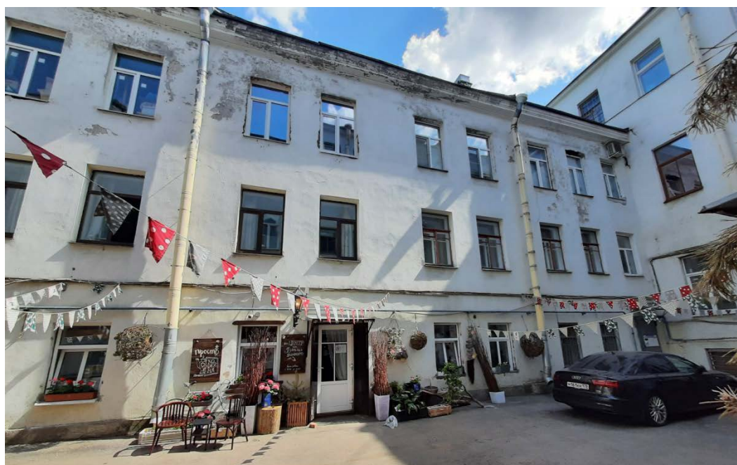
Фото 8. Фрагмент дворового фасада выявленного объекта культурного наследия «Дом Э. Паннаша»
