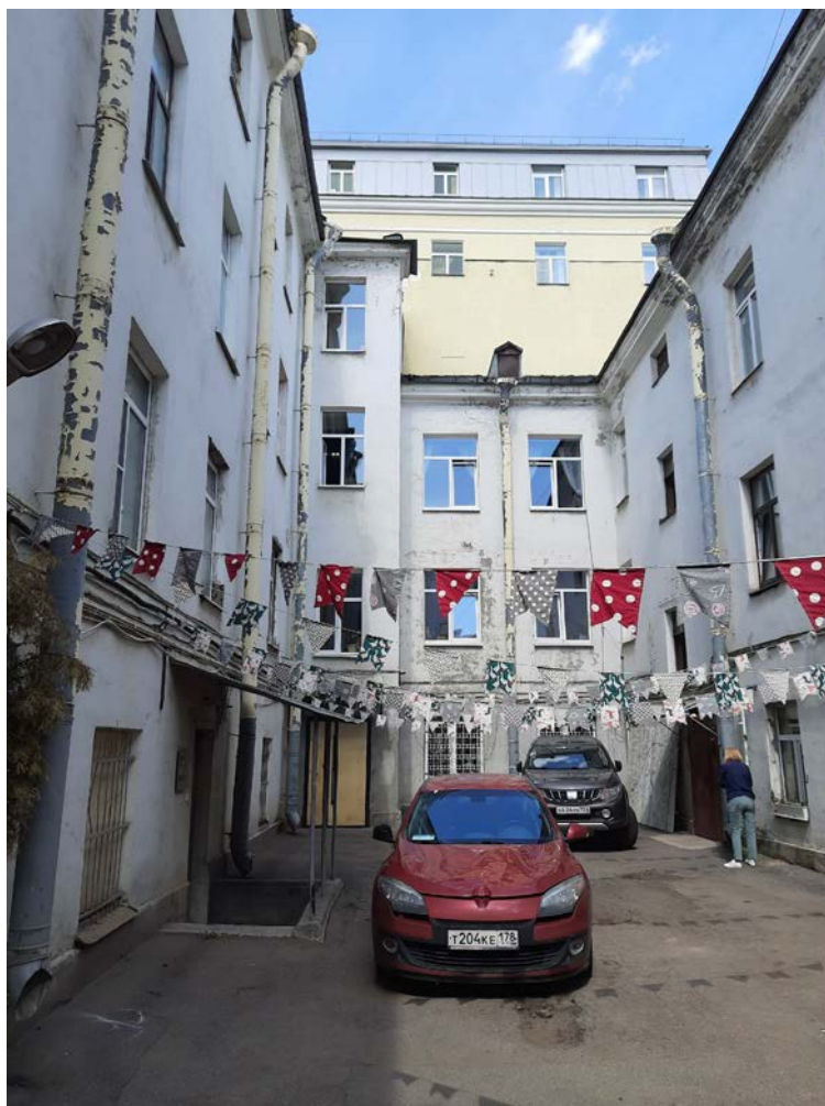
Фото 7. Фрагмент дворового фасада выявленного объекта культурного наследия «Дом Э. Паннаша»
