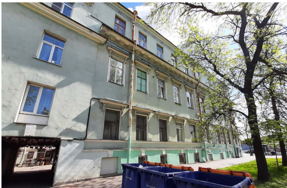
Фото 3. Лицевой фасад выявленного объекта культурного наследия «Дом Э. Паннаша»
