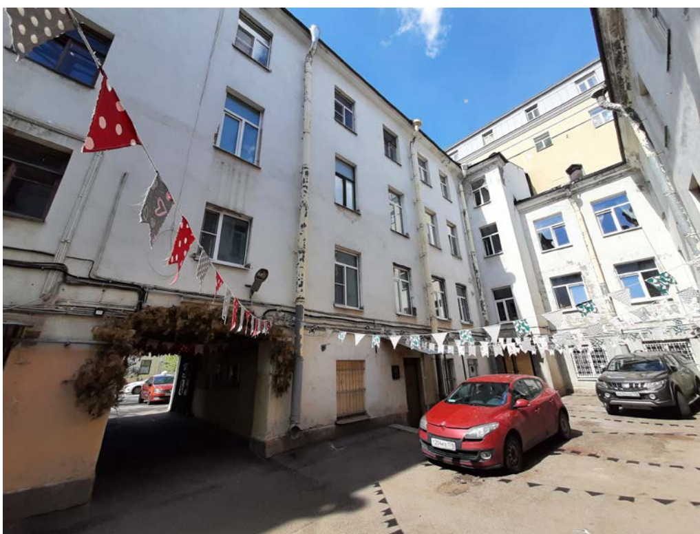
Фото 10. Фрагмент дворового фасада выявленного объекта культурного наследия «Дом Э. Паннаша»
