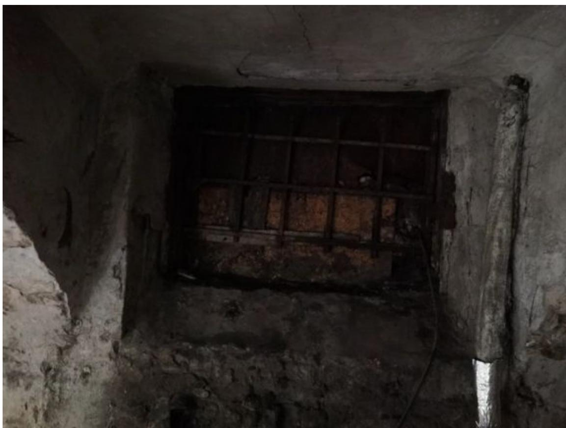
Фото 15. Точка 4 – пом. №2 (заложенный со стороны фасад оконный проем)
