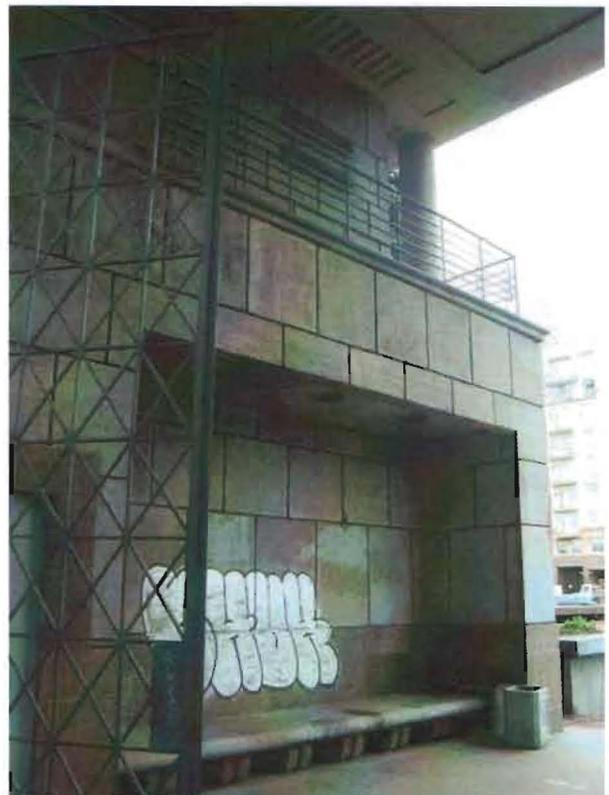
галерея 2-го этажа с ограждением кованого железа геометрического рисунка на круглых столбах, со сплошным остеклением, с двумя ведущими на галерею наружными лестницами (сложной конфигурации с ограждениями в виде глухих парапетов, отделанных терразитовой штукатуркой);
