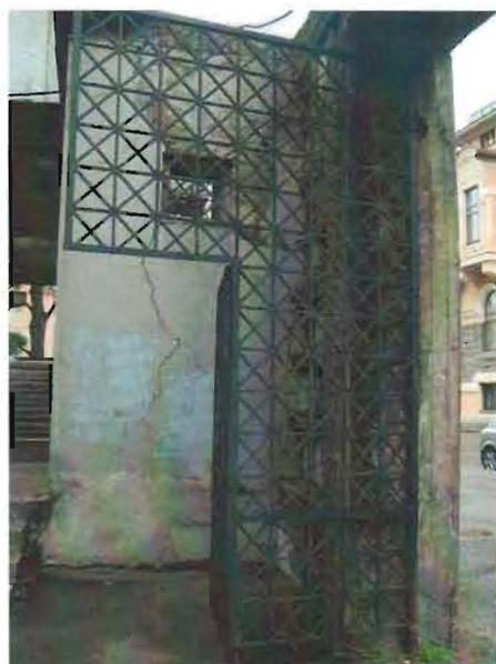
встроенный в ограду курдонера «павильон», состоящий из двух объемов электрощитовых, отделанных терразитовой штукатуркой, и беседкой-перголой между ними со стенками, выложенными из силикатного кирпича (кладка типа «пила»), и перекрытием с пересекающимися бетонными балками и сквозными просветами-кессонами между ними: гранитные скамьи на опорах-кронштейнах по трем сторонам «беседки».
