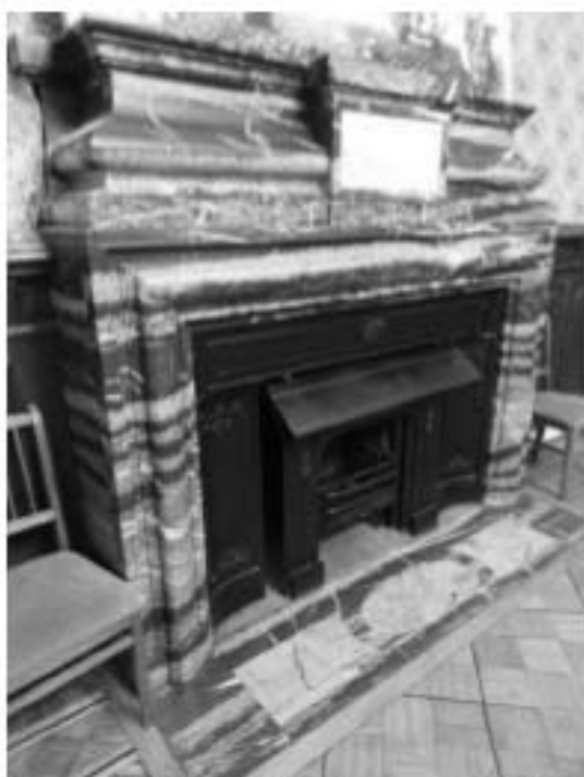
83. «Особняк Штифтер», ул. Моховая, д.15, лит.А. Помещение 3.4. Фрагмент. Фото 01.12.2020г.
