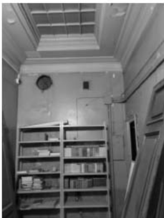
150. «Особняк Штифтер», ул. Моховая, д.15, лит.А. Общий вид помещения 4.17. Фото 01.12.2020г.
