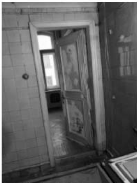
159. «Особняк Штифтер», ул. Моховая, д.15, лит.А. Дверной проём в помещение 4.14. Фото 01.12.2020г.
