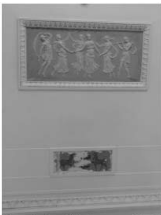
58. «Особняк Штифтер», ул. Моховая, д.15, лит.А. Помещение.2.6. Фрагмент. Фото 01.12.2020г.
