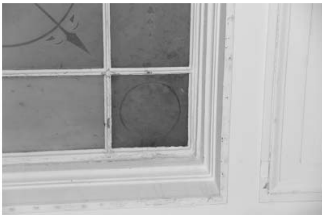
133. «Особняк Штифтер», ул. Моховая, д.15, лит.А. Помещение 4.11. Фрагмент. Фото 01.12.2020г.
