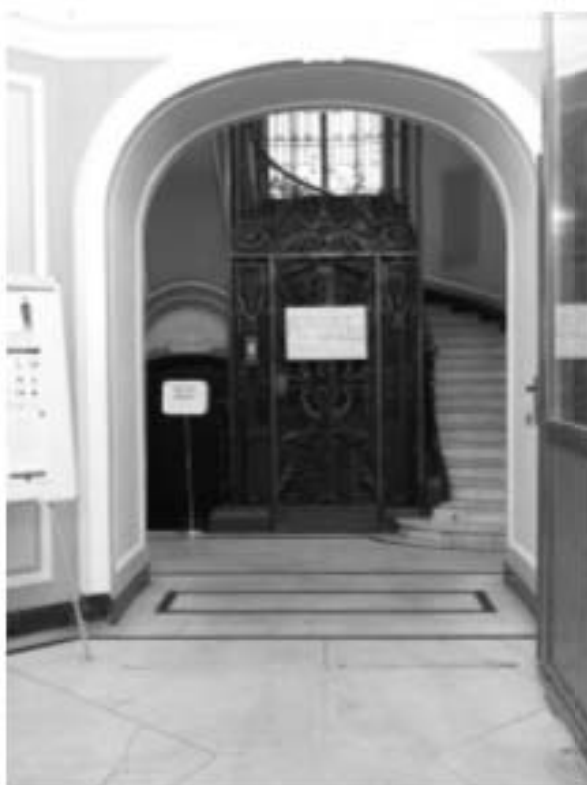
20. «Особняк Штифтер», ул. Моховая, д.15, лит.А. Вестибюль. Фрагмент. Фото 01.12.2020г.
