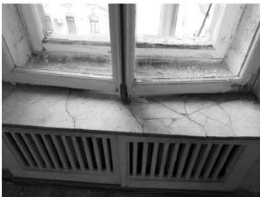
144. «Особняк Штифтер», ул. Моховая, д.15, лит.А. Помещение 4.10. Фрагмент. Фото 01.12.2020г.
