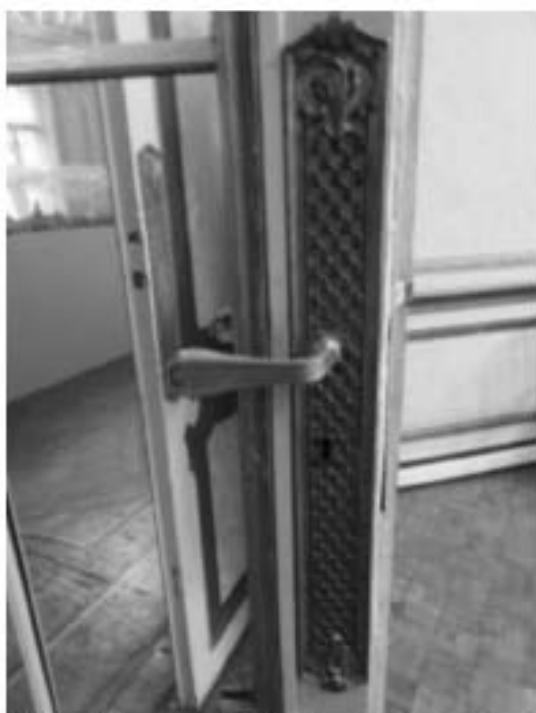
103. «Особняк Штифтер», ул. Моховая, д.15, лит.А. Помещение 3.5. Фрагмент. Фото 01.12.2020г.
