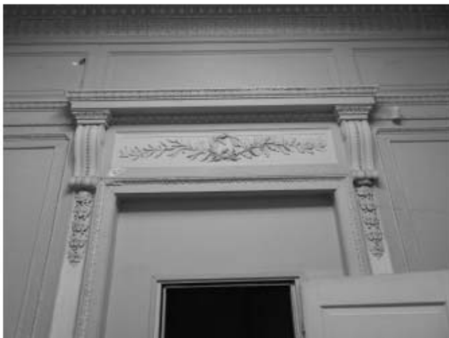
71. «Особняк Штифтер», ул. Моховая, д.15, лит.А. Помещение 3.1. Фрагмент. Фото 01.12.2020г.
