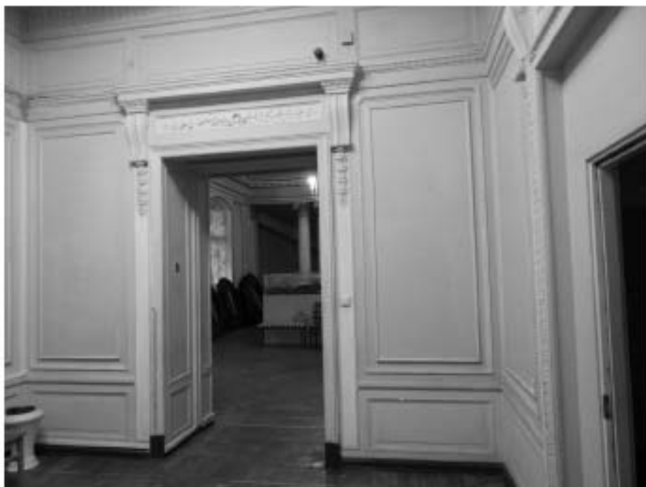
75. «Особняк Штифтер», ул. Моховая, д.15, лит.А. Дверной проём входа в помещении Колонного зала. Фото 01.12.2020г.
