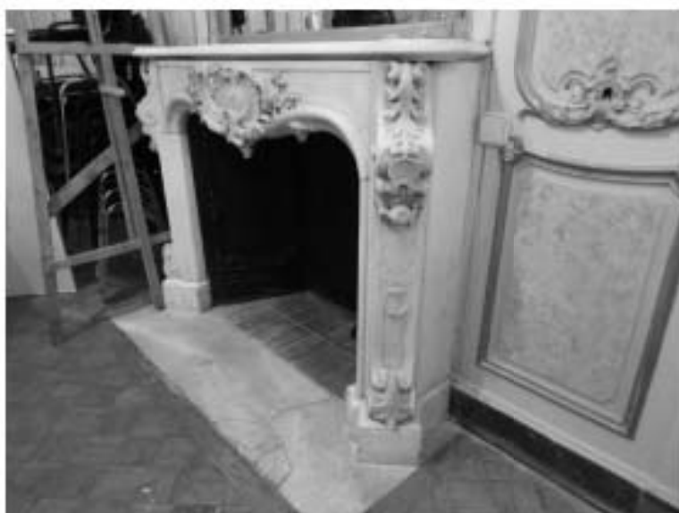
107. «Особняк Штифтер», ул. Моховая, д.15, лит.А. Помещение 3.6. Фрагмент. Фото 01.12.2020г.
