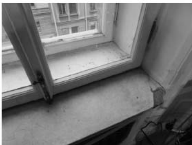
137. «Особняк Штифтер», ул. Моховая, д.15, лит.А. Помещение 4.12. Фрагмент. Фото 01.12.2020г.
