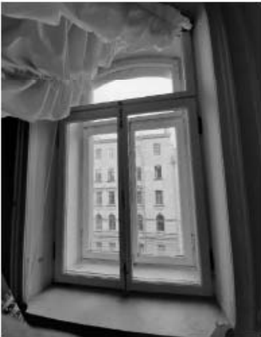
136. «Особняк Штифтер», ул. Моховая, д.15, лит.А. Помещение 4.12. Фрагмент. Фото 01.12.2020г.
