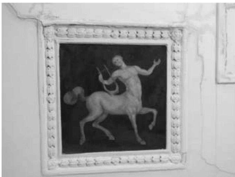
53. «Особняк Штифтер», ул. Моховая, д.15, лит.А. Помещение.2.6. Фрагмент. Фото 01.12.2020г.
