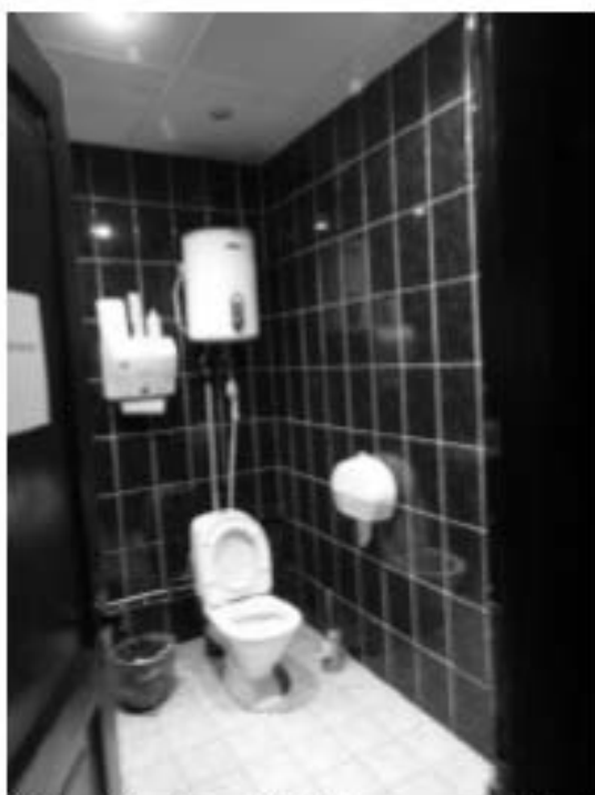
125. «Особняк Штифтер», ул. Моховая, д.15, лит.А. Общий вид помещения 4.5. Фото 01.12.2020г.
