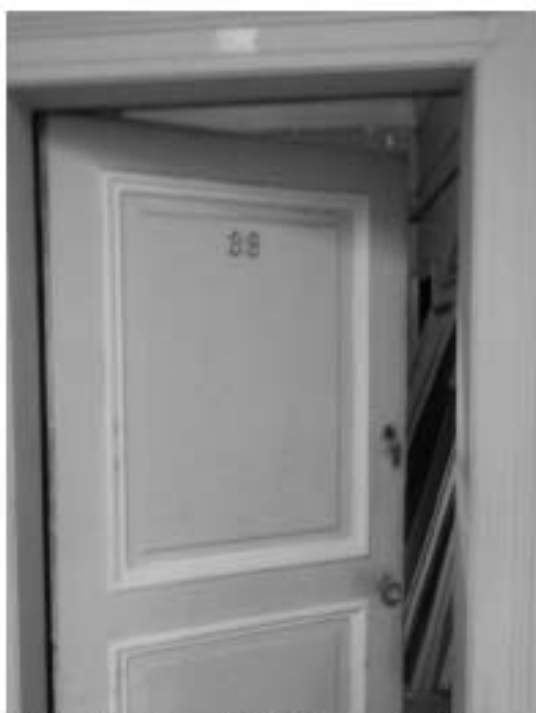
149. «Особняк Штифтер», ул. Моховая, д.15, лит.А. Дверной проём в помещение 4.17. Фото 01.12.2020г.
