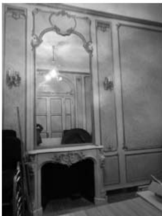
106. «Особняк Штифтер», ул. Моховая, д.15, лит.А. Помещение 3.6. Фрагмент. Фото 01.12.2020г.
