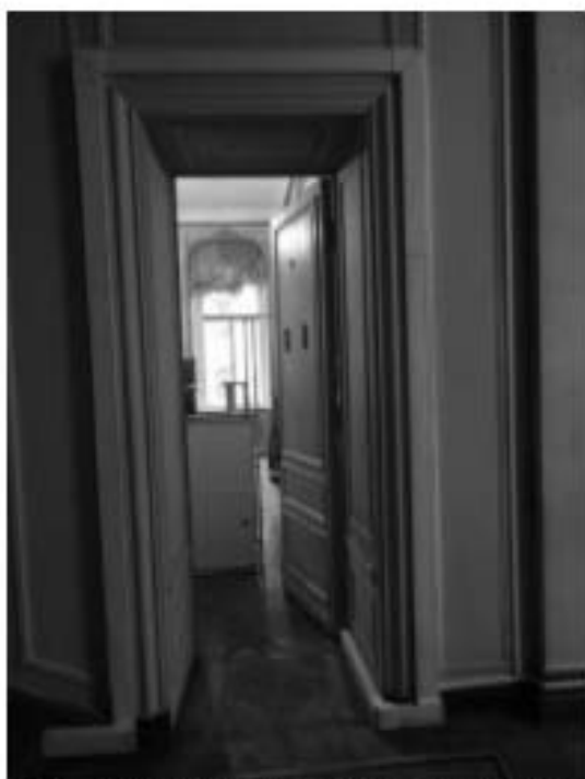
104. «Особняк Штифтер», ул. Моховая, д.15, лит.А. Дверной проём с тамбуром в помещении 3.6. Фото 01.12.2020г.
