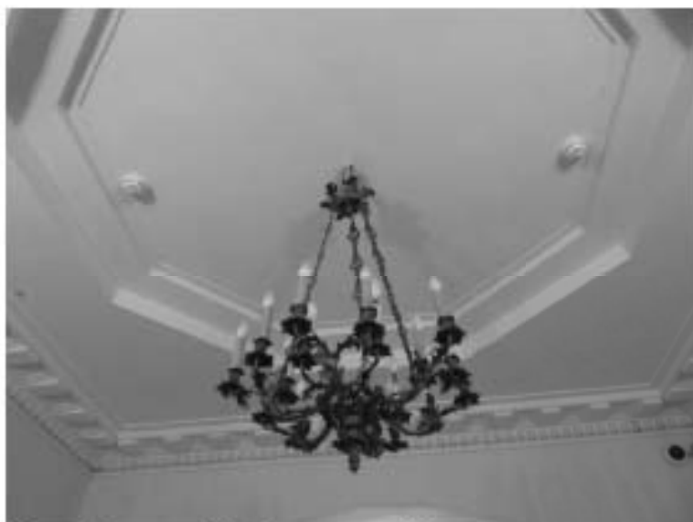
30. «Особняк Штифтер», ул. Моховая, д.15, лит.А. Общий вид потолка помещения 2.1. Фото 01.12.2020г.
