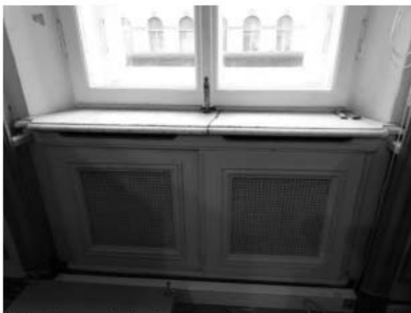
111. «Особняк Штифтер», ул. Моховая, д.15, лит.А. Помещение 3.6. Фрагмент. Фото 01.12.2020г.
