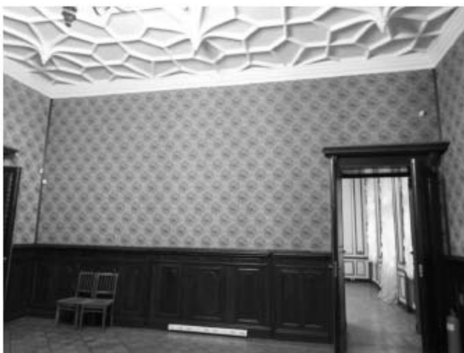
90. «Особняк Штифтер», ул. Моховая, д.15, лит.А. Помещение 3.4. Фрагмент. Фото 01.12.2020г.
