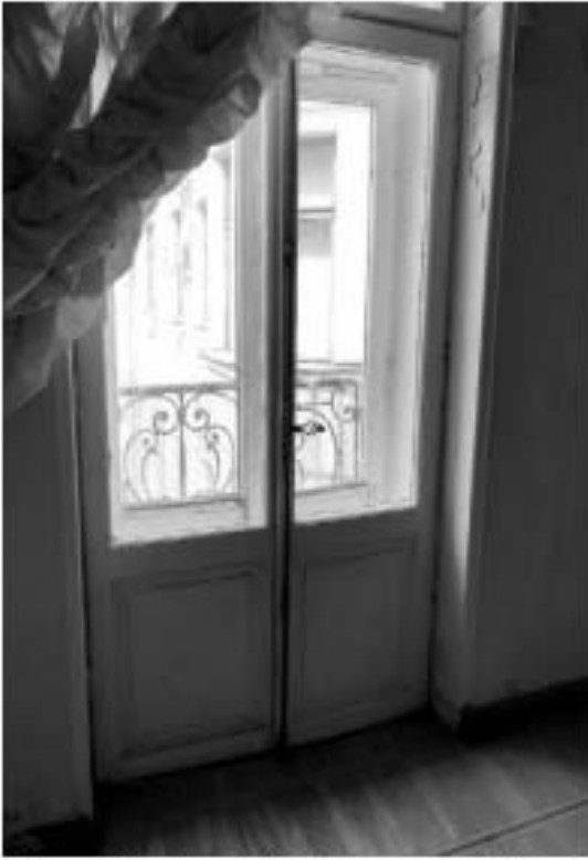
145. «Особняк Штифтер», ул. Моховая, д.15, лит.А. Помещение 4.10. Фрагмент. Фото 01.12.2020г.
