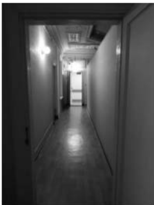
148. «Особняк Штифтер», ул. Моховая, д.15, лит.А. Общий вид помещения 4.11. Фото 01.12.2020г.
