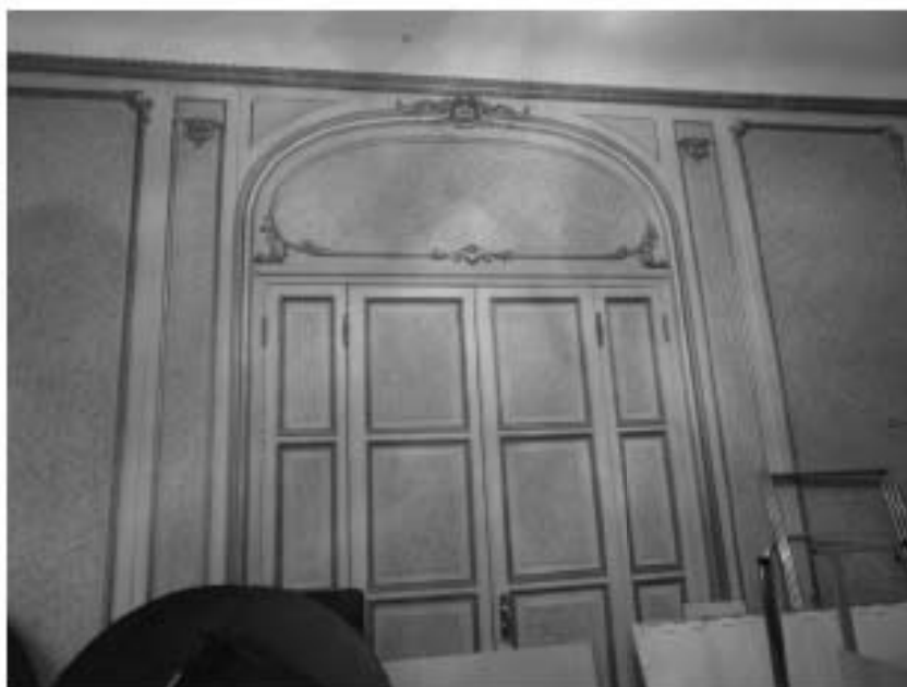
112. «Особняк Штифтер», ул. Моховая, д.15, лит.А. Помещение 3.6. Фрагмент. Фото 01.12.2020г.
