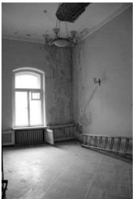
126. «Особняк Штифтер», ул. Моховая, д.15, лит.А. Общий вид помещения 4.6. Фото 01.12.2020г.
