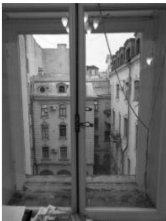
168. «Особняк Штифтер», ул. Моховая, д.15, лит.А. Помещение 4.9. Фрагмент. Фото 01.12.2020г.
