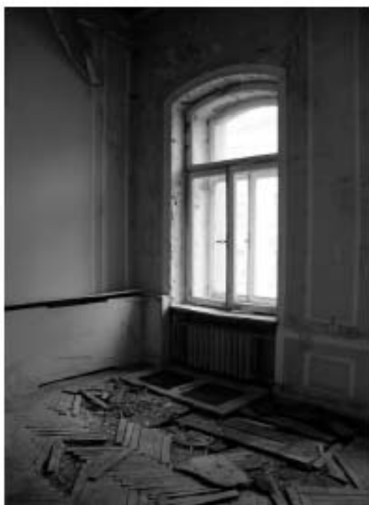
160. «Особняк Штифтер», ул. Моховая, д.15, лит.А. Общий вид помещения 4.14. Фото 01.12.2020г.
