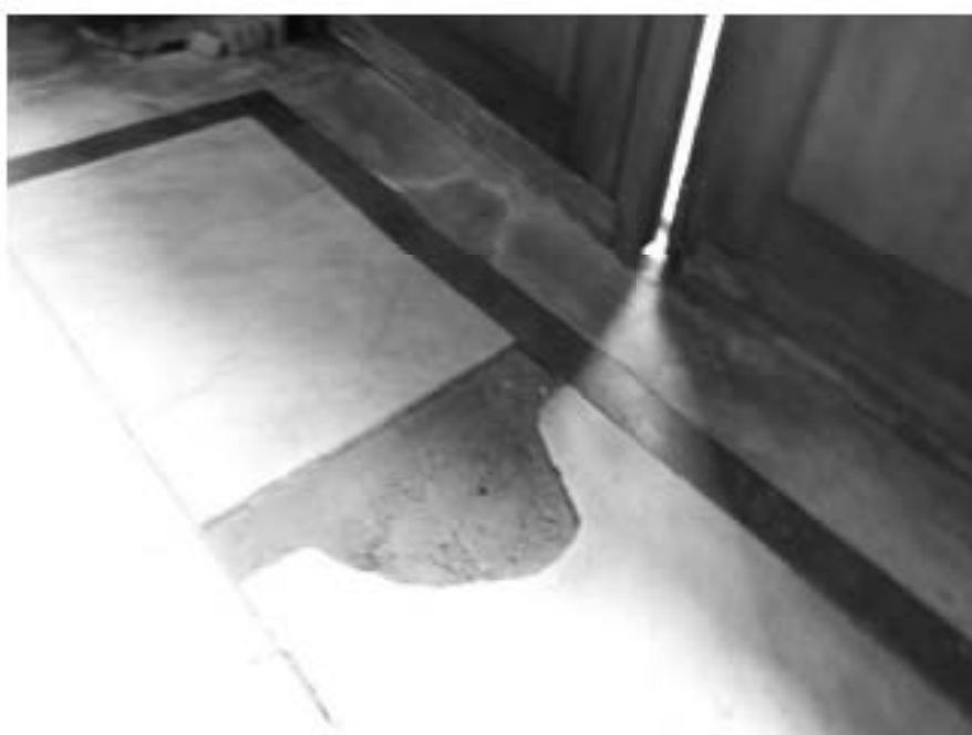
6. «Особняк Штифтер», ул. Моховая, д.15, лит.А. Тамбур. Фрагмент. Фото 01.12.2020г.
