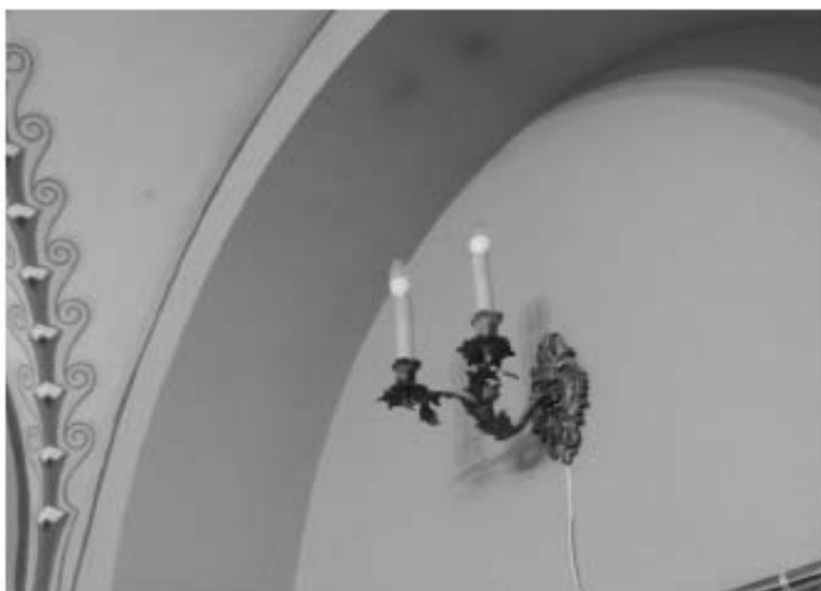
43. «Особняк Штифтер», ул. Моховая, д.15, лит.А. Помещение 2.7. Фрагмент. Фото 01.12.2020г.
