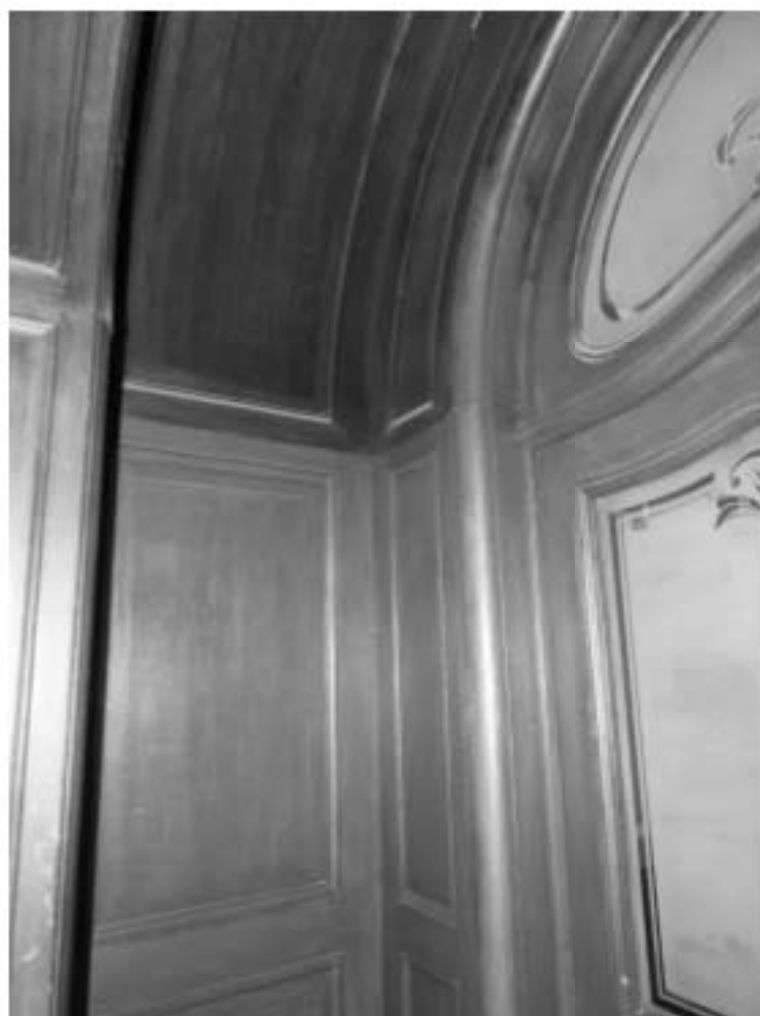
8. «Особняк Штифтер», ул. Моховая, д.15, лит.А. Тамбур. Фрагмент. Фото 01.12.2020г.
