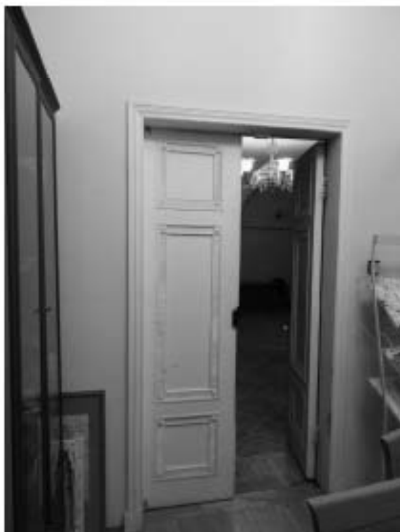
48. «Особняк Штифтер», ул. Моховая, д.15, лит.А. Помещение.2.8. Фрагмент. Фото 01.12.2020г.
