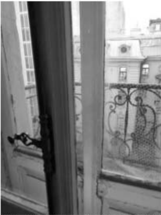
146. «Особняк Штифтер», ул. Моховая, д.15, лит.А. Помещение 4.10. Фрагмент. Фото 01.12.2020г.
