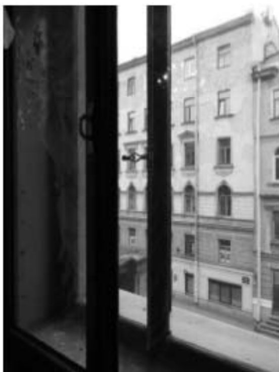
86. «Особняк Штифтер», ул. Моховая, д.15, лит.А. Помещение 3.4. Фрагмент. Фото 01.12.2020г.
