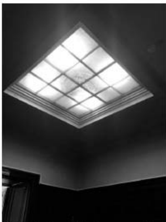
173. «Особняк Штифтер», ул. Моховая, д.15, лит.А. Помещение 4.1. Фрагмент. Фото 01.12.2020г.
