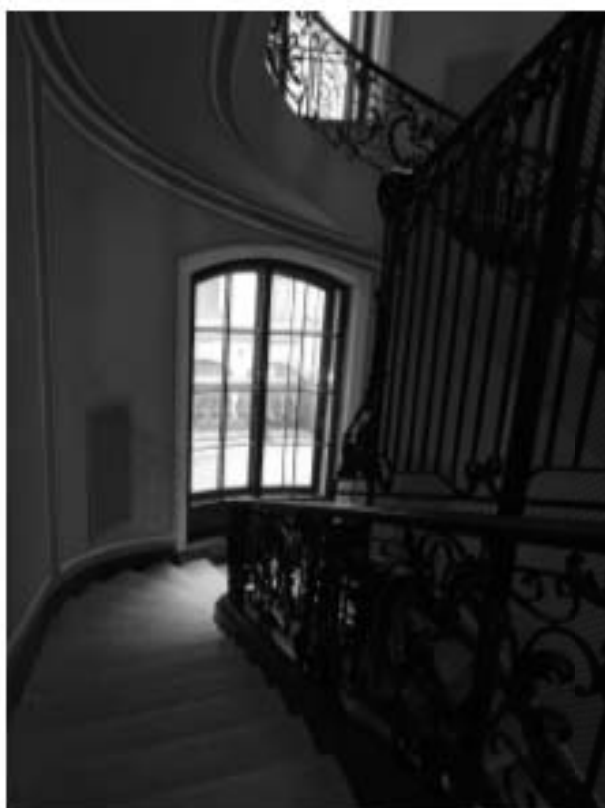
25. «Особняк Штифтер», ул. Моховая, д.15, лит.А. Фрагмент лестничного марша с 1 этажа на 2 этаж. Фото 01.12.2020г.
