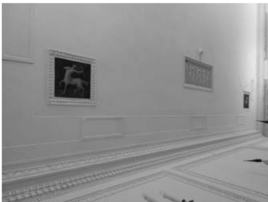
51. «Особняк Штифтер», ул. Моховая, д.15, лит.А. Помещение.2.6. Фрагмент. Фото 01.12.2020г.
