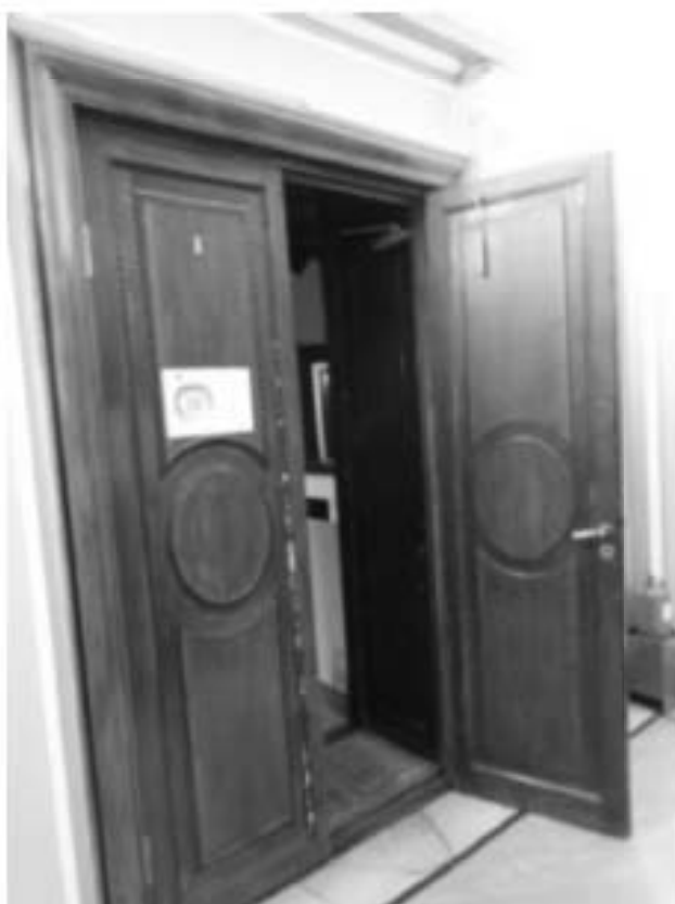
26. «Особняк Штифтер», ул. Моховая, д.15, лит.А. Входная дверь с тамбуром, в помещения 2 этажа с лестничной площадки. Фото 01.12.2020г.
