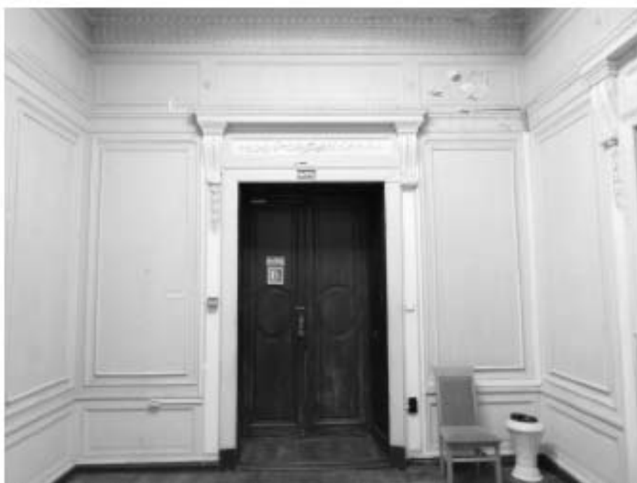
73. «Особняк Штифтер», ул. Моховая, д.15, лит.А. Общий вид помещения 3.2. Фото 01.12.2020г.
