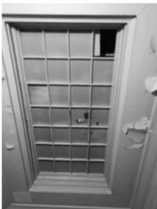
151. «Особняк Штифтер», ул. Моховая, д.15, лит.А. Помещение 4.17. Фрагмент. Фото 01.12.2020г.
