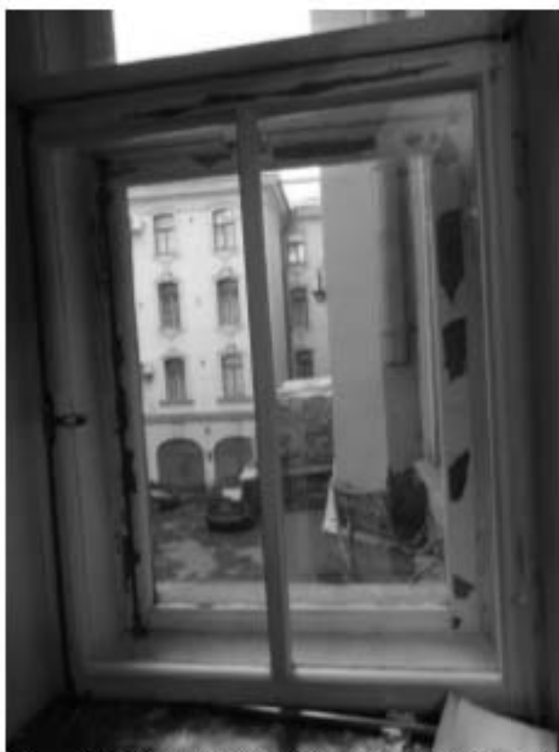
45. «Особняк Штифтер», ул. Моховая, д.15, лит.А. Помещение 2.7. Фрагмент. Фото 01.12.2020г.
