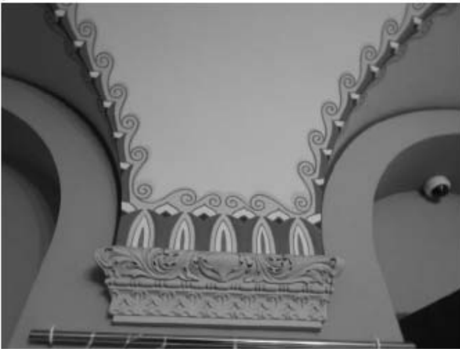
42. «Особняк Штифтер», ул. Моховая, д.15, лит.А. Помещение 2.7. Фрагмент. Фото 01.12.2020г.
