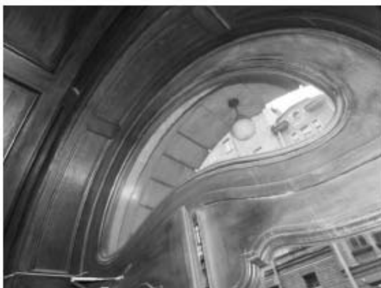
7. «Особняк Штифтер», ул. Моховая, д.15, лит.А. Тамбур. Фрагмент. Фото 01.12.2020г.
