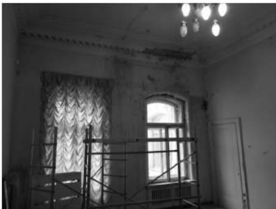
142. «Особняк Штифтер», ул. Моховая, д.15, лит.А. Общий вид помещения 4.10. Фото 01.12.2020г.
