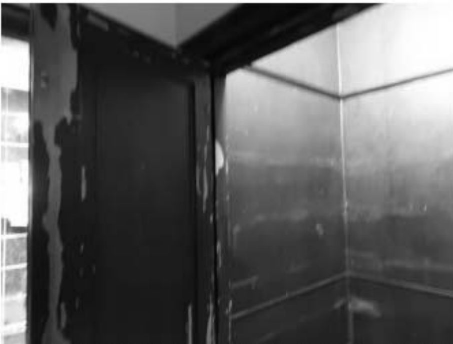
124. «Особняк Штифтер», ул. Моховая, д.15, лит.А. Общий вид помещения 4.3. Фото 01.12.2020г.
