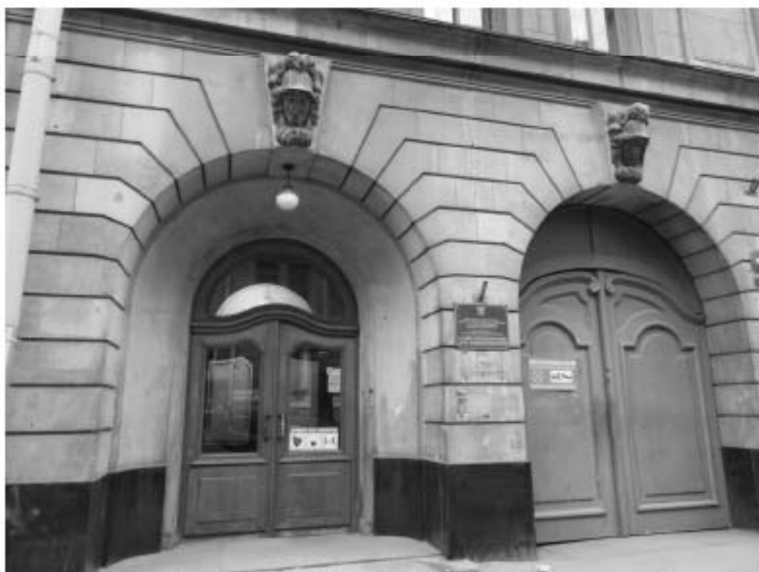
2. «Особняк Штифтер», ул. Моховая, д.15, лит.А. Восточный фасад. Фрагмент. Фото 01.12.2020г.
