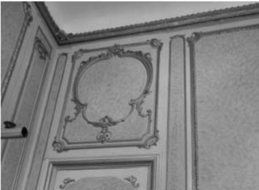
114. «Особняк Штифтер», ул. Моховая, д.15, лит.А. Помещение 3.6. Фрагмент. Фото 01.12.2020г.
