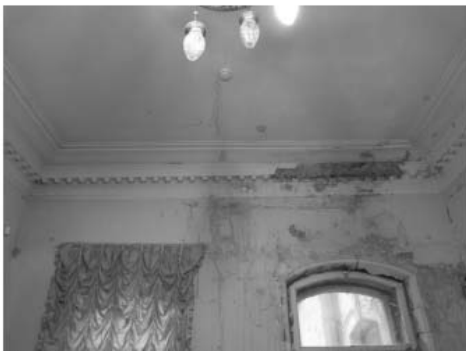
143. «Особняк Штифтер», ул. Моховая, д.15, лит.А. Помещение 4.10. Фрагмент. Фото 01.12.2020г.
