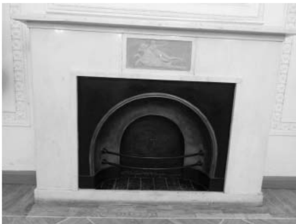
60. «Особняк Штифтер», ул. Моховая, д.15, лит.А. Помещение.2.6. Фрагмент. Фото 01.12.2020г.
