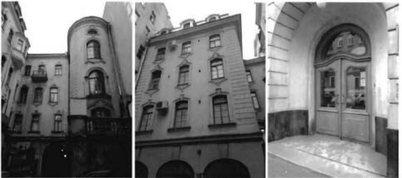
2. Вид на восточный дворовой фасад. 3. Вид на западный фасад объекта культурного наследия. 4. Входная группа с ул. Моховая, объекта культурного наследия.
