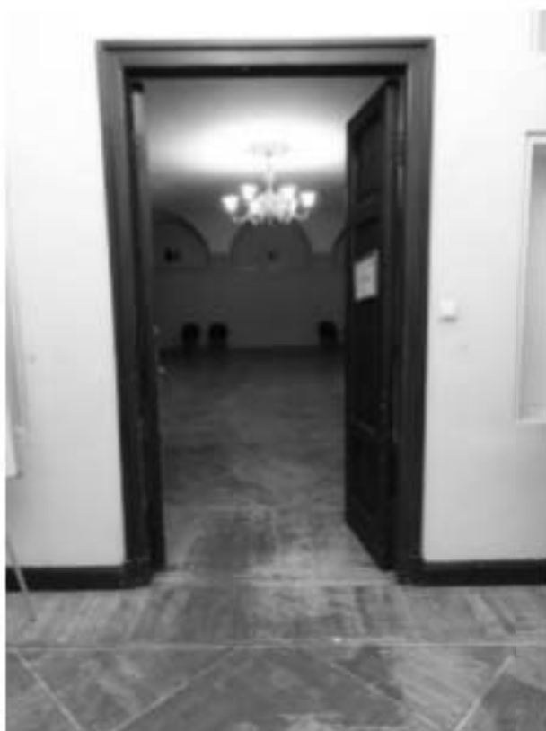
37. «Особняк Штифтер», ул. Моховая, д.15, лит.А. Дверной проём из помещения 2.5 в помещение 2.7. Фото 01.12.2020г.
