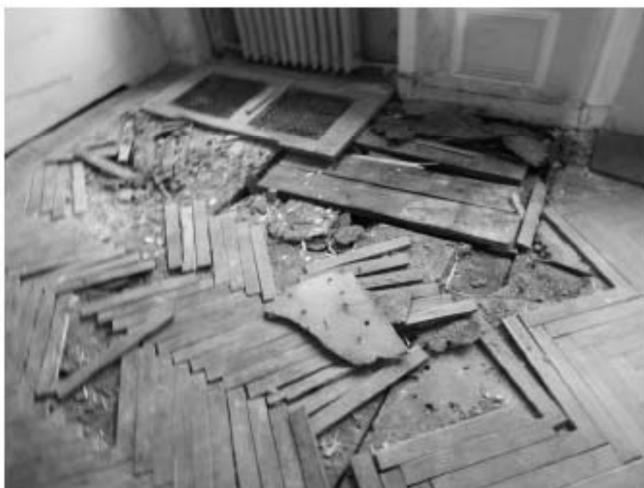
162. «Особняк Штифтер», ул. Моховая, д.15, лит.А. Помещение 4.14. Фрагмент. Фото 01.12.2020г.
