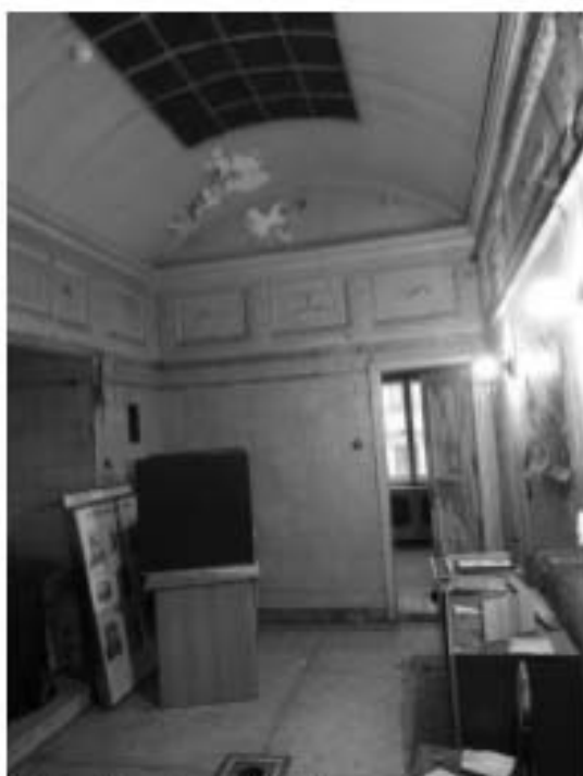
153. «Особняк Штифтер», ул. Моховая, д.15, лит.А. Общий вид помещения 4.13. с дверным проёмом в помещение 4.14. Фото 01.12.2020г.
