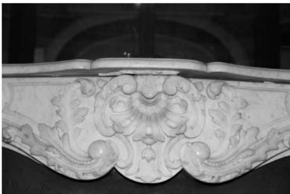
17. «Особняк Штифтер», ул. Моховая, д.15, лит.А. Вестибюль. Фрагмент. Фото 01.12.2020г.
