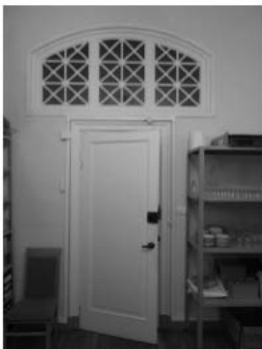
169. «Особняк Штифтер», ул. Моховая, д.15, лит.А. Помещение 4.9. Фрагмент. Фото 01.12.2020г.
