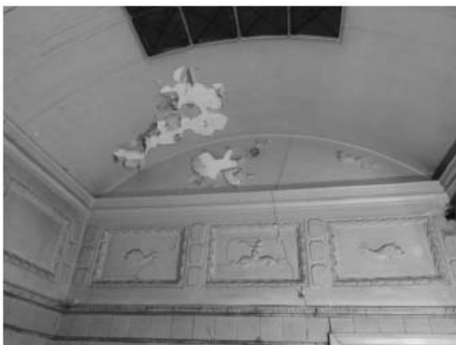
154. «Особняк Штифтер», ул. Моховая, д.15, лит.А. Помещение 4.13. Фрагмент. Фото 01.12.2020г.
