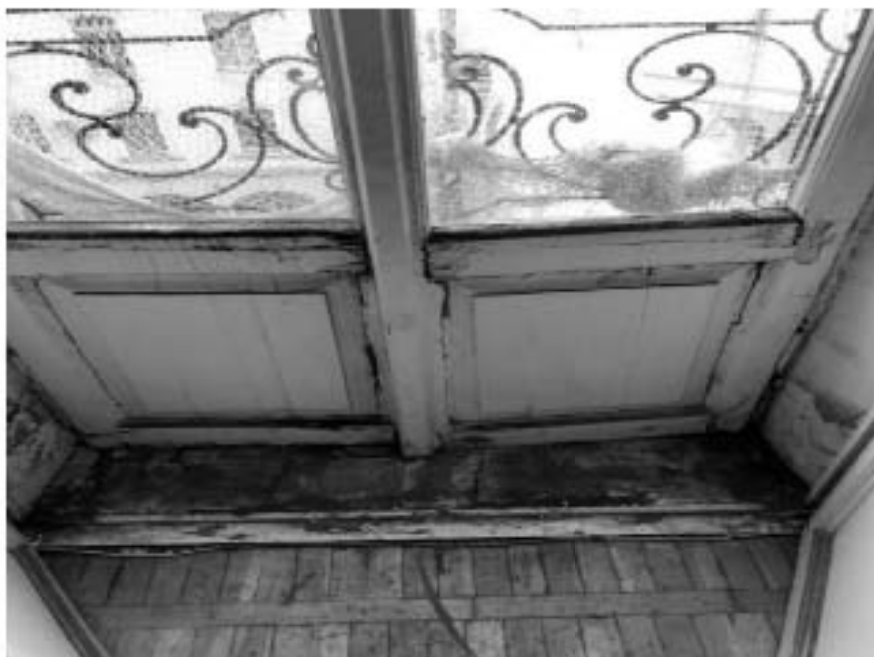
147. «Особняк Штифтер», ул. Моховая, д.15, лит.А. Помещение 4.10. Фрагмент. Фото 01.12.2020г.
