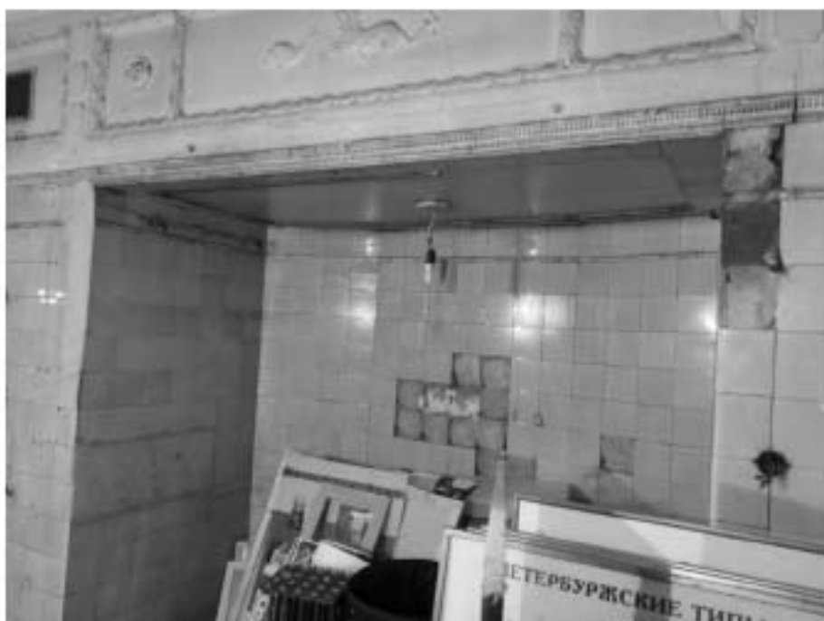
157. «Особняк Штифтер», ул. Моховая, д.15, лит.А. Помещение 4.13. Фрагмент. Фото 01.12.2020г.
