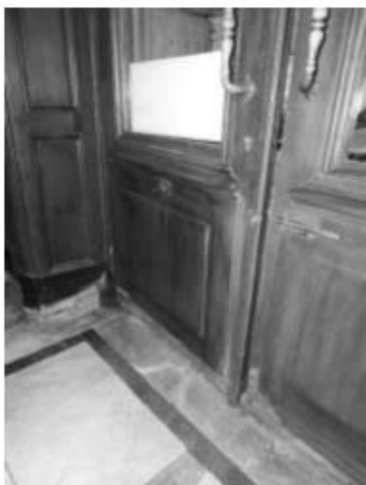
5. «Особняк Штифтер», ул. Моховая, д.15, лит.А. Тамбур. Фрагмент. Фото 01.12.2020г.
