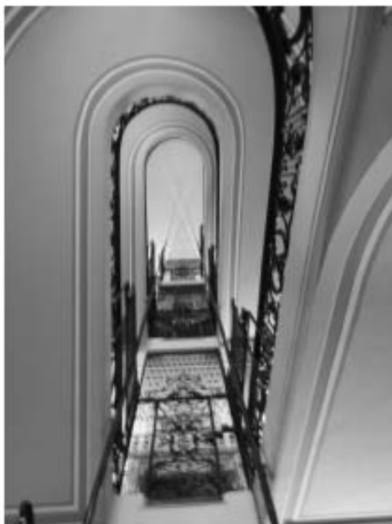
21. «Особняк Штифтер», ул. Моховая, д.15, лит.А. Общий вид лестницы с вестибюля. Фото 01.12.2020г.
