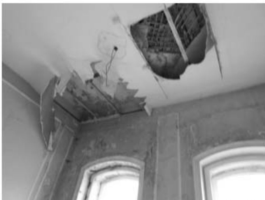
161. «Особняк Штифтер», ул. Моховая, д.15, лит.А. Помещение 4.14. Фрагмент. Фото 01.12.2020г.
