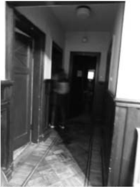
123. «Особняк Штифтер», ул. Моховая, д.15, лит.А. Общий вид коридора к помещениям 4.3-4.7. Фото 01.12.2020г.
