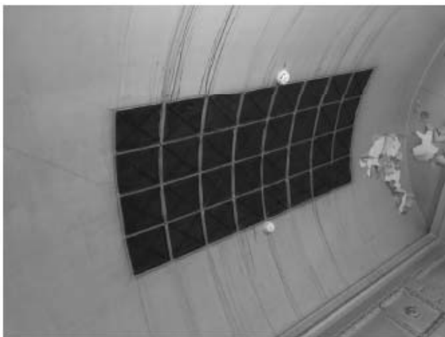
156. «Особняк Штифтер», ул. Моховая, д.15, лит.А. Помещение 4.13. Фрагмент. Фото 01.12.2020г.
