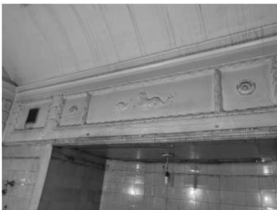
158. «Особняк Штифтер», ул. Моховая, д.15, лит.А. Помещение 4.13. Фрагмент. Фото 01.12.2020г.
