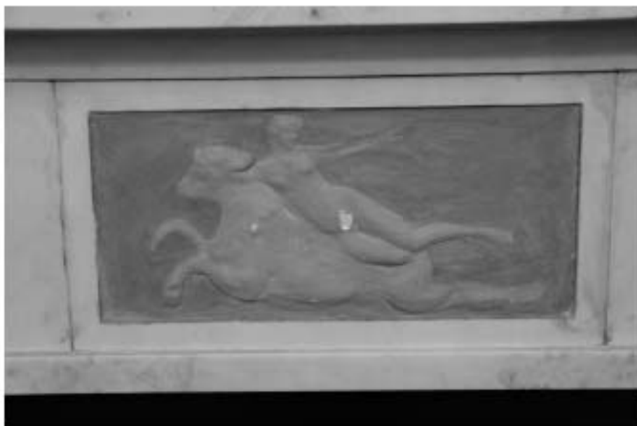
61. «Особняк Штифтер», ул. Моховая, д.15, лит.А. Помещение.2.6. Фрагмент. Фото 01.12.2020г.
