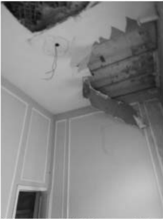
163. «Особняк Штифтер», ул. Моховая, д.15, лит.А. Помещение 4.14. Фрагмент. Фото 01.12.2020г.
