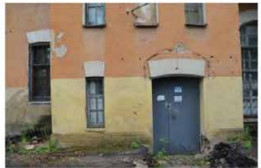
дверной проем юго-западной раскреповки с лучковой перемычкой, декорированной штукатурной разделкой под кирпич - габариты, местоположение;
