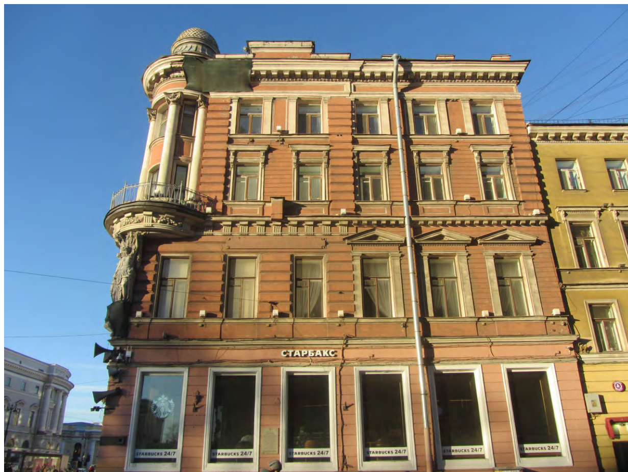
4. Восточная сторона фасада, общий вид. Дата фотофиксации: 02.09.2020 г.
