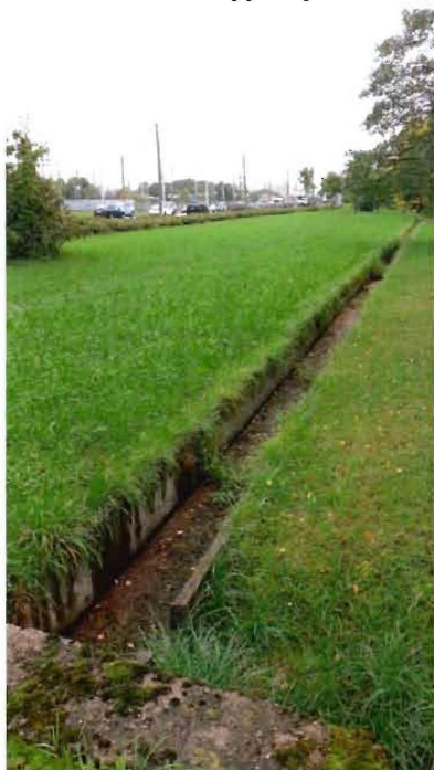
27. Водосбросный лоток в северной части территории
