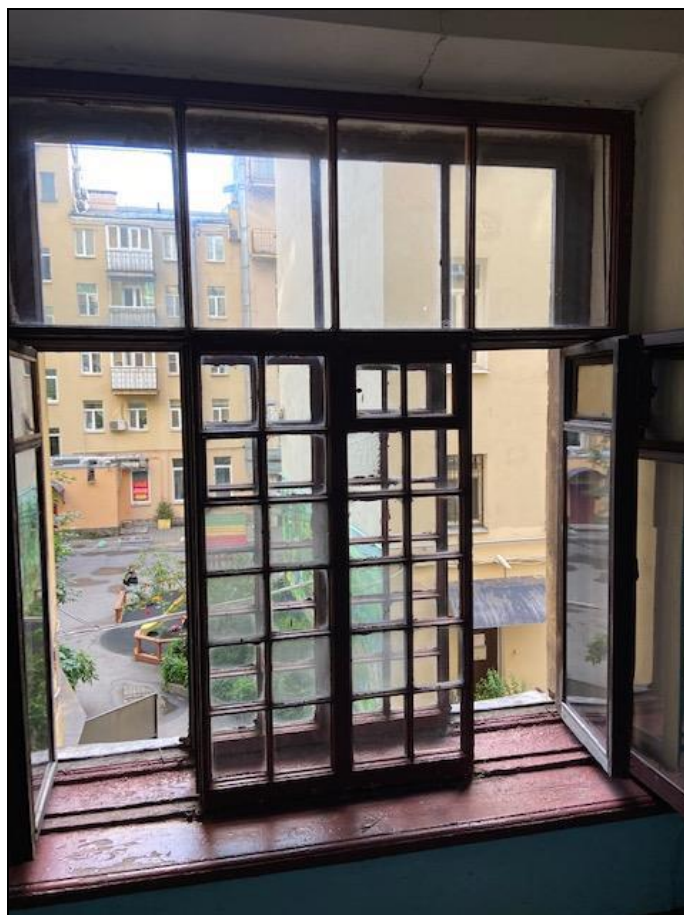
29. Флигель. Окно лестничной клетки. Дата съемки: 19 октября 2020 г. Фотограф: В. П. Орлов.
