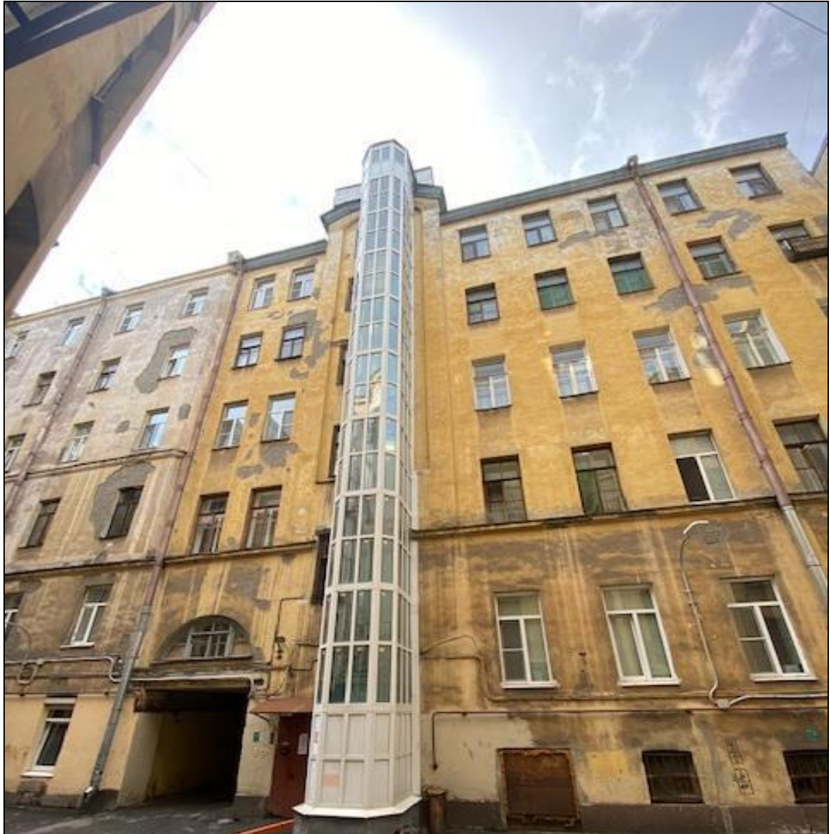
25. Вид на южный фасад поперечного флигеля. Дата съемки: 19 октября 2020 г. Фотограф: В. П. Орлов.
