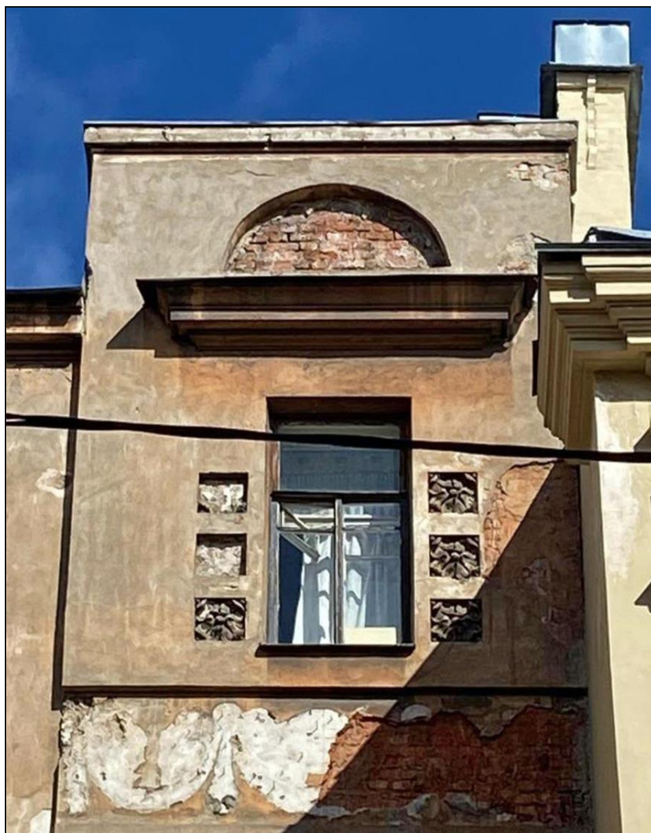
20. Лицевой фасад по Канонерской улице. Фрагмент. Оформление оконного проема в уровне пятого этажа. Дата съемки: 19 октября 2020 г. Фотограф: В. П. Орлов.
