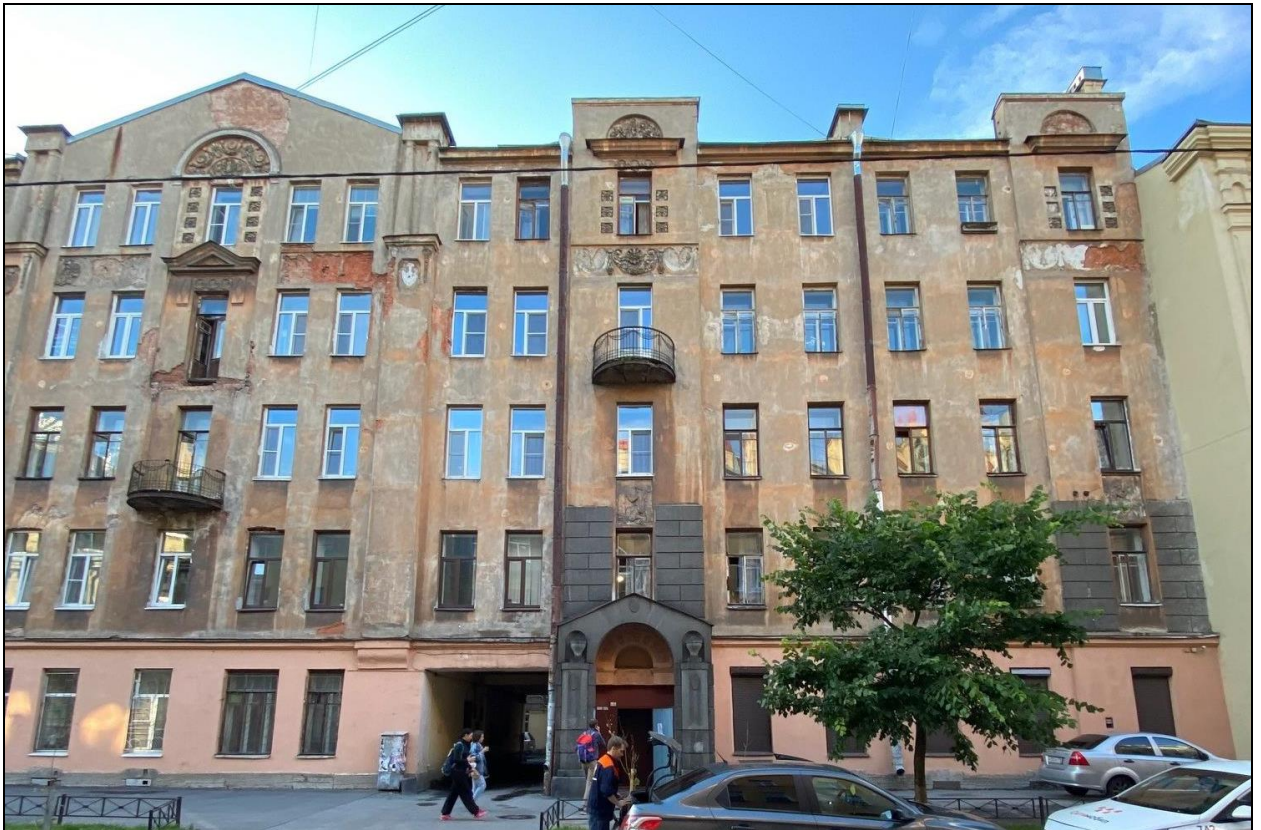
3. Выявленный объект культурного наследия «Дом Т. М. Любищевой». Лицевой фасад по Канонерской улице. Правая часть. Дата съемки: 19 октября 2020 г. Фотограф: В. П. Орлов.
