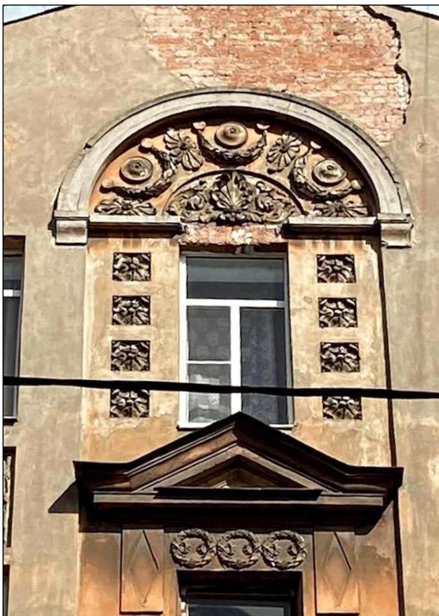
18. Лицевой фасад по Канонерской улице. Фрагмент. Оформление оконного проема в уровне пятого этажа. Дата съемки: 19 октября 2020 г. Фотограф: В. П. Орлов.
