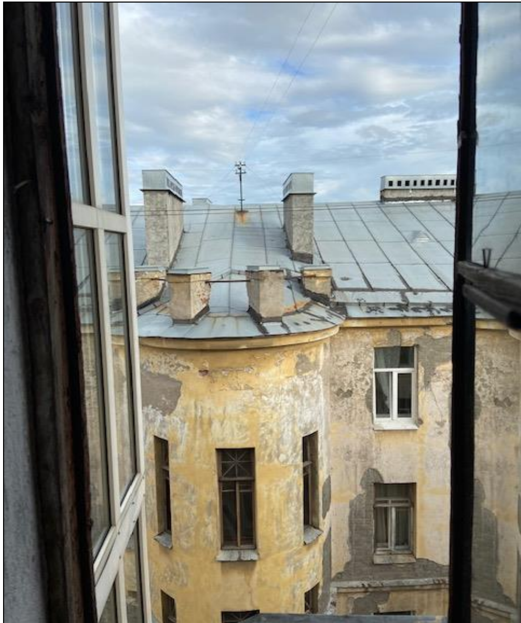
24. Дворовый фасад лицевого дома в уровне 4–5 этажа и крыша. Фрагмент. Дата съемки: 19 октября 2020 г. Фотограф: В. П. Орлов.
