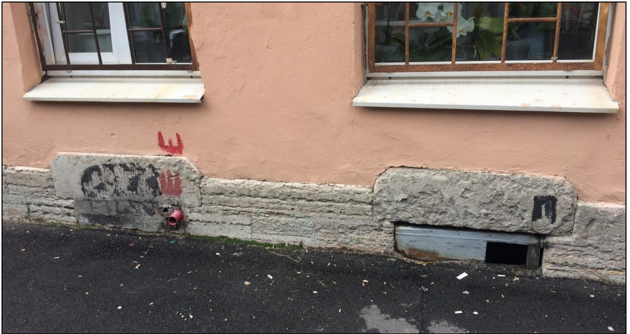
5. Выявленный объект культурного наследия «Дом Т. М. Любищевой». Лицевой фасад по Канонерской улице в уровне первого этажа. Фрагмент. Заложенные окна полуподвального этажа. Дата съемки: 19 октября 2020 г. Фотограф: В. П. Орлов.
