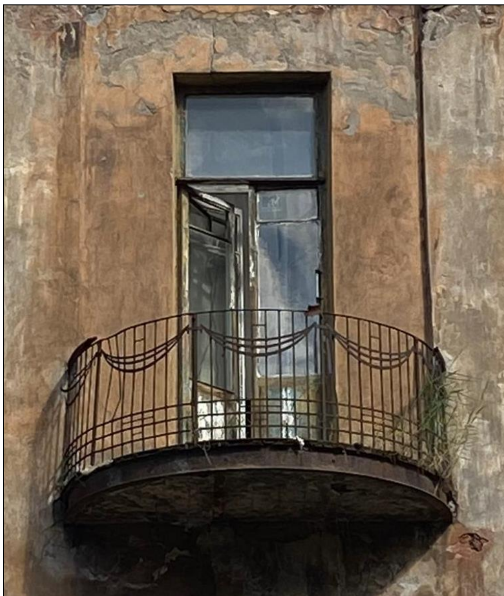
12. Лицевой фасад по Канонерской улице. Балкон с кованым металлическим ограждением в уровне третьего этажа. Дата съемки: 19 октября 2020 г. Фотограф: В. П. Орлов.
