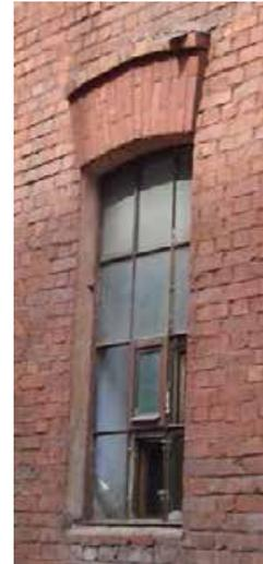
местоположение, габариты и конфигурация оконных проемов верхнего света центральной повышенной части здания: прямоугольной формы (заполнение и расстекловка утрачены);
