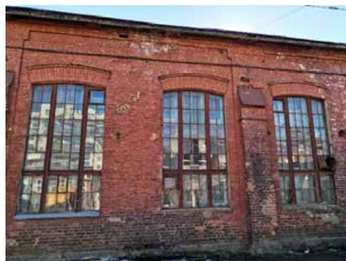
лучковые перемычки оконных проемов, выделенные всерной кирпичной кладкой;
