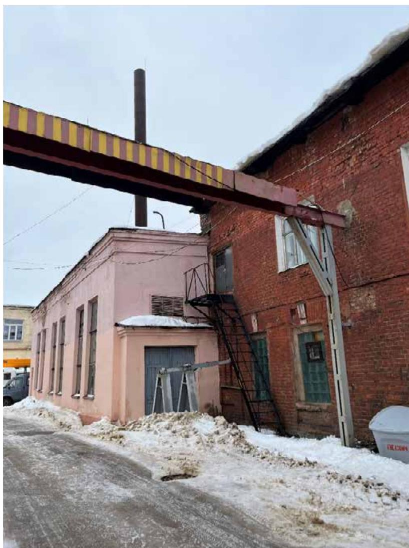
**Фото №3.** Здание депо под лит. С. Южный фасад, поздняя пристройка – оштукатурена и окрашена.
