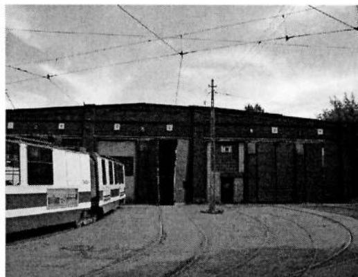
контрфорсы на всю высоту фасада в центральной части, в боковых частях в высоту воротных проемов;
