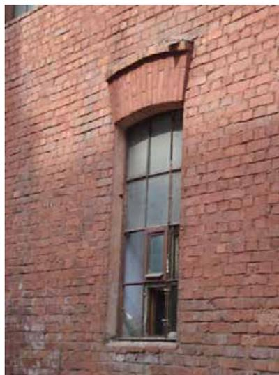
местоположение, габариты и конфигурация оконных проемов верхнего света центральной повышенной части здания: прямоугольной формы (заполнение и расстекловка утрачены);
