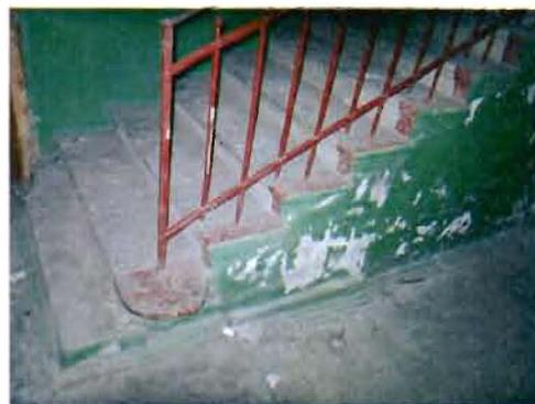
лестница в северной части здания: тип – трехмаршевая по косоурам с площадками на сводах; ступени – материал (лещадная плита), профиль; ограждения - материал (металл), рисунок (вертикальные стойки); поручень (материал – дерево, профиль);
