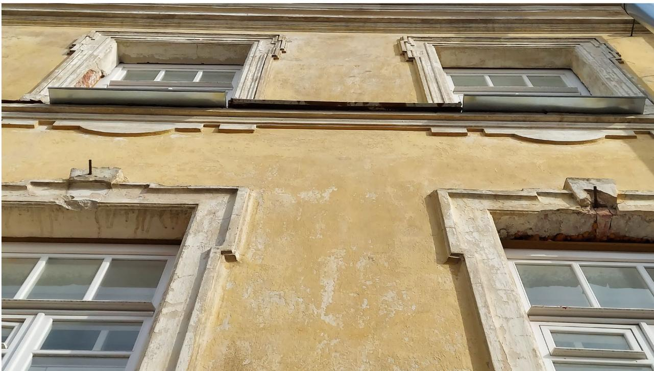
Фото 12. Стена, фрагмент, главного фасада дома по ул. Михайловская. Видна частичная утрата элементов декора (части наличников, замковые камни). Типичные элементы Петровского Барокко в отделке.
