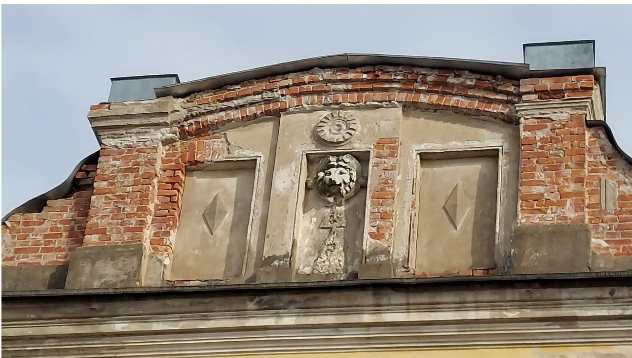
Фото 13. Аттик дома на главном фасаде. Разрушение штукатурного слоя, кирпичной кладки и лепного декора. Обратите внимание на лепной декор ниже маски льва.
