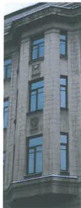
исторический входной проем в нише – его местоположение, конфигурация (прямоугольный), габариты, оформление в виде стилизованного портала с рустованными лопатками и филенчатым фризом (контррельефные филенки с картушем, гирляндами, лентой и завитками – по бокам, центральная филенка в профилированном обрамлении – с рельефным маскароном Горгоны Медузы с провисающими гирляндами);
