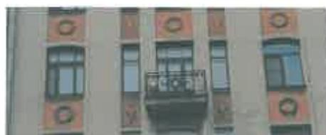
оконные заполнения – цвет (коричневый), рисунок (трехчастный с фрамугой мелкой расстекловкой; Т-образный с фрамугой мелкой геометрической расстекловки; Т-образный с трельяжной расстекловкой фрамуги;);
