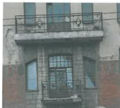
ограждение из черного металла, техника исполнения (прокат, литье, ковка), рисунок ограждения (стержни прямоугольного сечения с наложенными на них: тремя ромбами (лавровый венок и восьмилепестковые розетки в центре ромбов);
