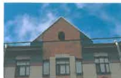
проем балконной двери в уровне 2-го этажа, габариты, конфигурация (проем фланкирован двумя щелевидными оконными проемами- дверной и оконные проемы объединенными лучковой перемычкой);
