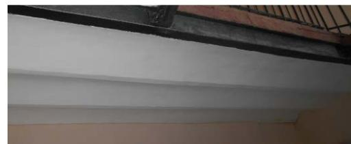
южная лестница - тип (двухмаршевая, распашная), конструкция (площадки на прусских (по балкам сводах), марши на оштукатуренных косоурах), материал ступеней (плиты из известняка), профиль ступеней;
