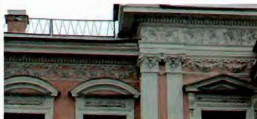
рустованные лопатки – в крайних осях фасада в уровне 1-го этажа;
