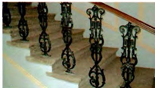
лестница № 1 – местоположение, габариты, конфигурация, тип (многомаршевая), конструкция (на косоурах), материал ступеней (известняк), ограждение – материал (металл), техника исполнения (литье), рисунок, материал покрытия пола площадок (известняк);
