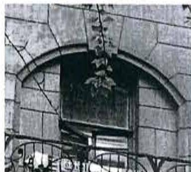
оконные проемы – местоположение, конфигурация (прямоугольная, с полуциркульным, лучковым завершением), габариты; историческое заполнение оконных проемов – рисунок, цвет (коричневый);
