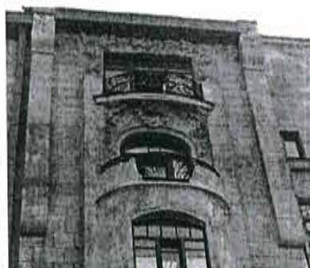
венчающий профилированный карниз с выносом и филенчатой подшивкой;
