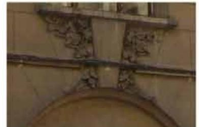
оформление пяти эркеров – стилизованные трехчетвертные колонны, выступающие карнизы, фигурные филонки в подоконном пространстве, подоконных проемов, штукатурные кронштейны;
