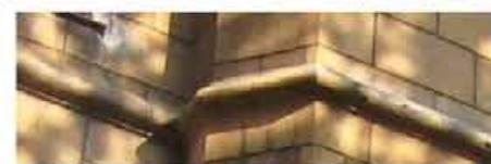
венчающий профилированный карниз с выносом и филончатой подшивкой;
