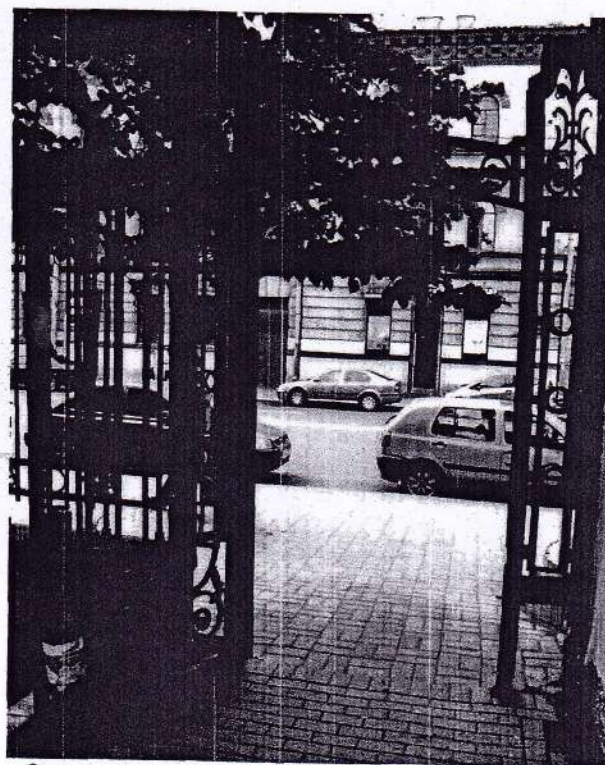
Ограда со стороны Кирочной ул. Фрагмент. Калитка. Съёмка 26.06.2012, Ю.Г. Матвеева
