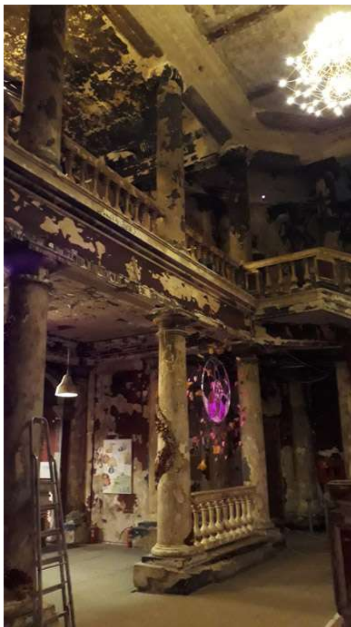
Фото 10. Объект культурного значения федерального значения «Церковь», 1775-1779гг, арх. Фельтон Ю.М., 1939г. арх. Гегелло А.И, арх. Косвен Л.С., по адресу: г. Санкт-Петербург, ул. Кирочная, дом 8, лит. В, входящего в состав объекта культурного наследия федерального значения "Церковь евангелическо-лютеранская Святой Анны" по адресу: г. Санкт-Петербург, Кирочная ул., дом 8, Фурштатская ул., между домами 7 и 9.
