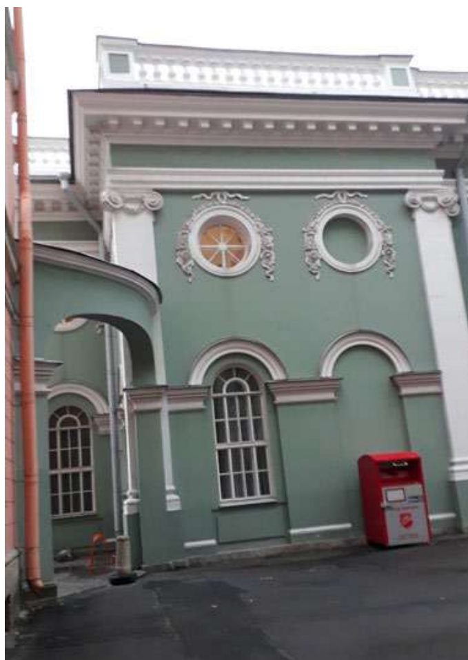
Фото 3. Объект культурного значения федерального значения «Церковь», 1775-1779гг, арх. Фельтон Ю.М., 1939г. арх. Гегелло А.И, арх. Косвен Л.С., по адресу: г. Санкт-Петербург, ул. Кирочная, дом 8, лит. В, входящего в состав объекта культурного наследия федерального значения "Церковь евангелическо-лютеранская Святой Анны" по адресу: г. Санкт-Петербург, Кирочная ул., дом 8, Фурштатская ул., между домами 7 и 9.
