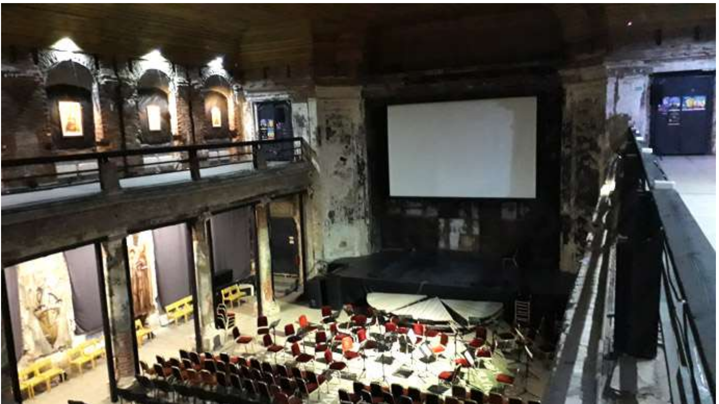
Фото 23. Объект культурного значение федерального значения «Церковь» , 1775-1779гг, арх. Фельтон Ю.М., 1939г. арх. Гегелло А.И, арх. Косвен Л.С., по адресу: г. Санкт-Петербург, ул. Кировная , дом 8, лит. В, входящего в состав объекта культурного наследия федерального значения "Церковь евангелическо-лютеранская Святой Анны" по адресу: г. Санкт-Петербург, Кировная ул., дом 8, Фурштатская ул., между домами 7 и 9 .
