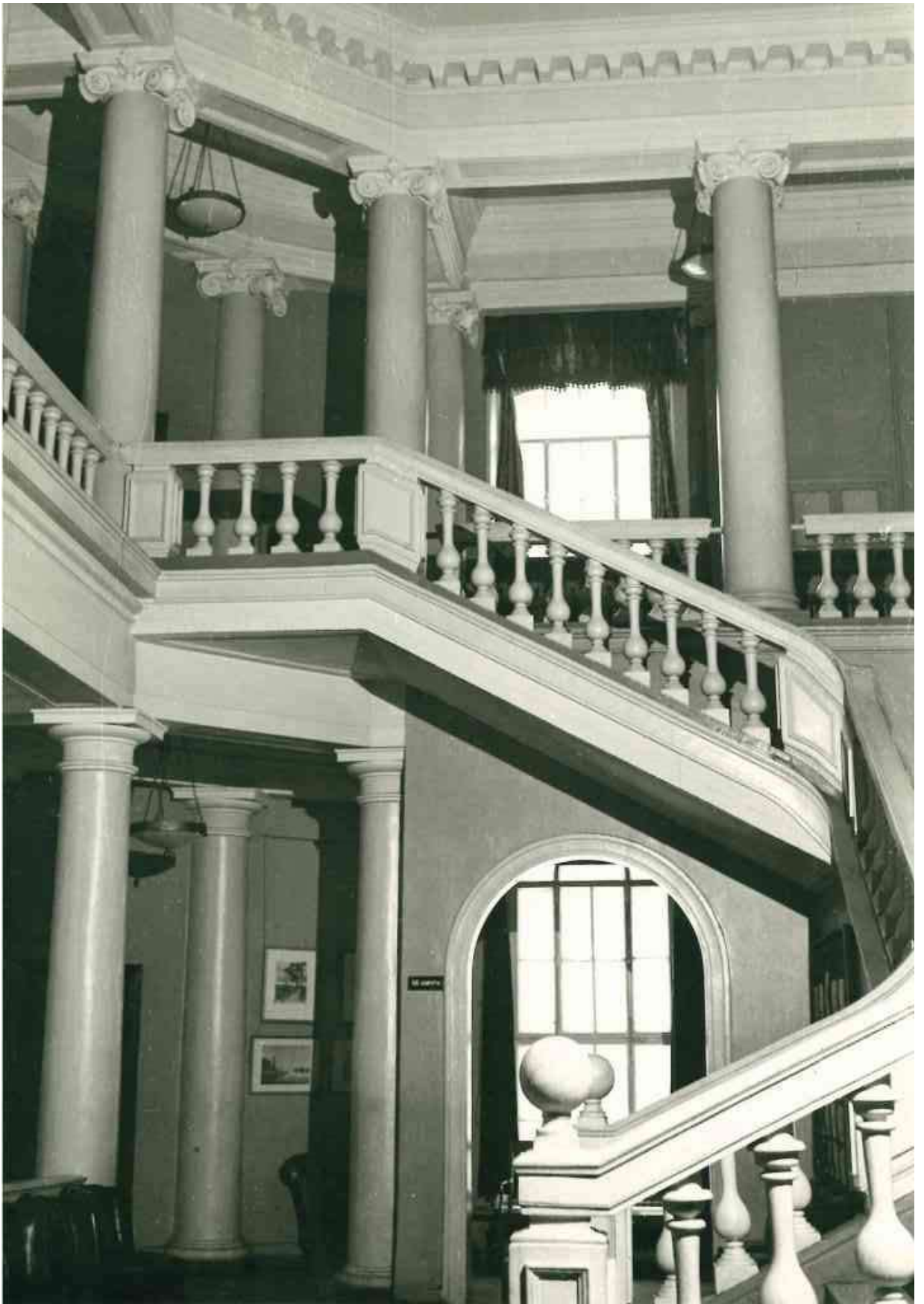
Рис. 49. Лестница на галерею в вестибюле кинотеатра. 1951 г. Архив КГИОП
