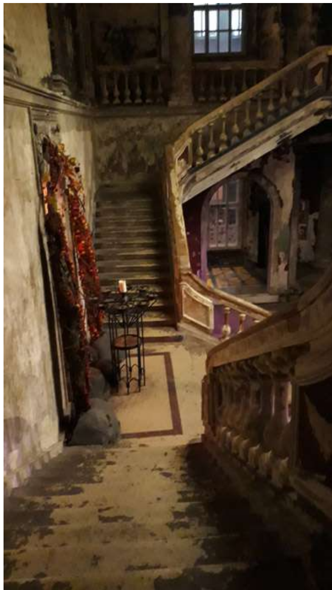
Фото 13. Объект культурного значения федерального значения «Церковь», 1775-1779гг, арх. Фельтон Ю.М., 1939г. арх. Гегелло А.И, арх. Косвен Л.С., по адресу: г. Санкт-Петербург, ул. Кирочная, дом 8, лит. В, входящего в состав объекта культурного наследия федерального значения "Церковь евангелическо-лютеранская Святой Анны" по адресу: г. Санкт-Петербург, Кирочная ул., дом 8, Фурштатская ул., между домами 7 и 9 .
