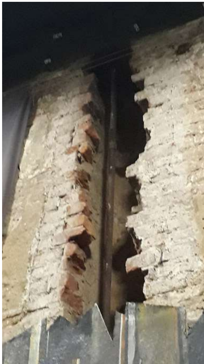
Фото 26. Объект культурного значения федерального значения «Церковь», 1775-1779гг, арх. Фельтон Ю.М., 1939г. арх. Гегелло А.И, арх. Косвен Л.С., по адресу: г. Санкт-Петербург, ул. Кирочная, дом 8, лит. В, входящего в состав объекта культурного наследия федерального значения "Церковь евангелическо-лютеранская Святой Анны" по адресу: г. Санкт-Петербург, Кирочная ул., дом 8, Фурштатская ул., между домами 7 и 9.
