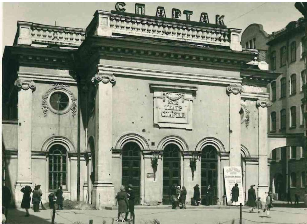
Рис. 27. Южный фасад. Фотография 1949 г. Архив КГИОП
