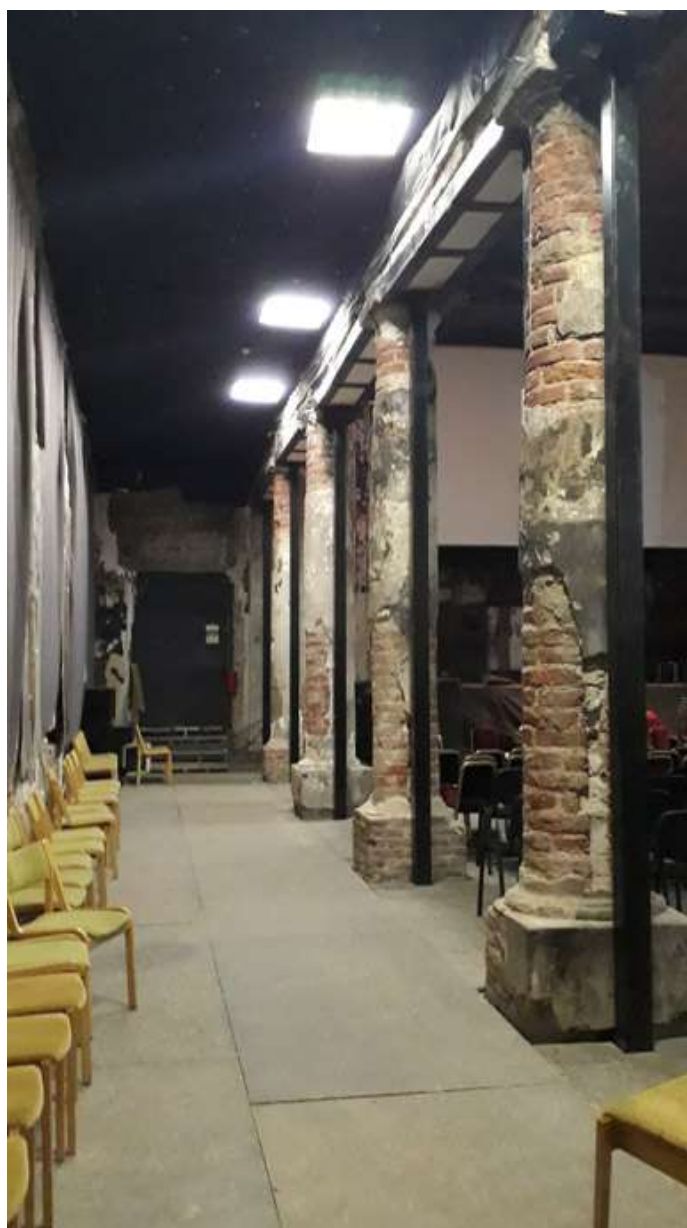
Фото 28. Объект культурного значения федерального значения «Церковь», 1775-1779гг, арх. Фельтон Ю.М., 1939г. арх. Гегелло А.И, арх. Косвен Л.С., по адресу: г. Санкт-Петербург, ул. Кирочная, дом 8, лит. В, входящего в состав объекта культурного наследия федерального значения "Церковь евангелическо-лютеранская Святой Анны" по адресу: г. Санкт-Петербург, Кирочная ул., дом 8, Фурштатская ул., между домами 7 и 9.
