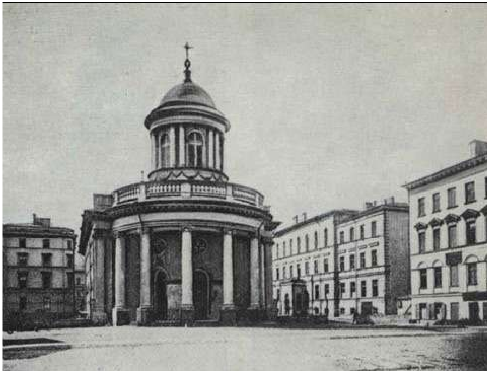
Рис. 18. Церковь св. Анны. Вид с Фурштадской улицы на юго-запад. Фотография нач. XX в. ЦГА КФФД
