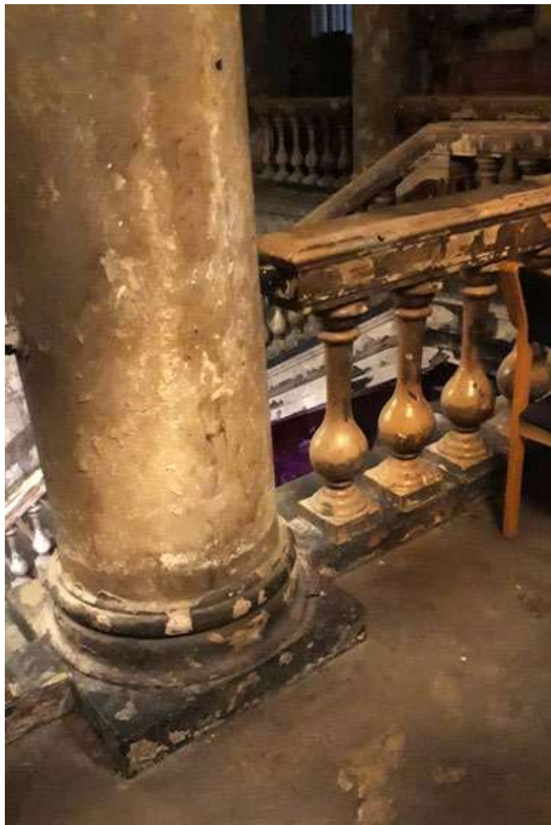
Фото 16. Объект культурного значения федерального значения «Церковь», 1775-1779гг, арх. Фельтон Ю.М., 1939г. арх. Гегелло А.И, арх. Косвен Л.С., по адресу: г. Санкт-Петербург, ул. Кирочная, дом 8, лит. В, входящего в состав объекта культурного наследия федерального значения "Церковь евангелическо-лютеранская Святой Анны" по адресу: г. Санкт-Петербург, Кирочная ул., дом 8, Фурштатская ул., между домами 7 и 9.
