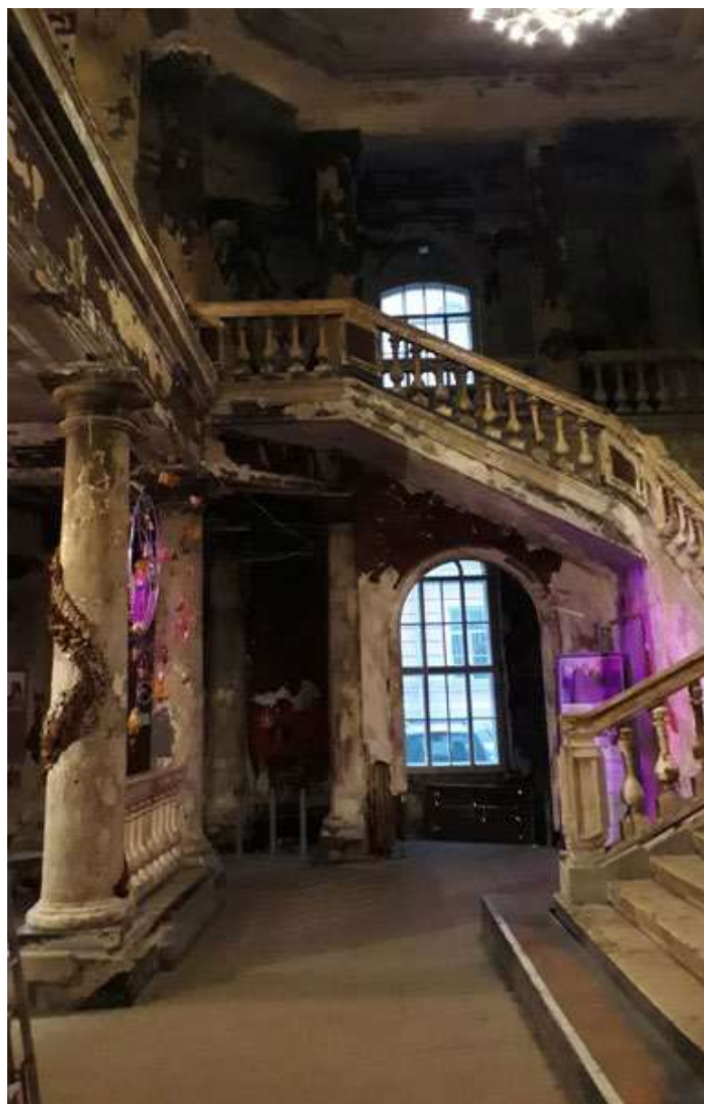
Фото 8. Объект культурного значения федерального значения «Церковь», 1775-1779гг, арх. Фельтон Ю.М., 1939г. арх. Гегелло А.И, арх. Косвен Л.С., по адресу: г. Санкт-Петербург, ул. Кирочная, дом 8, лит. В, входящего в состав объекта культурного наследия федерального значения "Церковь евангелическо-лютеранская Святой Анны" по адресу: г. Санкт-Петербург, Кирочная ул., дом 8, Фурштатская ул., между домами 7 и 9 .
