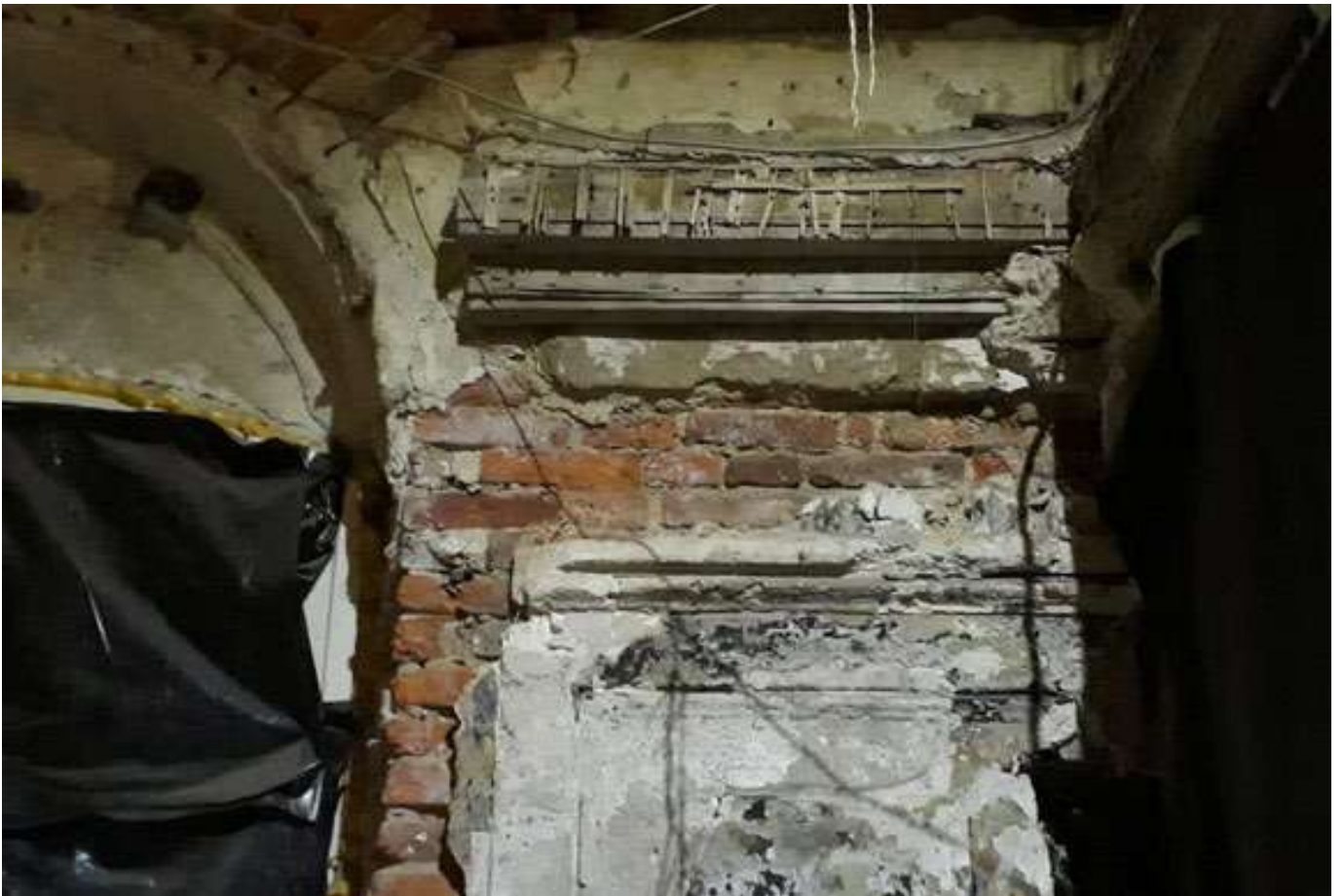
Фото 22. Объект культурного значения федерального значения «Церковь», 1775-1779гг, арх. Фельтон Ю.М., 1939г. арх. Гегелло А.И, арх. Косвен Л.С., по адресу: г. Санкт-Петербург, ул. Кирочная, дом 8, лит. В, входящего в состав объекта культурного наследия федерального значения "Церковь евангелическо-лютеранская Святой Анны" по адресу: г. Санкт-Петербург, Кирочная ул., дом 8, Фурштатская ул., между домами 7 и 9.
