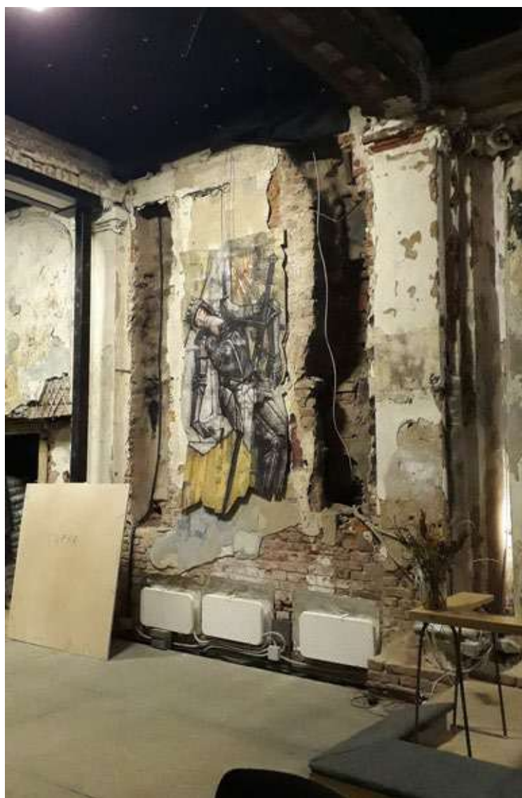
Фото 27. Объект культурного значения федерального значения «Церковь», 1775-1779гг, арх. Фельтон Ю.М., 1939г. арх. Гегелло А.И, арх. Косвен Л.С., по адресу: г. Санкт-Петербург, ул. Кирочная, дом 8, лит. В, входящего в состав объекта культурного наследия федерального значения "Церковь евангелическо-лютеранская Святой Анны" по адресу: г. Санкт-Петербург, Кирочная ул., дом 8, Фурштатская ул., между домами 7 и 9.
