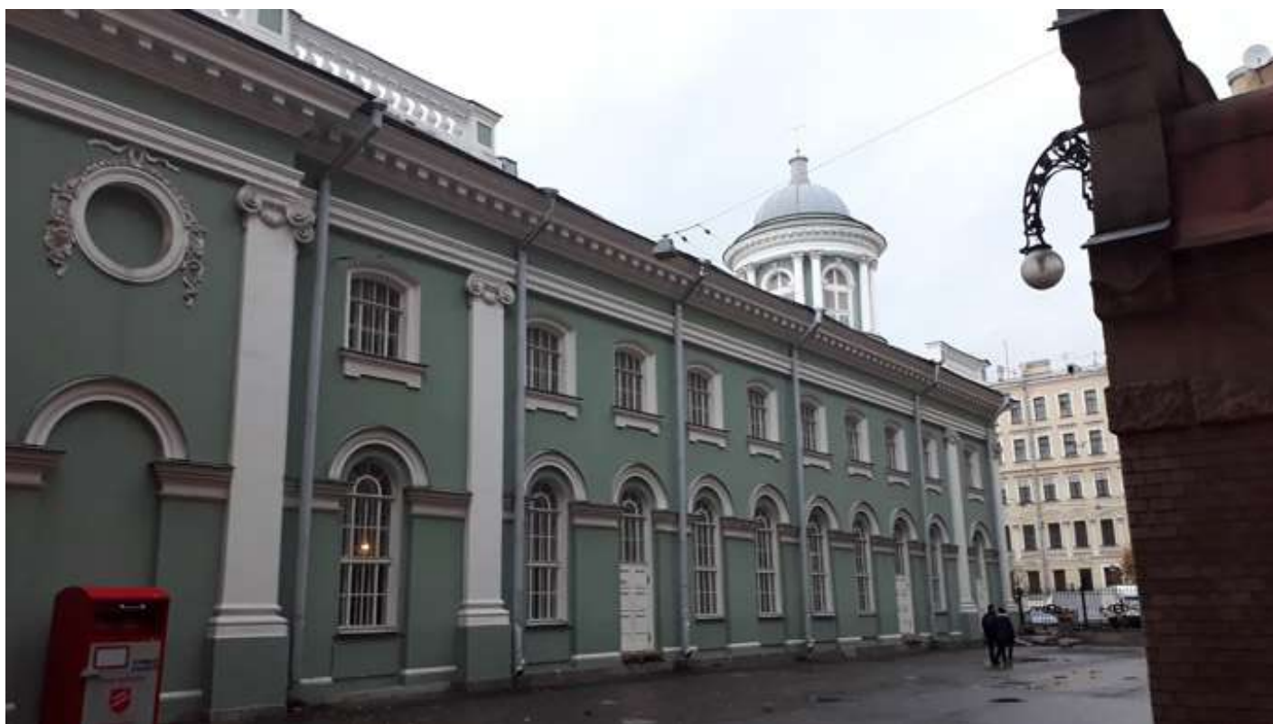
Фото 2. Объект культурного значения федерального значения «Церковь», 1775-1779гг, арх. Фельтон Ю.М., 1939г. арх. Гегелло А.И, арх. Косвен Л.С., по адресу: г. Санкт-Петербург, ул. Кирочная, дом 8, лит. В, входящего в состав объекта культурного наследия федерального значения "Церковь евангелическо-лютеранская Святой Анны" по адресу: г. Санкт-Петербург, Кирочная ул., дом 8, Фурштатская ул., между домами 7 и 9.
