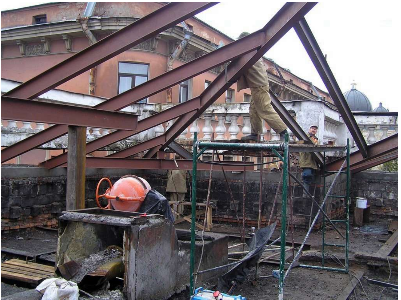
Рис. 98. Кинотеатр «Спартак» 2008 г. Работы по замене стропильной системы крыши Интернет-ресурс.
