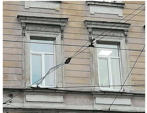
оформление окон четвертого этажа профилированными наличниками с изломом в верхней части, подоконными филенками;
