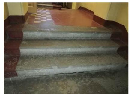
трехступенчатая лестница на первом этаже при входе в здание – профиль и материал (известняк) ступеней.
