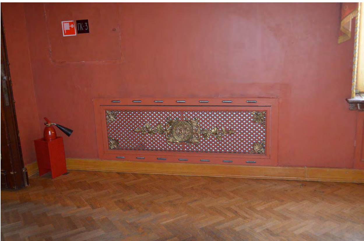
Фото 11. Дворец Юсуповых. Античная галерея. Фрагмент. Деревянная решётка радиатора (экрана). Съёмка 01.02.2022 г.
