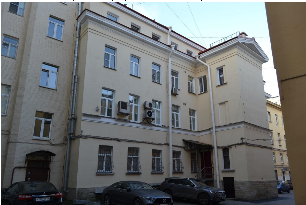
Фото 4. Южная часть дворового восточного фасада. На 3-м этаже в торцевой части ризалита оконные проемы квартиры № 47. Вид с юго-востока
