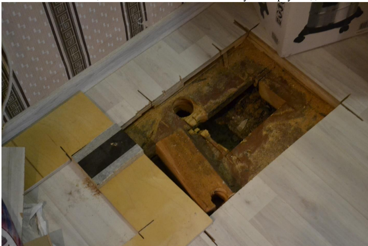
Фото 10. Участок вскрытия конструкций перекрытия под квартирой в помещении № 2. Вид с юго-востока
