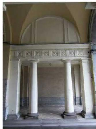
декоративное оформление стен воротного проезда – профилированные фигурные филенки в тимпанах, два ложных оконных проема в профилированном наличнике, с треугольными сандриками на орнаментированных кронштейнах;
