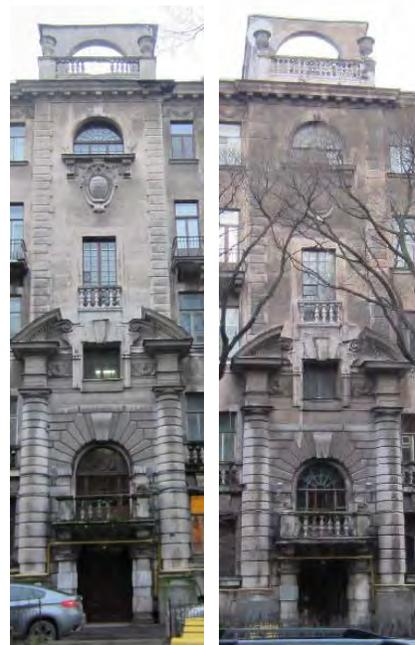
дверные проемы – габариты, конфигурация (прямоугольные), местоположение, оформление (два портала (центральные оси фасадов), фланкированные трехчетвертными колоннами с тосканскими капителями и рустованными стволами, поддерживающими отрезки антаблемента с разорванным лучковым фронтоном, веерный руст, замковые камни с гротескными маскаронами; портал (восточная часть северного фасада) рустованное обрамление, волюты, профилированный карниз, трехчастный замковый камень с гротескным маскаронном);
