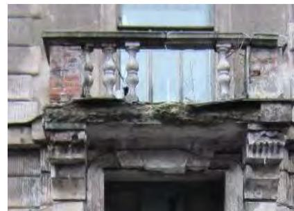
балконы на оштукатуренных кронштейнах – количество (16), местоположение (в уровне 3-4-го этажей), габариты, конфигурация (прямоугольны), ограждение – материал (металл), техника исполнения (ковка), рисунок (вертикальные стойки);
