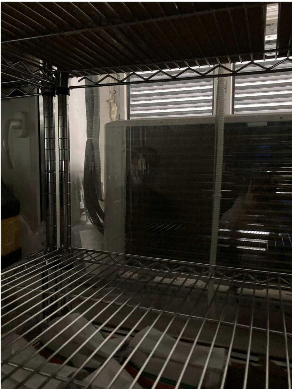
Фото 10. Литейный пр., д.46. Дворовый фасад. Заполнение окон. Наружный блок кондиционера, установленный на подставку в оконном проеме
