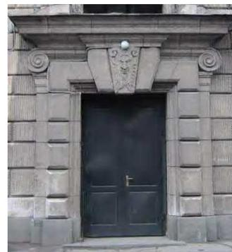
историческое заполнение дверных проемов – количество (два), конструкция (двухстворчатые, прямоугольные), оформление (профилированное обрамление с прорезкой растительного орнамента, профилированные филенки, в том числе алмазная грань), вид материала (дерево), покрытие (окраска);
