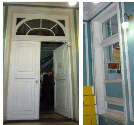
оконные проемы – количество (два), конфигурация (прямоугольный), местоположение, габариты, оформление (профилированное обрамление) историческое заполнение оконного проема - конфигурация, исторический рисунок, вид материала (дерево);
