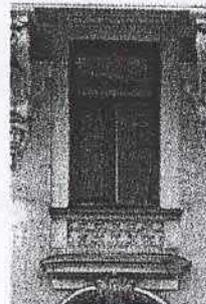
балкон – количество (один), габариты, конфигурация (прямоугольный), местоположение (в уровне 2-го этажа, по центральной оси); ограждение – конструкция (глухие опорные столбы и решетка), материал (металл), техника исполнения (ковка), рисунок (орнамент в виде завитков аканта); кронштейны – материал (оштукатурены), оформление (листья аканта, розетты, рокайли, маскароны);
