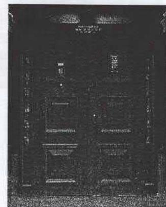
историческое заполнение дверных проемов – количество (два), конструкция (двухстворчатые, прямоугольные), оформление (профилированное обрамление с прорезкой растительного орнамента, профилированные филенки, в том числе алмазная грань), вид материала (дерево), покрытие (окраска);
