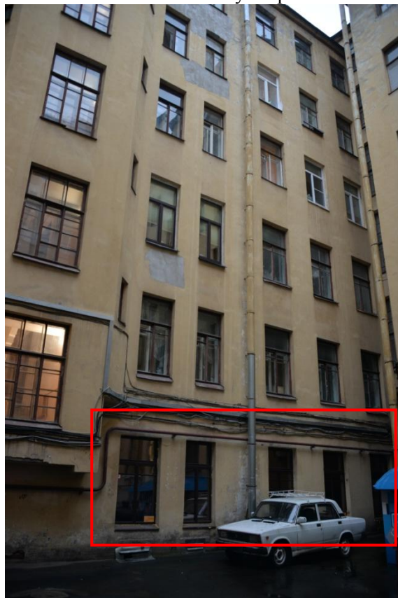
4. Фрагмент дворового фасада выявленного объекта культурного наследия «Дом Ф.Ф. Лумберга»
