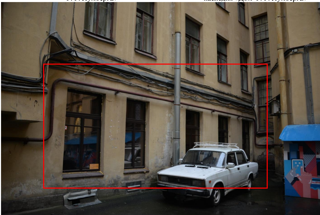
5. Фрагмент дворового фасада выявленного объекта культурного наследия «Дом Ф.Ф. Лумберга»
