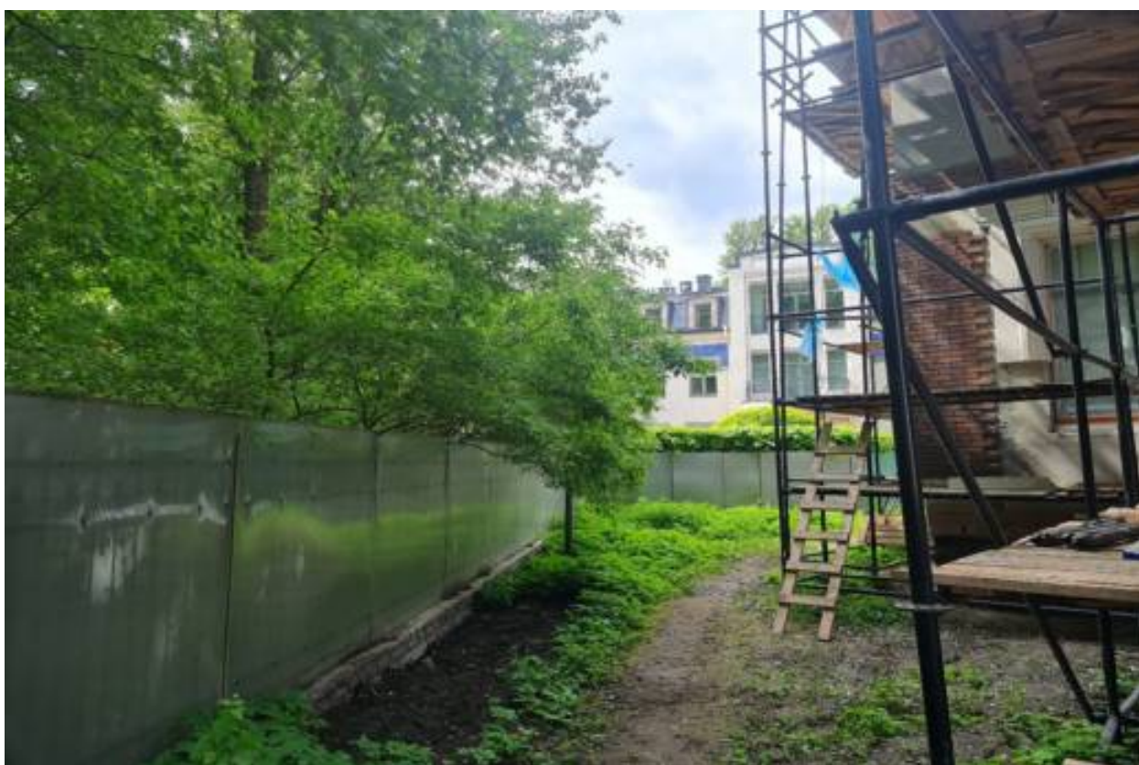
Фото 4. Южная часть земельного участка.
