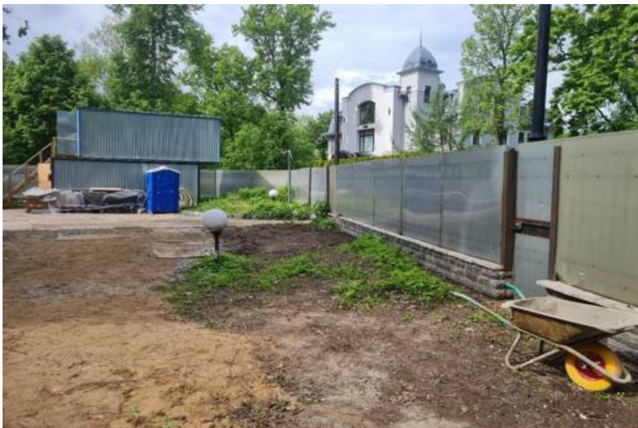
Фото 9. Северо-западная часть земельного участка (ворота и калитка).
