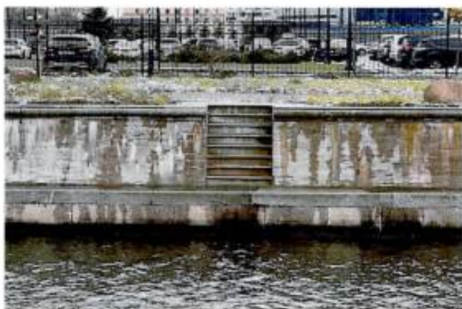
5. Общий вид на лестницу.
