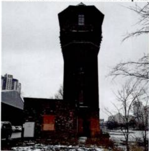
3. Общий вид с юной стороны.
