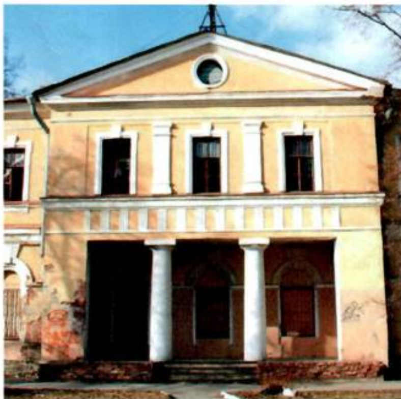
5. Ризалит южного фасада.
