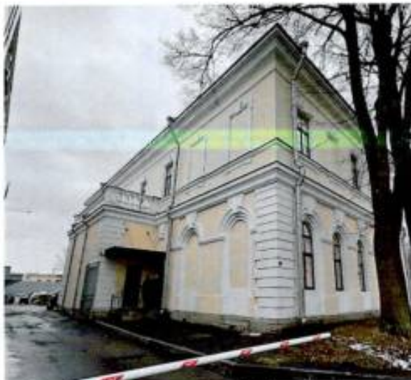
3. Общий вид на северный фасад.
