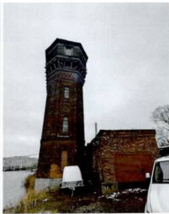
6. Общий вид на верхнюю часть башни.
