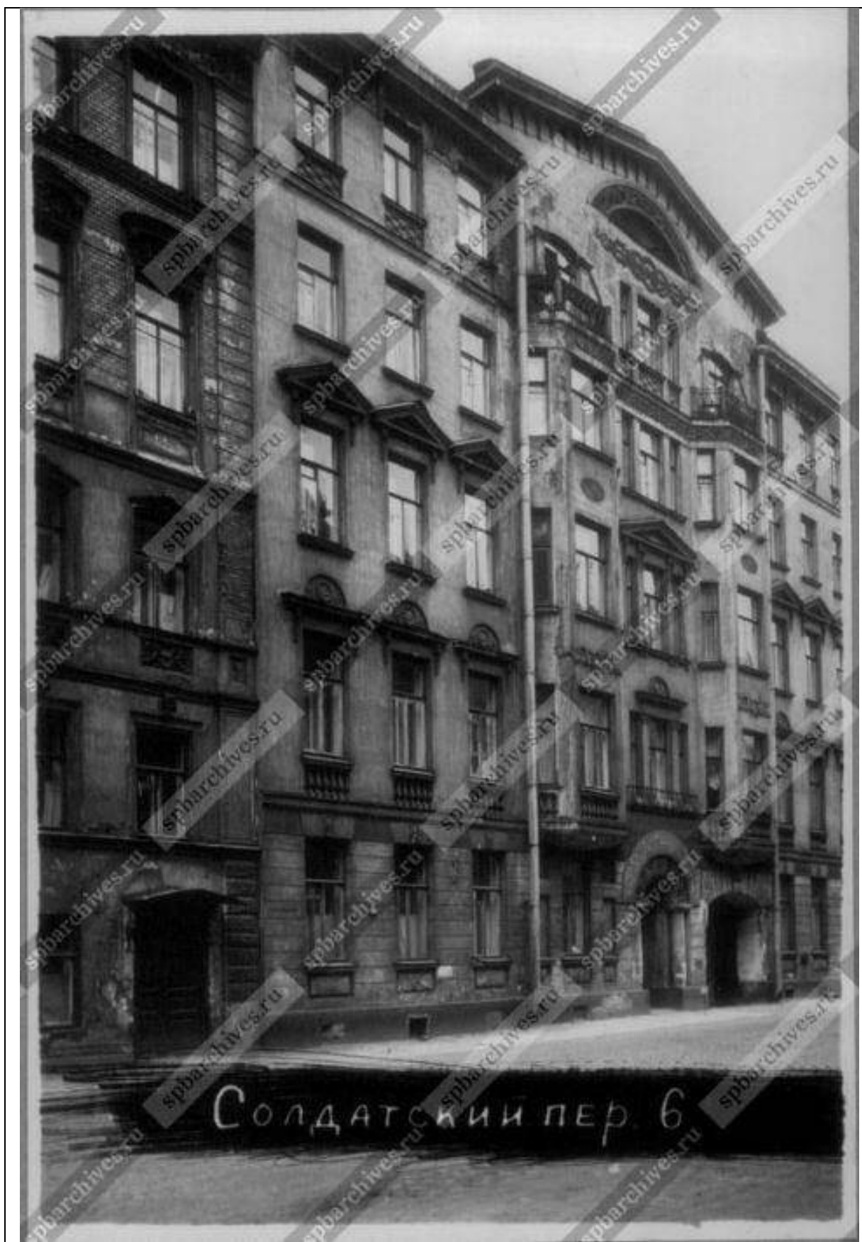
30. Фасад дома №6 по Солдатскому пер.1960 г. ЦГАКФФД СПб, №Гр57518
