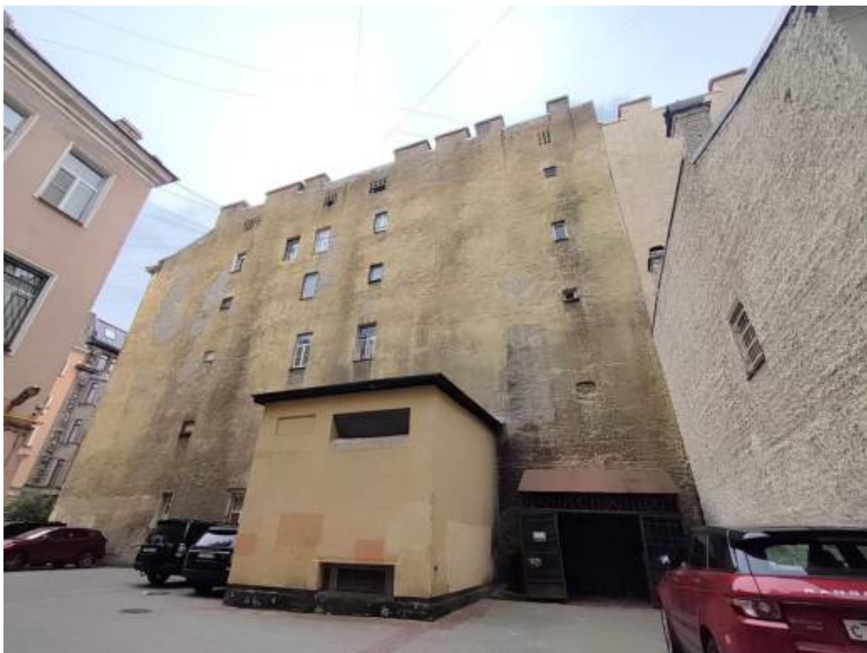
Фото 3. Вид на восточный фасад выявленного объекта культурного наследия «Дом О.Л. Чахотиной».
