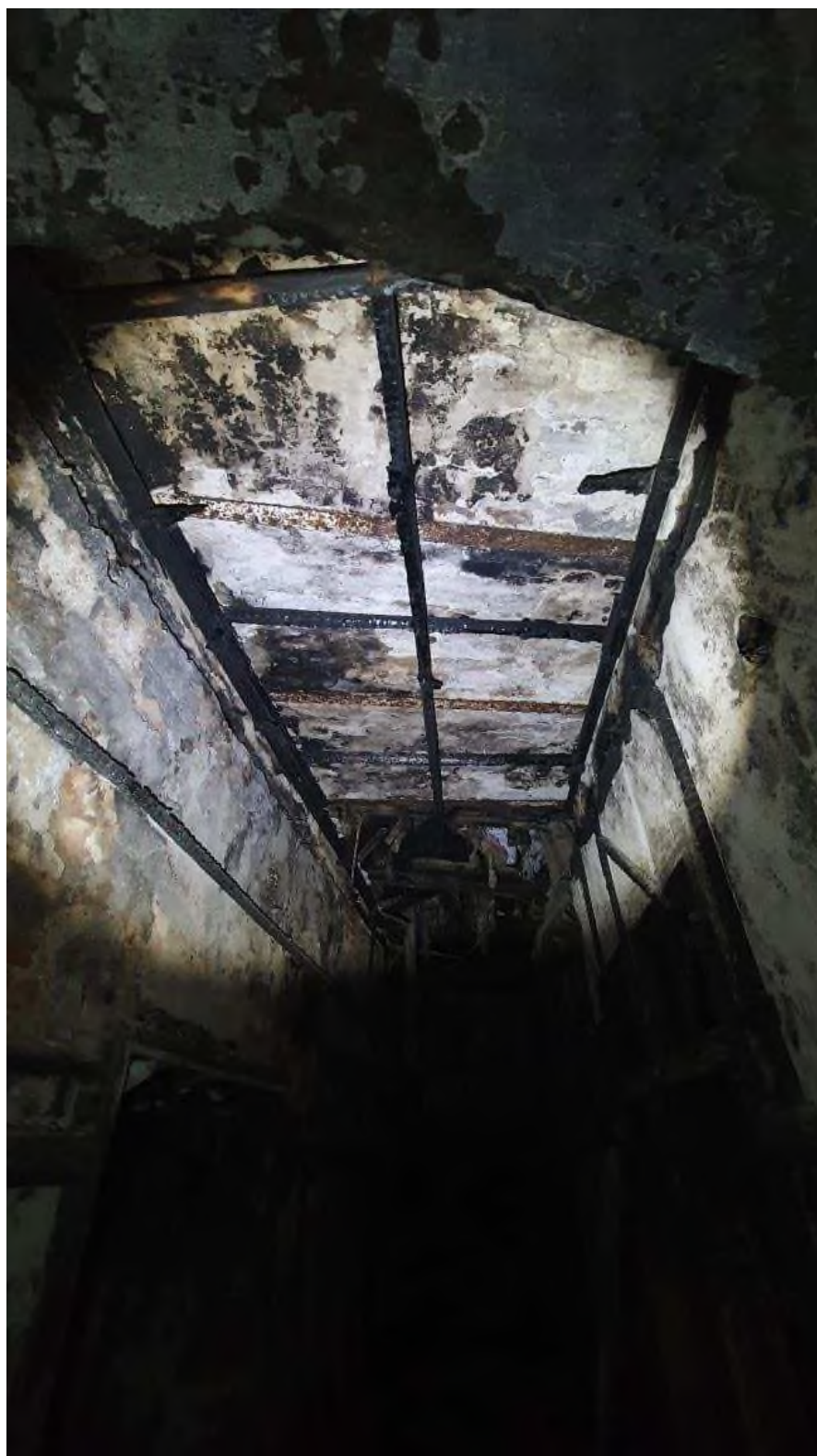
Фото 21 1-й этаж исследуемого объекта культурного наследия регионального значения «Жилой дом Степанова В.Ф.», вид в помещение коридора. Автор Митяев П.А.
