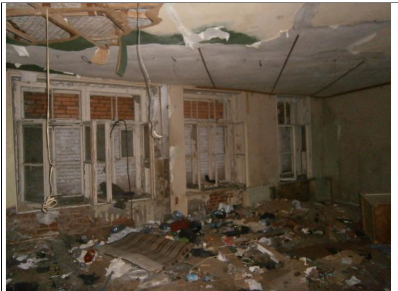
56. 2010-е г. Интерьер ОКН. Помещение первого этажа.
