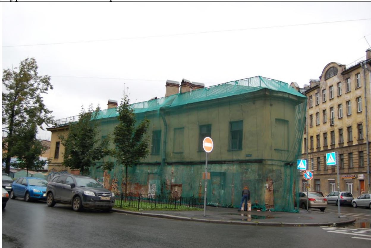
47. 2011 г. Северо-восточный фасад по улице Воронежской.
