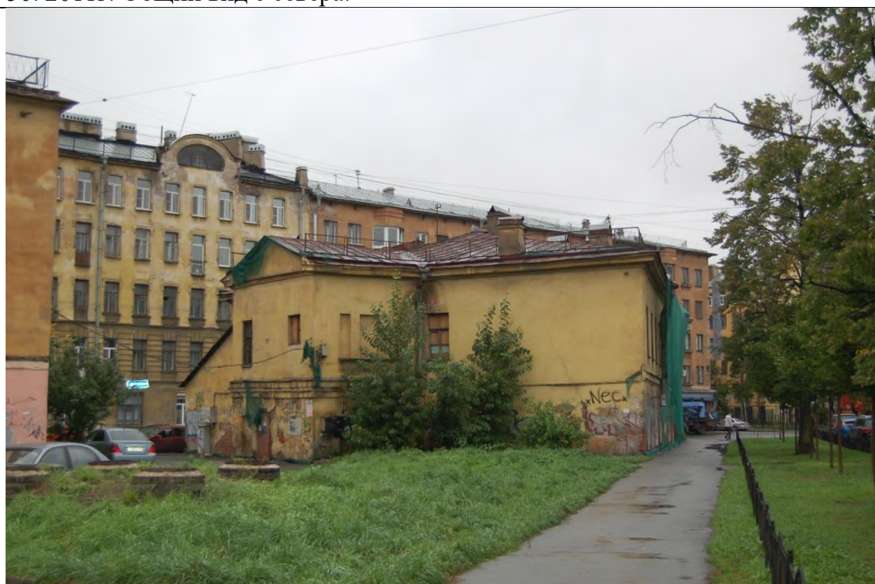
51. 2011г. Надворный южный фасад. Вид с юго-востока.
