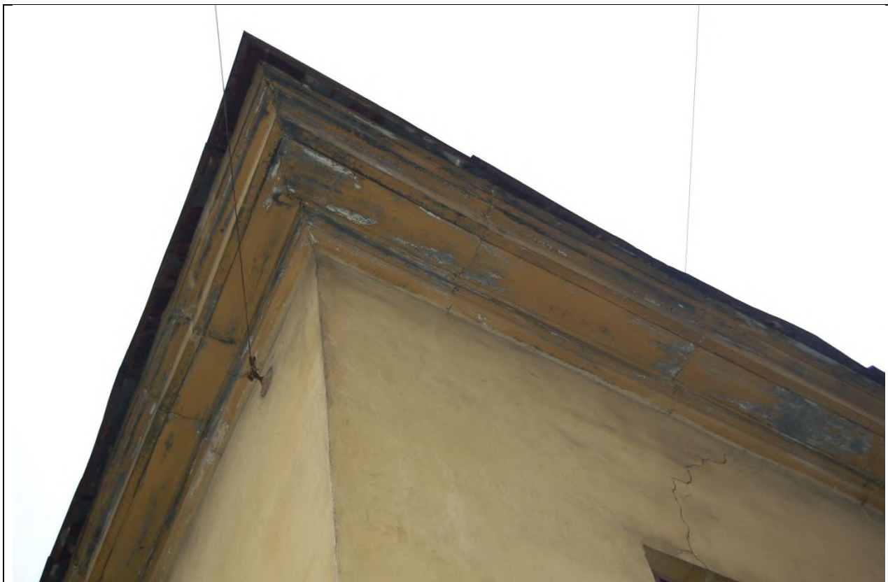
54. 2011г. Фиксационный архитектурный фрагмент ОКН. Венчающий карниз.
