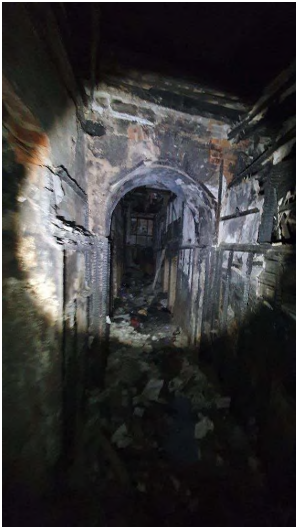
Фото 18 Цокольный этаж исследуемого объекта культурного наследия регионального значения «Жилой дом Степанова В.Ф.», кирпичная арка в коридоре. Автор Митяев П.А.
