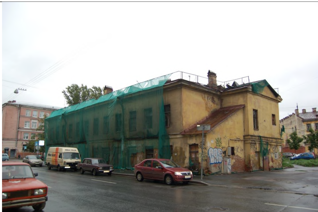
52. 2011г. Надворный южный фасад. Вид с юго-запада.
