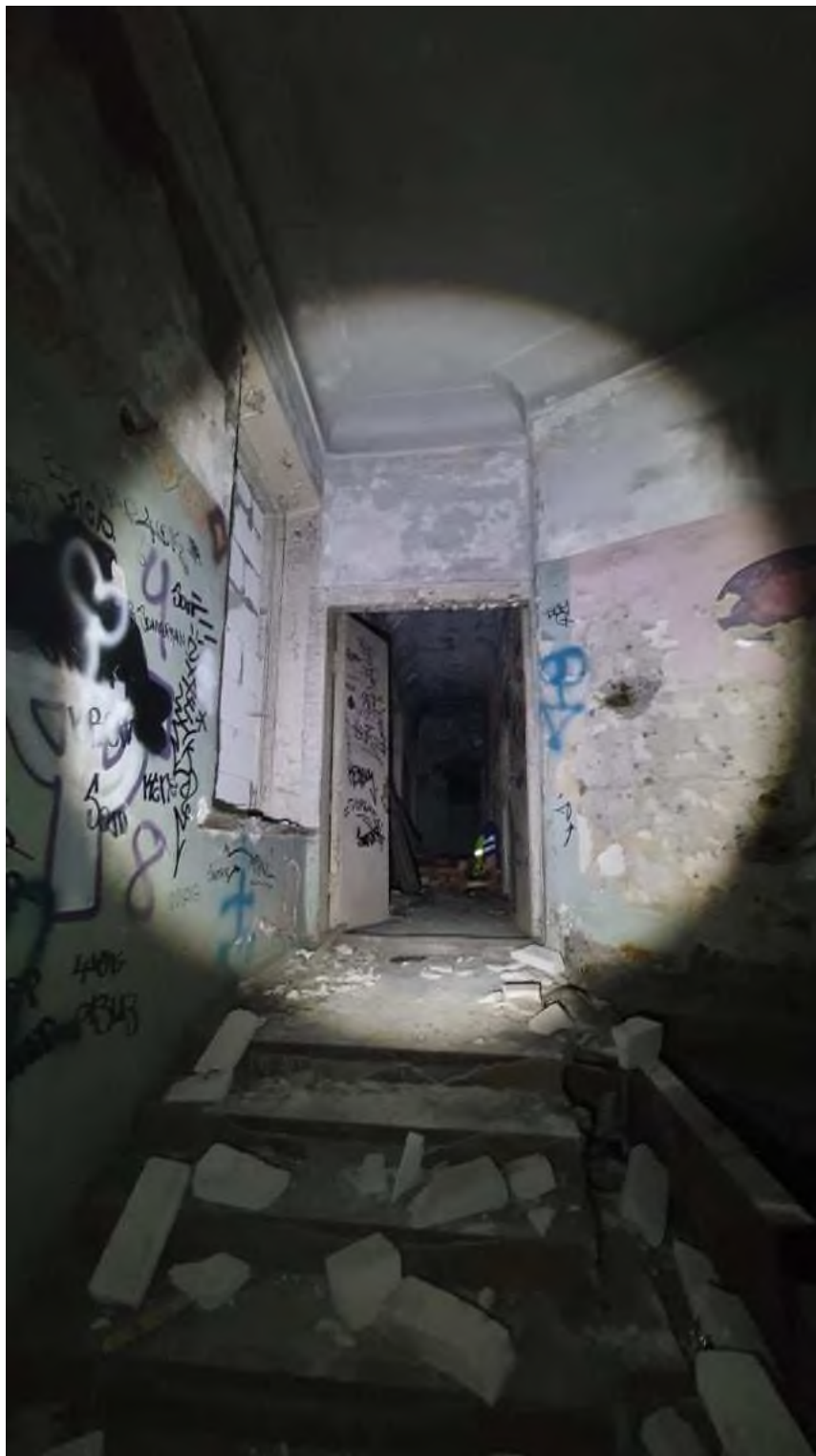
Фото 20 1-й этаж исследуемого объекта культурного наследия регионального значения «Жилой дом Степанова В.Ф.», вид в помещение коридора из углового помещения с каменной лестницей. Автор Митяев П.А.
