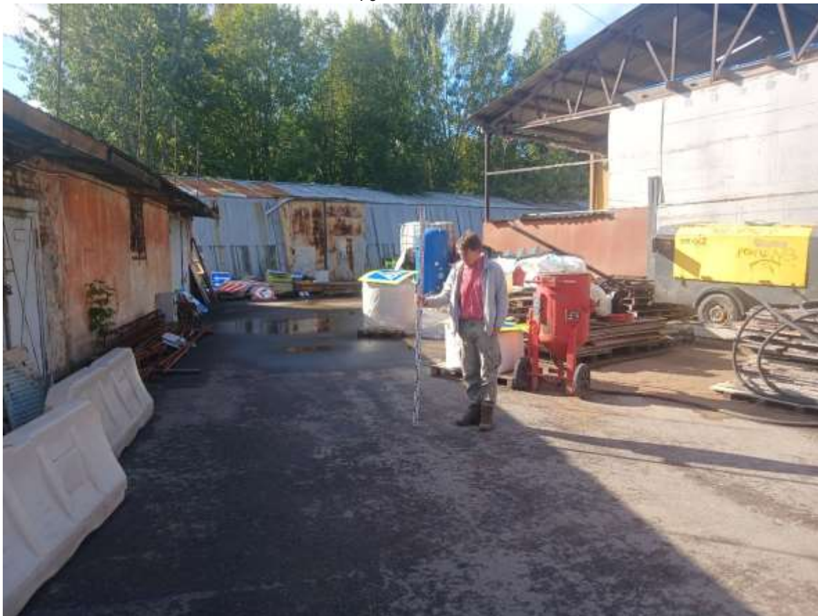
Рис. 20. Санкт-Петербург, Сердобольская улица, дом 60, литера А (кадастровый номер: 78:34:0004009:12). Общий вид участка. Точка съемки 6. Вид на юг
