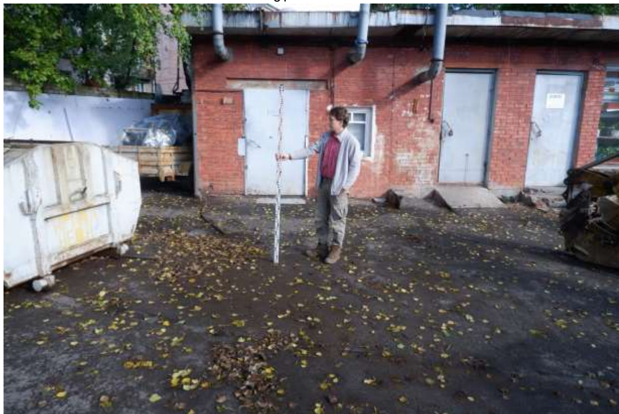
Рис. 24 Санкт-Петербург, Сердобольская улица, дом 60, литера А (кадастровый номер: 78:34:0004009:12). Шурф 1. Общий вид до начала работ. Вид на север
