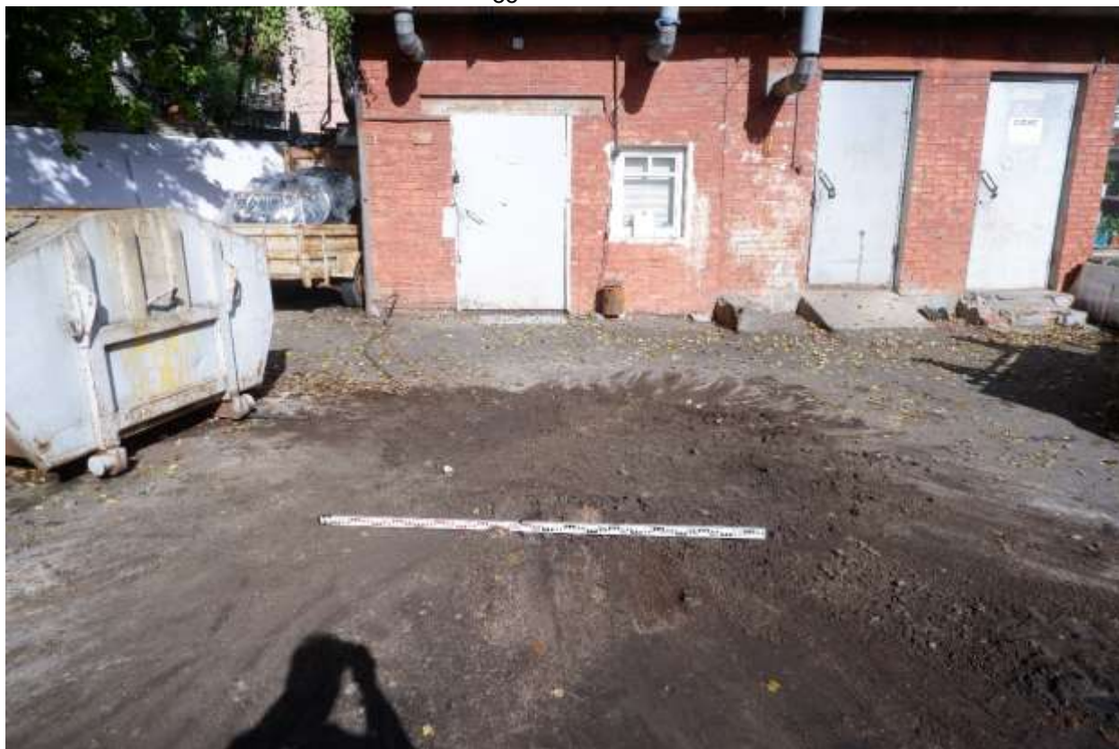
Рис. 32. Санкт-Петербург, Сердобольская улица, дом 60, литера А (кадастровый номер: 78:34:0004009:12). Шурф 1. Фотофиксация после рекультивации. Вид на север
