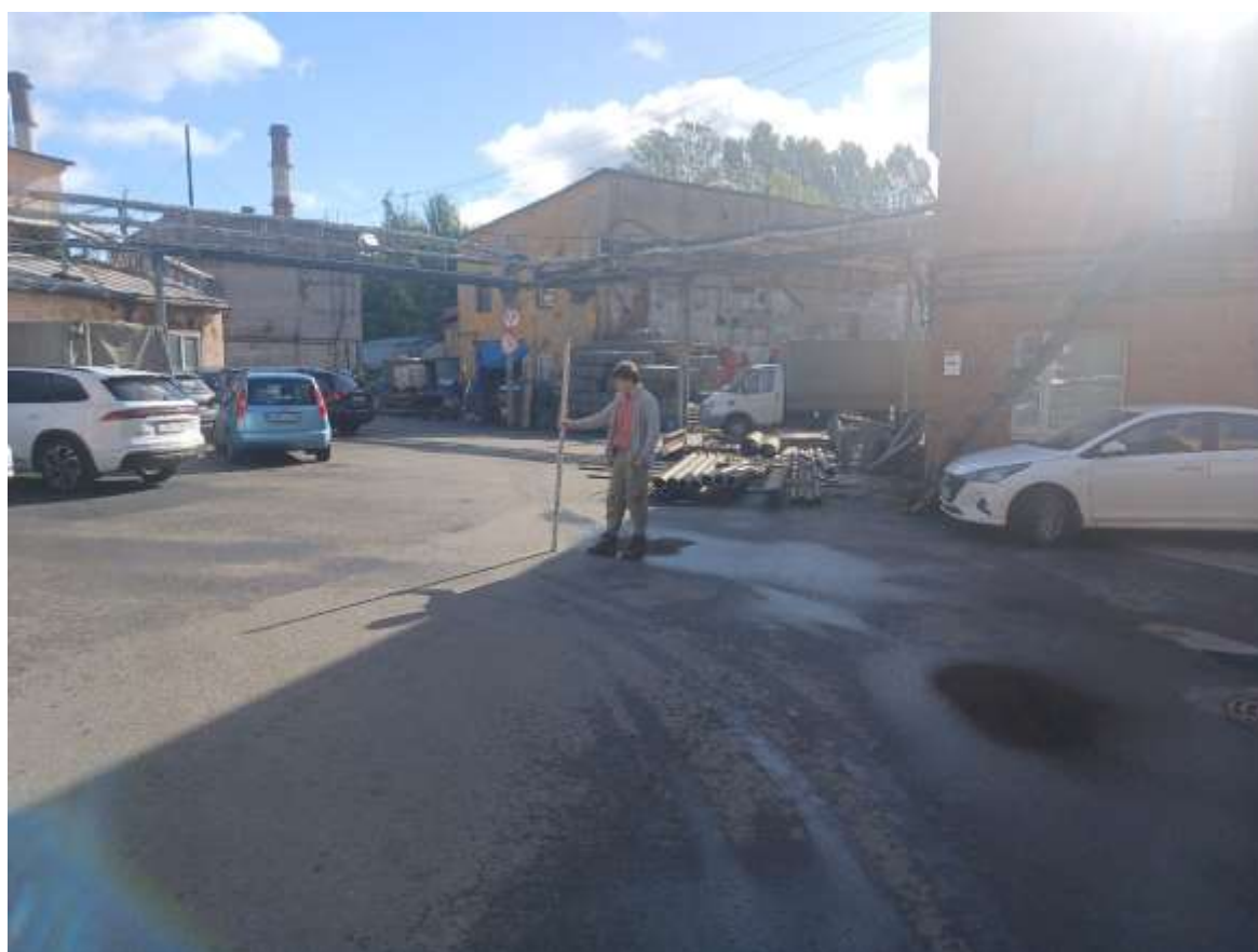
Рис. 15. Санкт-Петербург, Сердобольская улица, дом 60, литера А (кадастровый номер: 78:34:0004009:12). Общий вид участка. Точка съемки 2. Вид на юго-восток
