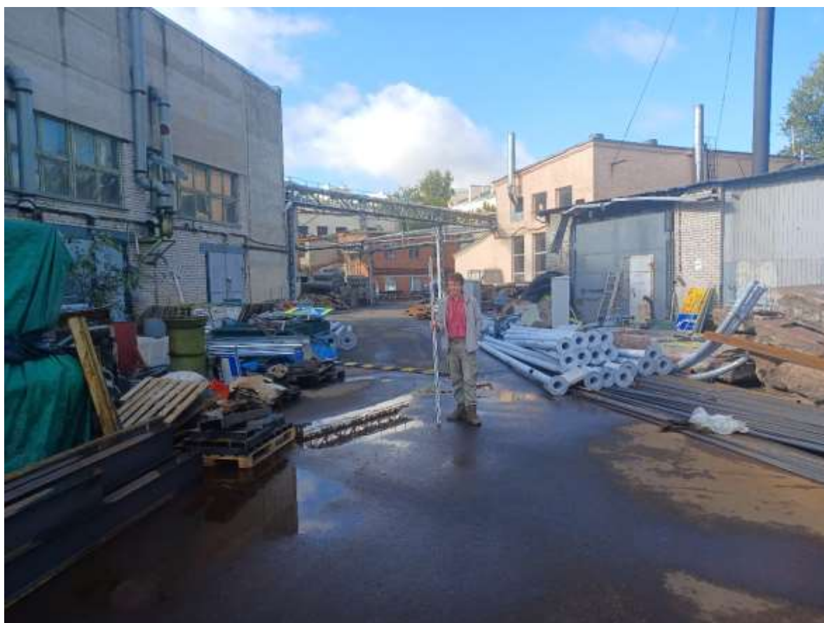
Рис. 17. Санкт-Петербург, Сердобольская улица, дом 60, литера А (кадастровый номер: 78:34:0004009:12). Общий вид участка. Точка съемки 4. Вид на запад
