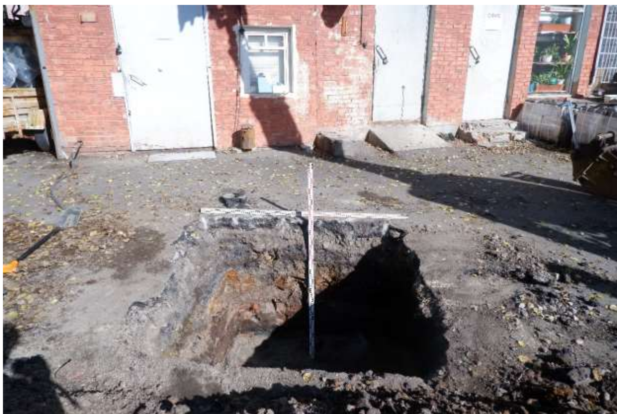
Рис. 25. Санкт-Петербург, Сердобольская улица, дом 60, литера А (кадастровый номер: 78:34:0004009:12). Шурф 1. Фотофиксация выкопанного шурфа. Вид на север
