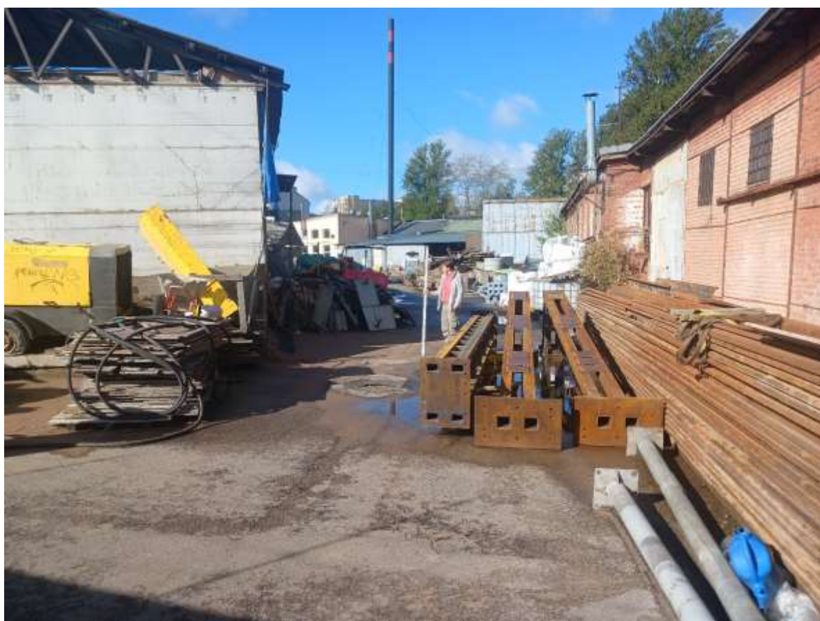
Рис. 19. Санкт-Петербург, Сердобольская улица, дом 60, литера А (кадастровый номер: 78:34:0004009:12). Общий вид участка. Точка съемки 5. Вид на запад
