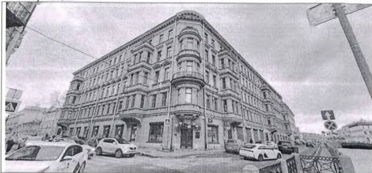
1. Общий вид лицевого фасада.
