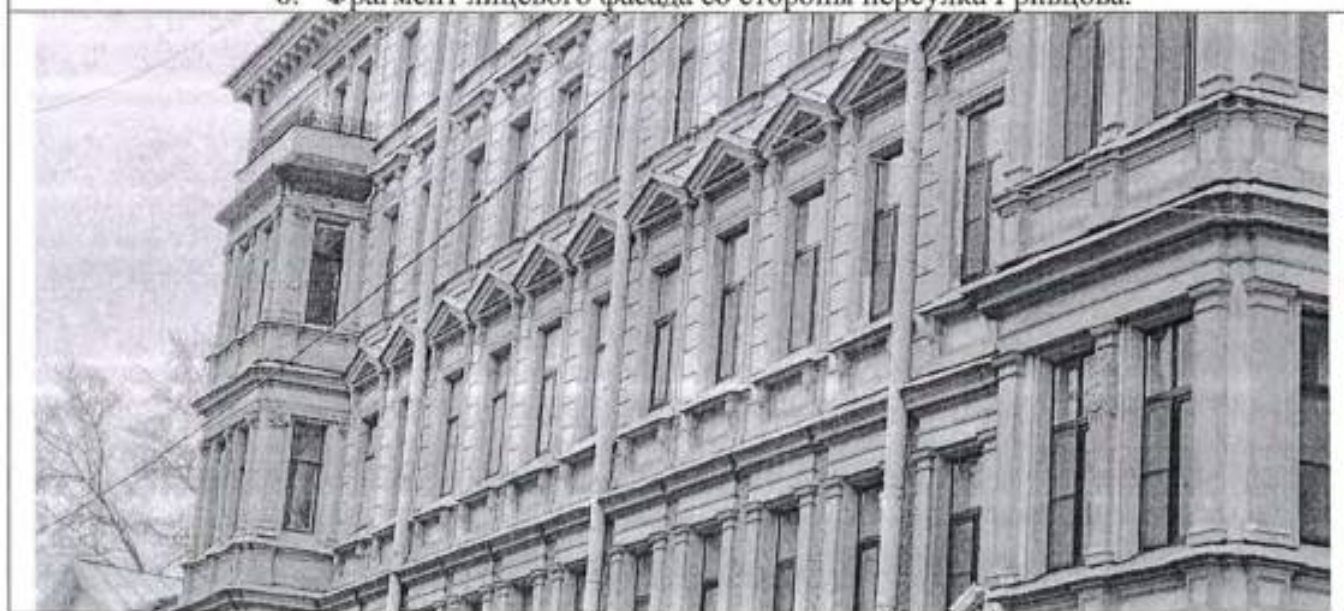
9. Фрагмент лицевого фасада со стороны переуллка Гривцова.
