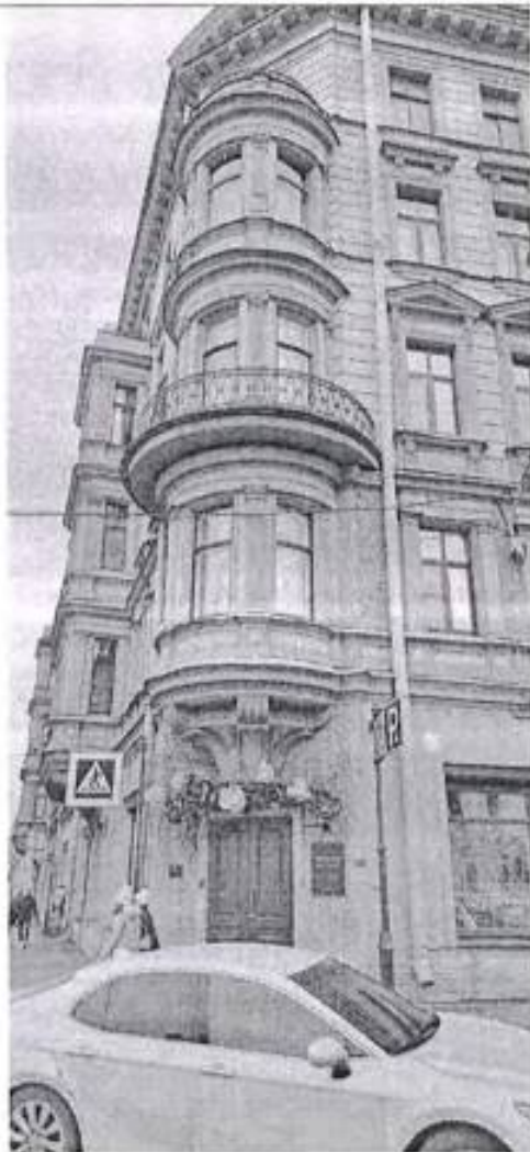
5. Фрагмент лицевого фасада на пересечении переулка Гривцова и наб. реки Мойки.
