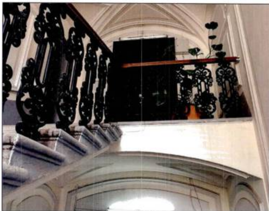
4. Двухмаршевая лестница 6-ЛК. Верхняя площадка.
