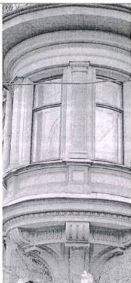
10. Фрагмент балкона на лицевом фасаде.
