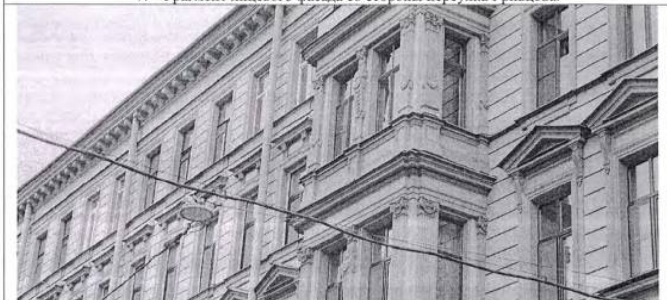
8. Фрагмент лицевого фасада со стороны переуллка Гривцова.
