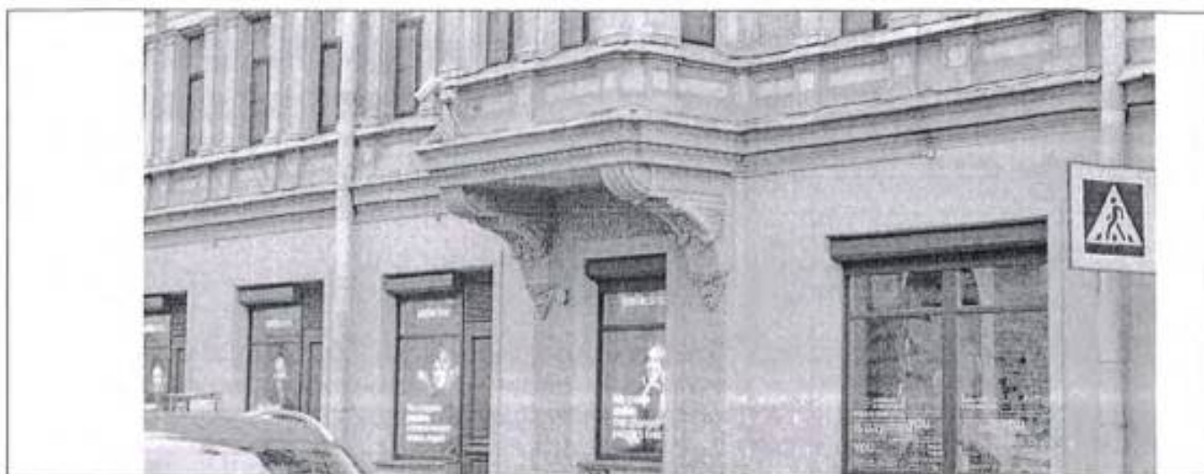
7. Фрагмент лицевого фасада со стороны переуллка Гривцова.
