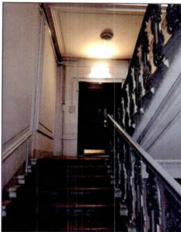
3. Двухмаршевая лестница 7-ЛК. Общий вид.
