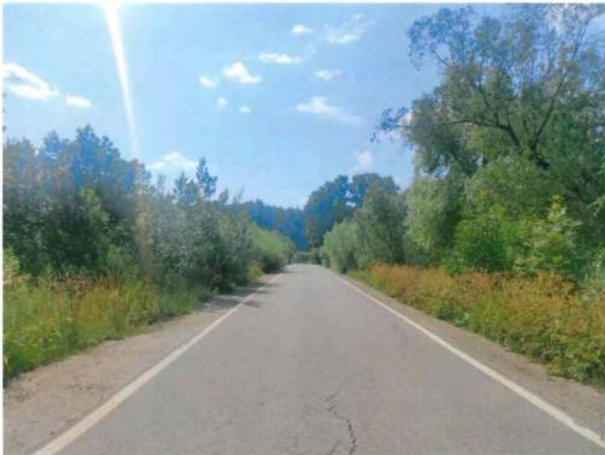
1. Центральная дорога. Вид с севера.
