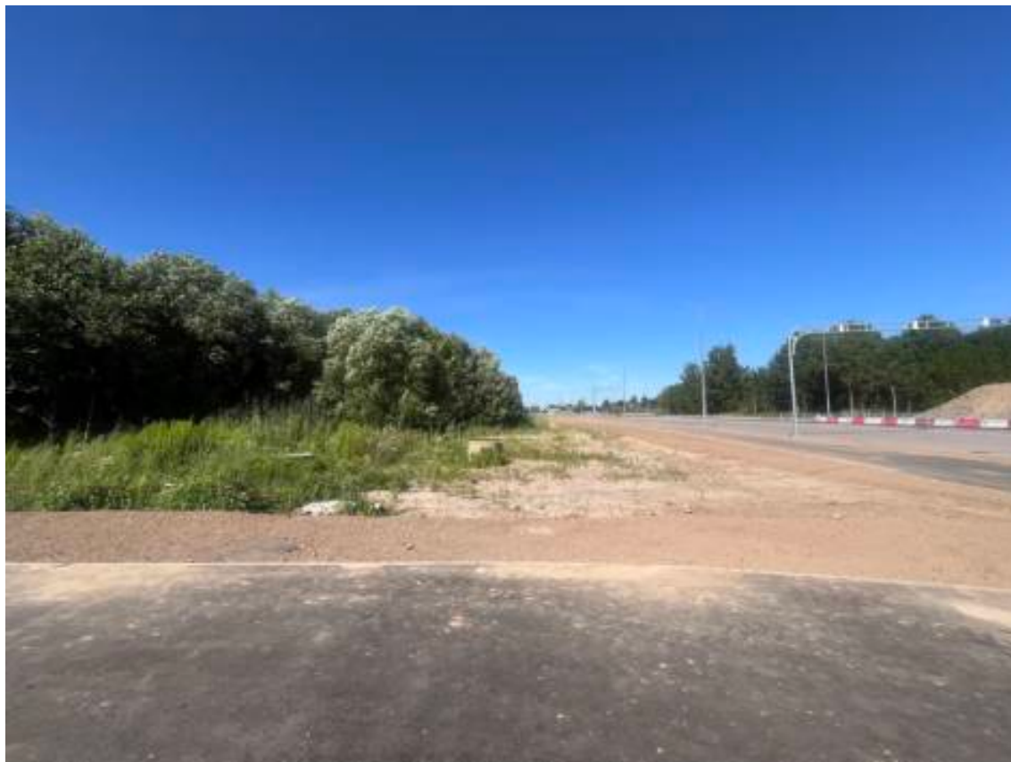
Фото 53. Общий вид Цитадельского шоссе г. Кронштадт. Справа территория объекта культурного наследия регионального значения «Участок комендантской дачи». Общий вид с юго-востока.
