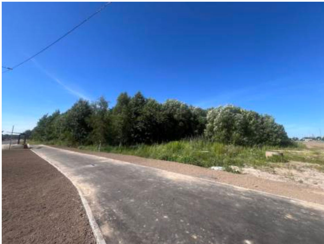
Фото 52. Общий вид Цитадельского шоссе г. Кронштадт. Справа территория объекта культурного наследия регионального значения «Участок комендантской дачи». Общий вид с юго-востока.
