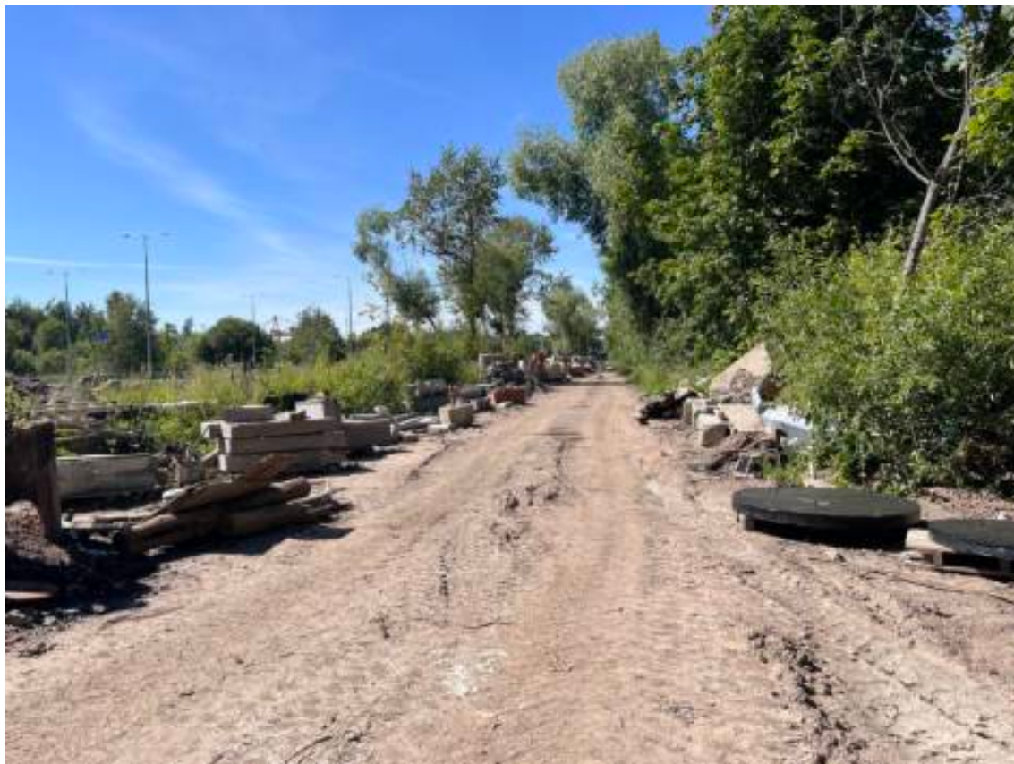
Фото 14. Участок проектируемого объекта «Проектирование строительства здания крытого спортивного комплекса на территории, ограниченной ул. Литке, Цитадельским шоссе, проектируемым проездом № 2, береговой линией Невской губы, проектируемым проездом № 4, ул. Адмирала Грейга, проектируемым проездом № 5, проектируемым проездом № 6, Кронштадтским шоссе; ОЗУ № 16». Общий вид с южной части участка. Вид на запад.
