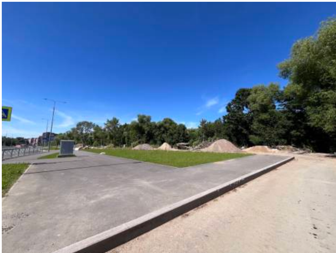
Фото 11. Участок проектируемого объекта «Проектирование строительства здания крытого спортивного комплекса на территории, ограниченной ул. Литке, Цитадельским шоссе, проектируемым проездом № 2, береговой линией Невской губы, проектируемым проездом № 4, ул. Адмирала Грейга, проектируемым проездом № 5, проектируемым проездом № 6, Кронштадтским шоссе; ОЗУ № 16». Общий вид с юго-востока.
