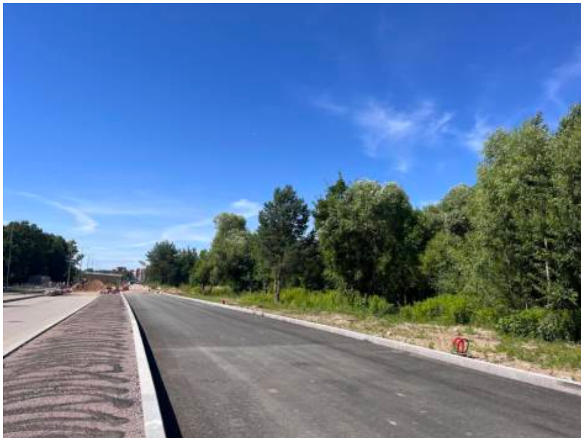
Фото 5. Фрагмент Цитадельского шоссе, г. Кронштадт. Объект культурного наследия регионального значения «Участок дворца Петра I». Общий вид с юга на запад.
