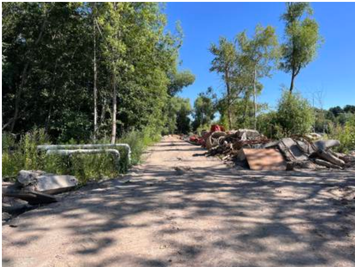
Фото 15. Участок проектируемого объекта «Проектирование строительства здания крытого спортивного комплекса на территории, ограниченной ул. Литке, Цитадельским шоссе, проектируемым проездом № 2, береговой линией Невской губы, проектируемым проездом № 4, ул. Адмирала Грейга, проектируемым проездом № 5, проектируемым проездом № 6, Кронштадтским шоссе; ОЗУ № 16». Общий вид с южной части участка. Вид на восток.
