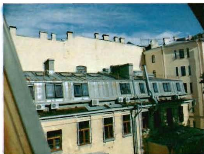
15. Мансардная надстройка над 3-им этажом
