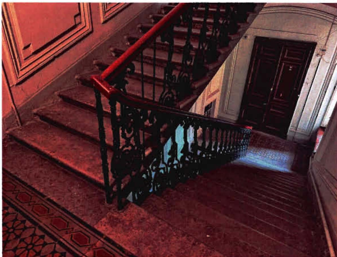
6. Лестница 3ЛК объекта культурного наследия. Фото от 24.04.2025.
