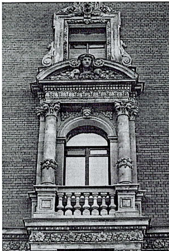
Фрагмент фасада. Балкон
