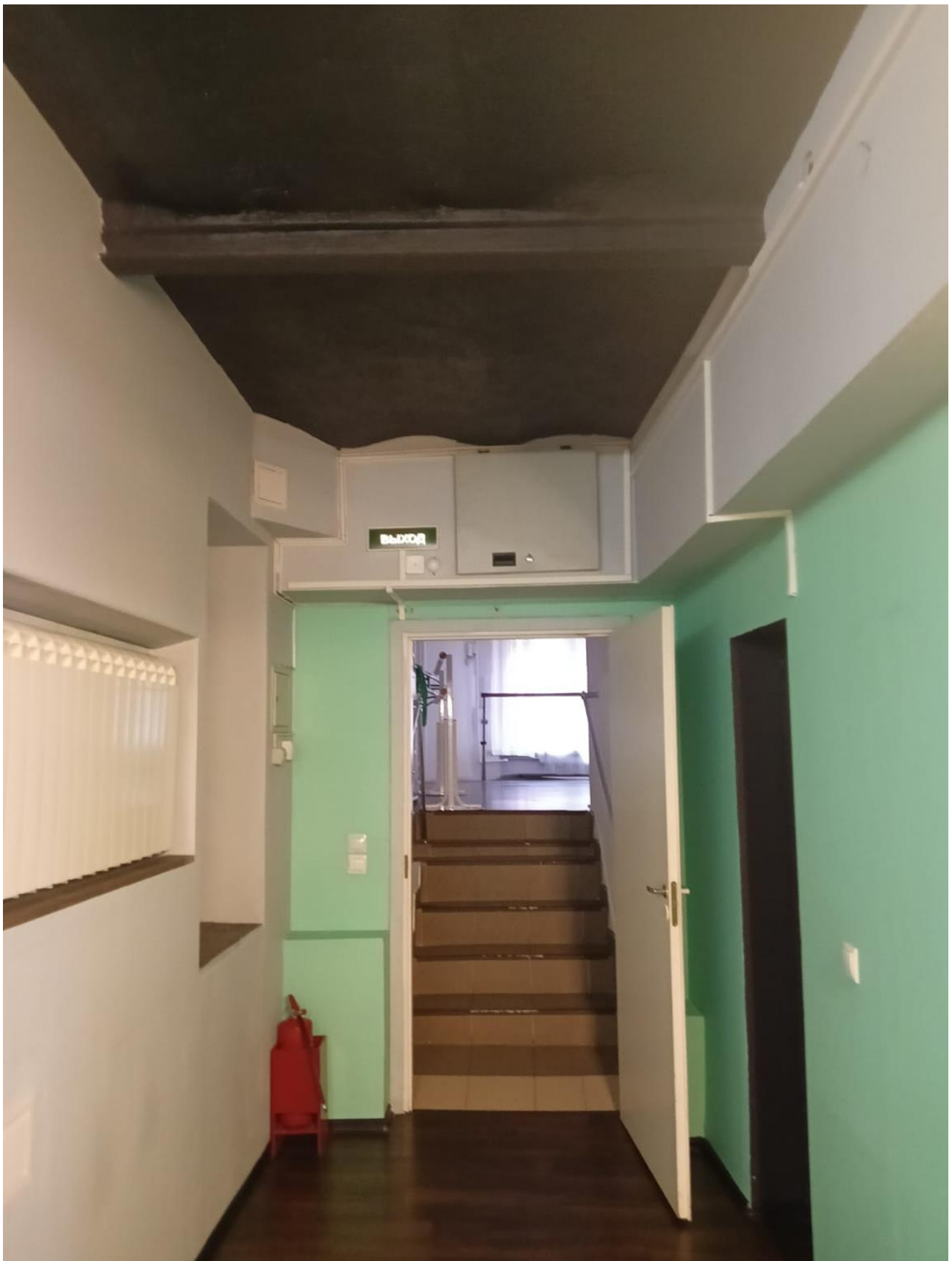
Фото 11. Помещение 6Н(3). Эвакуационный выход.
