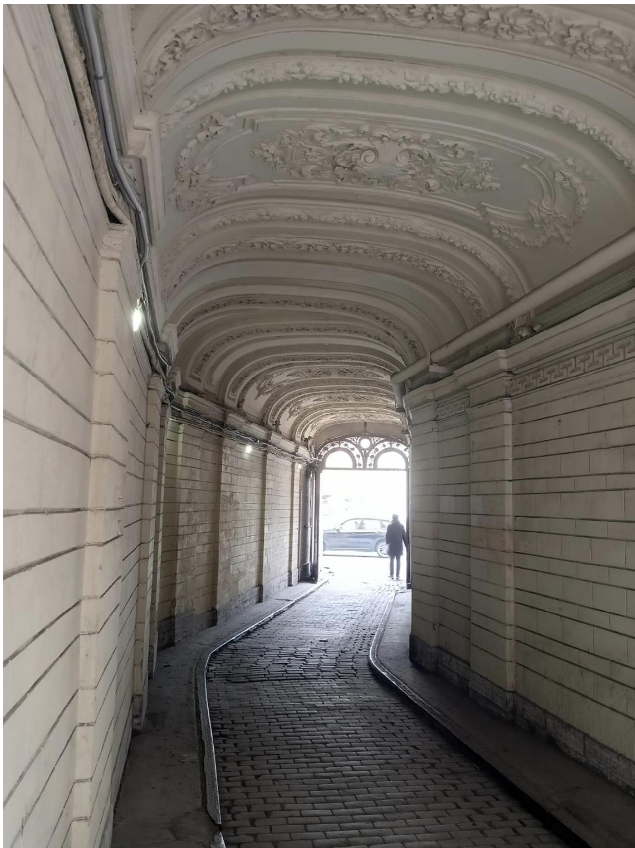
Фото 3. Воротный проезд из северо-западного двора в сторону наб. реки Фонтанки.
