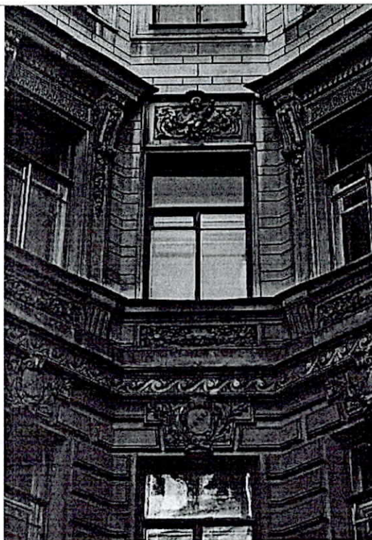
Фрагмент дворового фасада
