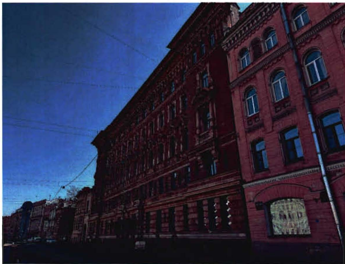
1. Общий вид на северо-западный лицевой фасад объекта культурного наследия. Фото от 16.04.2025.
