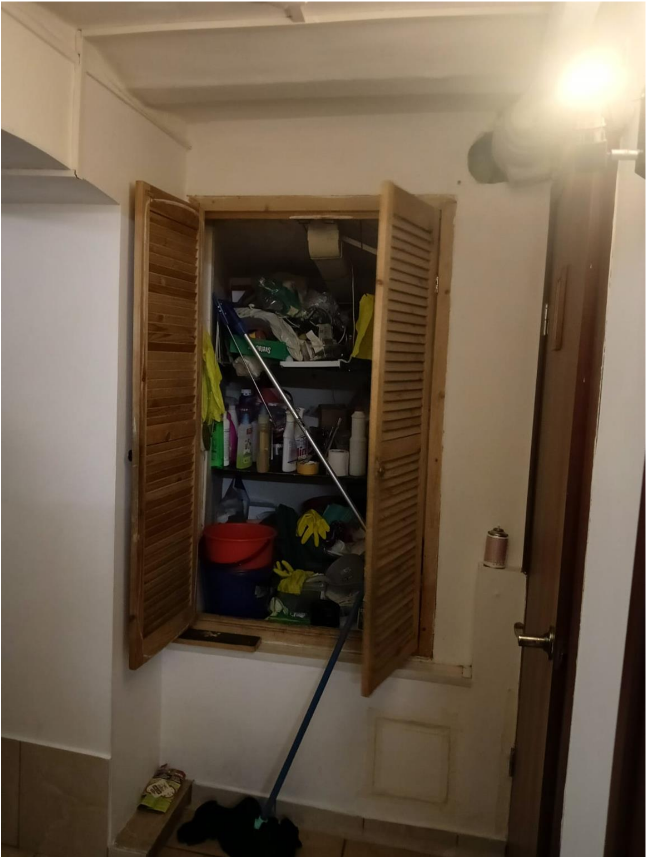
Фото 17. Помещение 16Н(2). Оконный проем заложен в нишу.
