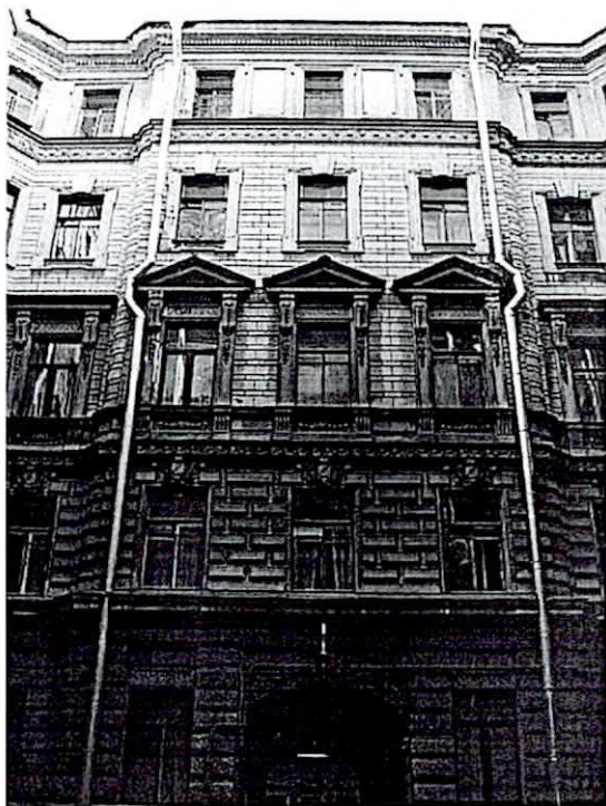
Общий вид на дворовый фасад
