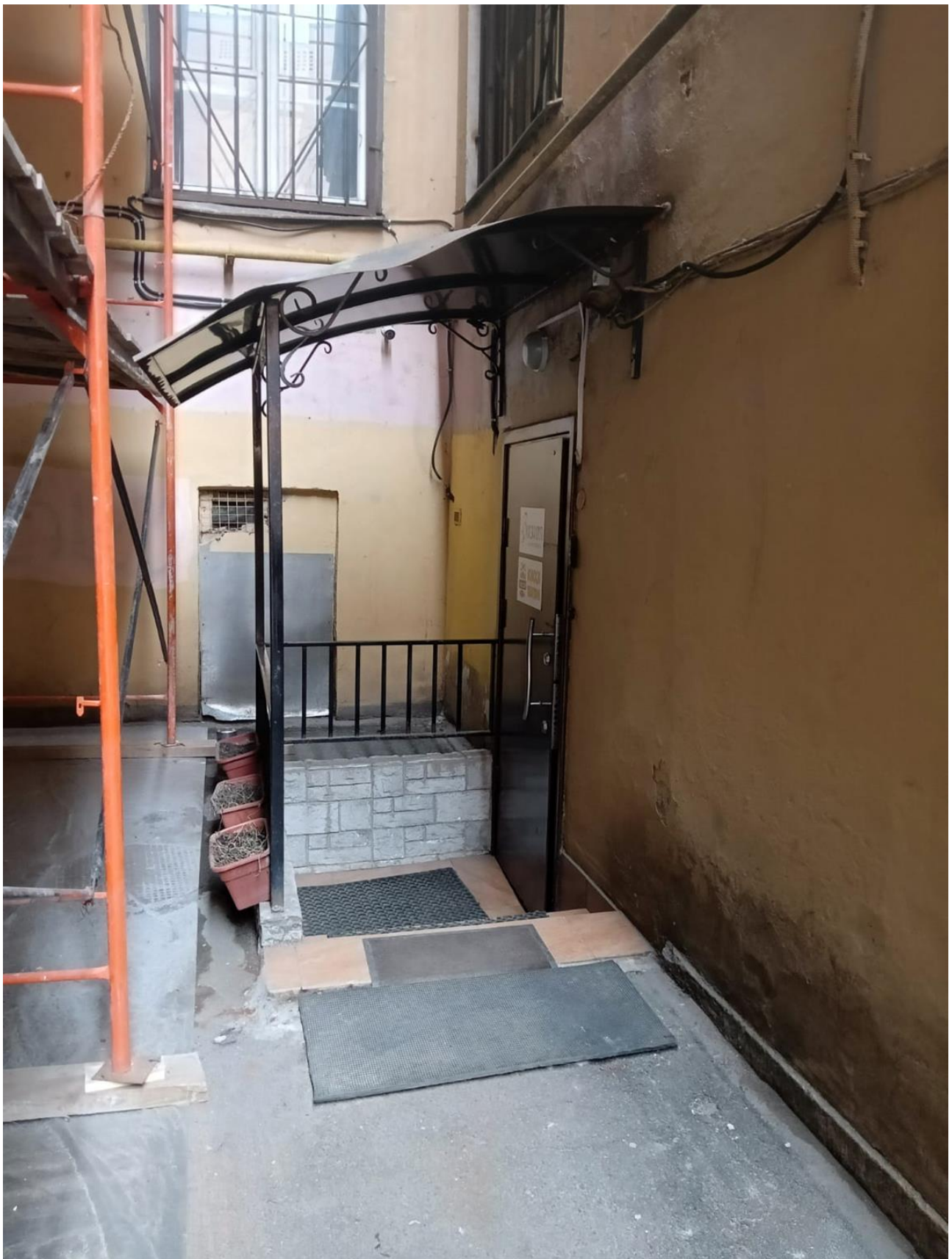
Фото 18. Юго-западный фасад. Заполнение дверного проема в пом. 16Н.
