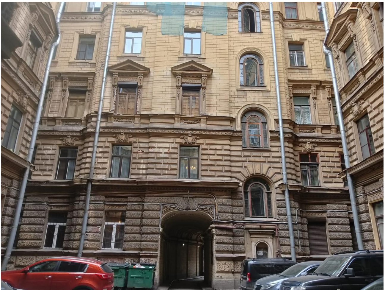
Фото 5. Юго-восточный фасад северо-западного двора.
