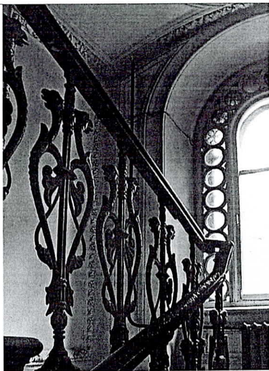
Металлическое лестничное ограждение в парадной
