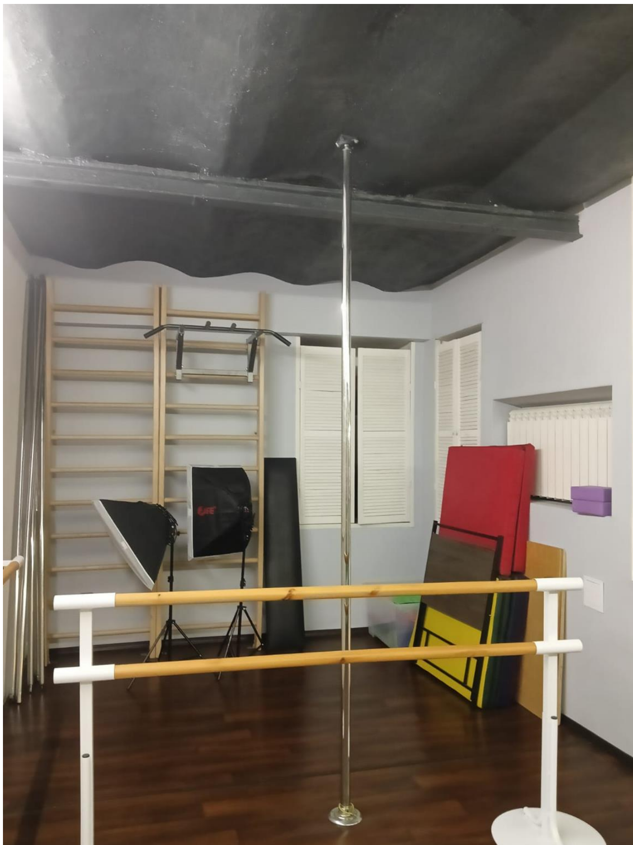
Фото 13. Фрагмент помещения 6Н(3). Дверной проем заложен.
