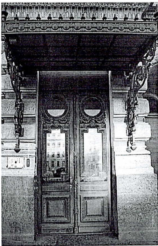
Фрагмент фасада. Дверное заполнение с металлическим козырьком
