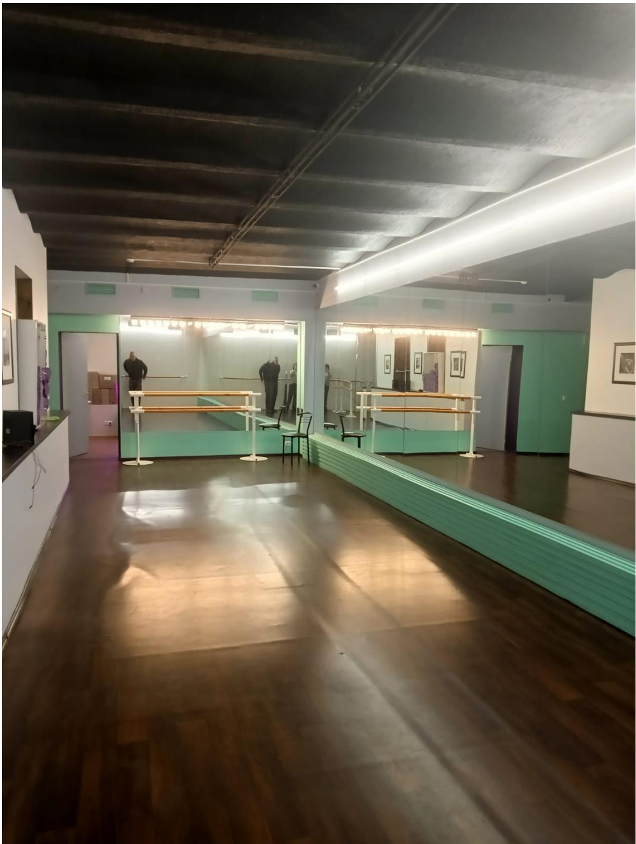
Фото 12. Помещение 6Н(3). Надподвальные своды монье (по балкам).
