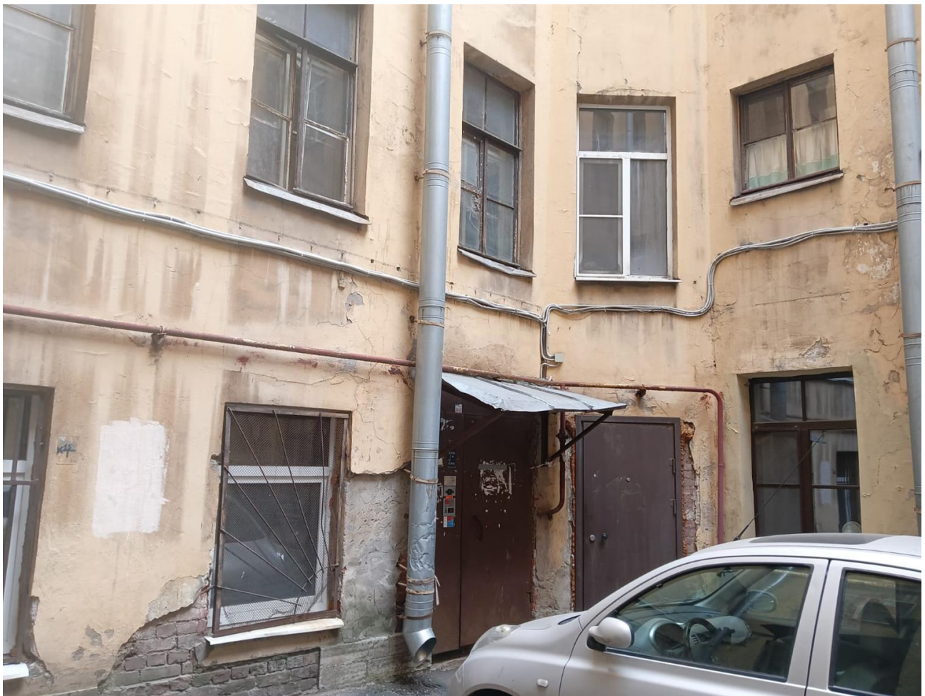
Фото 7. Оконные проемы цокольного этажа юго-западного фасада.
