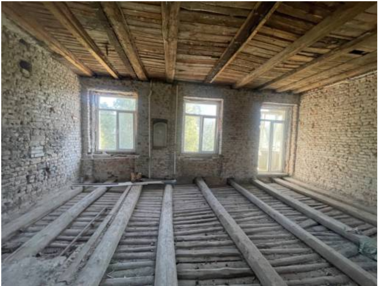
10. Помещения со стороны дворового фасада.
