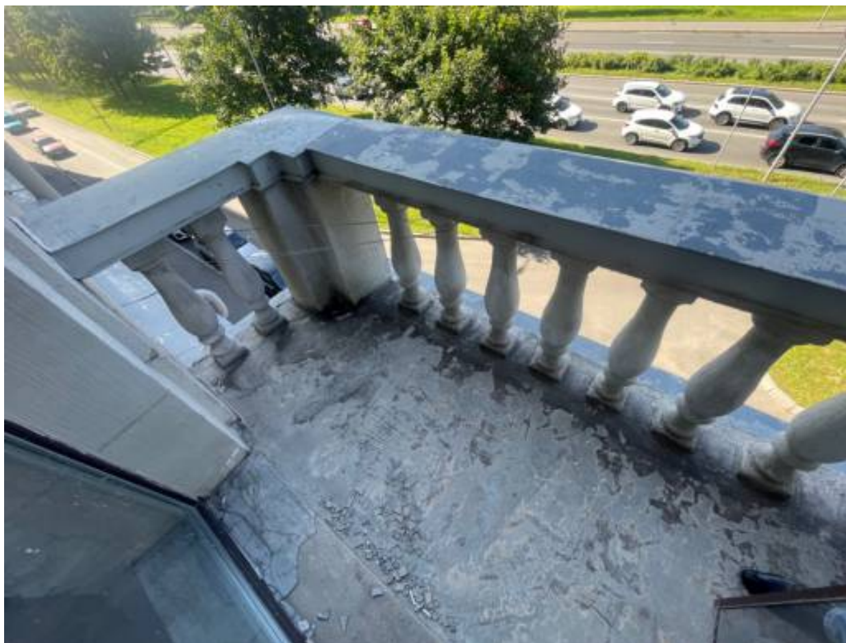
8. Балкон со стороны лицевого фасада.
