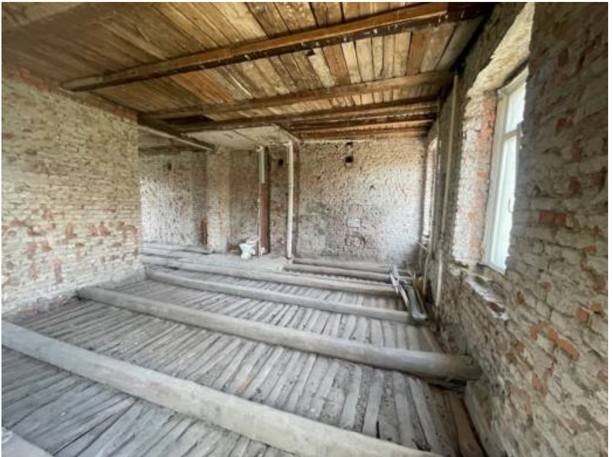
14. Помещение со стороны дворового фасада.
