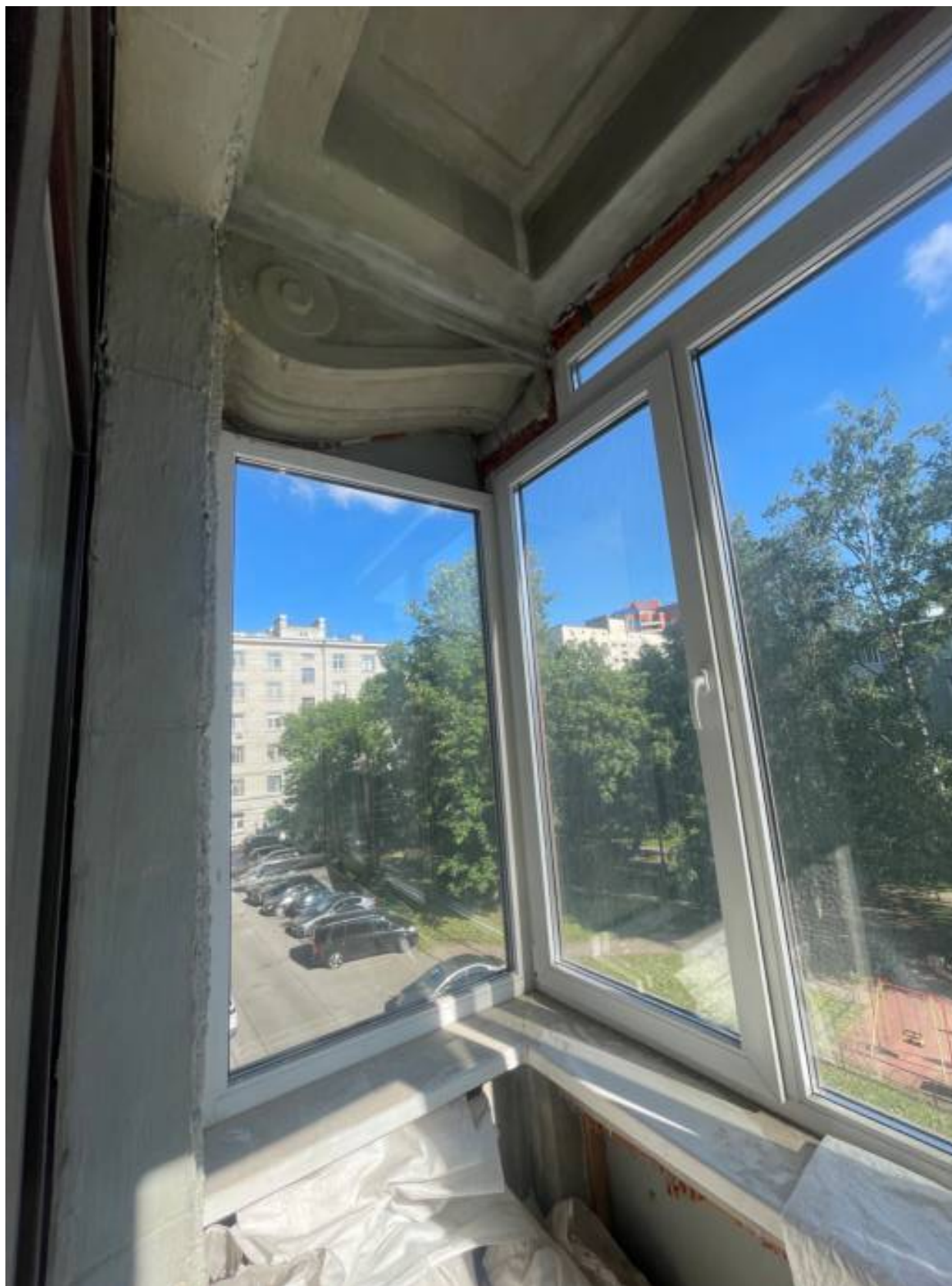
11. Балкон со стороны дворового фасада.
