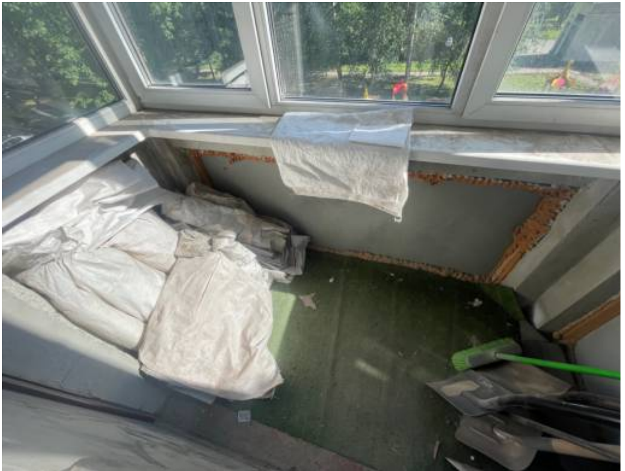
13. Балкон со стороны дворового фасада.
