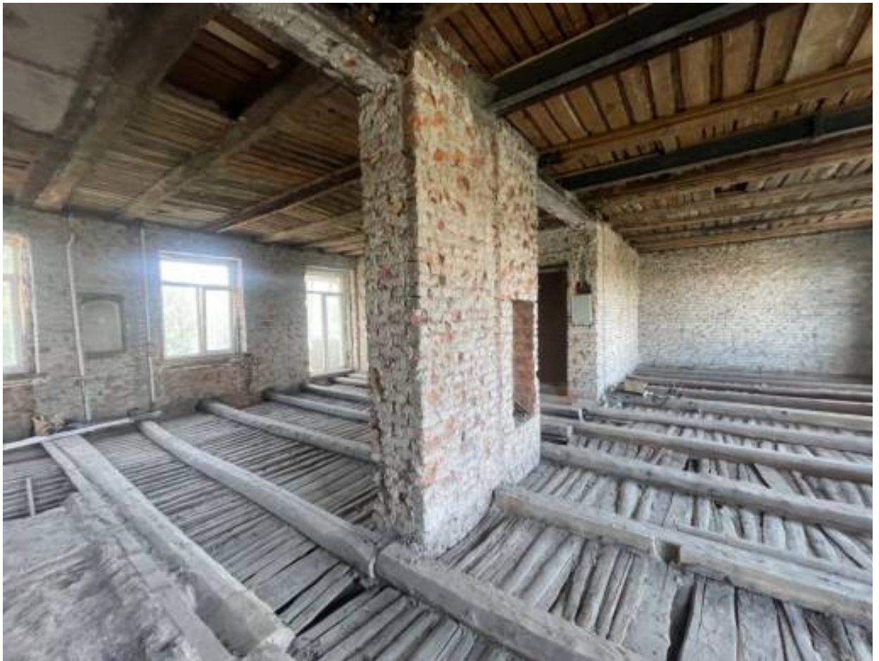
9. Общий вид помещений.
