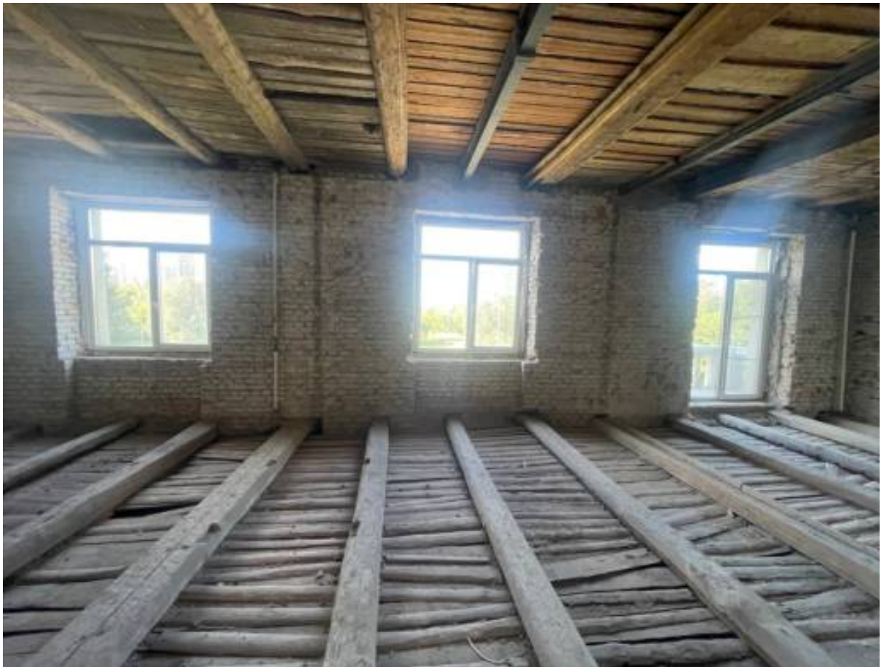
7. Помещение со стороны лицевого фасада.
