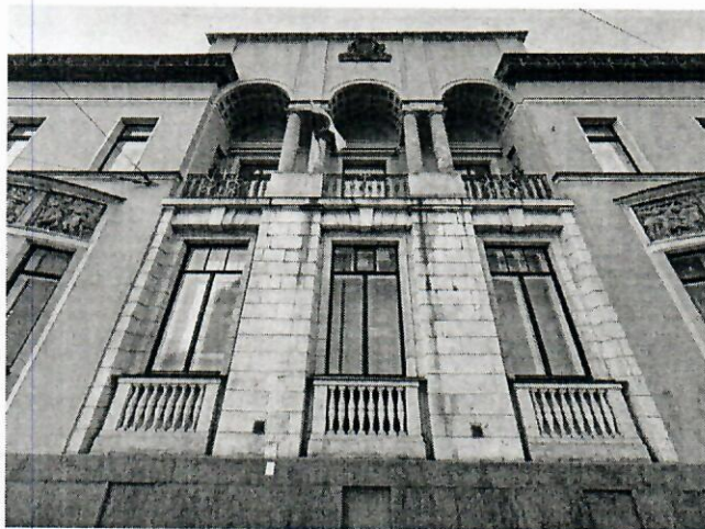
2. Фрагмент восточного фасада
