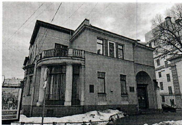
3. Фрагмент северного фасада
