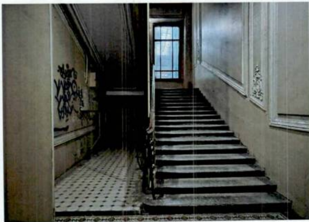
6. Межэтажная лестница 2ЛК.
