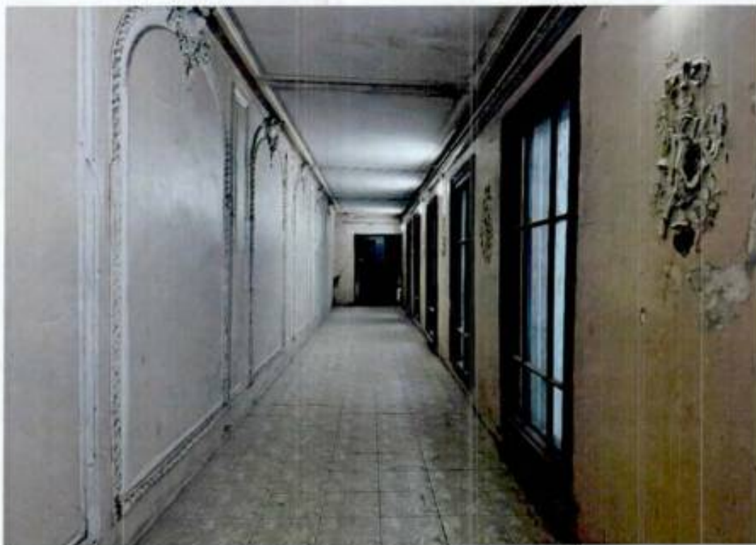
7. Помещение 2ЛК. Крытая галерея в уровне 2 этажа.
