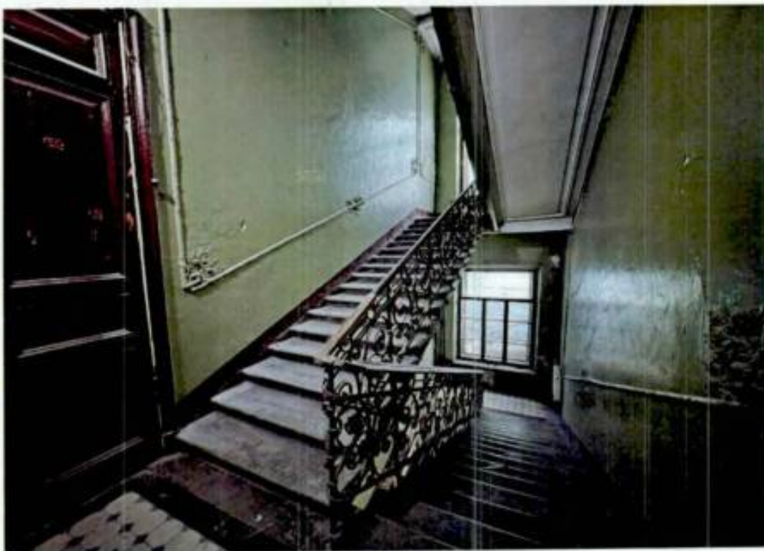
8. Межэтажная лестница 6ЛК.
