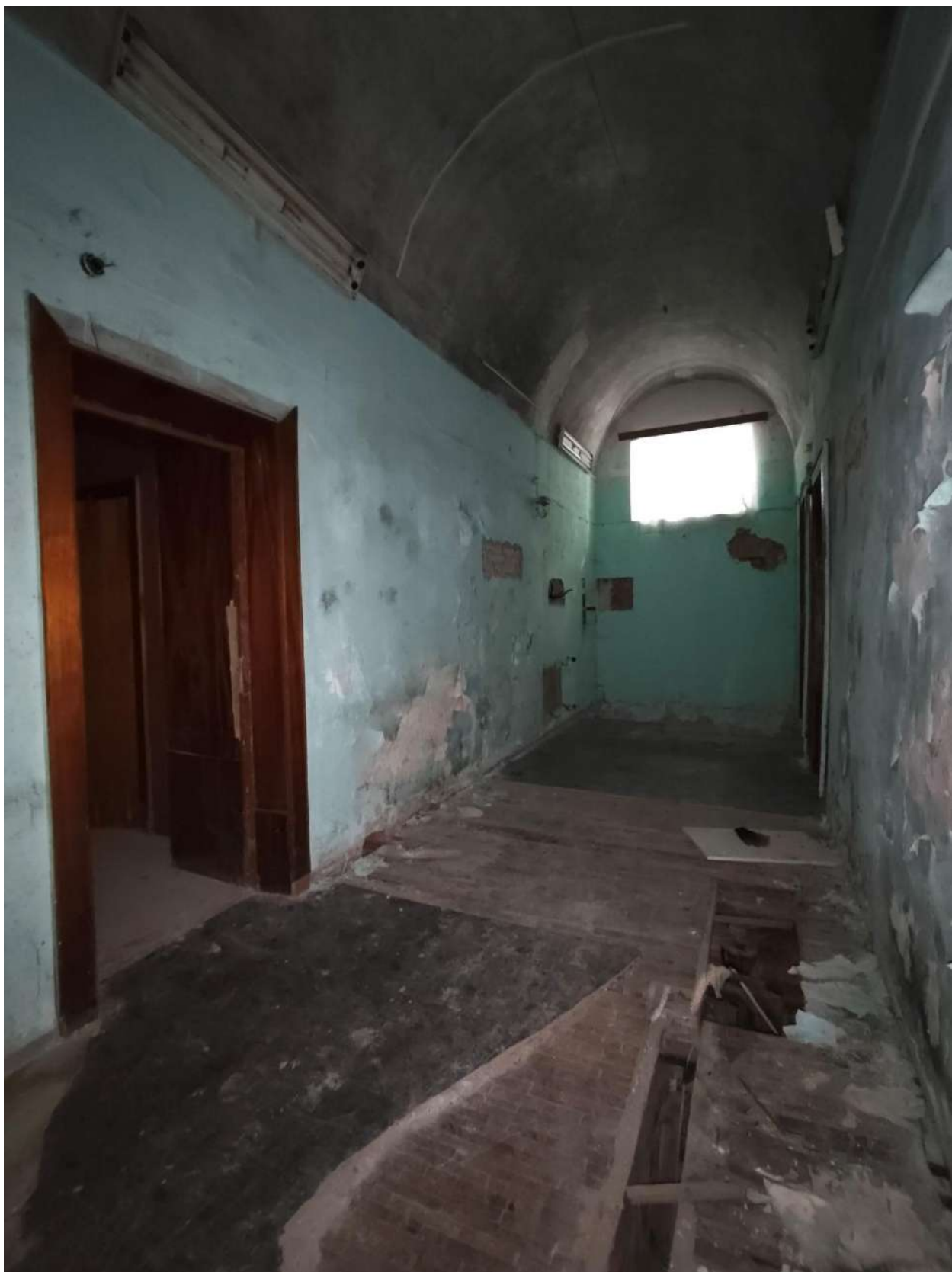
44. Фрагмент интерьера 1 этажа.
