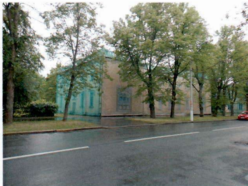
4. Западный дворовый фасад:
