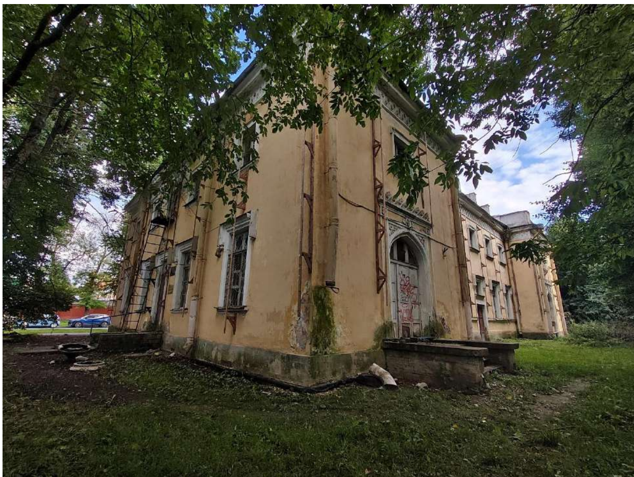
7. Северный и западный фасады.
