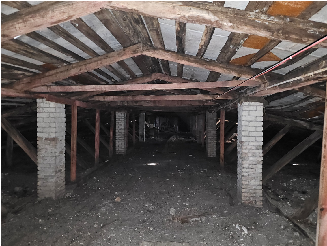
18. Объект культурного наследия регионального значения «Здание Технической школы», по адресу: г. Санкт-Петербург, пр. Стачек, д. 30, лит. А. Общий вид стропильной системы крыши над центральной частью основного объема.
