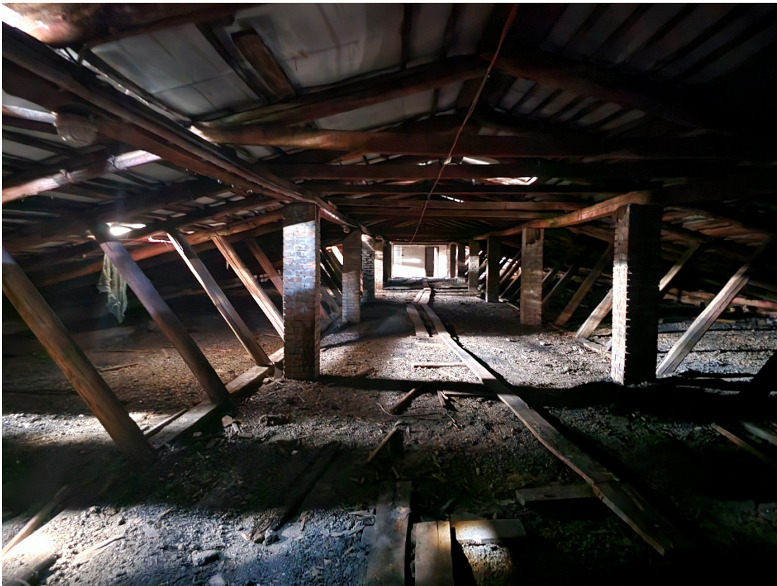
22. Объект культурного наследия регионального значения «Здание Технической школы», по адресу: г. Санкт-Петербург, пр. Стачек, д. 30, лит. А. Общий вид стропильной системы крыши над западной частью основного объема.
