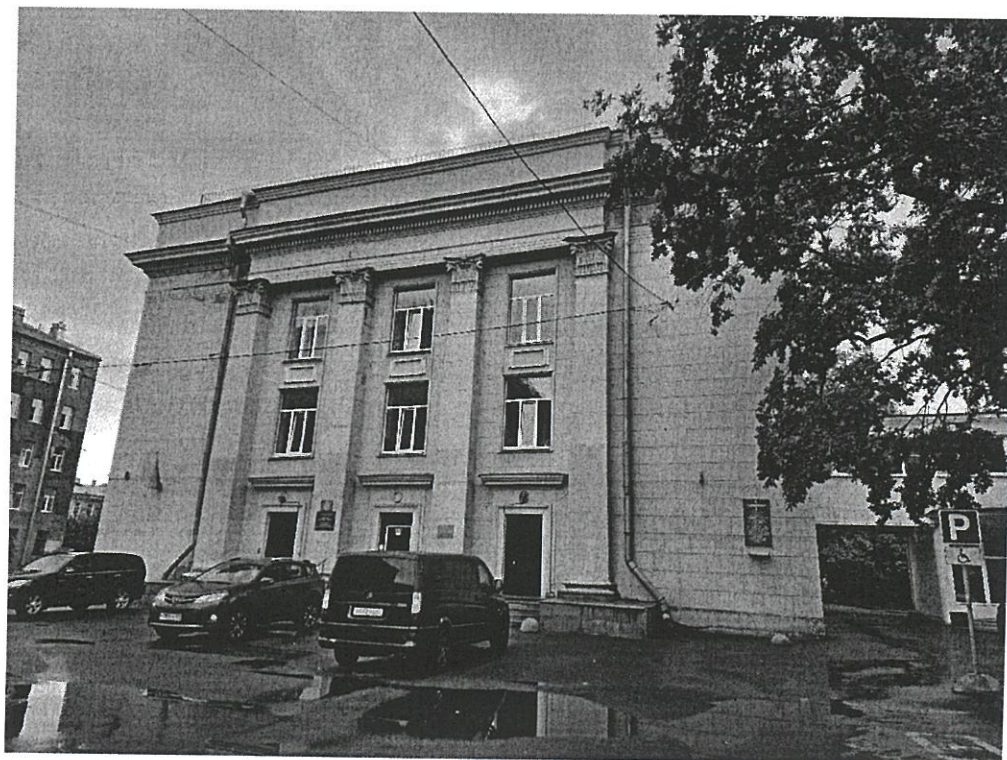
1. Общий вид на северо-западный фасад.
