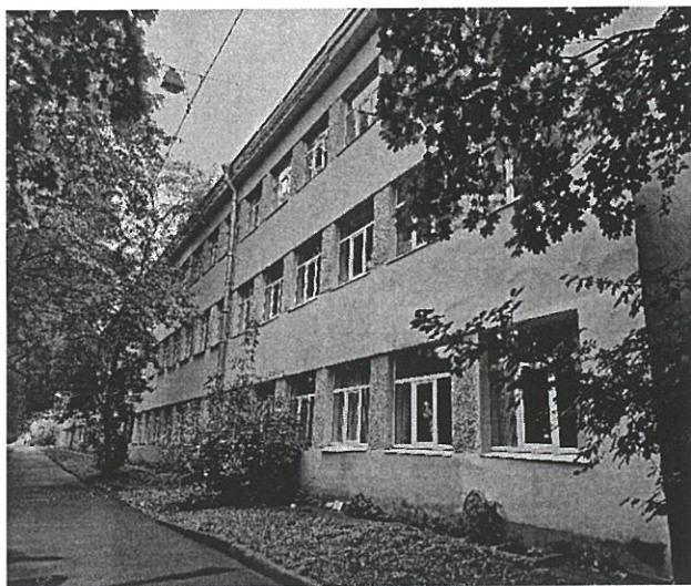
7. Фрагмент юго-западного фасада.
