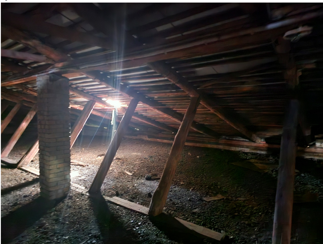
23. Объект культурного наследия регионального значения «Здание Технической школы», по адресу: г. Санкт-Петербург, пр. Стачек, д. 30, лит. А. Фрагмент стропильной системы крыши над западной частью основного объема.
