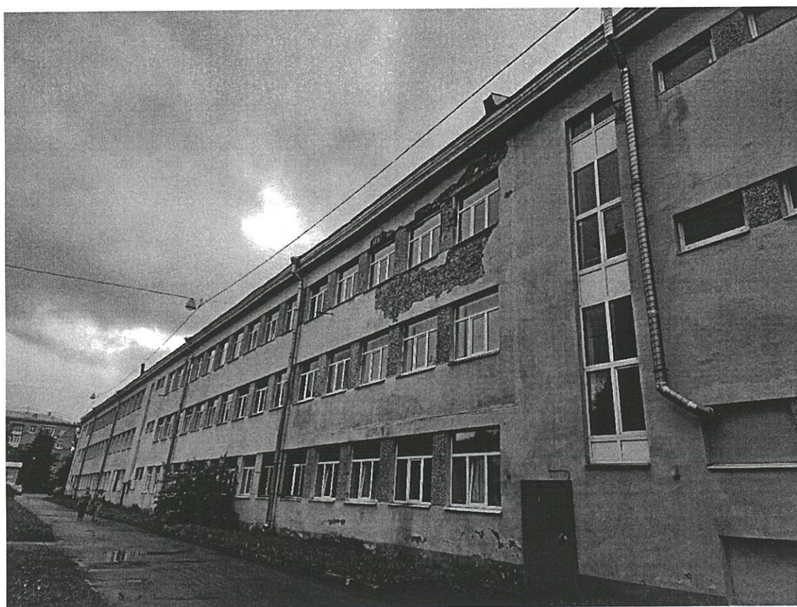
3. Общий вид северо-восточного фасада.
