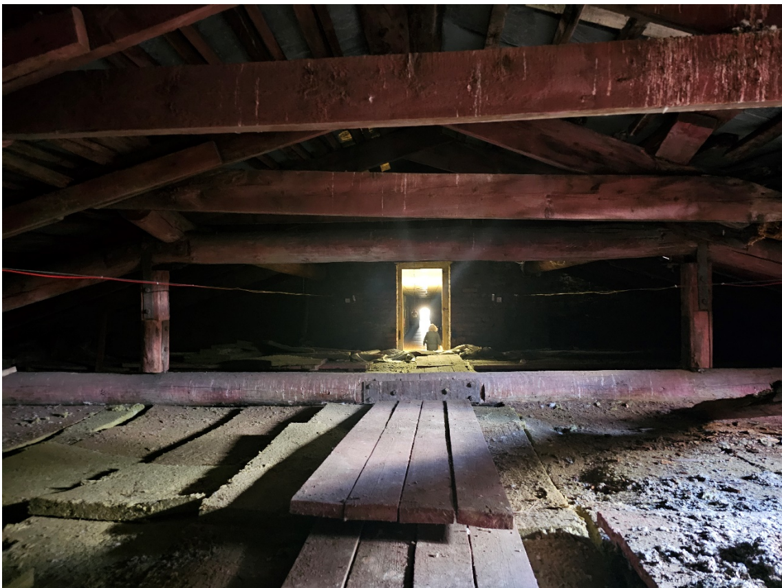
17. Объект культурного наследия регионального значения «Здание Технической школы», по адресу: г. Санкт-Петербург, пр. Стачек, д. 30, лит. А. Общий вид стропильной системы крыши над восточным закругленным объемом.
