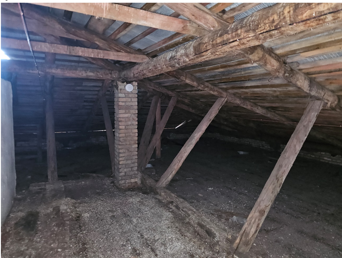
21. Объект культурного наследия регионального значения «Здание Технической школы», по адресу: г. Санкт-Петербург, пр. Стачек, д. 30, лит. А. Фрагмент стропильной системы крыши над восточной частью основного объема.
