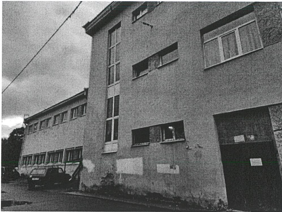
4. Фрагмент северо - восточного фасада.
