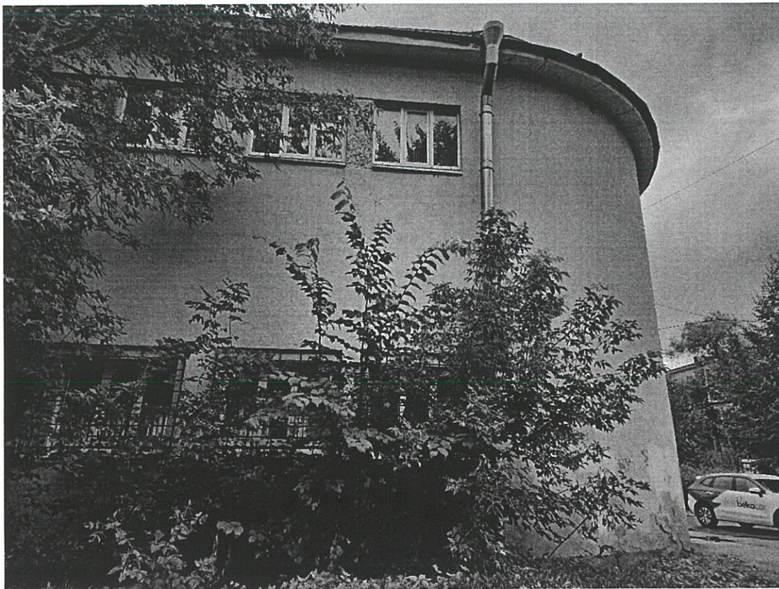
6. Фрагмент юго-западного фасада.
