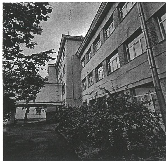
8. Фрагмент юго-западного фасада.
