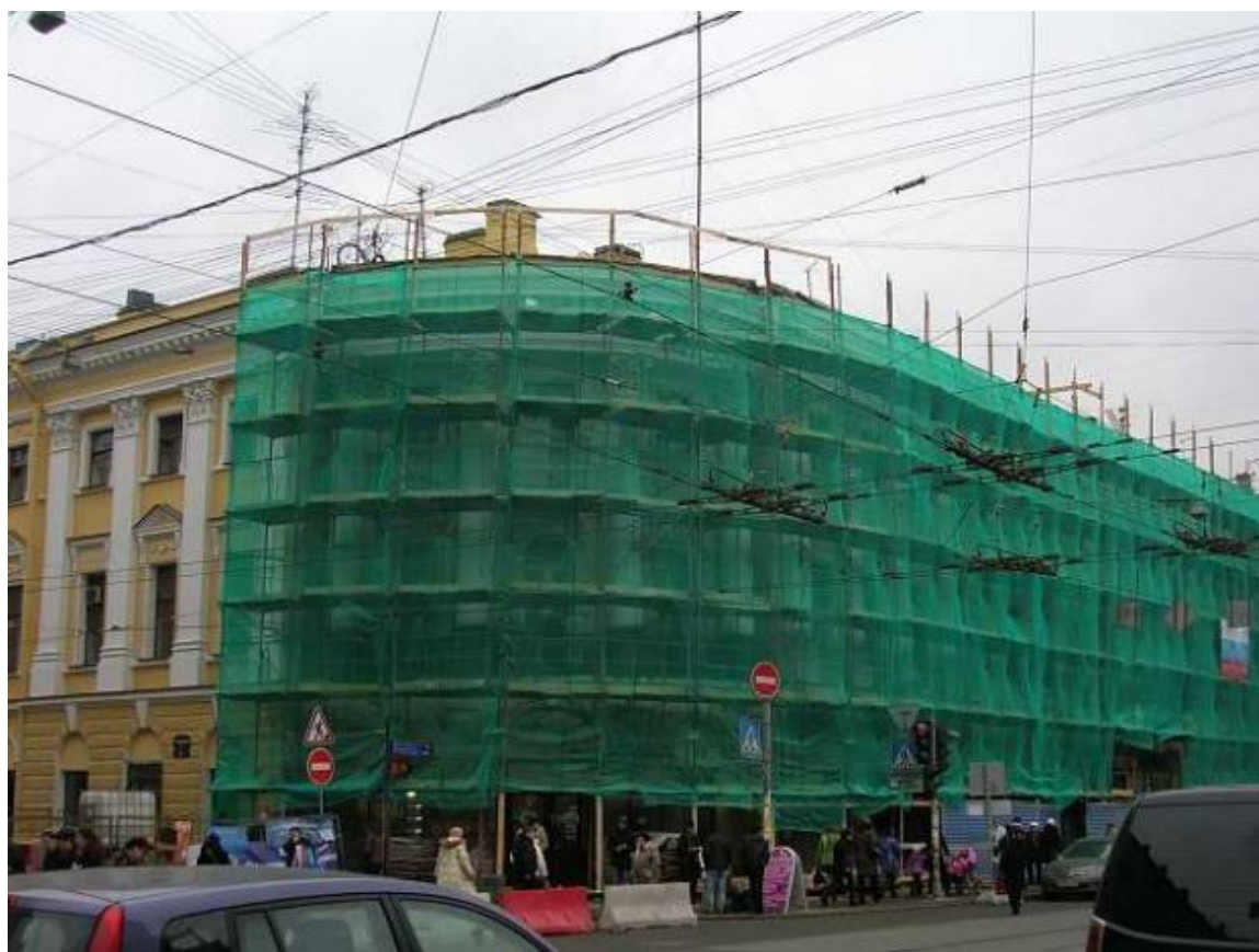
Рис. 26 Перекресток Гороховой и Садовой улицы. Выполнение работ по фасадам и кровле. 2011 г.
