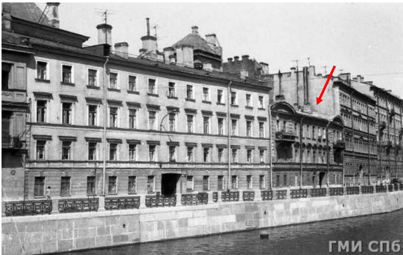
Илл. 126. Фото 1985 г. Колтун И. Б., фотограф. ГМИ СПб Инв.№-П-Б-16964 н. ГОСКАТАЛОГ.РФ. Интернет-ресурс https://www.goskatalog.ru/portal/#/collections?id=49683040 . Лицевой фасад по наб. р. Мойки.
