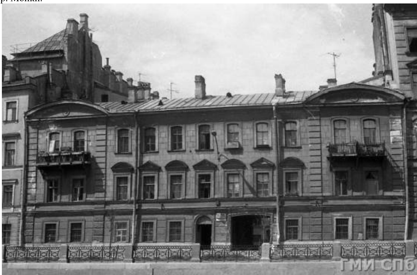
Илл. 127. Фото 1985 г. Колтун И. Б., фотограф. ГМИ СПб Инв.№-П-Б-16965 н. ГОСКАТАЛОГ.РФ. Интернет-ресурс https://www.goskatalog.ru/portal/#/collections?id=49683040 . Лицевой фасад по наб. р. Мойки.
