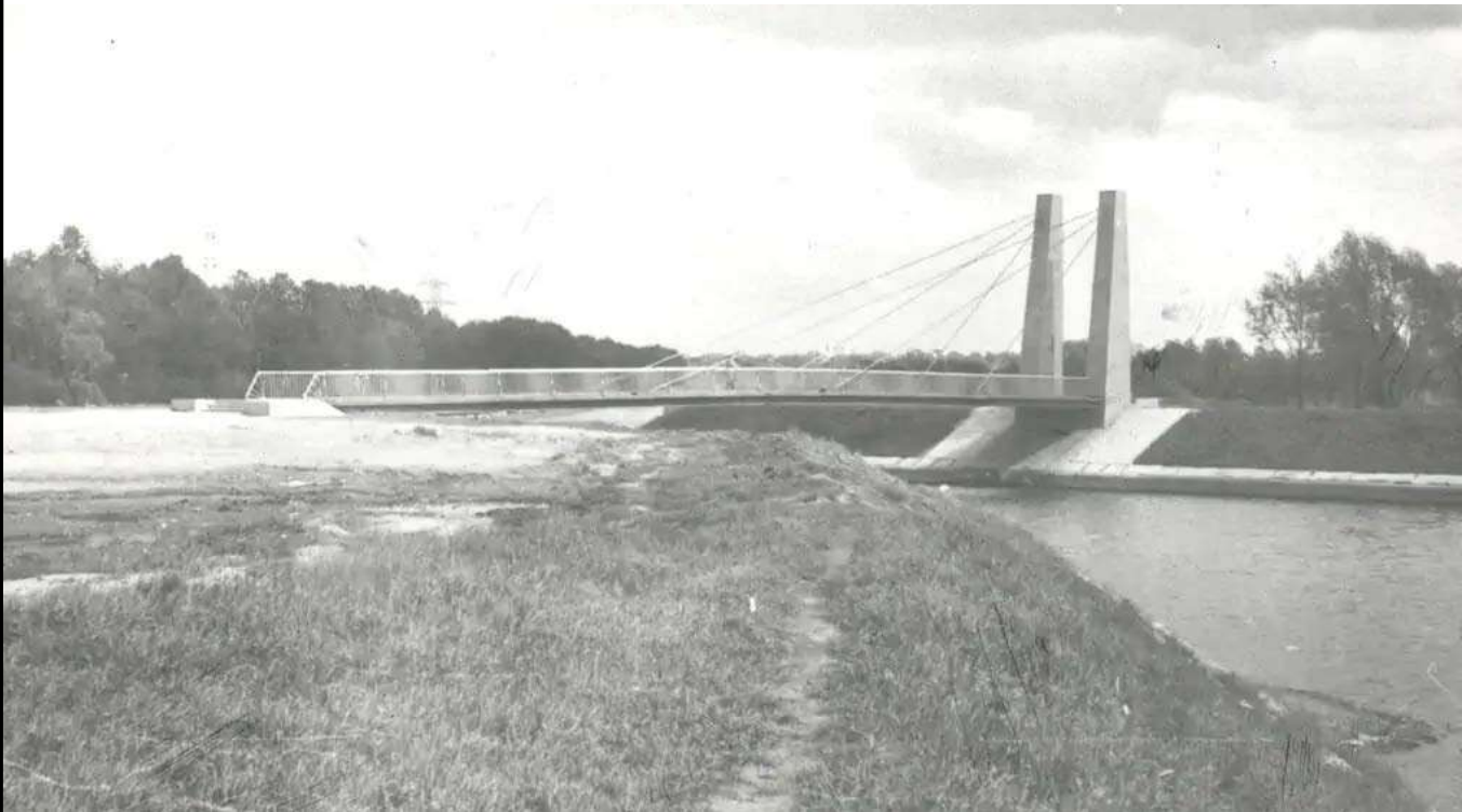
Илл.13. Пешеходный вантовый мост по «аллее Славы» (Мост сооружен в 1986- 1988 годах по проекту инженера Ленгипроинжпроекта А.А. Соколова и архитектора Ю. Шиндина. Мост пешеходный, однопролетный, металлический, вантовой системы. Это первый в городе вантовый мост). 1990. // Источник: https://yandex.by/collections/card/5dc515ebc8ba52496247a1e/
