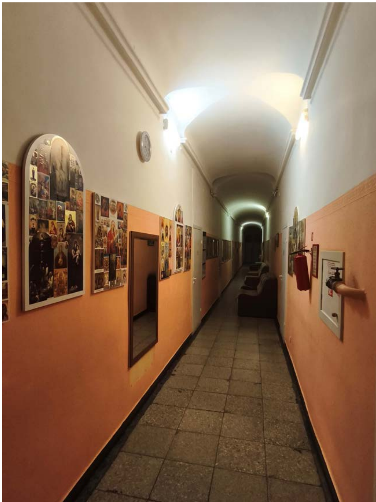
Фото 13. Коридор второго этажа;
