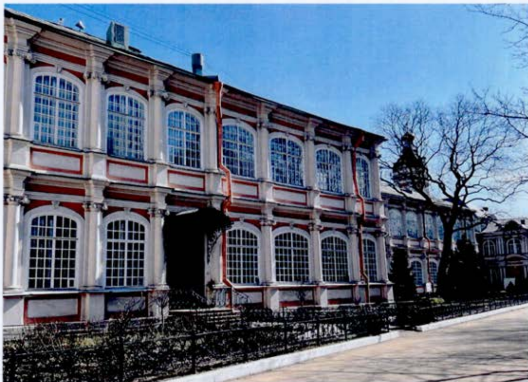
2. Западный фасад объекта культурного наследия.
