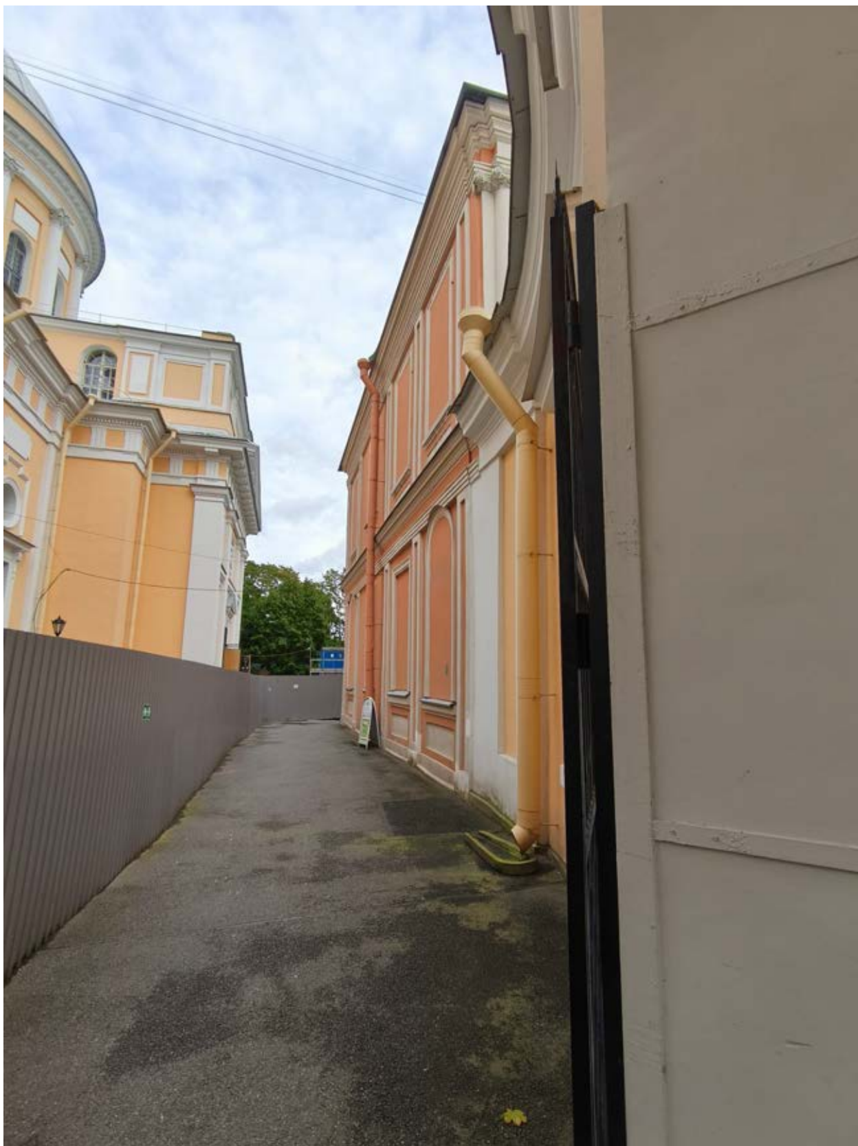
Фото 3. Вид на проход со стороны северного фасада.
