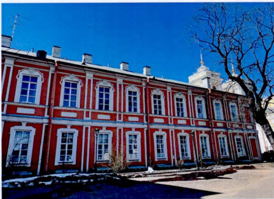
3. Восточный фасад объекта культурного наследия.
