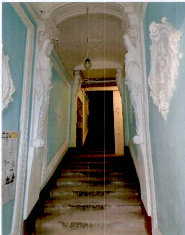
7. Марш в уровне вестибюля (дата съемки 11.03.2024).
