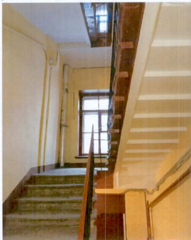
9. Лестница дворового корпуса (дата съемки 01.03.2024).
