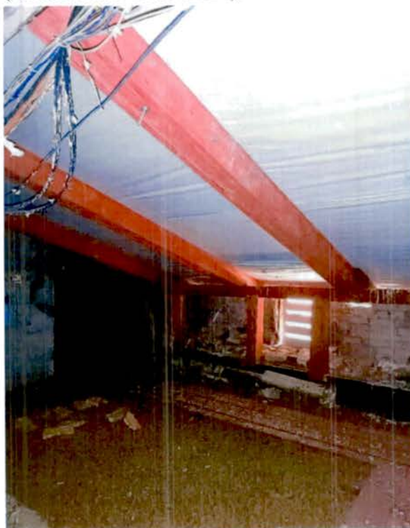
16. Конструкции крыши. (дата съемки 01.03.2024).
