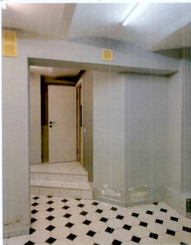
11. Помещение 1-Н, ч.п. 2 (цокольный этаж) (дата съемки 11.03.2024).
