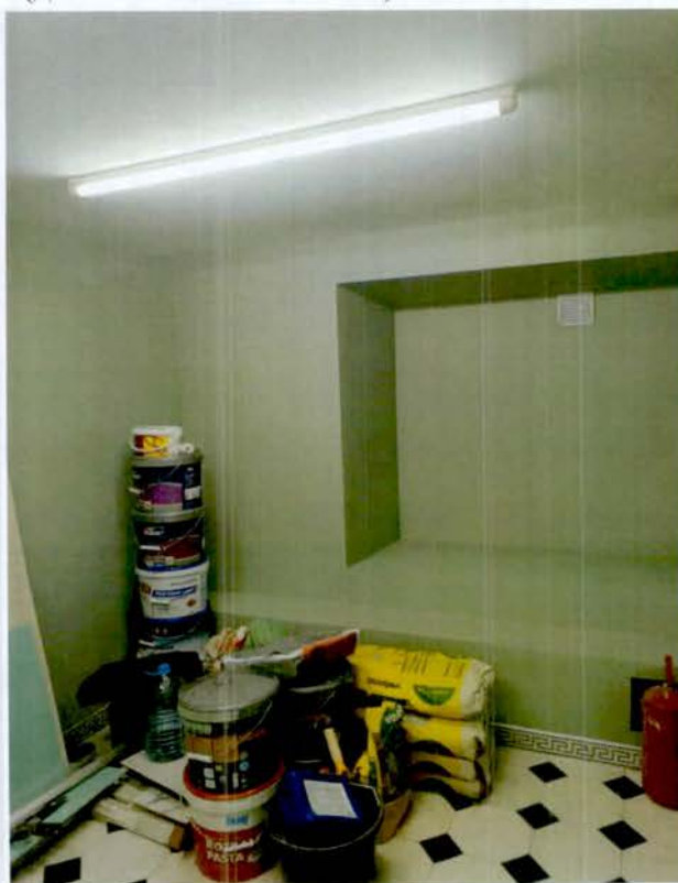
12. Помещение 2-Н (цокольный этаж) (дата съемки 11.03.2024).
