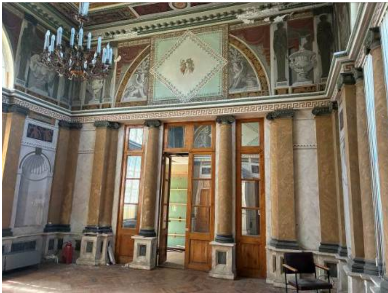
3. Бывшая спальня. Оформление стен и колонн под искусственный мрамор
