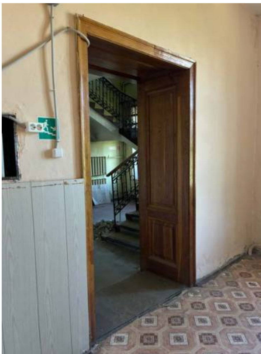
39. Вид в сторону помещения 42/24,2. Дверной проем
