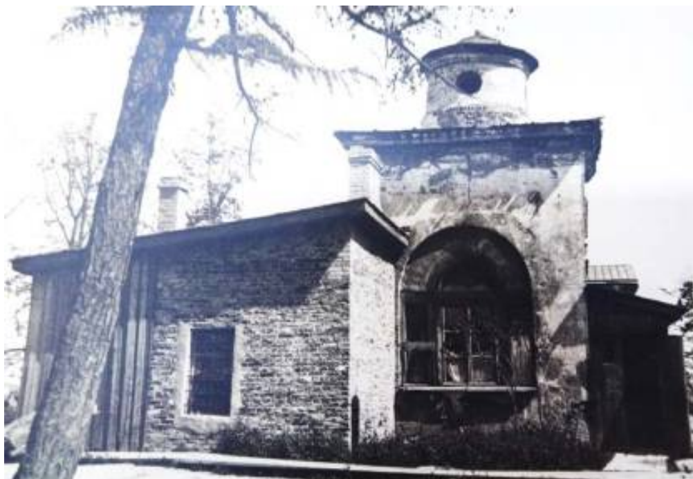
65. Дача Безобразовых. Западный фасад (башенка). 1938 г. Архив КГИОП. Н-157. Паспорт № 32 на здание общежития Охтинского лесопильного завода (бывшая дача Безобразовых). Альбом фотографий. 1939 г. Стр. 25
