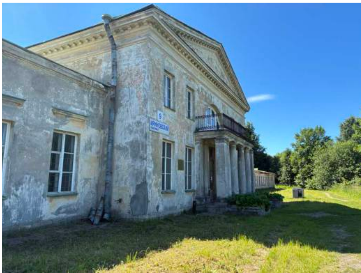
15. Северный фасад. Фрагмент. Вид с северо-восточной стороны на центральную часть
