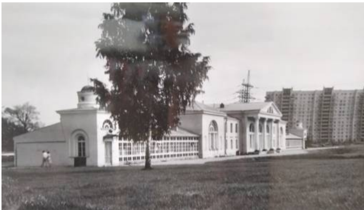
82. Дача Безобразовых ("Жерновка"). Северный фасад. Архив КГИОП. Фототека
