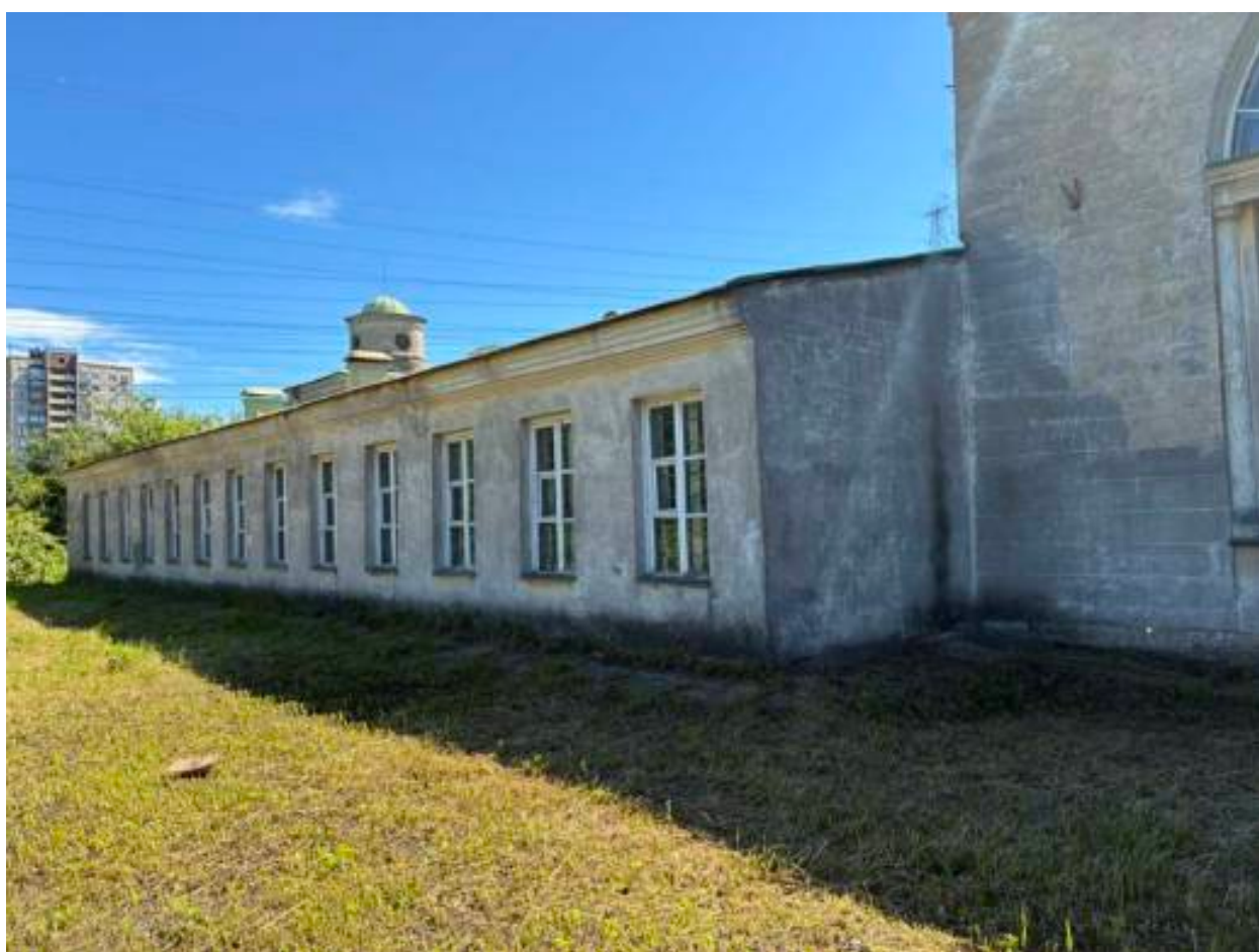
13. Северный фасад. Фрагмент. Восточное крыло
