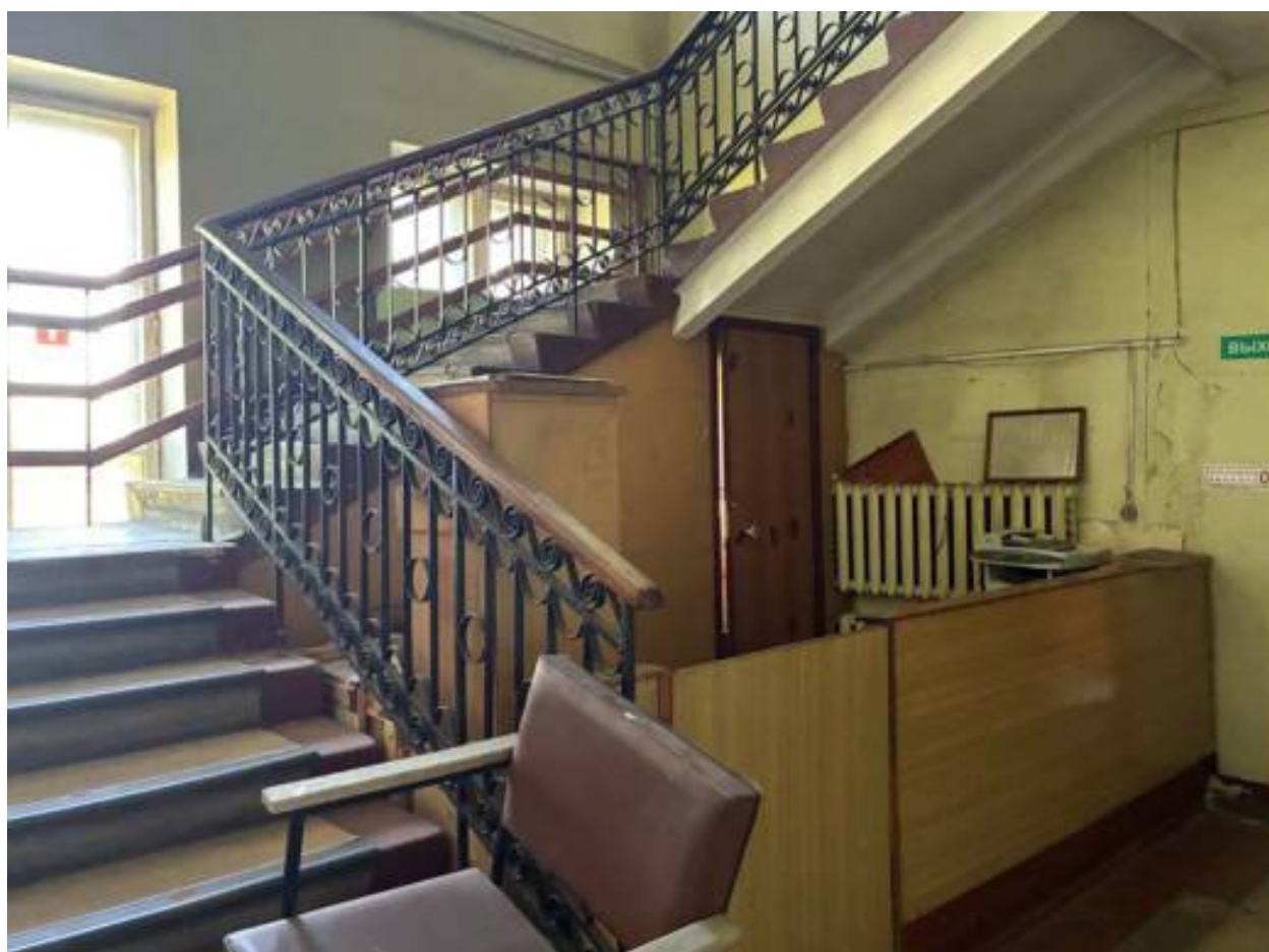
60. Западная лестница. Помещение 45/21, 2
