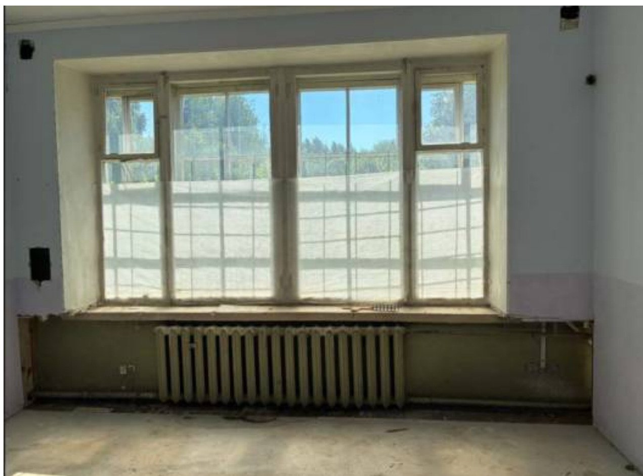
54. Западное крыло. Помещение 76/24,8
