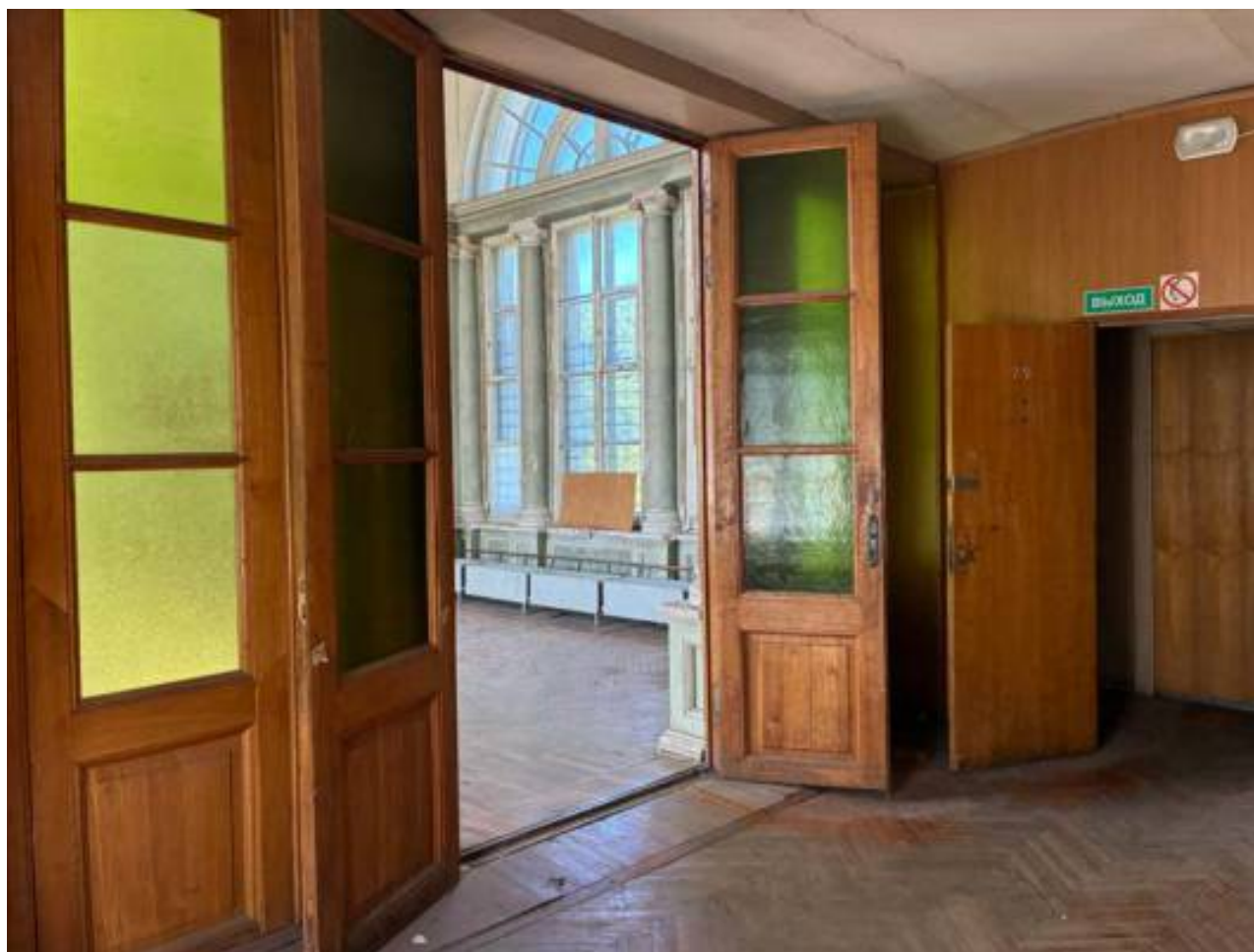
49. Западное крыло Помещение 58/18,4
