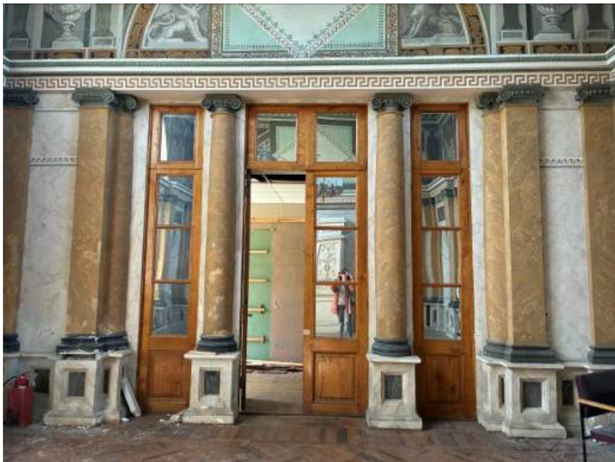
6. Бывшая спальня. Полуколонны, колонны в одну четверть, пилястры ионического ордера
