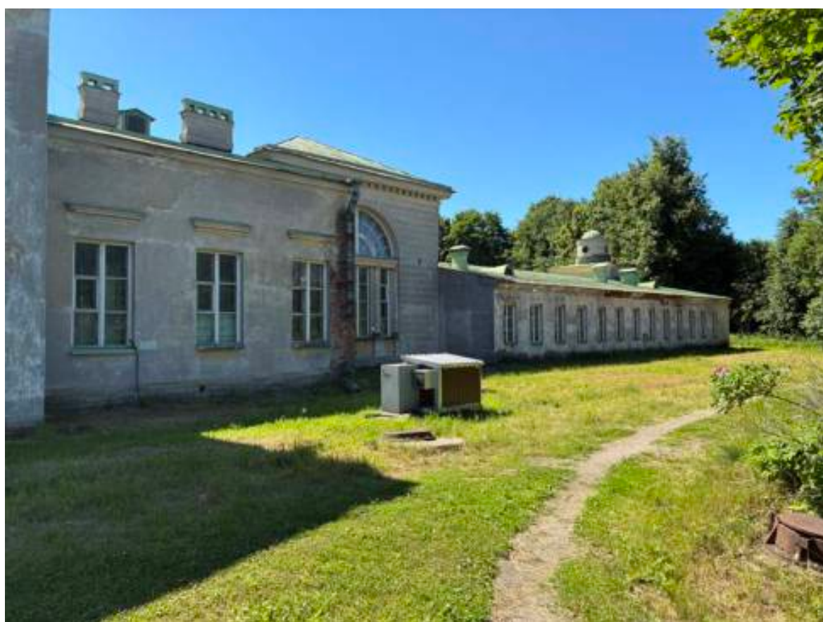
22. Северный фасад. Фрагмент. Западное крыло
