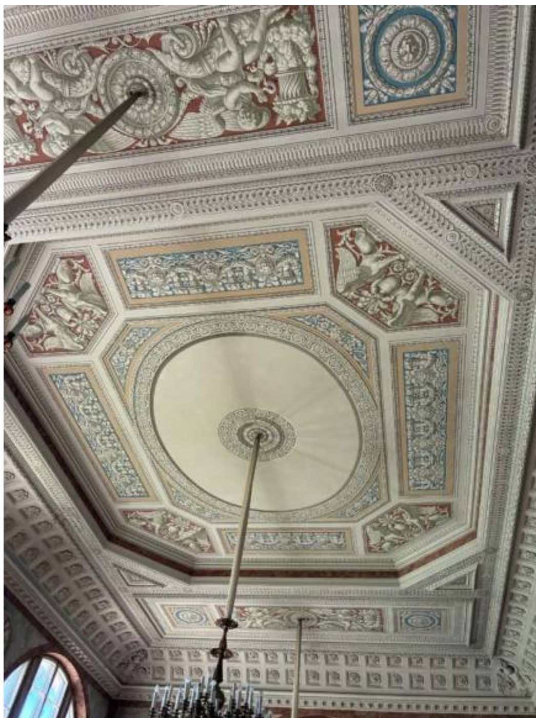
17. Зал. Оформление плафона потолка в технике гризайль
