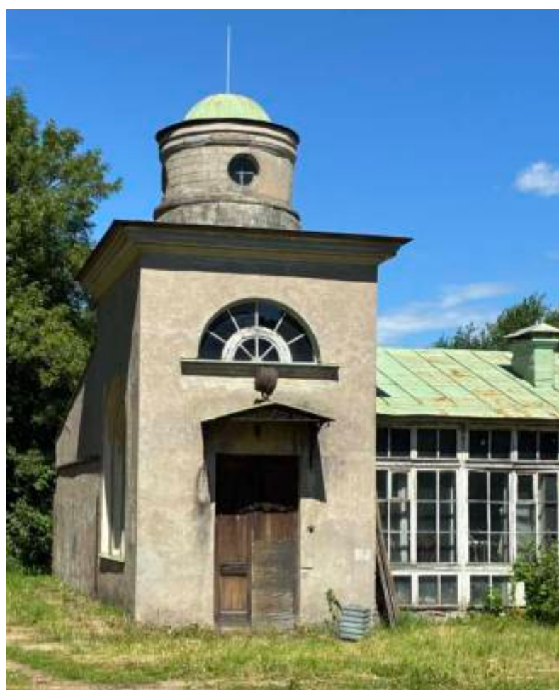
3. Южный фасад. Фрагмент. Башня западного крыла.
