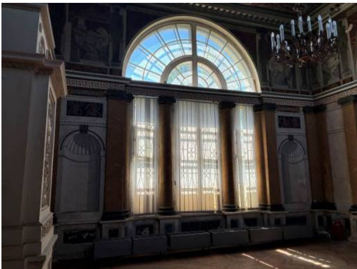
7. Бывшая спальня. Полуколонны, колонны в одну четверть, пилястры ионического ордера – поверхность фуста – имитация сиенского мрамора. Альфрейная роспись стен – ниша-экседра
