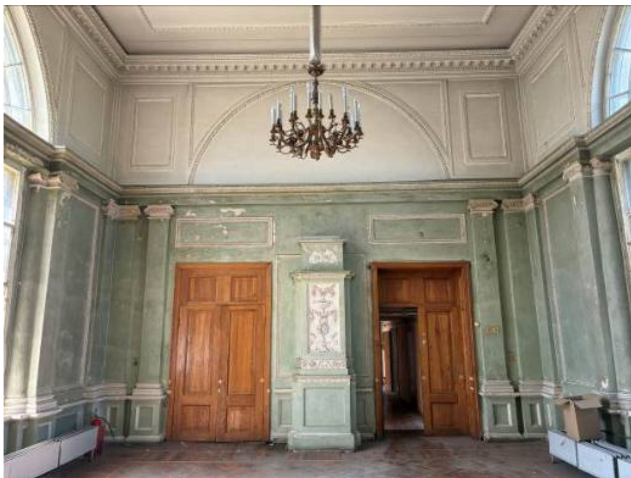
20. Помещение полностью восстановленного павильона б. столовой. Вид в сторону устроенной печи по аналогу с располагавшейся в б. спальне
