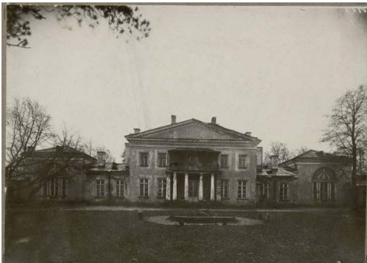
58. Дача Безобразовых. Северный фасад. 1937 г. Провенанс ГМИМК. НИМ РАХ КП-401/15. Ф-8679
