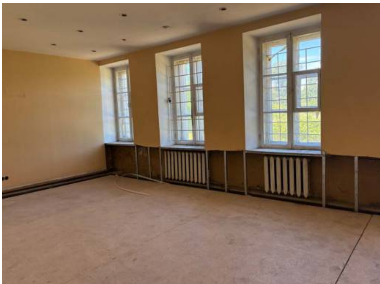
29. Помещение восточного флигеля (26/28,0).
