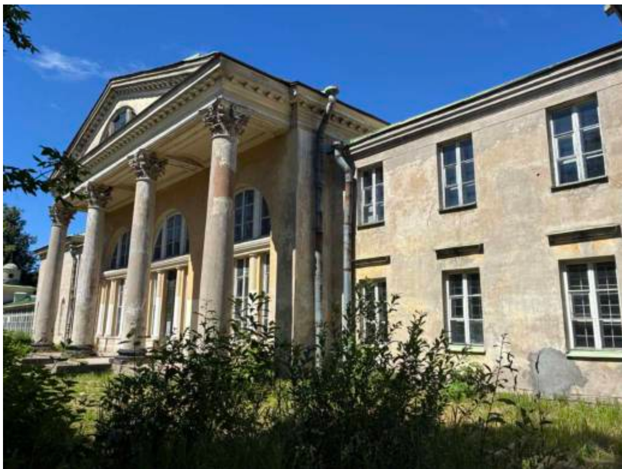
6. Южный фасад. Фрагмент. Четырехколонный портик с треугольным фронтоном
