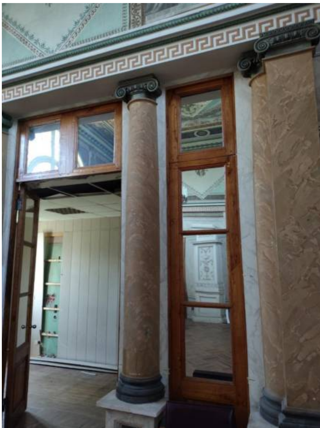
5. Бывшая спальня. Оформление дверного проема полуколоннами и пилястрами ионического ордера
