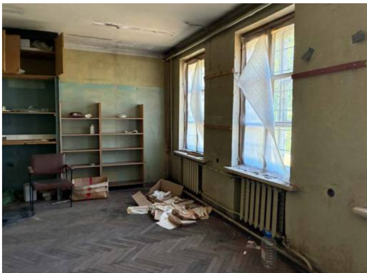
57. Западное крыло. Помещение 89/22,2
