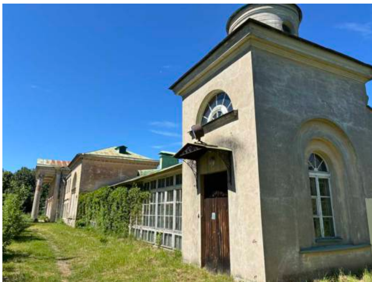
8. Вид со стороны восточного крыла. Восточный павильон с башенкой
