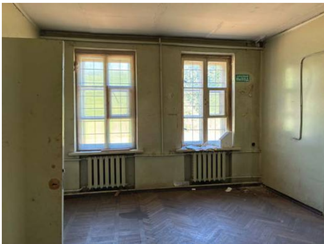
56. Западное крыло. Помещение 84/17,7
