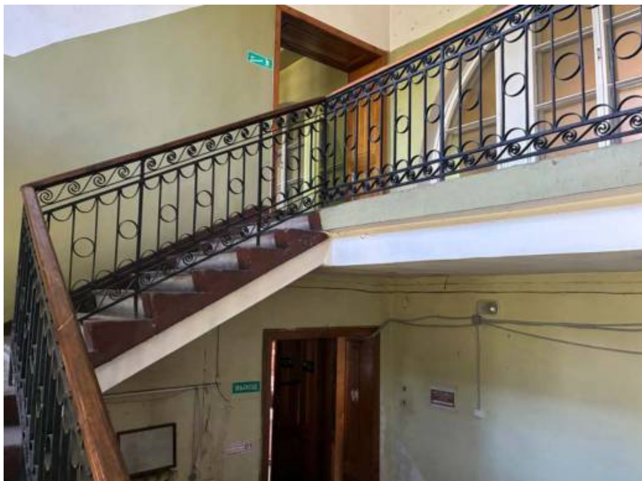
61. Лестница. 1 этаж. Помещение 45/21, 2
