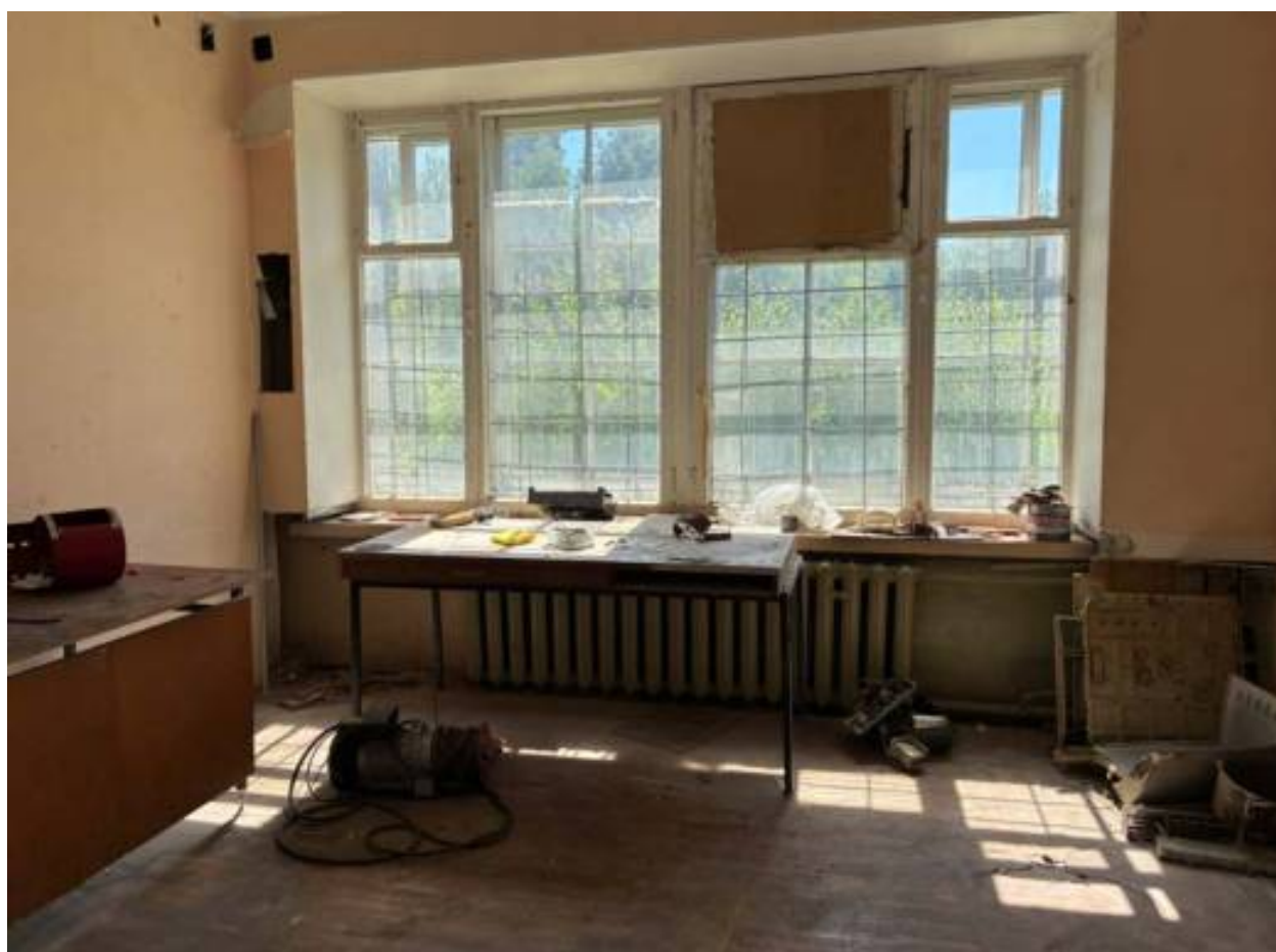
51. Западное крыло Помещение 62/23,9
