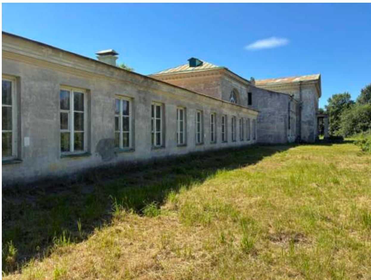
12. Северный фасад. Фрагмент. Восточное крыло
