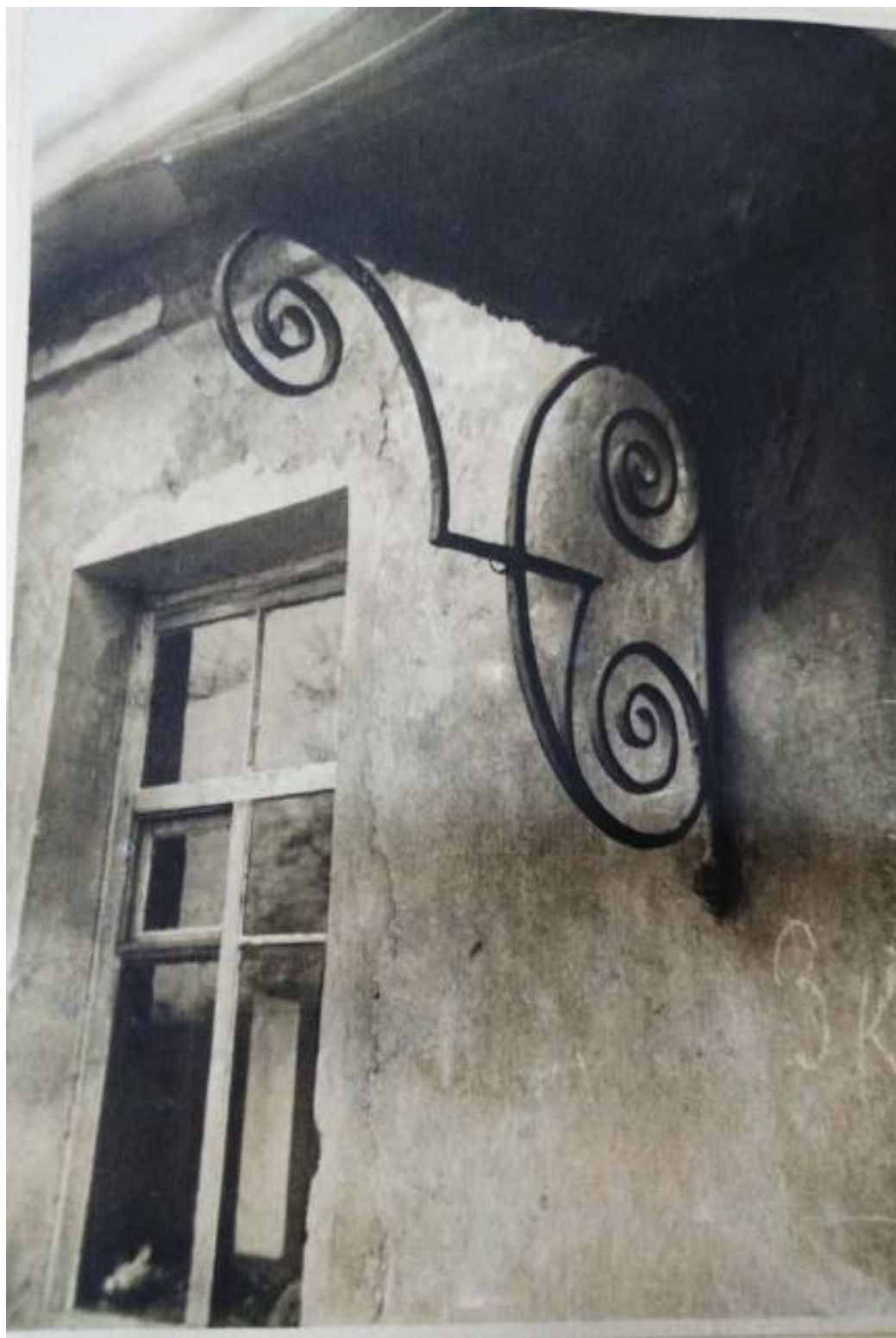
60. Дача Безобразовых. Северный фасад. Кронштейны навеса. Архив КГИОП. Н-157. Паспорт № 32 на здание общежития Охтинского лесопильного завода (бывшая дача Безобразовых). С. 47
