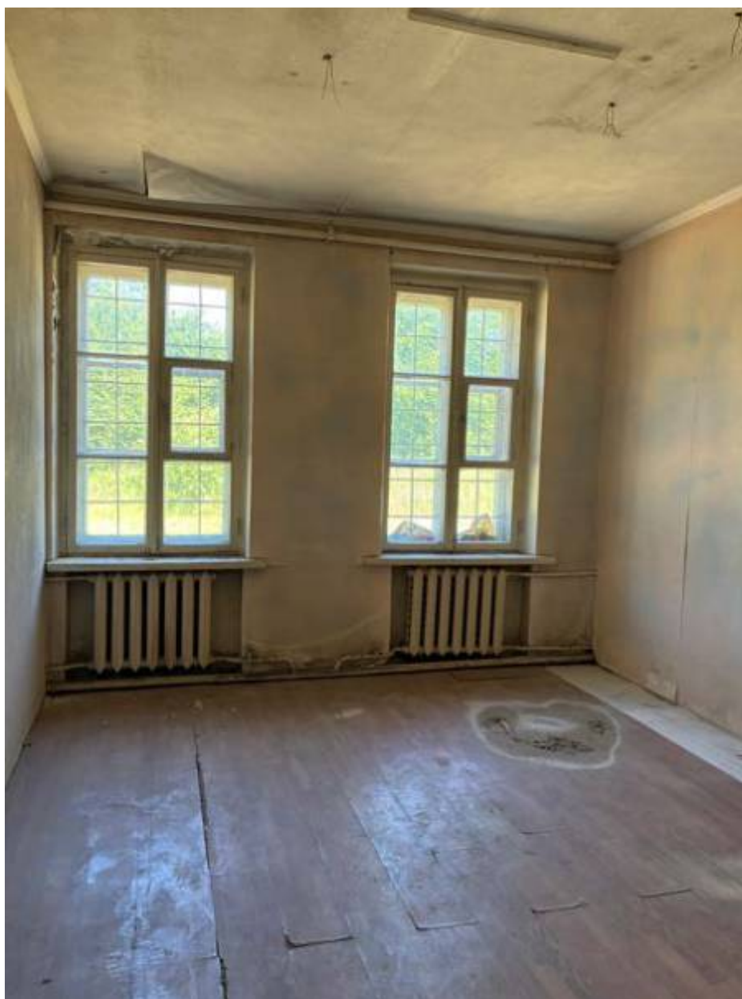
53. Западное крыло. Помещение 72/14, 5
