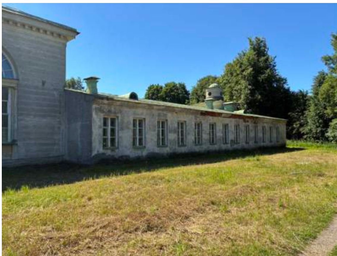
23. Северный фасад. Фрагмент. Западное крыло
