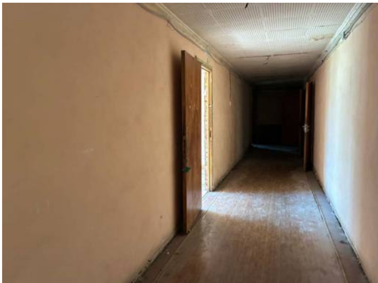
58. Коридор западного крыла. Помещение 79/47,2
