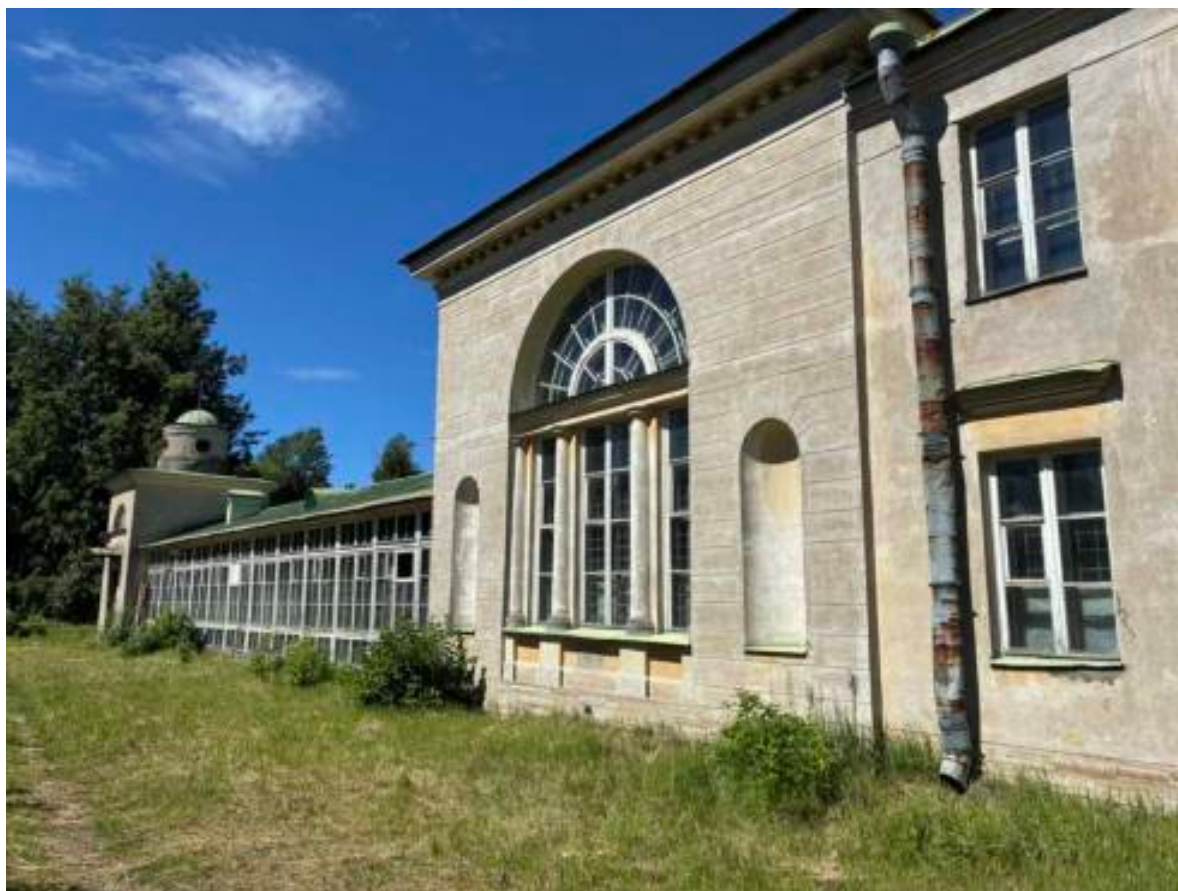
2. Южный фасад. Фрагмент. Западное крыло и центральная часть. Восстановленный объем б. Спальни.
