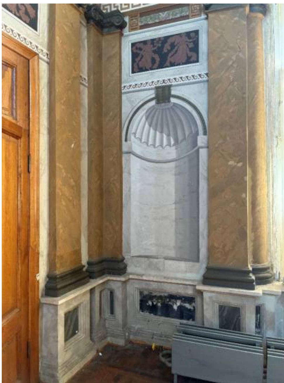
8. Бывшая спальня. Полуколонны, колонны в одну четверть, пилястры ионического ордера – поверхность фуста – имитация сиенского мрамора. Альфрейная роспись стен – ниша-экседра
