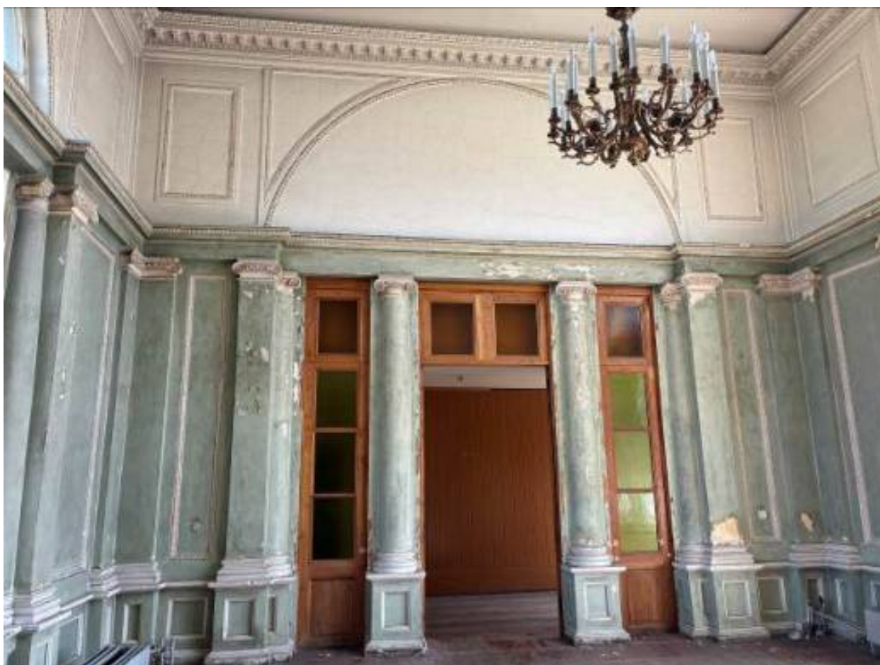
23. Помещение полностью восстановленного павильона б. столовой. Оформление стен и оконного проема пилястрами, полуколоннами, колоннами в одну четверть ионического ордера
