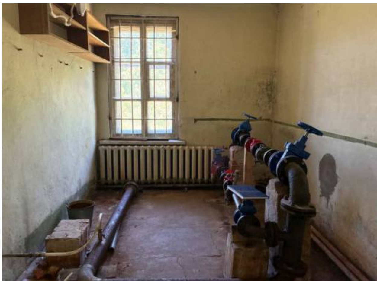
35. Помещение восточного флигеля (16/12,0)
