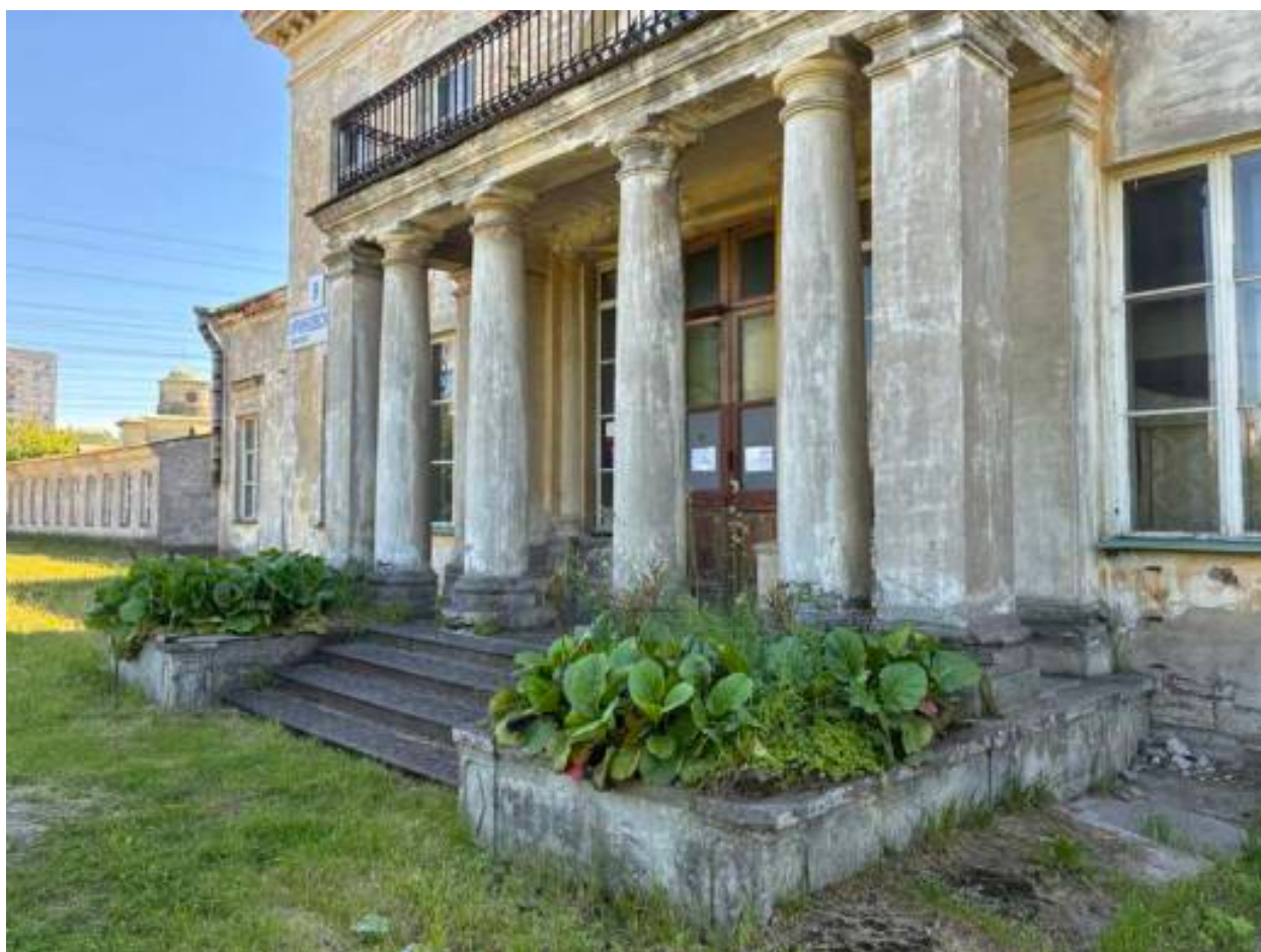
19. Северный фасад. Фрагмент. Центральный объем. Портик тосканского ордера с балконом
