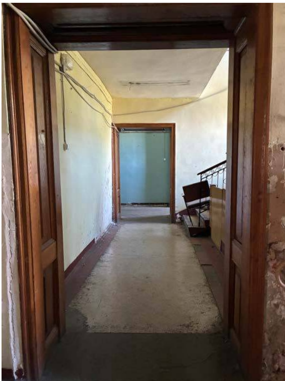
43. Западная лестница. Помещение 45/21,2
