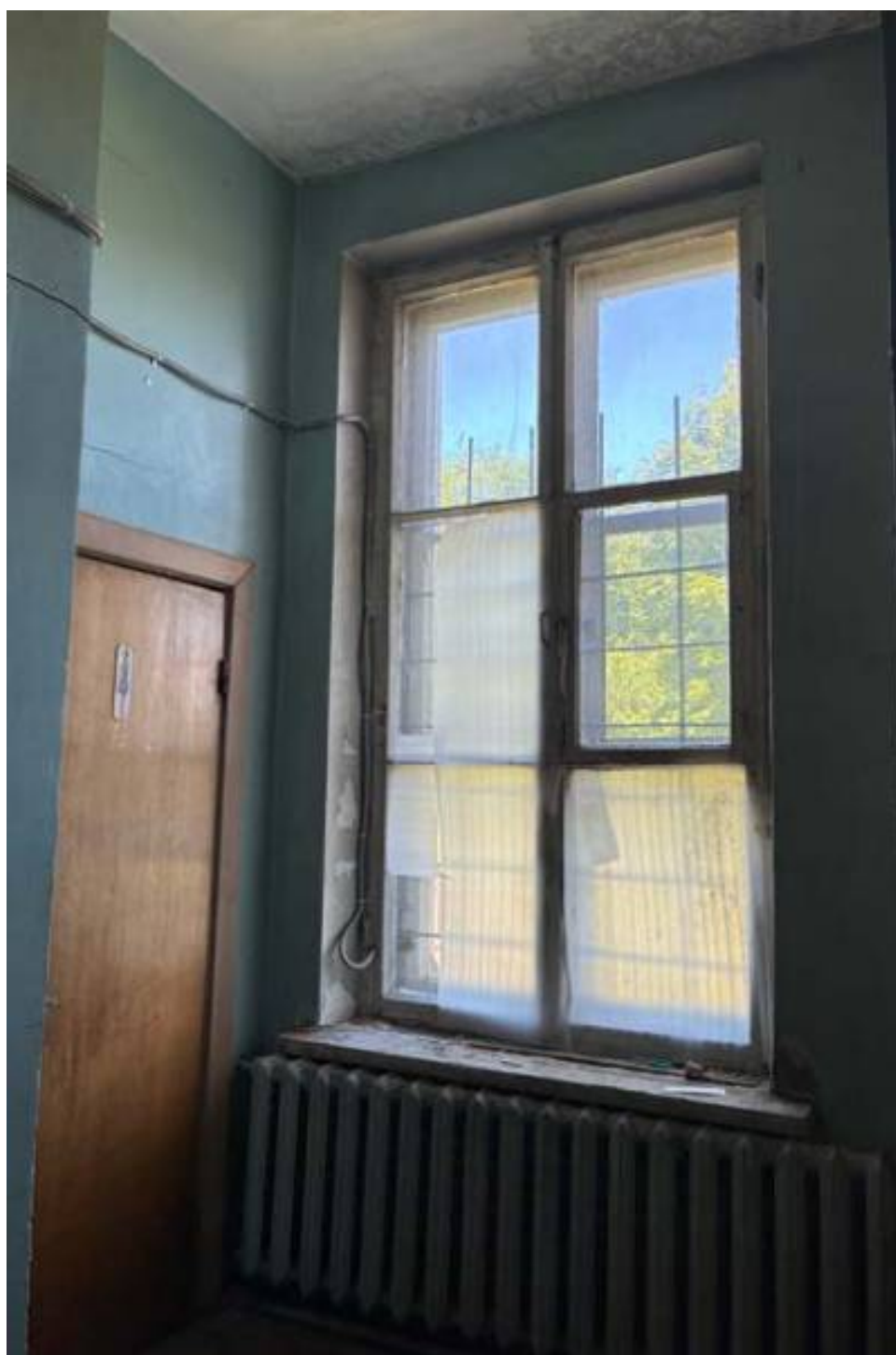
45. Западное крыло. Помещение 47/11,7
