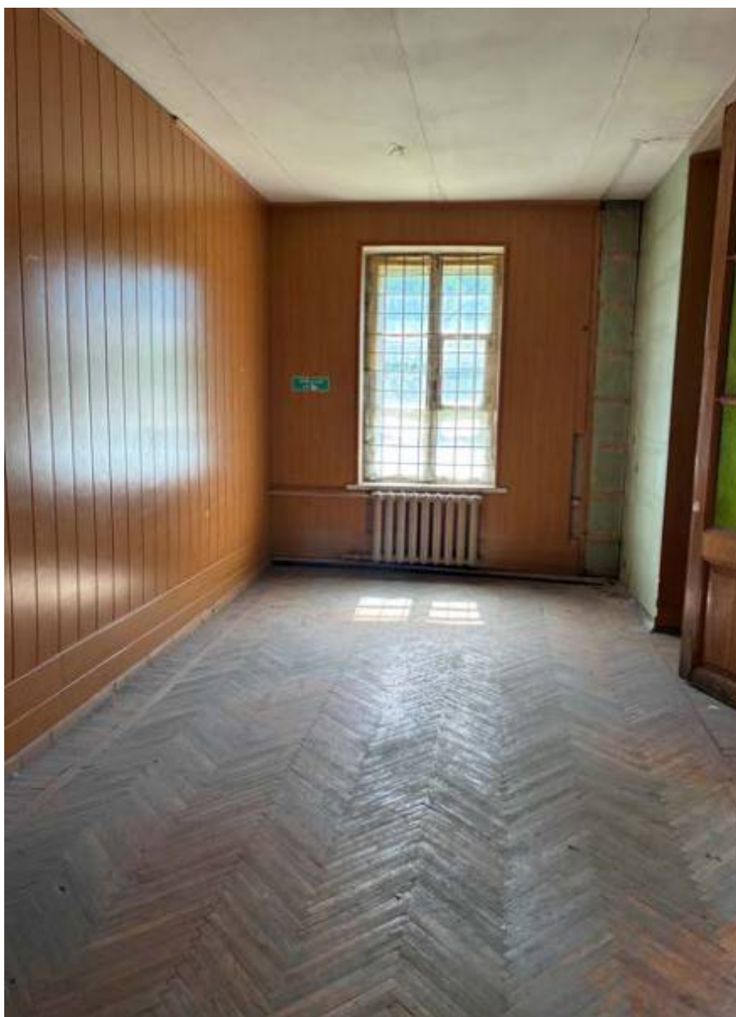
48. Западное крыло Помещение 58/18,4
