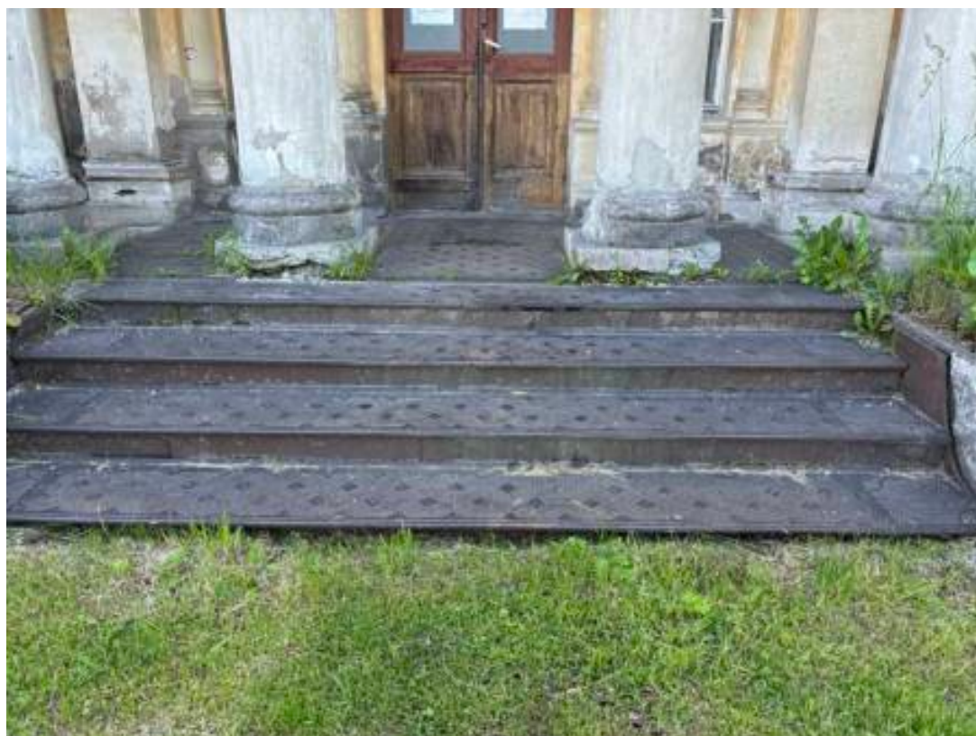
20. Северный фасад. Фрагмент. Центральный объем. Крыльцо, облицованное чугунными плитами
