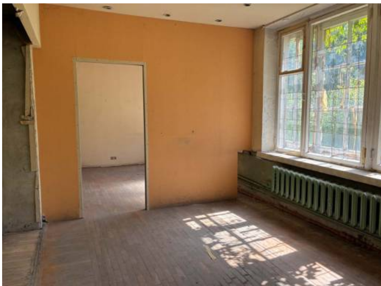
32. Помещение на месте бывшей оранжереи восточного крыла (6/36,0).
