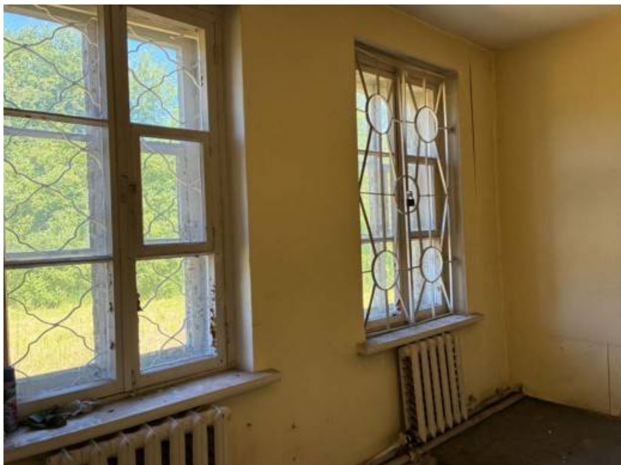
34. Помещение восточного флигеля (22/14,4)
