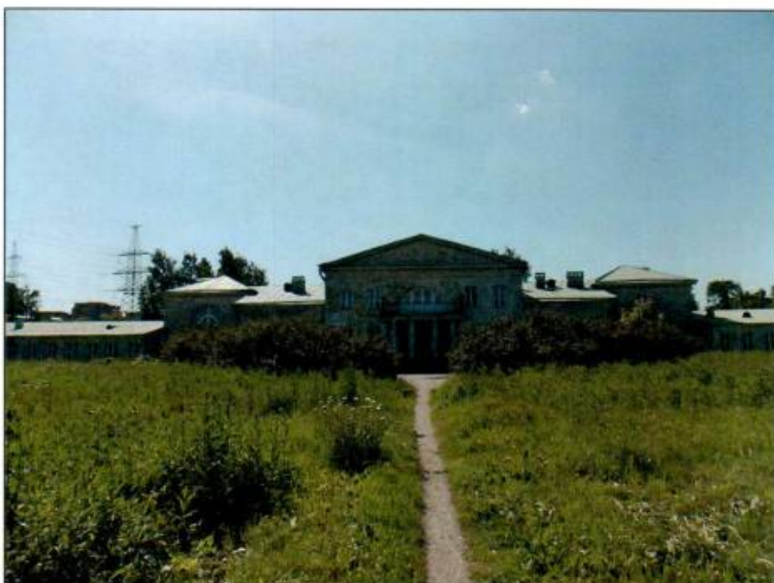
21. Вид на северный фасад здания дачи.
