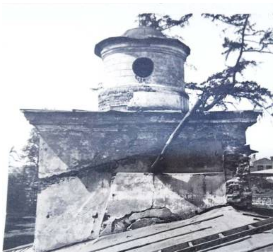
66. Дача Безобразовых. Западная башенка. Восточный фасад. 1938 г. Архив КГИОП. Н-157. Паспорт № 32 на здание общежития Охтинского лесопильного завода (бывшая дача Безобразовых). Альбом фотографий. 1939 г. Стр. 29
