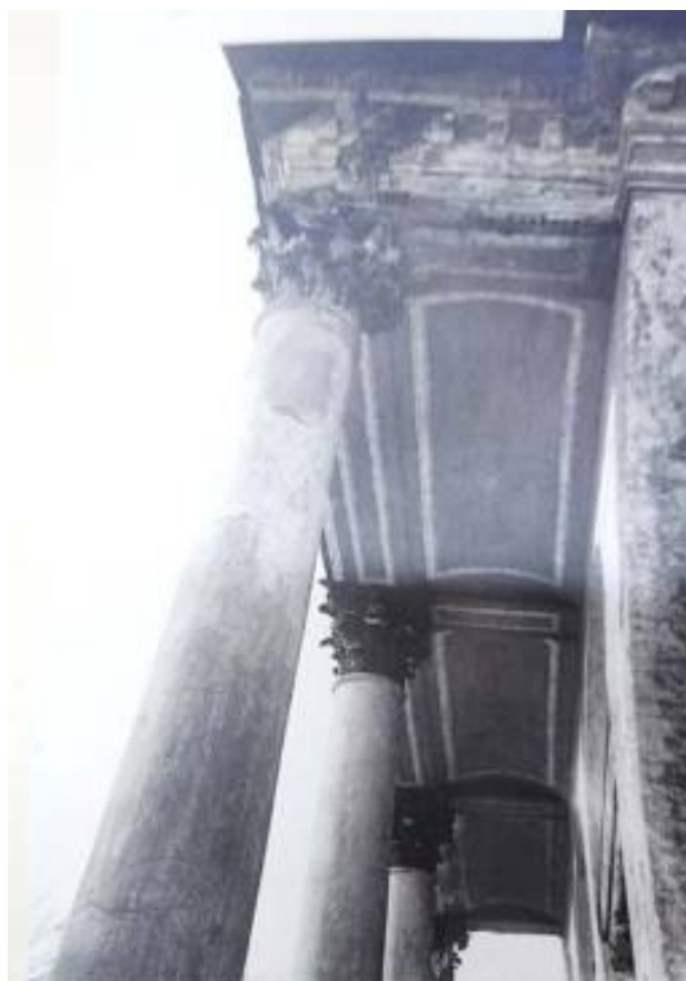
52. Дача Безобразовых. Южный фасад (фрагмент портика). Архив КГИОП. Н-157. Паспорт № 32 на здание общежития Охтинского лесопильного завода (бывшая дача Безобразовых). С. 41.
