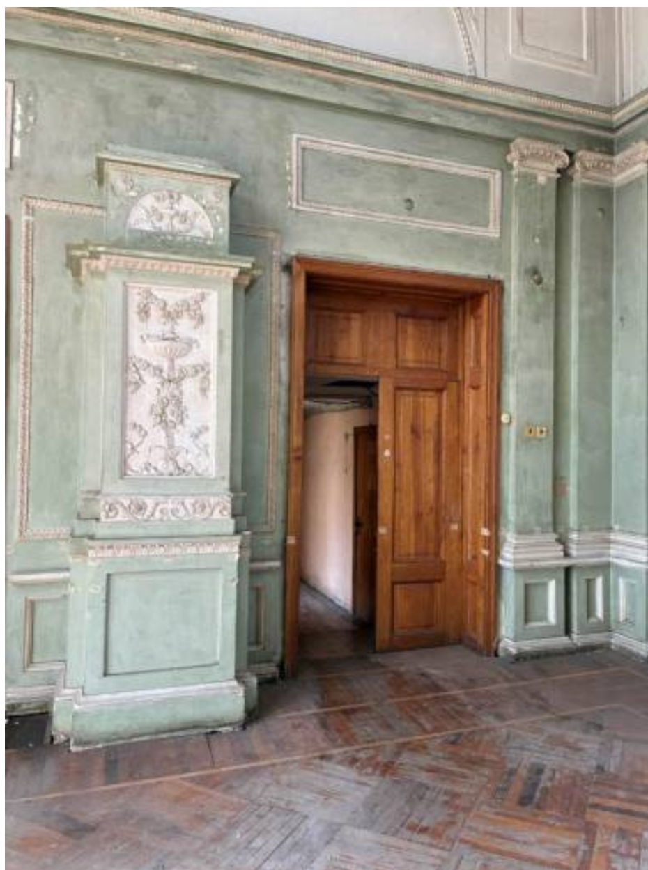
21. Помещение полностью восстановленного павильона б. столовой. Вид в сторону устроенной печи по аналогу с располагавшейся в б. спальне
