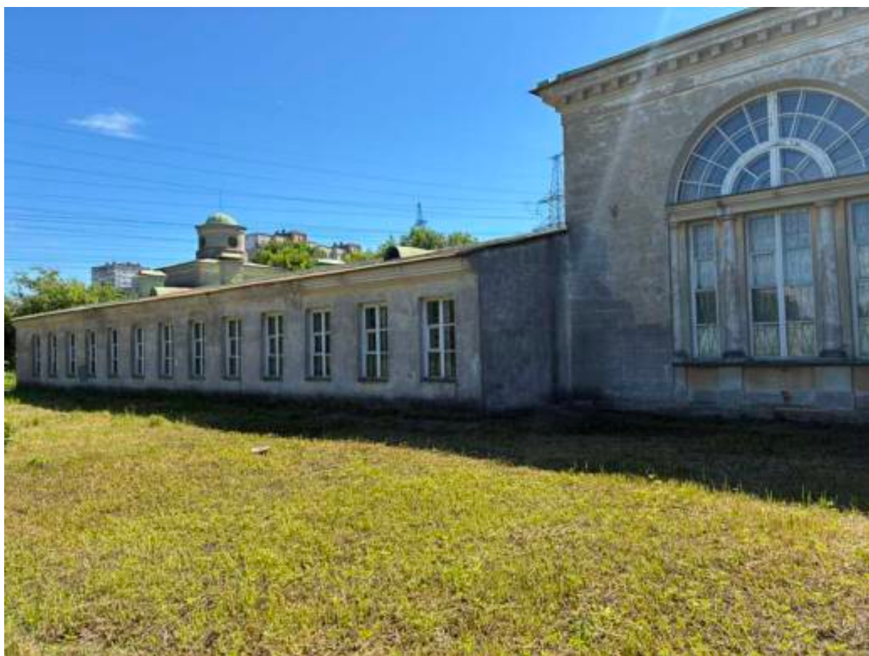
16. Северный фасад. Фрагмент. Восточное крыло.
