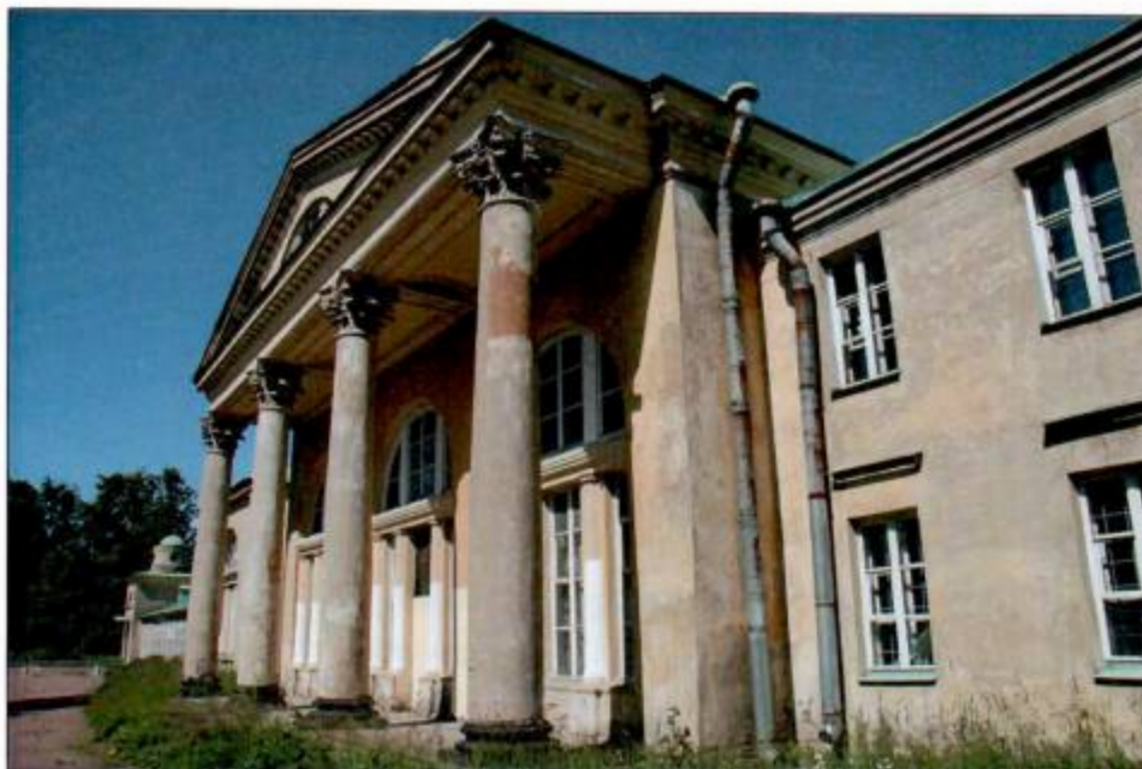
6. Фрагмент. Северный фасад.
