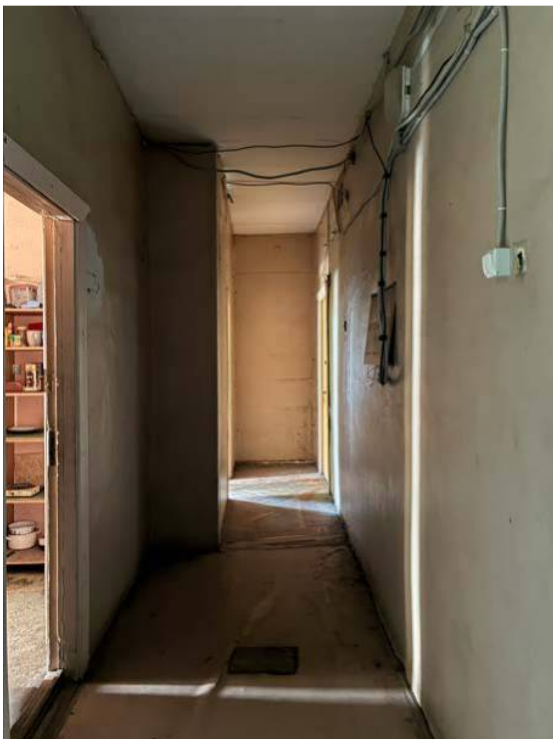
47. Западное крыло Помещение 57/9,7
