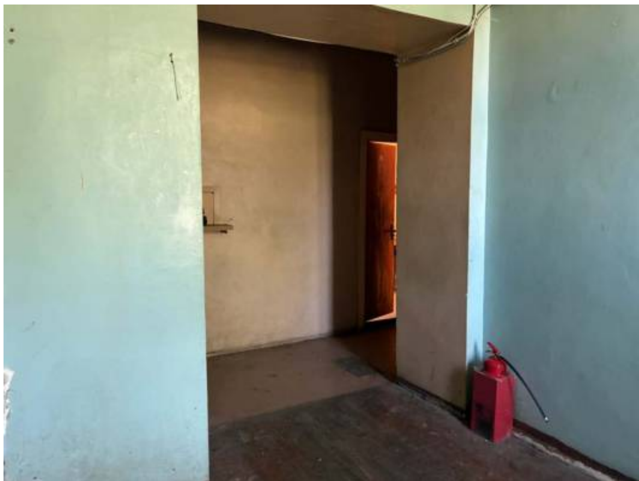
46. Западное крыло. Вид в сторону помещения 57/9,7
