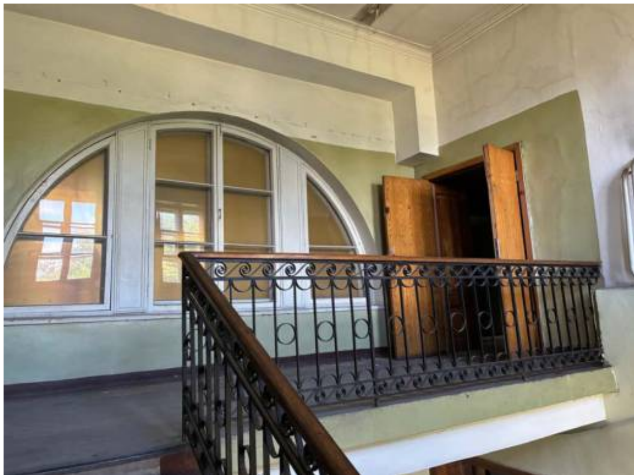
62. 2 этаж. Лестница. Помещение 122/24,9
