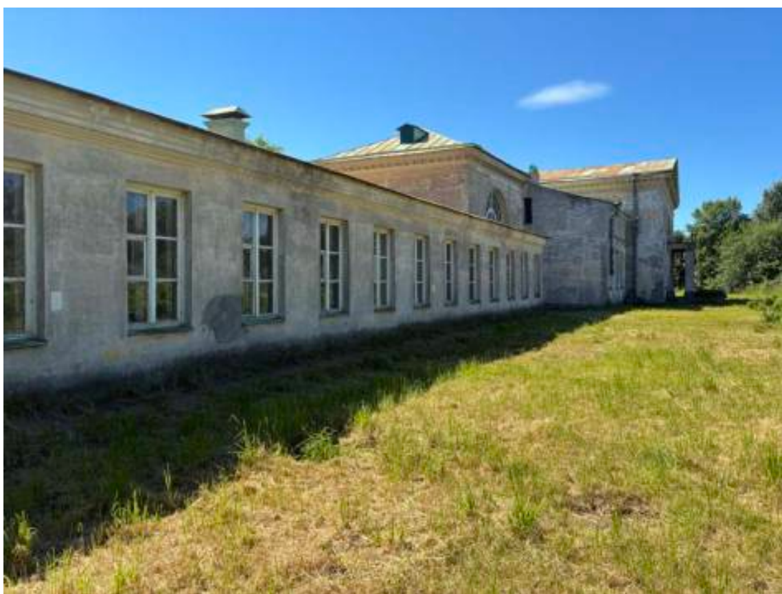
14. Северный фасад. Фрагмент. Вид с северо-восточной стороны на центральную часть
