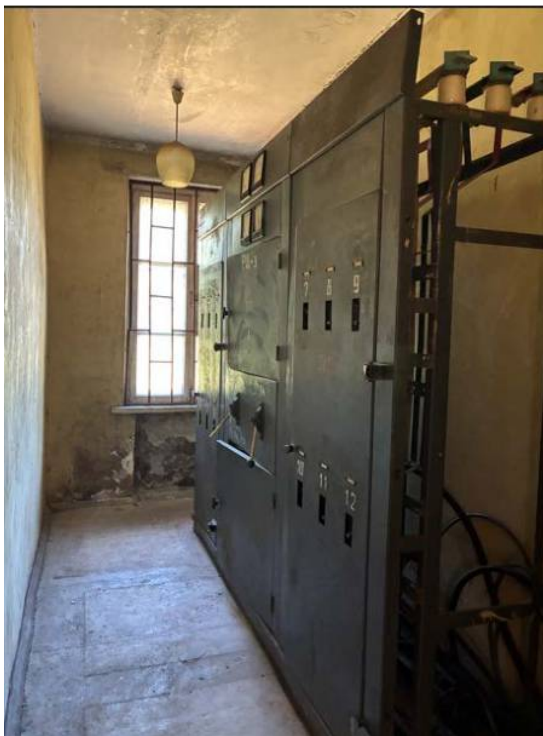
52. Западное крыло Помещение 69/9,0
