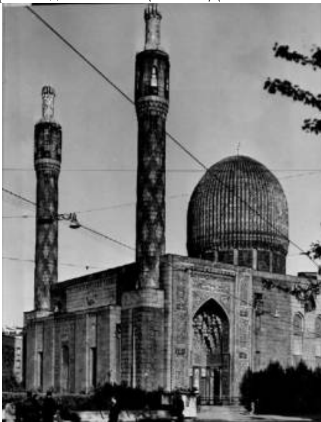
22. Общий вид с северо-запада. 1971 г. — Соборная мечеть // Citywalls.ru – архитектурный сайт Петербурга [Электронный ресурс]. URL: https://www.citywalls.ru/house5457.html .
