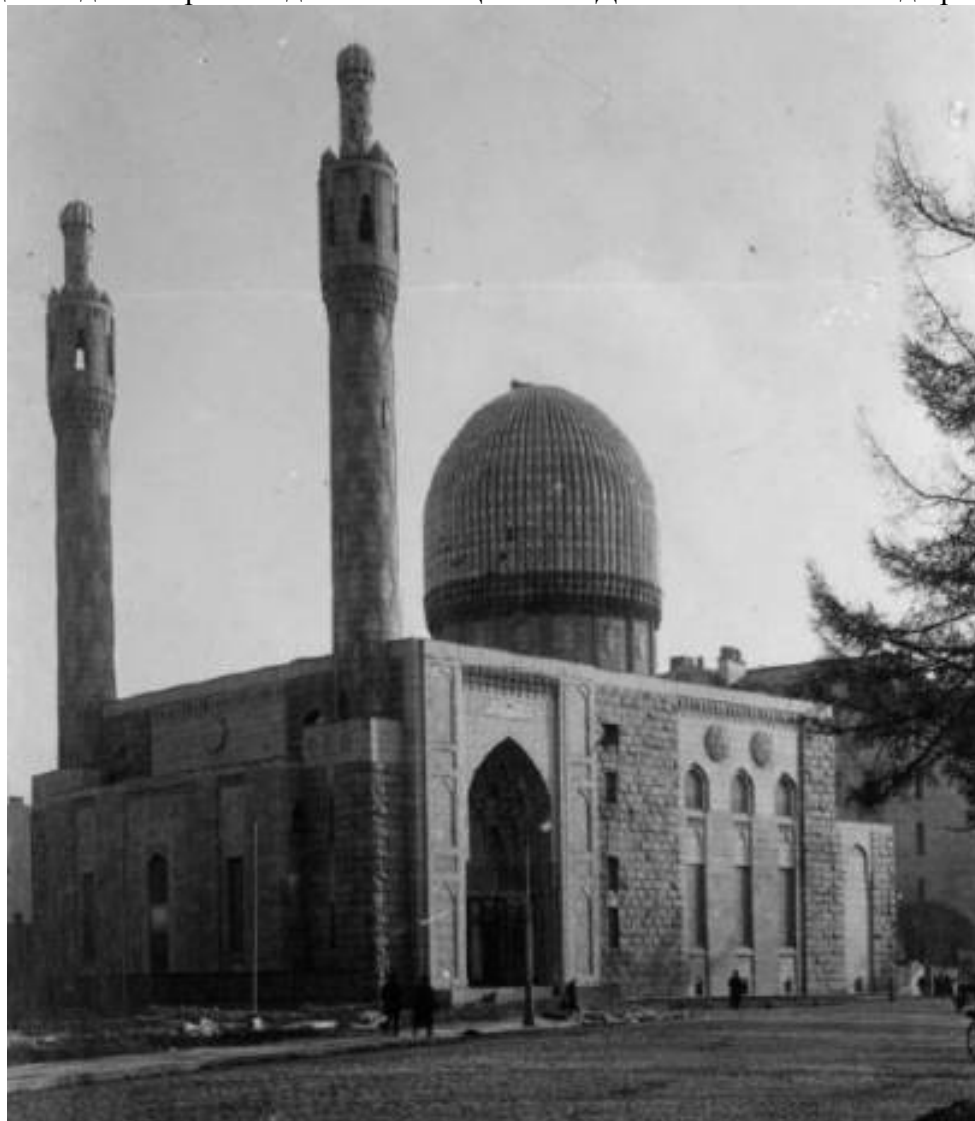
16. Общий вид с северо-запада. 1934 г. // ЦГАКФФД СПб Гр 39175
