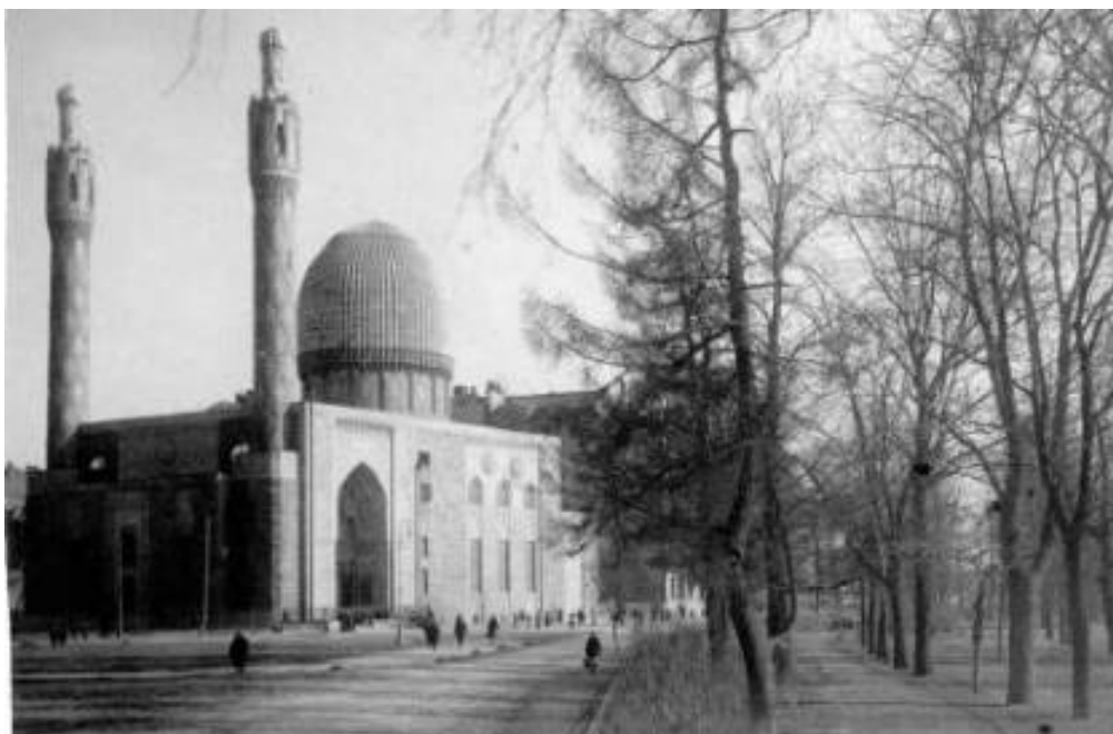
15. Общий вид с северо-запада. 1933 г. // ЦГАКФФД СПб. Оп. 1ВР-25. Ед.хр. 33142
